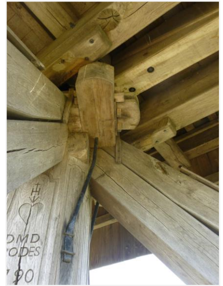
Foto 8: verbinding steekbalken en zetel
