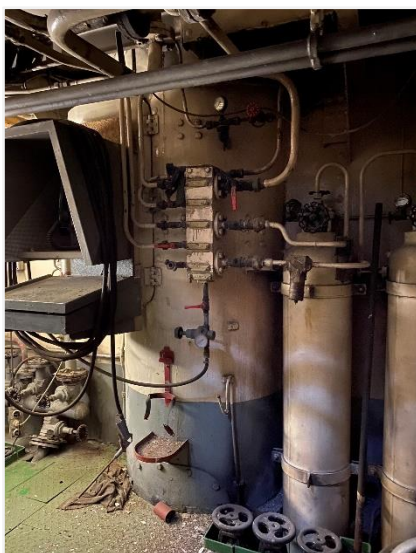
Foto 35: perslucht tanks en voet licht
