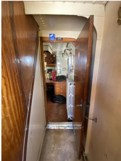
Foto 111: toegang tot de radiokamer
