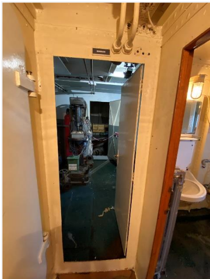
Foto 60: tussendek achter: doorgang naar werkplaats en stuurmachine
