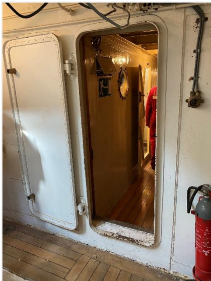
Foto 69: voorbeeld van een deur van een waterdicht schot
