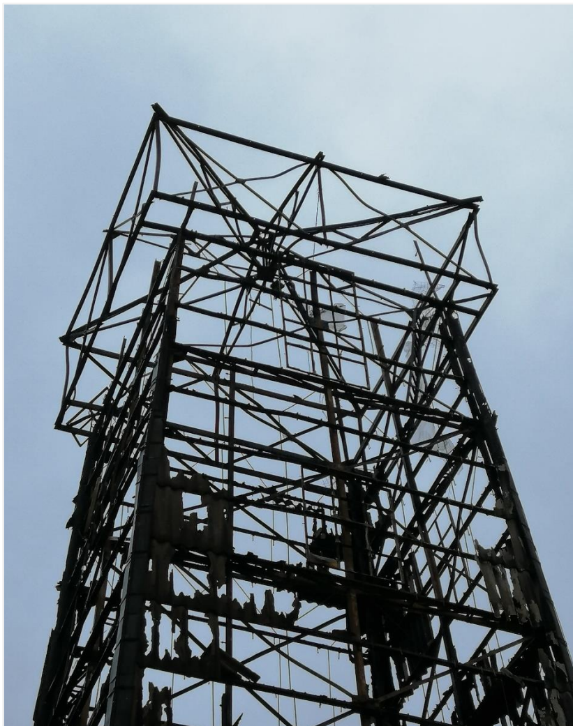
Foto 3: Detail van het skelet van de bekroning van de toren
