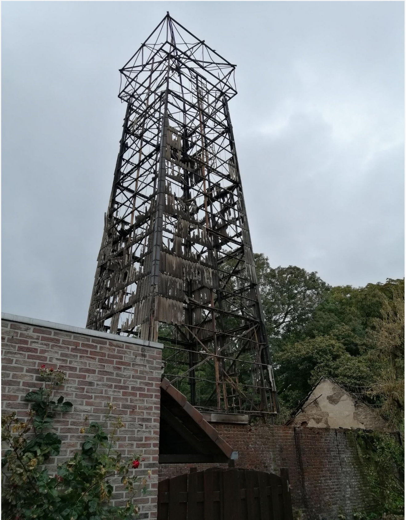
Foto 1: De staalstructuur van de toren
