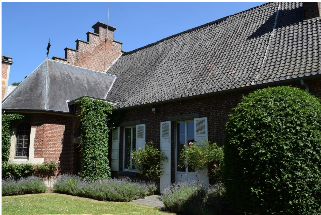
Foto 36: gedeelte van de schuur dat werd ingenomen door een woongedeelte of dienstwoning en werd toegevoegd aan de woning van 1926. De uiterst linker travee is uitgebouwd tot een huiskapel met driezijdige sluiting en zijlingse deurtravee.
