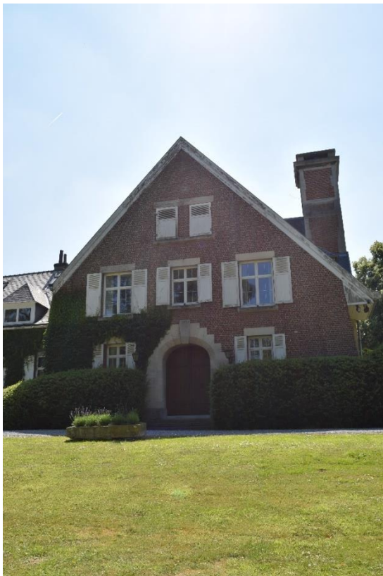
Foto 42: De hoofdkom van de woning ligt aan een brede in grind heraangelegde oprit; de voorgevel is uitgebouwd als een diephuis met hoge puntgevel onder een steil zadeldak.
