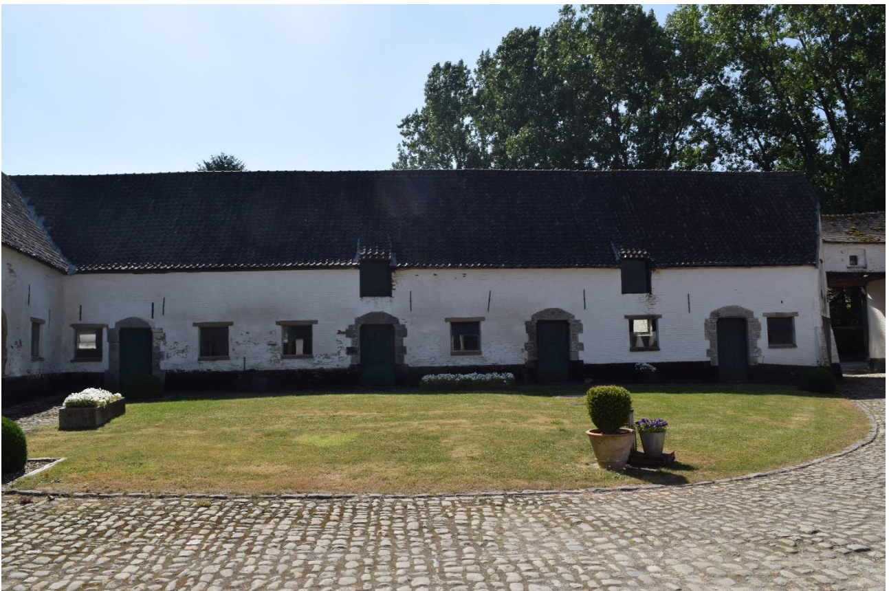
Foto 12: zuidoostelijke stalvleugel repetitief doorbroken door vier rechthoekige deuren met zware gebouchardeerde omlijstingen geflankeerd tussen jongere rechthoekige vensteropeningen onder latei; rechts aanpalend de zuidelijke veldpoort
