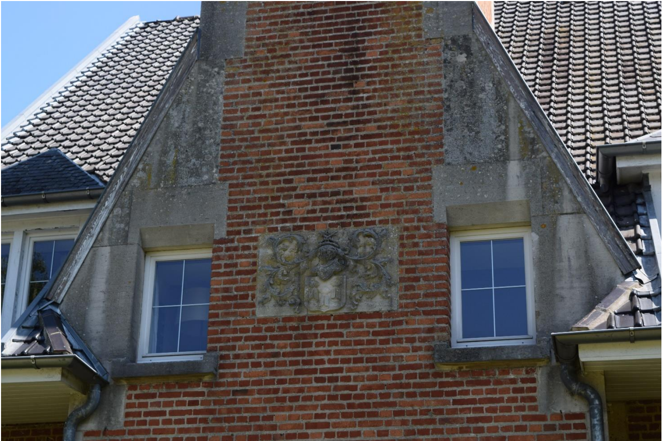
Foto 39: in de zuidwestelijke tuingevel zit kenmerkend een zwaar uitgewerkte schoorsteenaanzet met centraal een ingewerkt wapenschild tussen flankerende vensters onder zware latei
