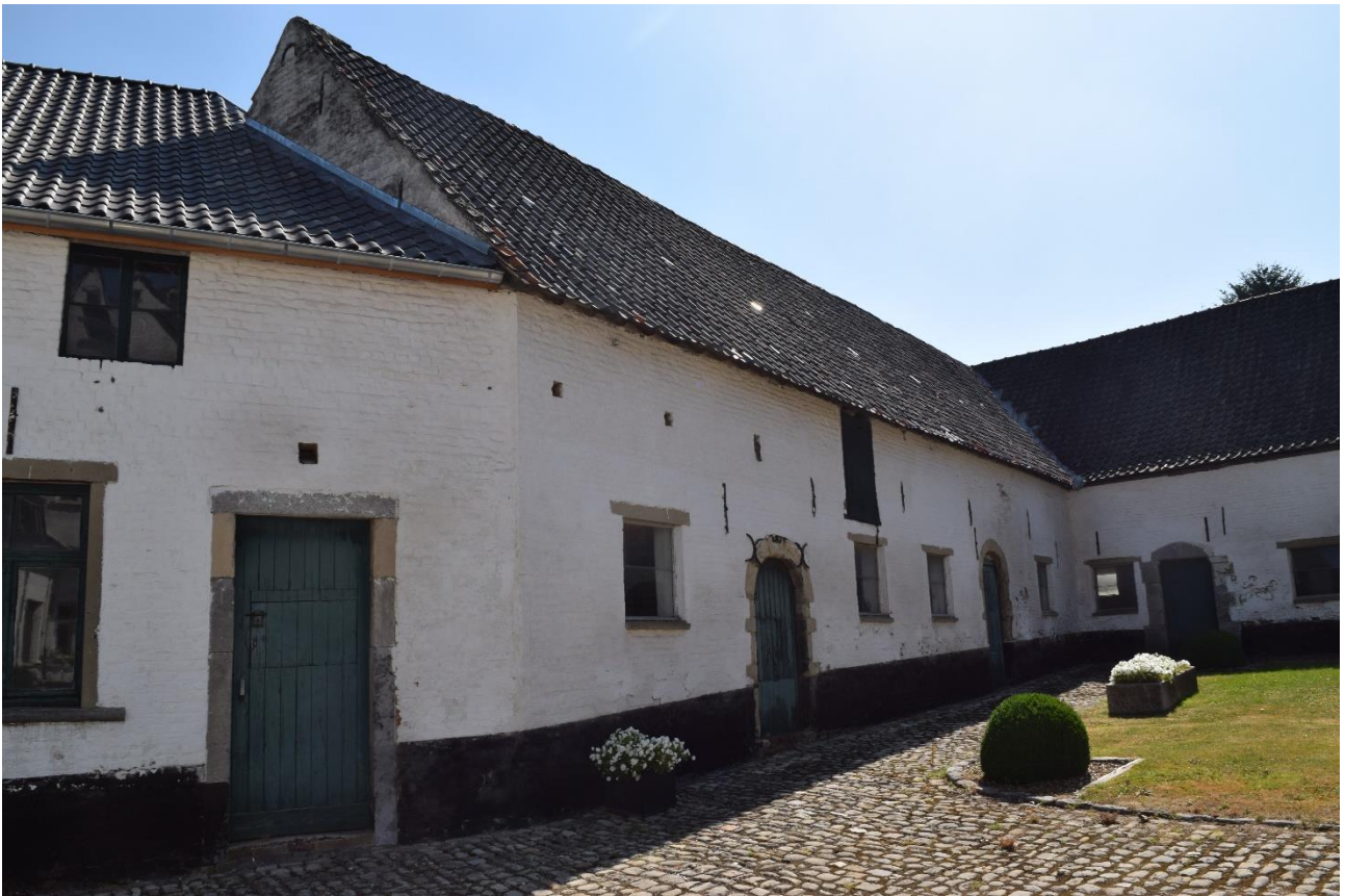
Foto 11: noordoostelijke stalvleugel met rondboogvormige omlijste deuropeningen tussen telkens twee rechthoekige vensteropeningen onder latei
