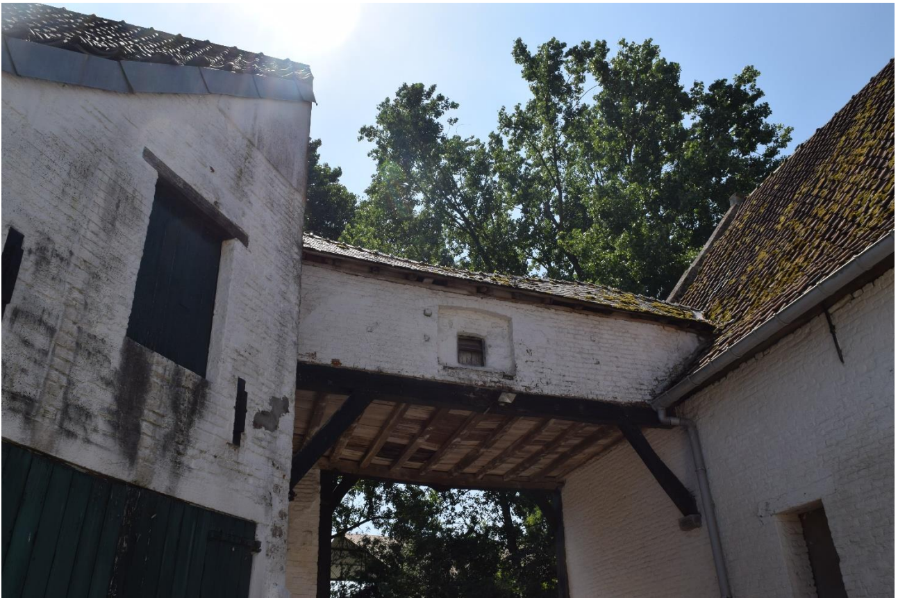
Foto 19: zuidelijke veldpoort onder houten dwarsbalk op korbelen en houten zoldering onder leien zadeldakje
