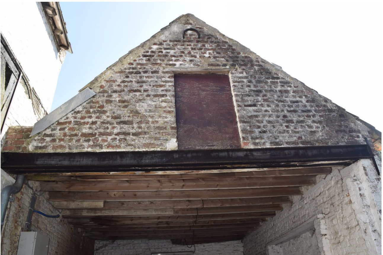
Foto 30: open wagenhuis of wagenberging onder metalen latei met balkenzoldering in de verankerde topgevel met pannen zadeldak; het bakstenen volume paalt aan de stalvleugel, rechts van de zuidelijke veldpoort
