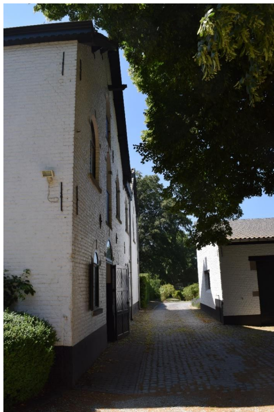
Foto 51: in 1913 werd ten zuiden van de hoeve een remise gebouwd, waarbij de nog bestaande dienstgebouwen verbonden waren door een overluifeling met deels gekasseide doorgang tussen de siertuin en de vroegere moestuin
