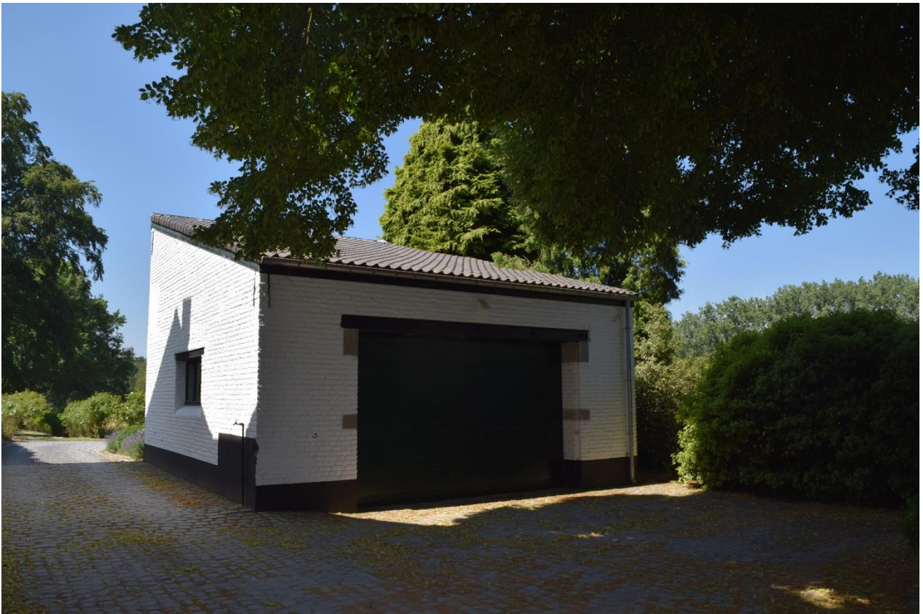
Foto 54: aangepast bijgebouw, als onderdeel refererend naar de remise van 1913, eertijds opgetrokken bij de aanleg van de siertuin en de vroegere moestuin, heden gerenoveerd garagebouw
