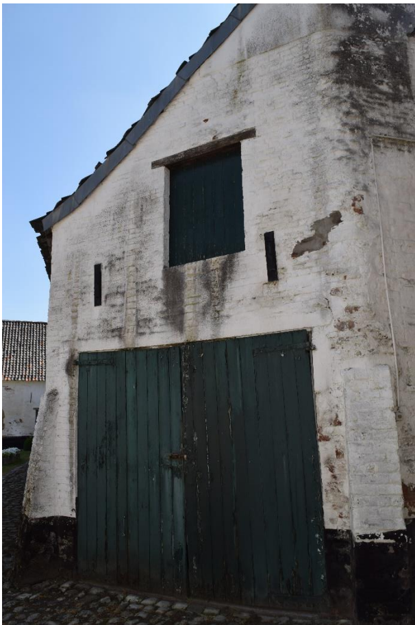
Foto 16: rechthoekige poort in de zuidelijke kopse gevel van de zuidoostelijke stalvleugel, op de hoeken met versterkte muurgedeelten of steunberen
