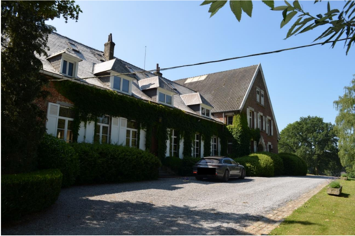
Foto 44: De noordwestelijke buitengevels (veldzijde) van de boerenhuizen werden in het begin van de 20ste eeuw aangepast aan de stijl van het moderne landelijke wonen. De vensteropeningen werden vergroot en beluikt; de leien daken werden doorbroken door grote dakkapellen. Enkel de drie uiterste linkse (noordelijke) traveeën behielden hun ouder uitzicht.
