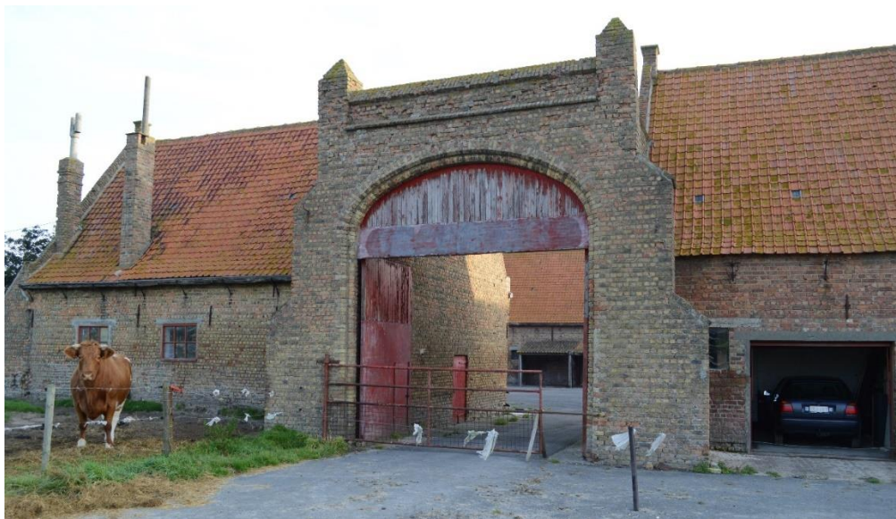
Foto 8. De toegangspoort aan de westzijde, deel uitmakend van de L-vormige stalvleugel (19.10.2017).
