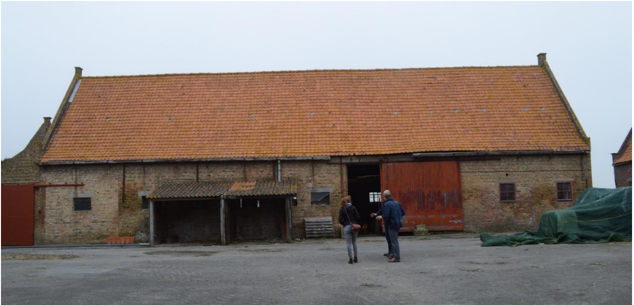
Foto 36. De erfgevel van de dwarsschuur met rechts bewaarde schuifpoort. De linker schuurpoort is dichtgemetseld. Tussen beide schuurpoorten, lichtgleuven. Rechts de aardappel- en bietenkelder. De deuren zijn intussen echter dichtgemetseld. Deels bewaarde bakgoot op in de muur verankerde ijzeren haken. DHet recente afdak onder lessenaarsdak tegen de erfgevel heeft geen erfgoedwaarde (12.04.2018).
