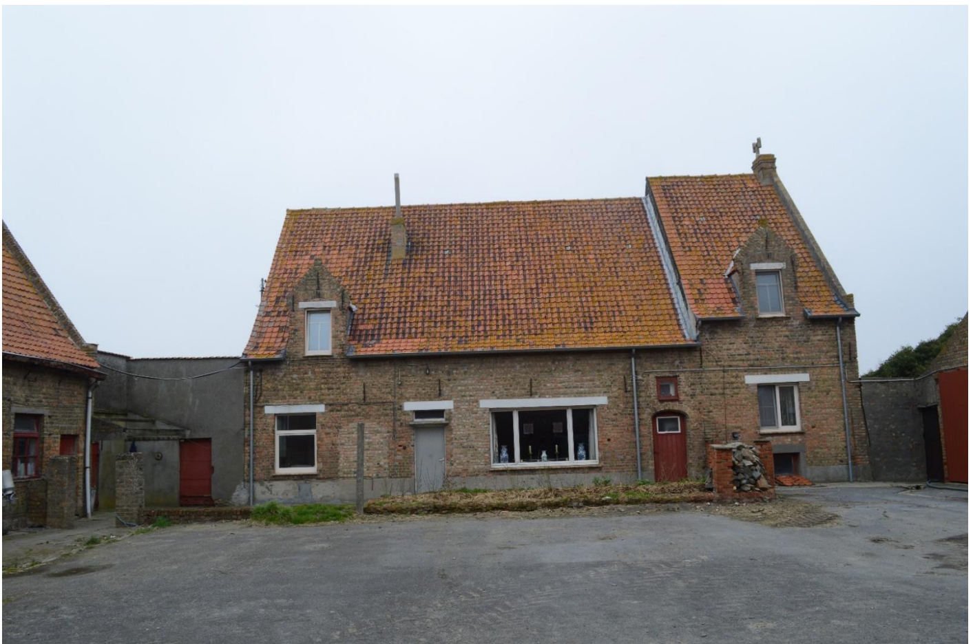
Foto 33. De boerenwoning. Zuidgevel: verbouwd, in het bijzonder door aanpassingen venster- en deuropeningen. Behoud van dakvensters met tuitgevels en aandaken alsook de korfboogvormige toegangsdeur links van de opkamer. Voor de woning hekpijlers en muurrestanten als verwijzing naar voortuintje (12.04.2018).
