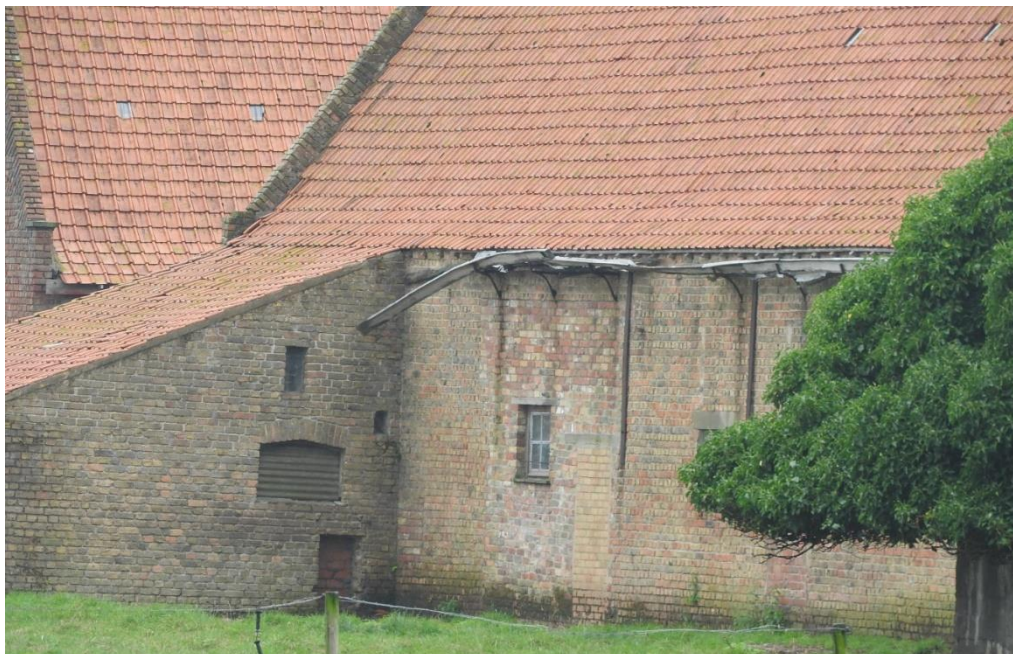
Foto 34. De buitengevel van de dwarsschuur met aanbouw onder lessenaarsdak. Nog deels bewaarde bakgoot op in de muur verankerde ijzeren haken (29.08.2018).
