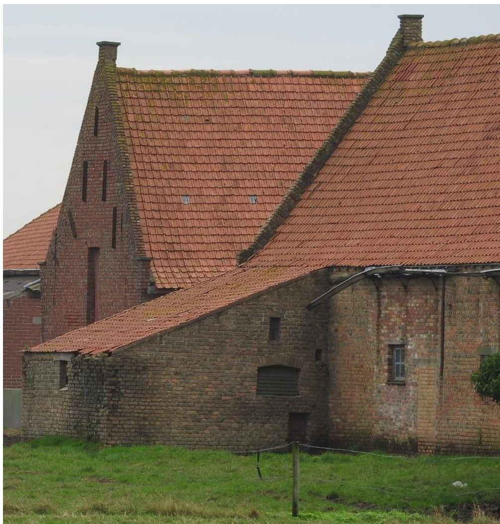
Foto 35. De buitengevel van de dwarsschuur met aanbouw onder lessenaarsdak. Zuidelijke zijtuitgevel met aandaken en schouderstukken (29.08.2018).
