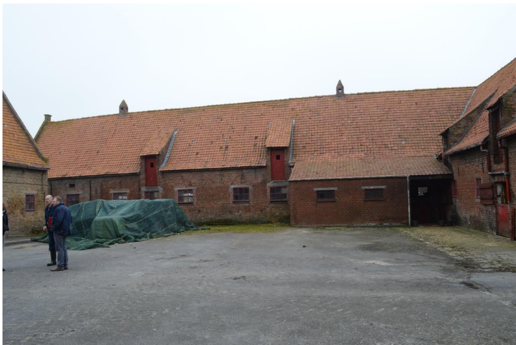
Foto 25. Erfzijde van de zuidvleugel. Nieuwe constructie onder lessenaarsdak tegen de zuidgevel, ter hoogte van de overgang met de westvleugel. De recentere aanbouw onder lessenaarsdak heeft geen erfgoedwaarde (12.04.2018).
