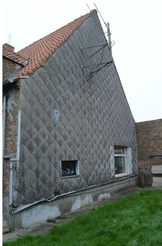
Foto's 26. Boerenwoning. Noordgevel, bedoeld als voorgevel, voorafgegaan door tuintje. Westelijke zijgevel met eternietplaten beslagen (12.04.2018).
