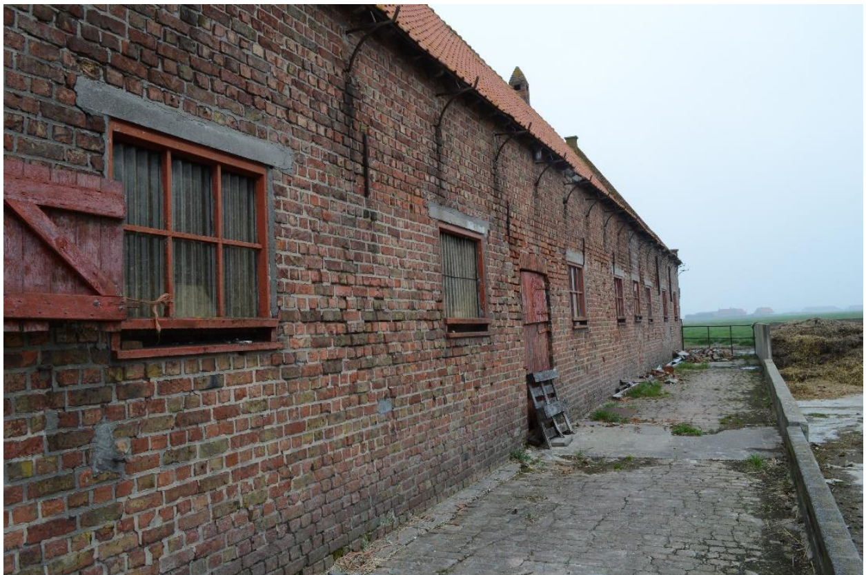
Foto 22. Zicht op de zuidgevel van de zuidvleugel. Betonnen stalvensters (recenter dan wederopbouw). Nog bewaarde metalen bakgootijzers, verankerd in metselwerk. Bakgoot verdwenen (12.04.2018).
