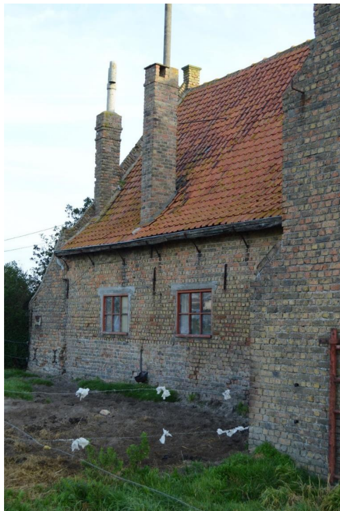
Foto 11. De noordwestzijde van de westvleugel, ten noorden van de toegangspoort. Bewaarde bakgoot op in de muur verankerde ijzeren haken (19.10.2017).
