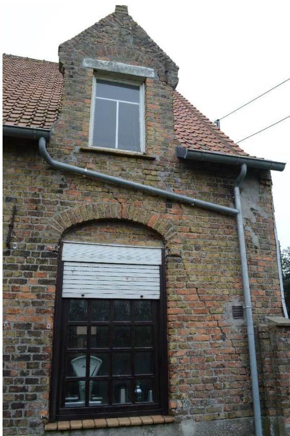
Foto 27. Boerenwoning. Noordgevel rechts: korfboogvormig venster met daarboven een dakvenster met tuitgevel en schouderstukken (12.04.2018).
