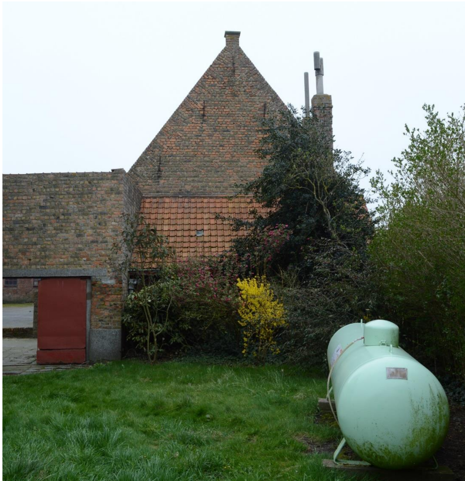
Foto 12. De noordzijde van de westvleugel. Zijtuiggevel met muurvlechtingen. Verbindingsmuur tussen westvleugel en boerenhuis (of noordvleugel) (29.08.2018).
