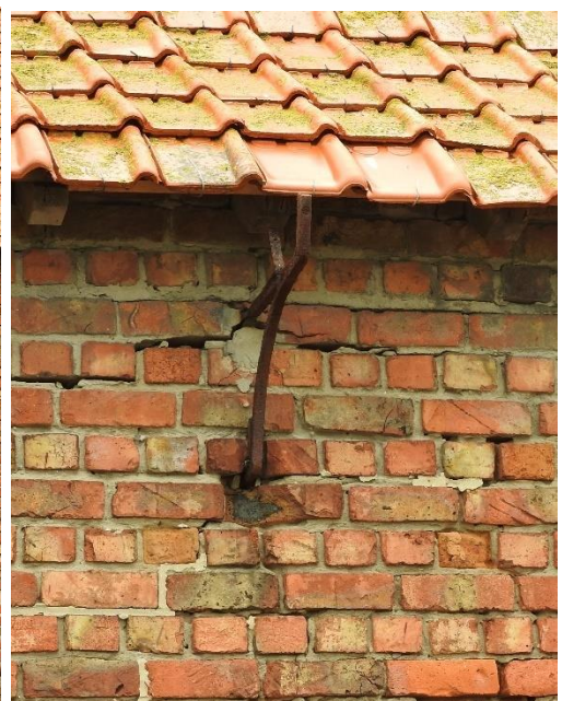
Foto's 15. De zuidwestzijde van de westvleugel, ten zuiden van de toegangspoort. Nog bewaarde bakgootijzers, verankerd in het metselwerk (29.08.2018).
