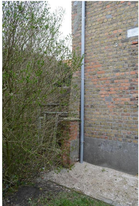
Foto 30. Boerenwoning. Hoek boord- en oostgevel: schuinoplopende steunbeer met hekpijler (12.04.2018).
