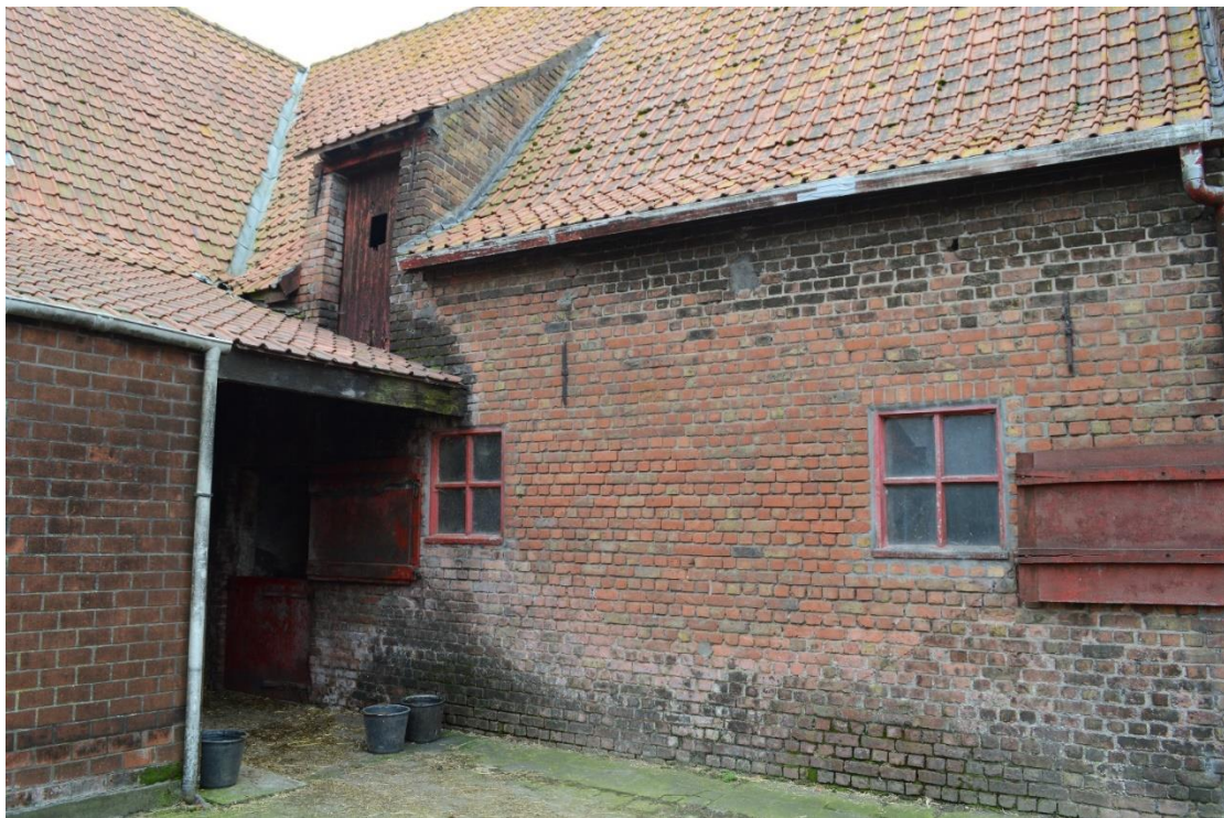
Foto 20. Stal: overgang tussen de west- en de zuidvleugel. Nieuwe constructie tegen de zuidvleugel, onder lessenaarsdak. De recentere aanbouw onder lessenaarsdak heeft geen erfgoedwaarde (12.04.2018).
