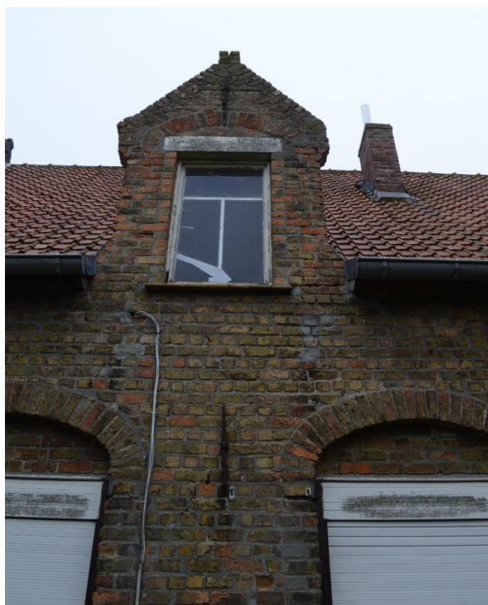
Foto 28. Boerenwoning. Noordgevel: korfboogvormige vensters met boven een tweede dakvenster met tuitgevel en schouderstukken (12.04.2018).
