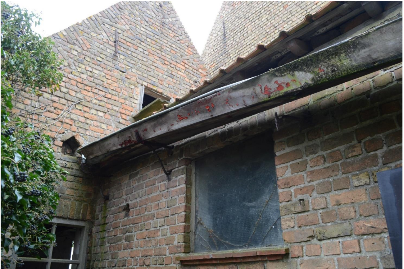
Foto 38. Zijgevel "rijtuigkot", tichelen onderdorpels. Bewaarde bakgoot op in de muur verankerde ijzeren haken (12.04.2018).
