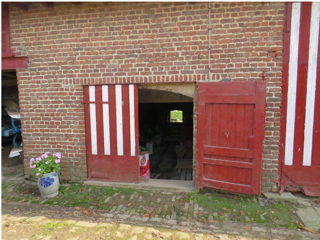
Foto 47: erfgevel van de schuurvleugel – rechthoekige lage poort onder kopse laag (aardappelkelder) – bewaarde poort met kenmerkende rood-witte kleurencombinatie (31.10.2019).
