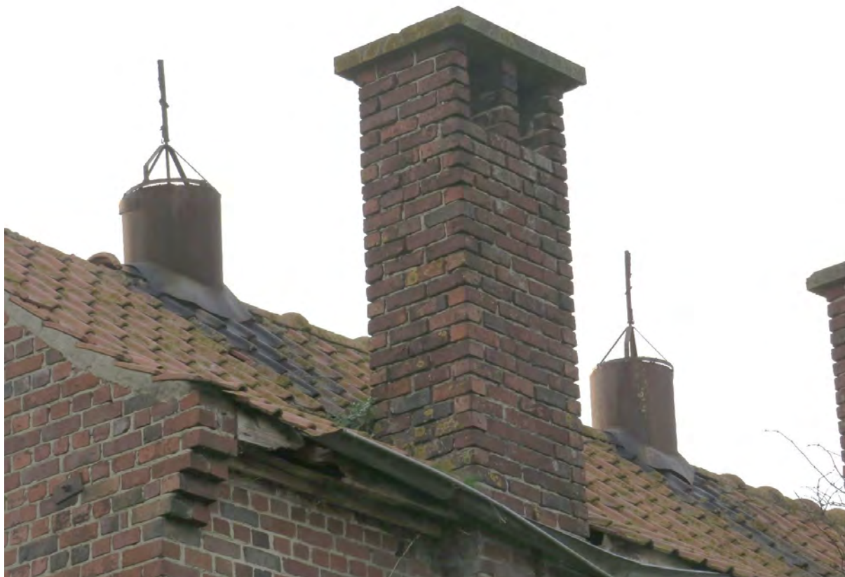
Foto 60: de nok van de hoger opgetrokken tabaksast is voorzien van twee ronde, metalen windschouwen met een vaste eestmuts – bovenkant van één van de uitkragende bakstenen rookkanalen – de bovenkant is tweeledig uitgewerkt en afgedekt met simillistenen plaat – geknikte dakoverstek en getrapt bakstenen schouderstuk (31.10.2019).
