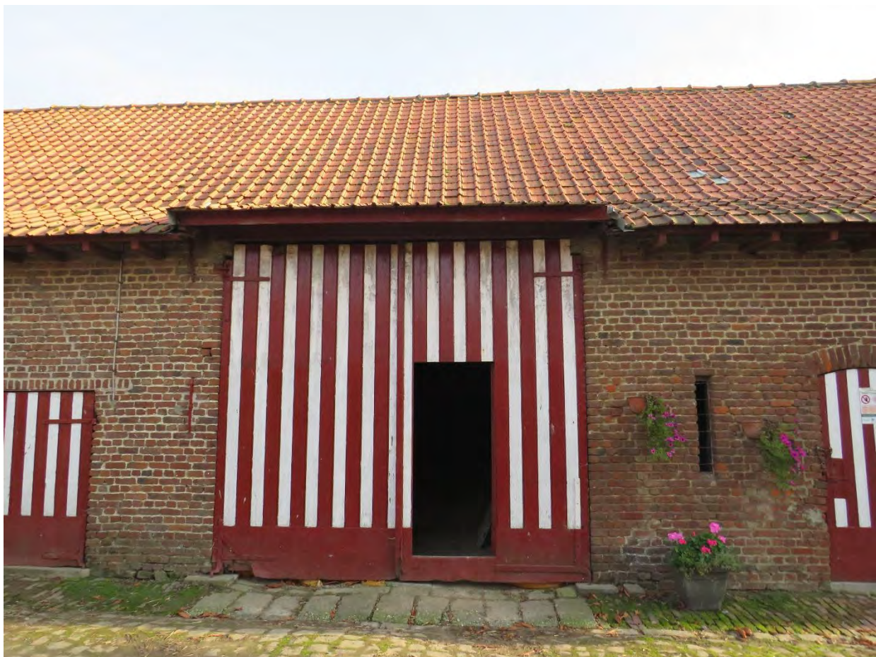
Foto 48: erfgevel van de schuur – hoge poort van de dwarsschuur onder verhoogde dakoverstek – bewaarde schuurpoort met twee vleugels en klinket – kenmerkende rood-witte kleurencombinatie (31.10.2019).
