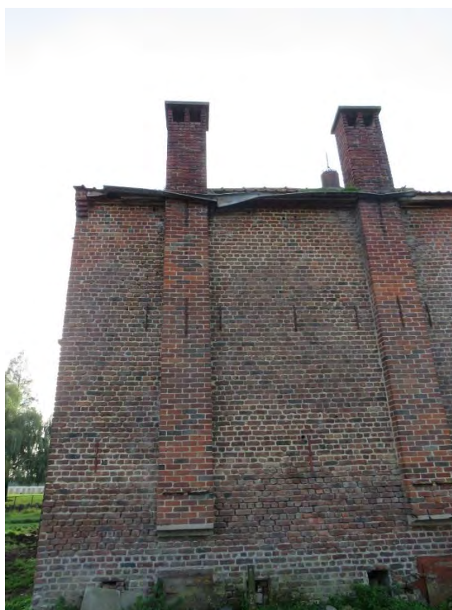
Foto 61: de oostelijke zijgevel (naar de straat gericht) van de hoger opgetrokken tabaksast - twee rookkanalen, uitkragend op betonnen consoles (31.10.2019).
