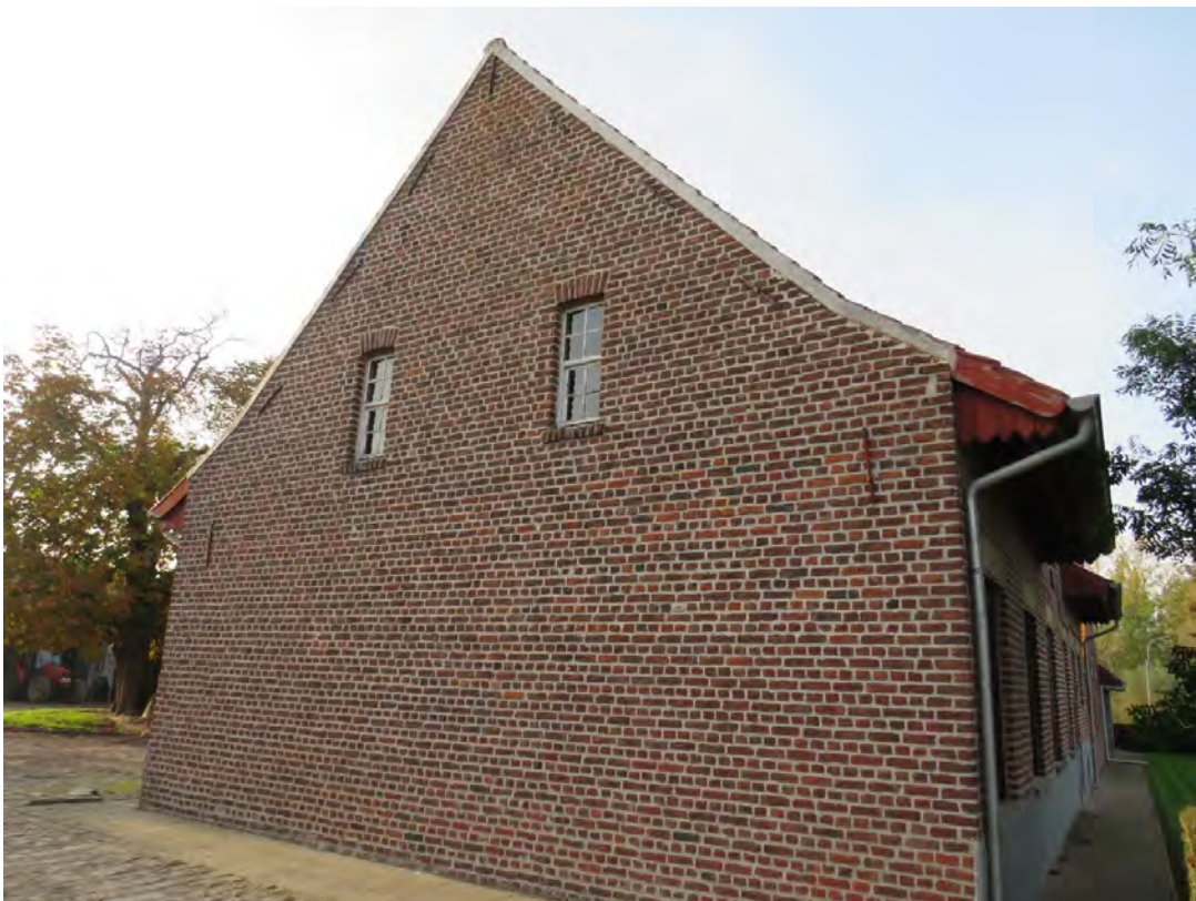
Foto 31: vrijstaande zijgevel van de boerenwoning langs de erfoprit – smalle venstertjes met bewaard houtwerk met kleine roedeverdeling – de uiteinden van de dakoversteken zijn voorzien van een houten beplanking met een gekartelde onderkant (31.10.2019).
