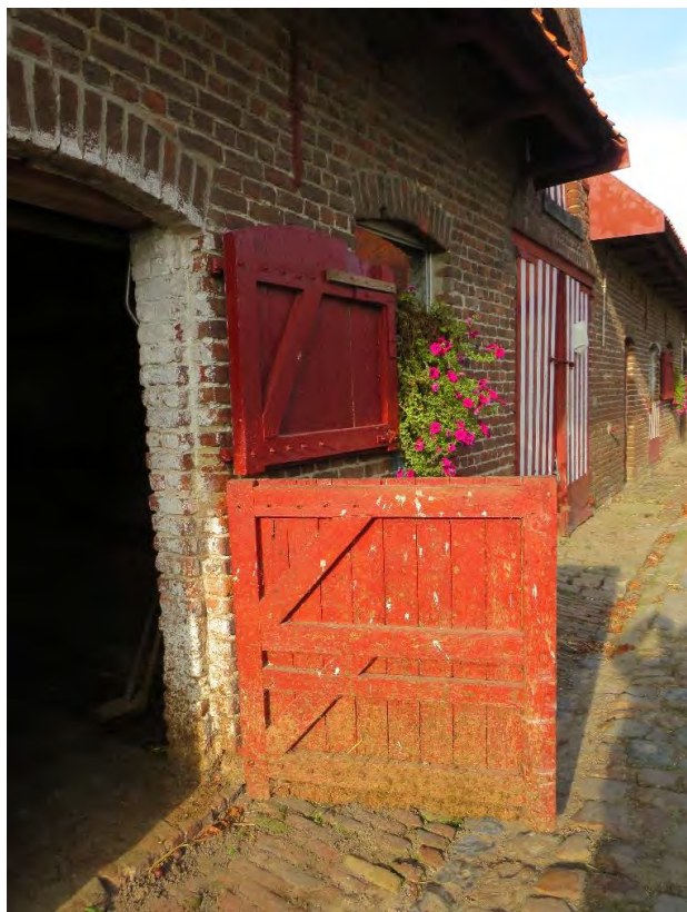
Foto 38: erfgevel van de stalvleugel – tweedelige staldeur van koeststal (ten westen van voederkeuken) - opgeklampt houten kader met houten beplanking – bewaard hang- en sluitwerk (31.10.2019).
