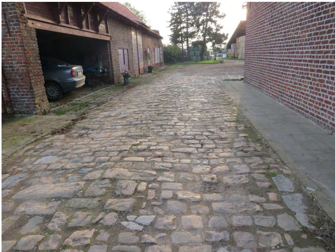
Foto 15: de erfoprit met kasseien en gerecupereerde natuursteen - de kasseien lopen gedeeltelijk door op het erf, zoals voor de erfgevel van de schuur (31.10.2019).
