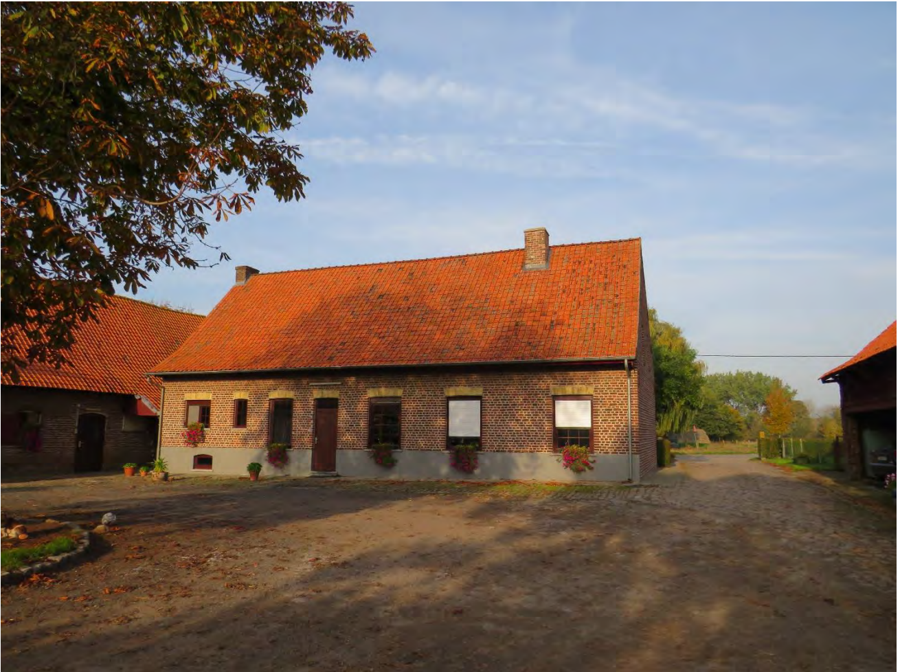
Foto 30: erfgevel van de boerenwoning – beschilderde gecementeerde plint - getoogde muuropeningen onder geelbakstenen strek (vernieuwd houtwerk) (31.10.2019).
