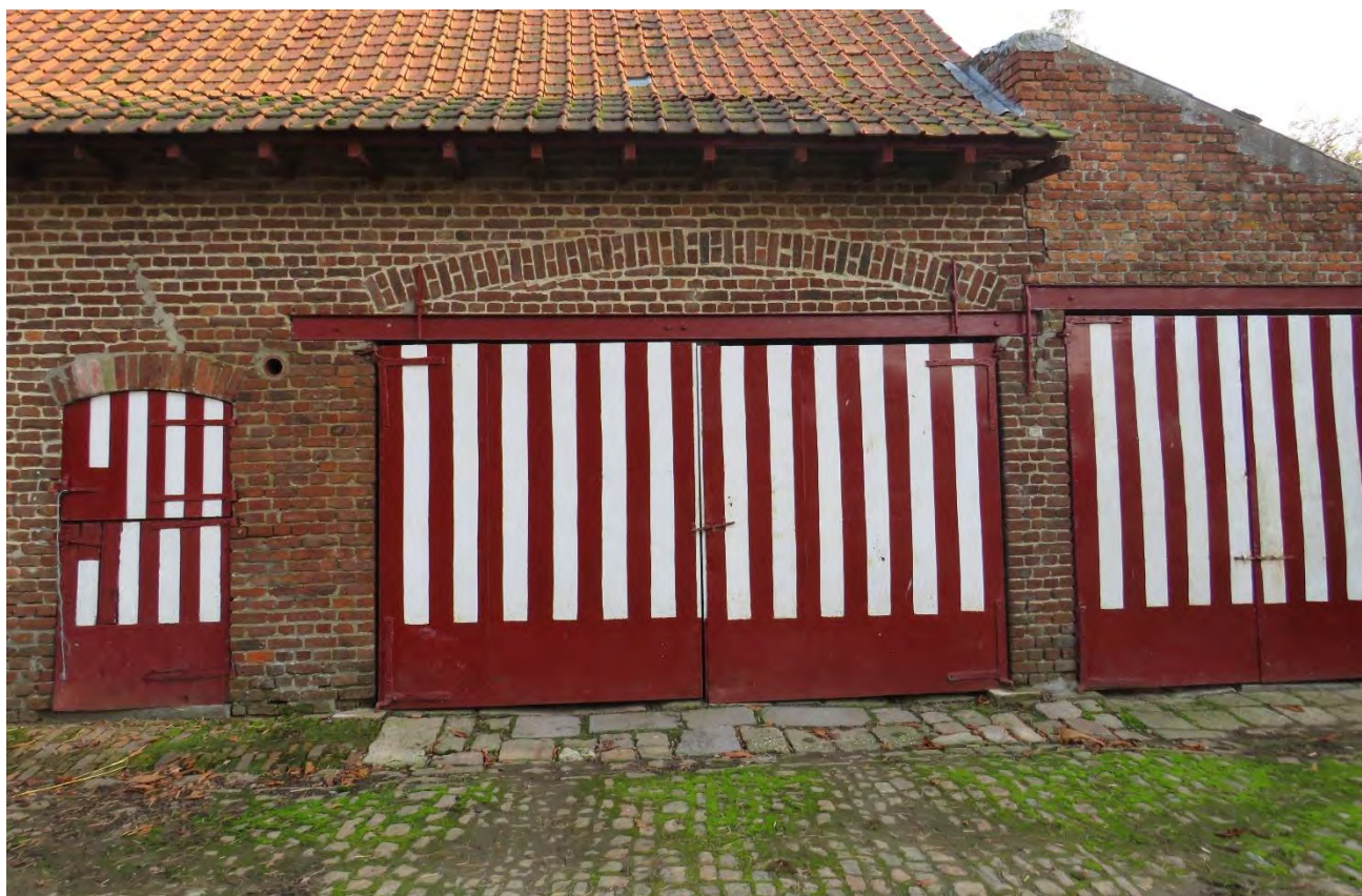
Foto 21: bestrating met bakstenen op hun kant (links) en abrisstenen voor de erfgevel van de schuur. De abrisstenen komen vooral voor ter hoogte van de poorten. Daarvoor is er een gekasseide strook (31.10.2019).
