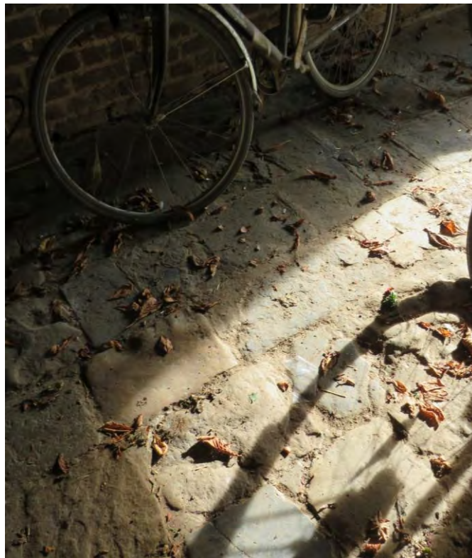
Foto 41: overdekte gang tussen de stalvleugel en de boerenwoning – bestrating van gerecupereerde natuursteen (31.10.2019).
