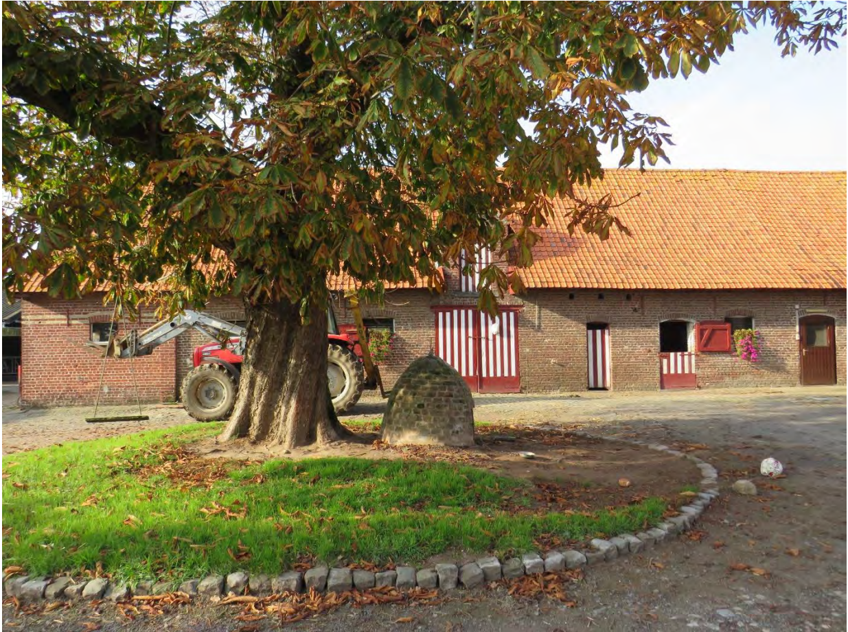
Foto 32: erfgevel van de stalvleugel – de linker (eind)travee is één of twee decennia jonger – getoogde stalvenstertjes en -deuren – poort naar voederkeuken onder metalen I-profiel – houtwerk met kenmerkende rood-witte kleurencombinatie (31.10.2019).
