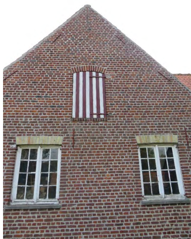
Foto 29: de rechter zijgevel van stalvleugel in de voortuin, in het verlengde van de boerenwoning – twee oorspronkelijke houten ramen met kleine roedeverdeling en het laadluik (kenmerkende rood-witte kleurencombinatie) zijn bewaard (31.10.2019).
