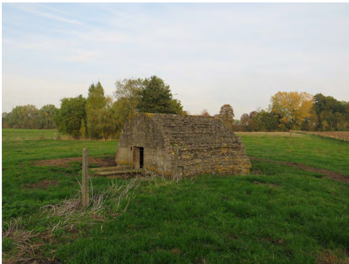
Foto 69: de achtermuur met toegang is naar de straat en de 'Pollepelhoeve' gericht (weg van het front), en is om begrijpelijke redenen veel dunner (31.10.2019).
