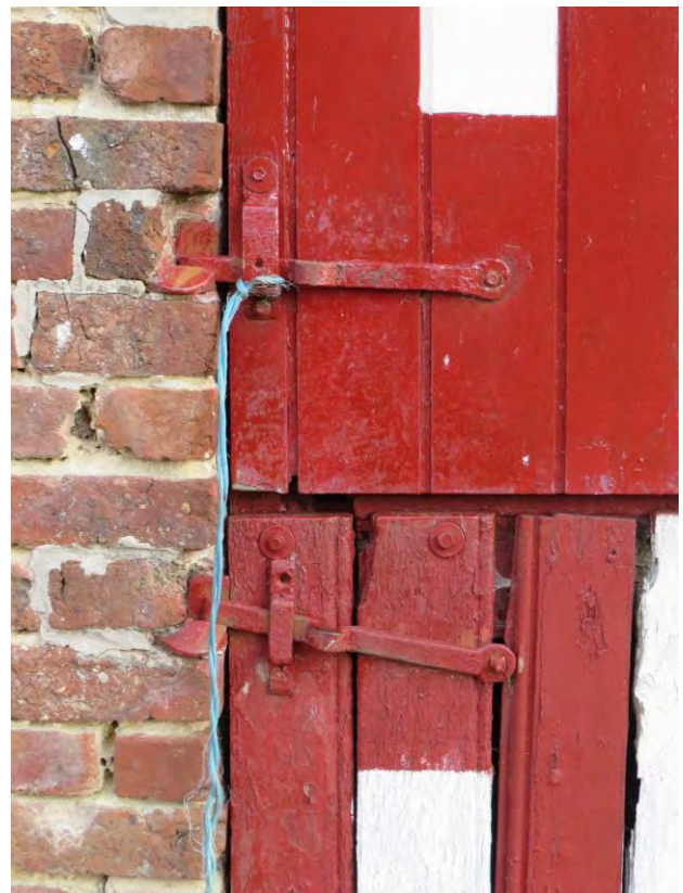
Foto 51: erfgevel van de schuur – tweeledige staldeur met detail hang- en sluitwerk (31.10.2019).
