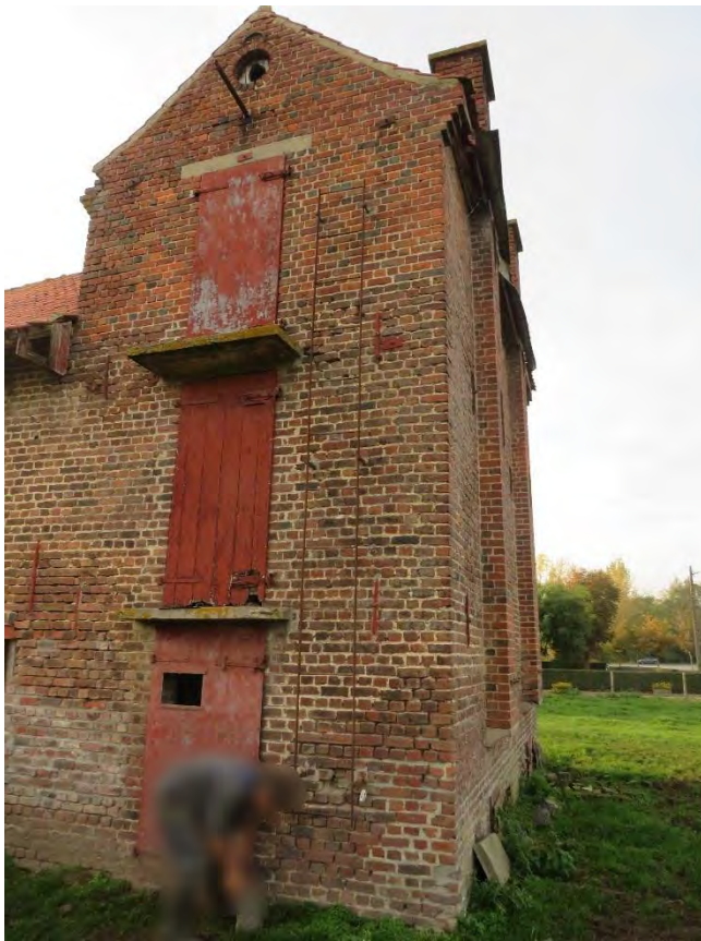
Foto 56: de tabaksast in het oostelijk deel van de ast (naar de straat gericht) – zicht op de zuidgevel (naar de begraafplaats gericht) met de hogere puntgevel – boven elkaar gestelde laaddeuren en -platformen en ijzeren ladder – deels ijzeren deuren, onderaan met kijkluikje (31.10.2019).
