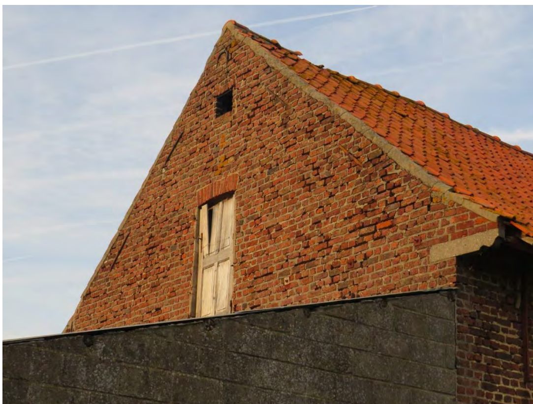
Foto 67: de westelijke zijgevel van de chicorei-ast – laaddeur in het gevelveld met daarboven vierkant tochtgat – geprofileerde betonnen console als afboording van de dakoverstek (31.10.2019).
