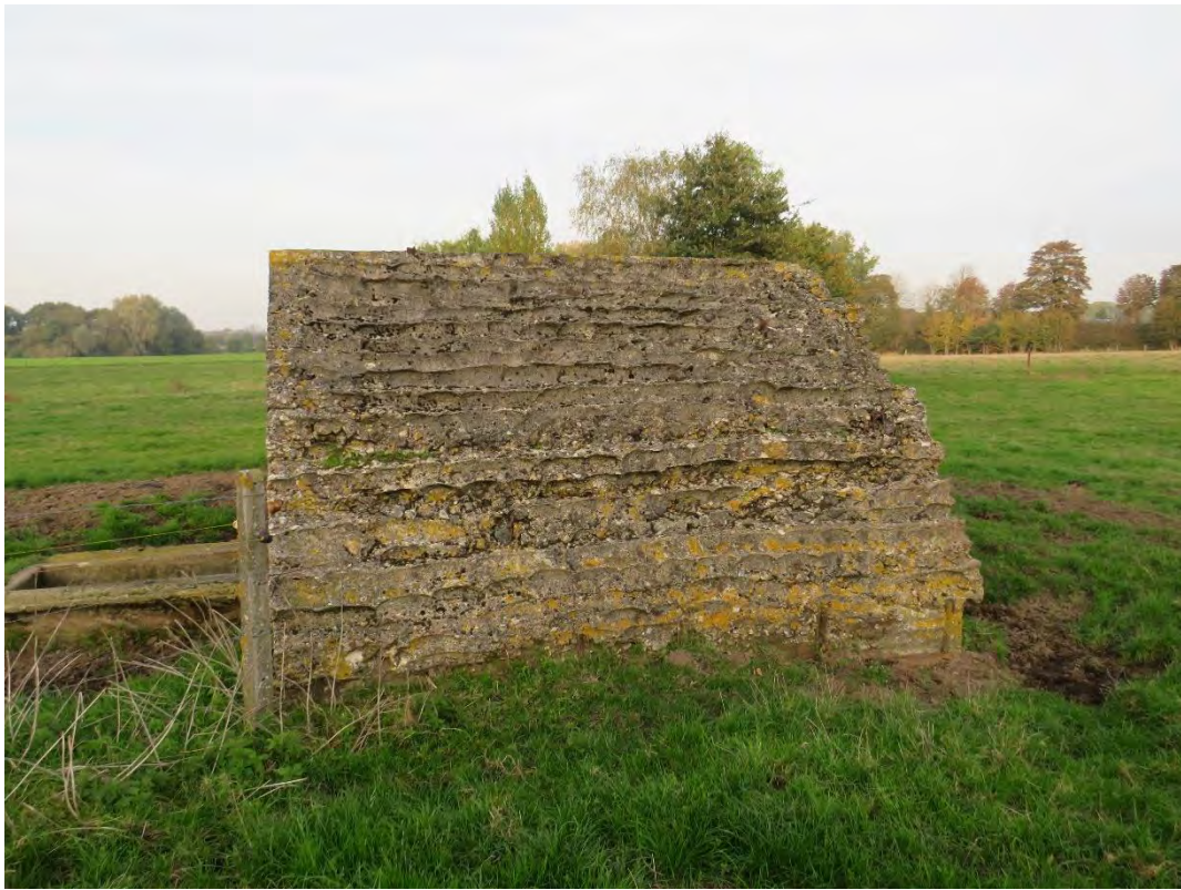
Foto 70: de bunker van gewapend beton werd gegoten tegen zakjes aarde, waarvan de ronde afdrukken in het beton van het cilindervormige dak en de noordoostelijke voormuur achterbleven (31.10.2019).
