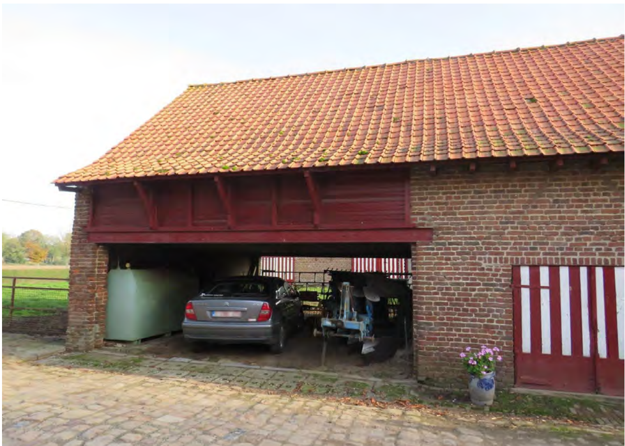
Foto 46: erfgevel van de vleugel – wagenhuis onder metaal I-profiel - daarboven houten vakwerk met plankenbebording en dakoverstek op houten korbelen – kasseien en gerecupereerde natuursteen – abrisstenen voor het wagenhuis (31.10.2019).
