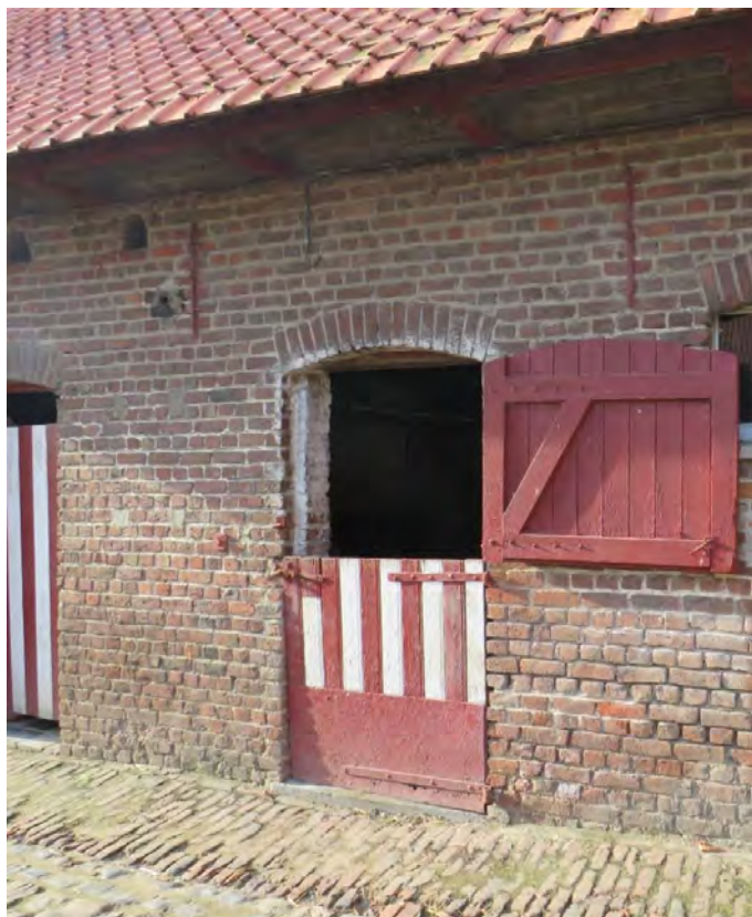
Foto 39: erfgevel van de stalvleugel – tweedelige staldeur van de koeststal (ten oosten van voederkeuken) - opgeklampt houten kader met houten beplanking - bewaard hang- en sluitwerk – trottoir van bakstenen op hun kant (31.10.2019).
