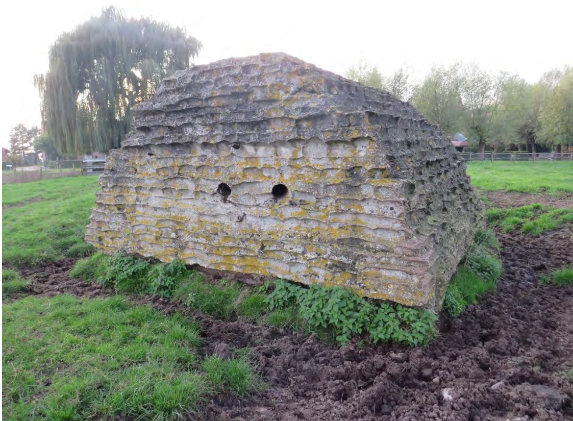
Foto 71: de bunker van gewapend beton werd gegoten tegen zakjes aarde, waarvan de ronde afdrukken in het beton van het cilindervormige dak en de noordoostelijke voormuur achterbleven – voormuur met twee ronde openingen (31.10.2019).
