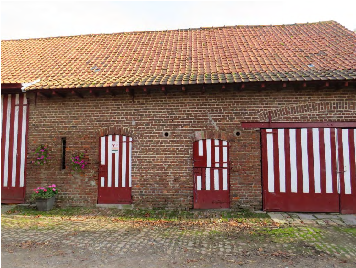
Foto 49: erfgevel van de schuur – verluchtingsgleuf en getoogde deuren – kenmerkende rood-witte kleurencombinatie (31.10.2019).
