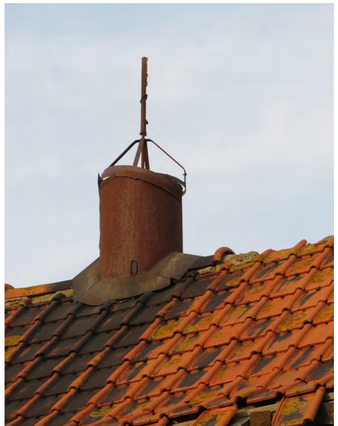
Foto 59: de nok van de hoger opgetrokken tabaksast met ronde, metalen windschouwen met een vaste eestmuts (31.10.2019).
