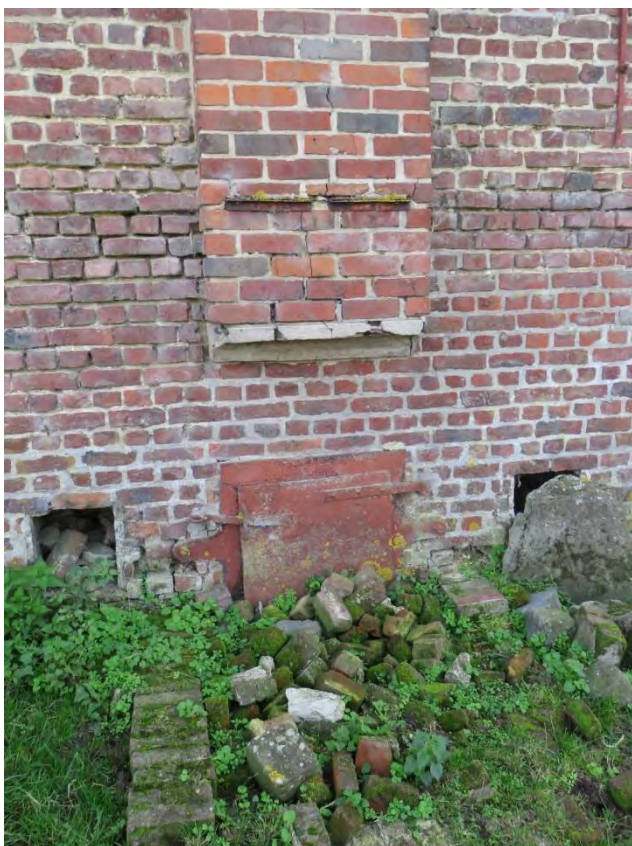
Foto 63: de oostelijke zijgevel (naar de straat gericht) van de tabaksast – rechter ovenmond en erboven uitkragend rookkanaal - restant van de in baksteen gemetselde open putten van waaruit de twee eestovens in de ast van buitenaf werden gestookt (31.10.2019).
