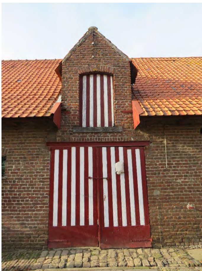
Foto 36: erfgevel van de stalvleugel – poort van voederkeuken onder metalen I-profiel, daarboven dakvenster met laaddeur – kasseien voor de poort (31.10.2019).
