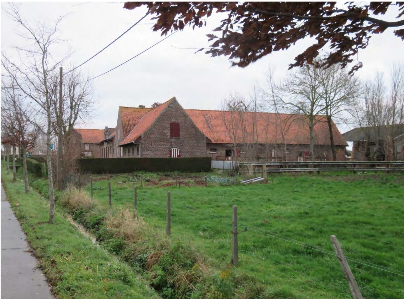
Foto 44: zij- en achtergevel van de stalvleugel op L-vormige plattegrond – varkensstal evenwijdig met de straat – zicht vanaf de Komenseweg, vanuit het noorden (13.12.2019).
