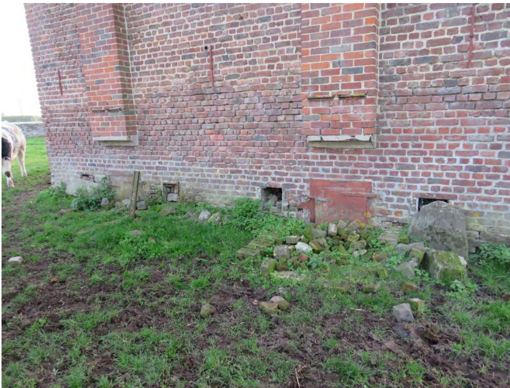
Foto 62: de oostelijke zijgevel (naar de straat gericht) van de tabaksast - ovenmonden met gietijzeren luikjes en dito omkadering met opschrift - erboven twee uitkragende rookkanalen (31.10.2019).
