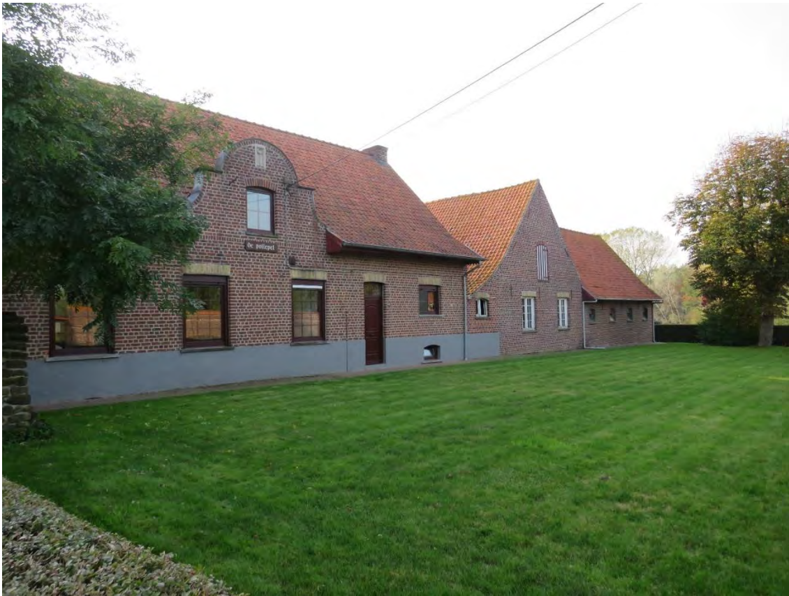
Foto 25: in voortuin gelegen voorgevel van de boerenwoning – beschilderde gecementeerde plint - getoogde muuropeningen onder geelbakstenen strek (vernieuwd houtwerk) - de stalvleugel op L-vormig grondplan in het verlengde (31.10.2019).
