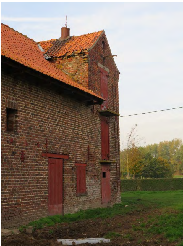
Foto 58: de zuidgevel (naar de begraafplaats gericht) van de ast – links, de cichorei-ast met ventilatievenstertje - midden, de snijkamer met deur en luikje – rechts, de tabaksast met laaddeuren (31.10.2019).
