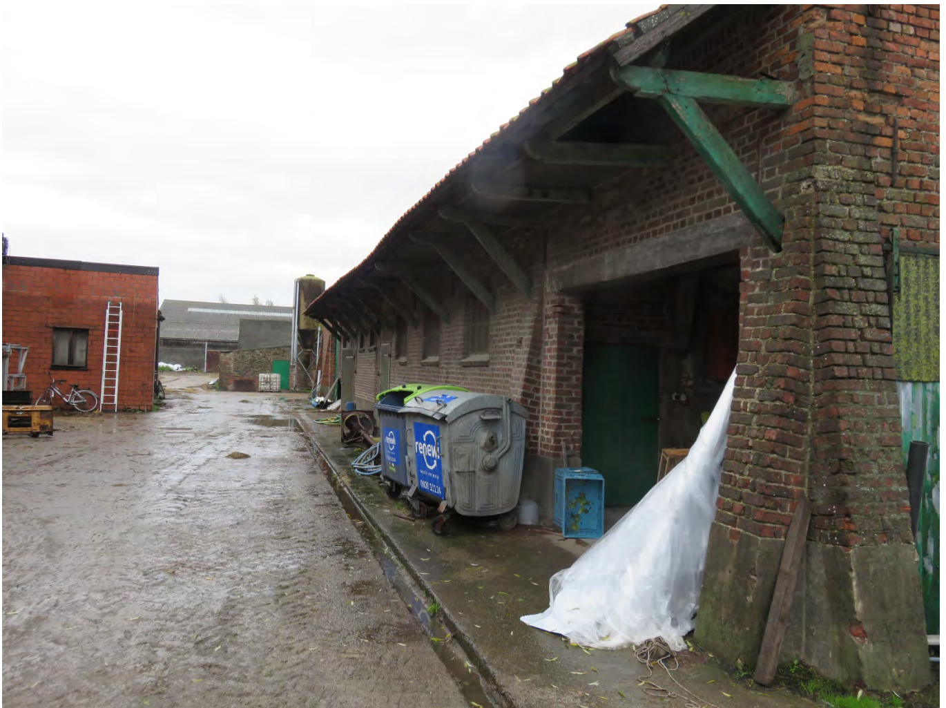
Foto 92: westelijke langsgevel of achtergevel van de stal- en schuurvleugel - brede dakoverstek op houten modillons en korbelen ter hoogte van het stalgedeelte – rechts uitsparing in de gevel met overdekte werkruimte en staldeur – betonnen lateien (14.11.2019).
