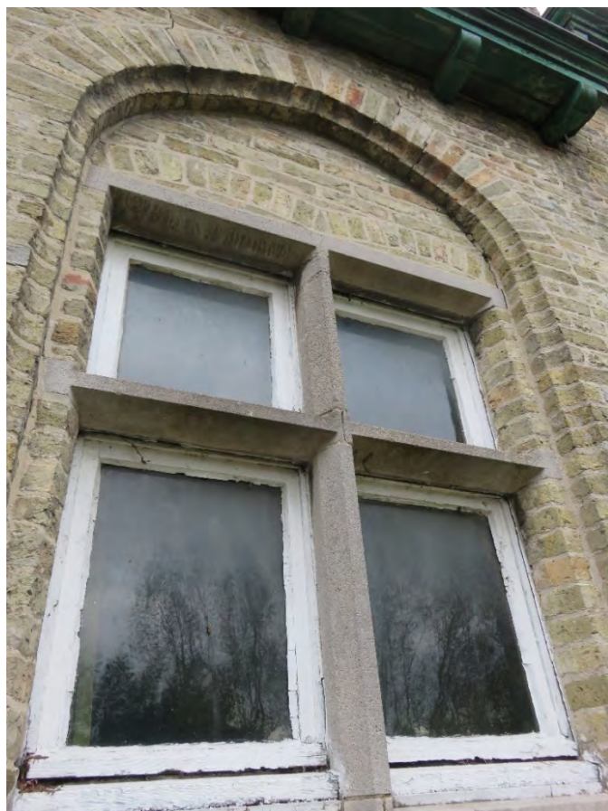
Foto 56: de hogere zuidvleugel met hall (zuidwesten) - zuidelijke langsgevel – rechts van het portaal: stenen kruiskozijn in korfboogomlijsting in profielbaksteen - ingevuld met geschilderd houten raam (14.11.2019).
