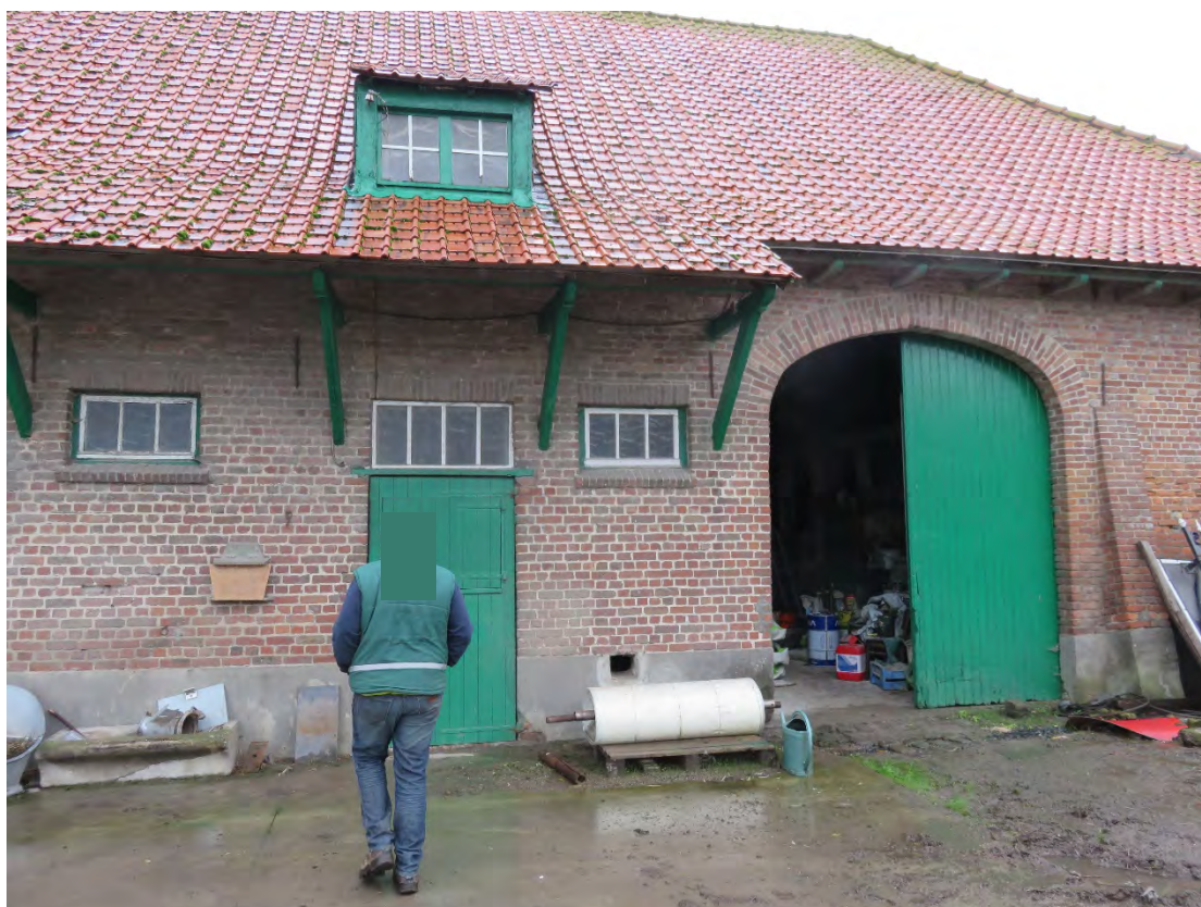
Foto 87: de oostelijke langsgevel of de erfgevel van de stal- en schuurvleugel – cementering - brede dakoverstek en dakvenster onder sleepdak boven de staldeur - rechts korfbogige schuurpoort – overgang naar smalle dakoverstek op houten modillons ter hoogte van schuurpoort (14.11.2019).
