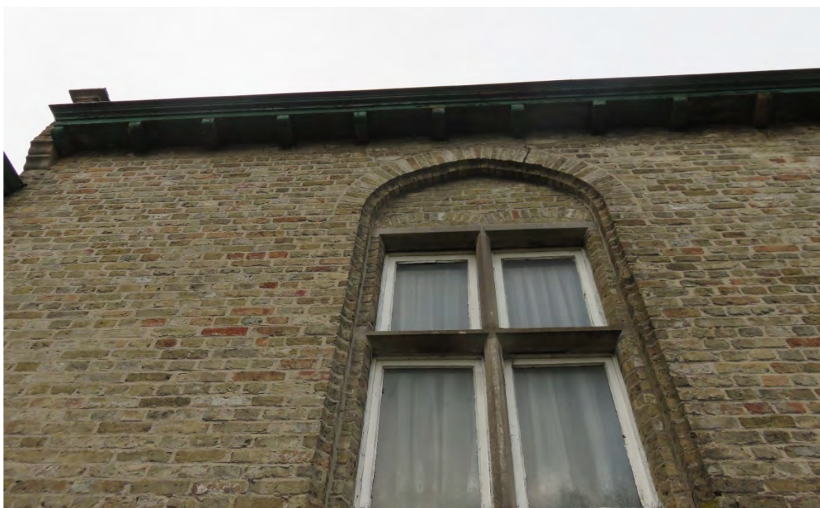
Foto 60: zuidelijke langsgevel van de hogere woon- of voutekamer- opkamervenster: stenen kruiskozijn in korbboogomlijsting in profielbaksteen - ingevuld met geschilderd houten raam (14.11.2019).
