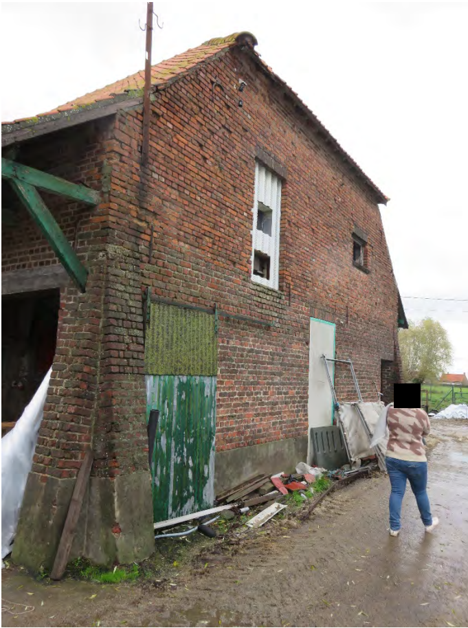
Foto 89: linker of zuidelijke zijgevel met wolfseind – centraal, rechthoekige deur onder strek (14.11.2019).
