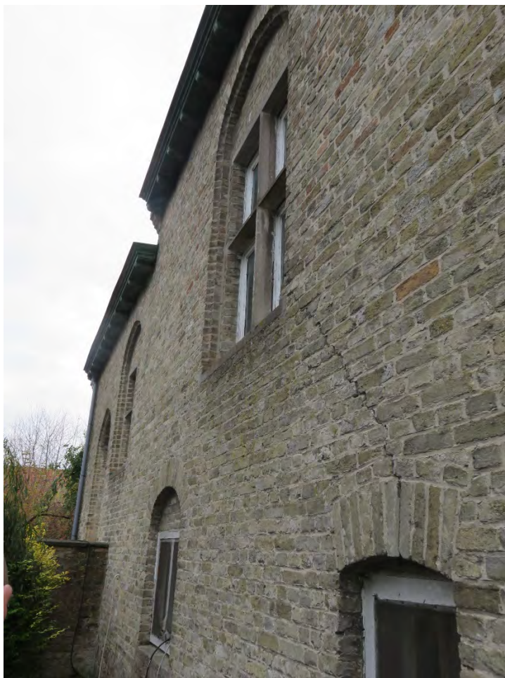
Foto 59: zuidelijke langsgevel van de hogere woon- of voutekamer- kelder met twee keldervensters en voutekamer met stenen kruiskozijn (14.11.2019).
