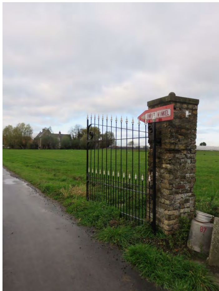
Foto 4: algemeen beeld van de hoeve vanaf de Oostendestraat – erfpijler, erfoprit, weide rechts van de dreef, het omwalde landhuis en de imposante stal- en schuurvleugel in de verte (14.11.2019).
