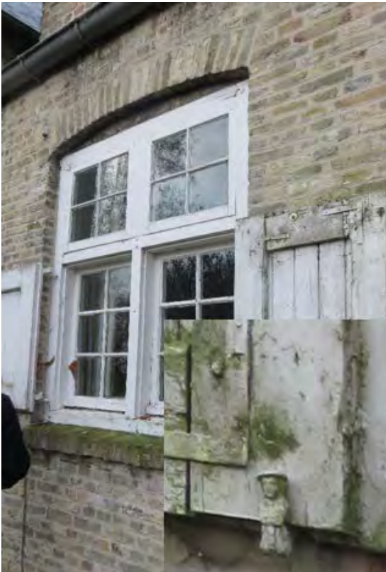
Foto 71: oostelijke langsgevel van de keuken - houten kruiskozijn met kleine roedeverdeling en beluikte benedenvakken – inzet: detail gietijzeren luikvasthouder met mannetje met baret (14.11.2019).
