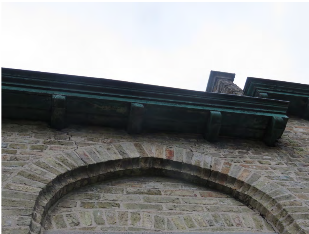
Foto 57: overgang tussen de zuidelijke langsgevels van de hall en de hogere woon- of voutekamer– de houten gootlijsten op modillons volgen de hoogte van de gevels – de geprofileerde korfboognis boven het kruisvenster van de hall (14.11.2019).
