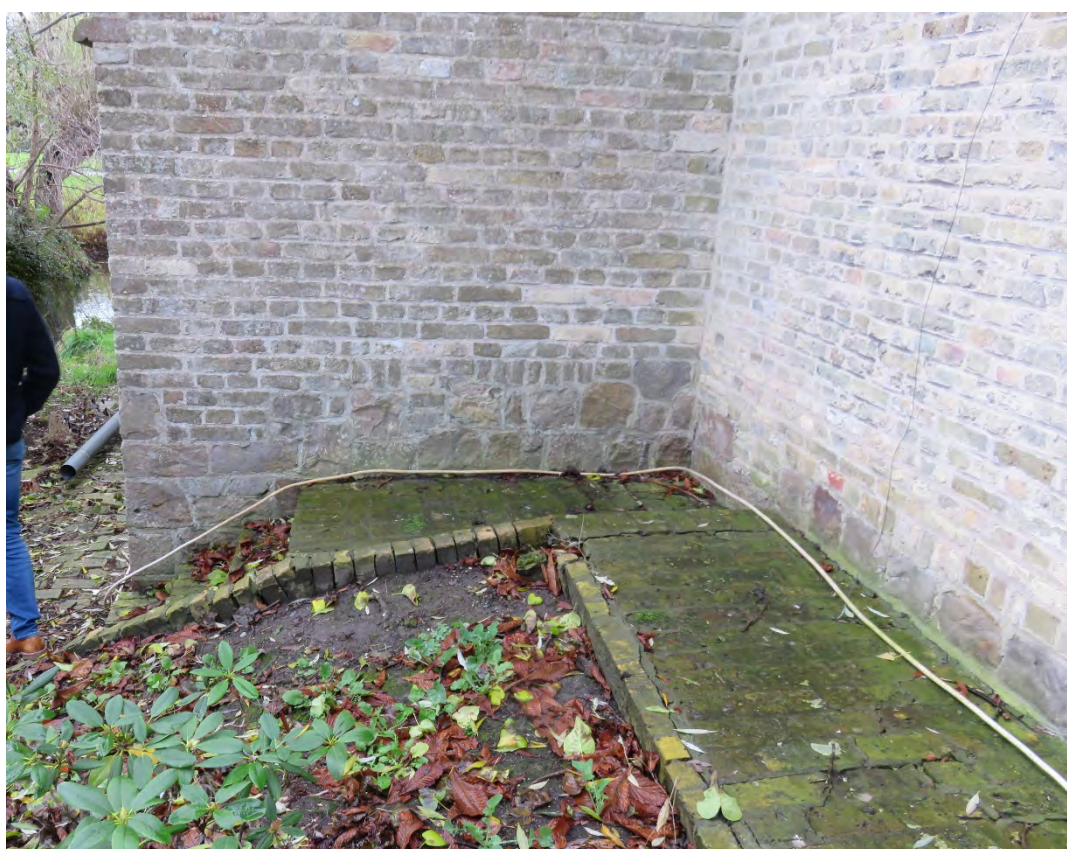
Foto 70: korte noordelijke langsgevel van de hogere woon- of voutekamer- plint in Artesische zandsteen – omlopend bakstenen pad en dito trapje – overgang naar oostelijke langsgevel van keuken (14.11.2019).
