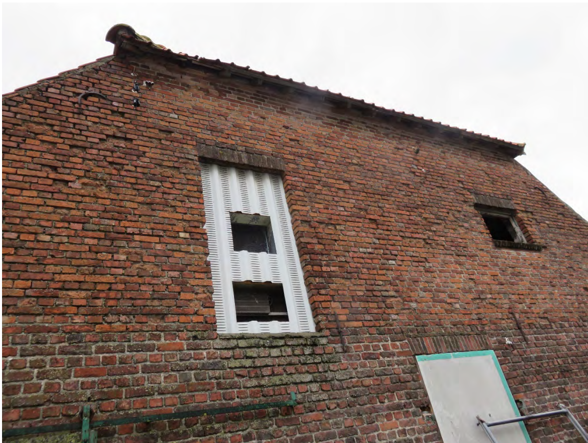
Foto 91: linker of zuidelijke zijgevel met wolfseind – rechthoekige muuropeningen onder strek (14.11.2019).
