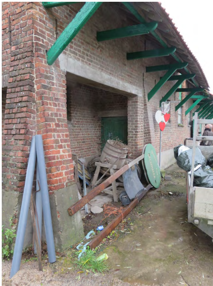
Foto 81: de oostelijke langsgevel of de erfgevel van de stal- en schuurvleugel – brede dakoverstek met houten modillons en korbelen ter hoogte van het stalgedeelte – links uitsparing in de gevel met overdekte werkruimte – overhoeks geplaatste steunberen – omlopende cementering langs de gevels van de schuur (14.11.2019).
