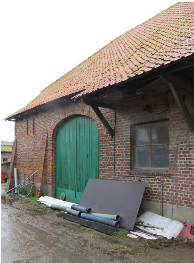
Foto 94: achtergevel met korbogige schuurpoort - bewaarde poort met twee vleugels - overgang naar smalle dakoverstek op houten modillons bij schuurgedeelte - steunberen en verticale verluchtingsgleuven onder en boven - vernieuwde invulling raam zonder erfgoedwaarde (14.11.2019).
