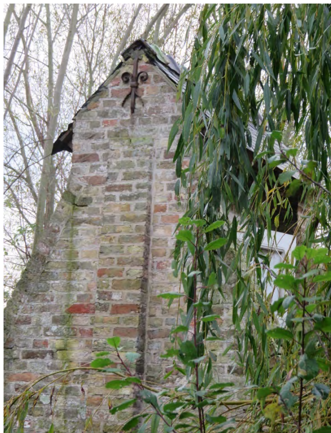
Foto 34: omwalling (zuidzijde) – zijkant van de toegangspoort (boven het water) – uitkragende liseen, steunberen, puntgevel en muuranker - zicht vanaf oostzijde (14.11.2019).
