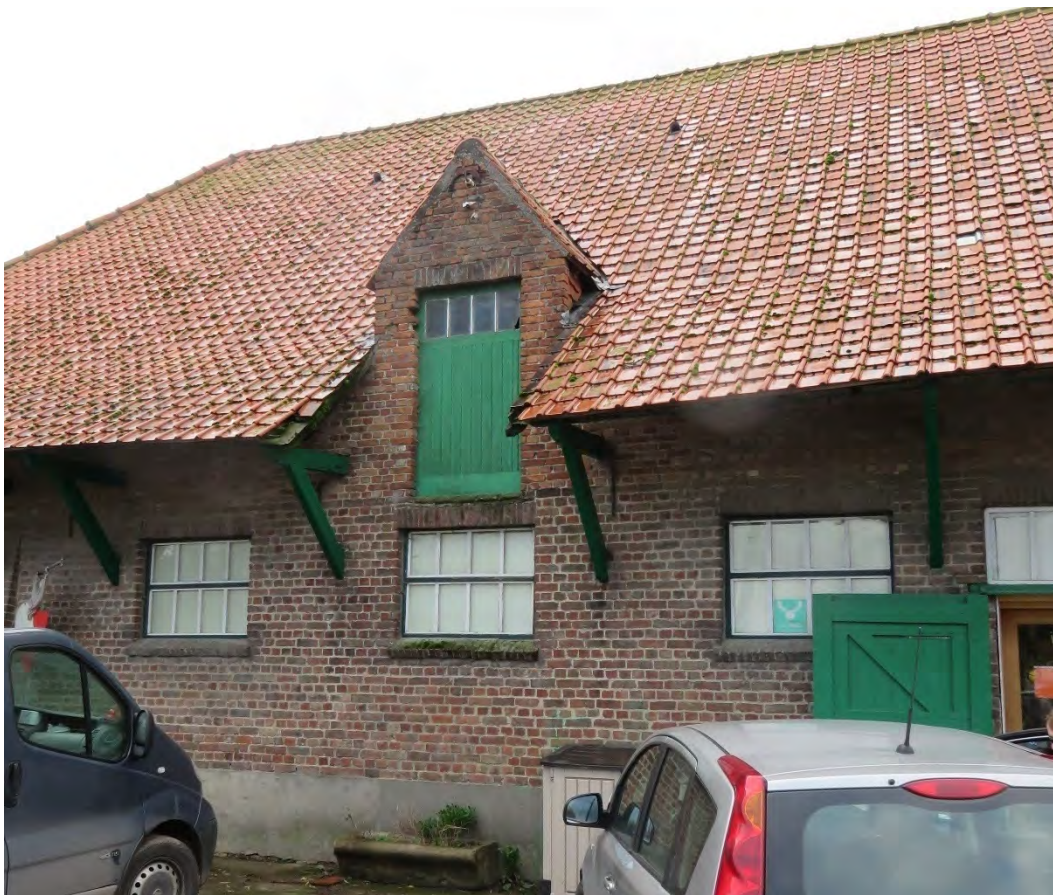
Foto 84: de oostelijke langsgevel of de erfgevel van de stal- en schuurvleugel – rechthoekige stalvensters onder bakstenen strek en op dito afzaat – houtwerk deels vernieuwd naar oud model - dakvenster (laaddeur) met puntgevel (14.11.2019).
