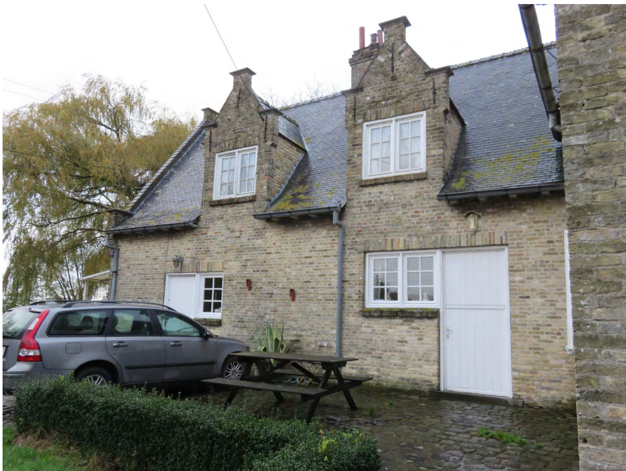
Foto 41: het omwalde landhuis - noordvleugel met kook- & bakplaats en keuken – westelijke langsgevel - twee dakvensters met tuitgevel en vlechtingen. Dakoverstek op modillons (14.11.2019).
