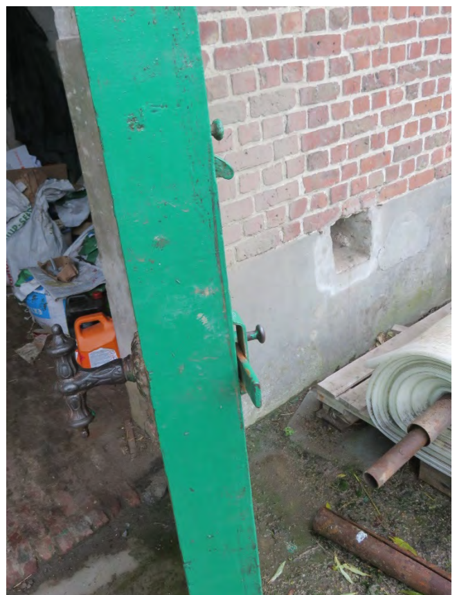
Foto 86: de oostelijke langsgevel of de erfgevel van de stal- en schuurvleugel – opgeklampte staldeuren met bewaard ijzeren hang en sluitwerk (14.11.2019).
