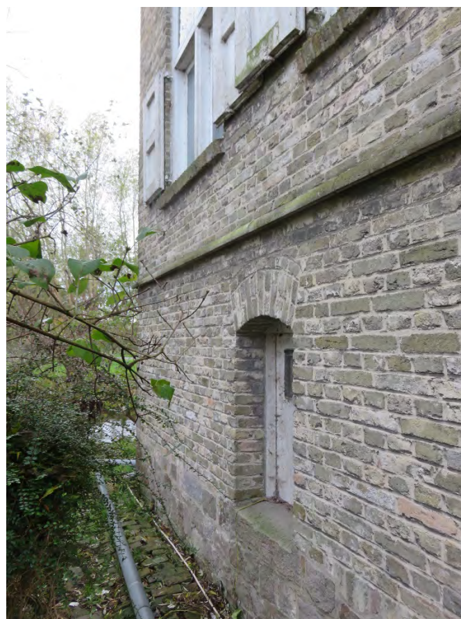
Foto 68: oostelijke zijgevel van de hogere woon- of voutekamer- getoogd keldervenster met houten luik – stenen waterlijst boven het keldervenster- plint in Artesische zandsteen (14.11.2019).
