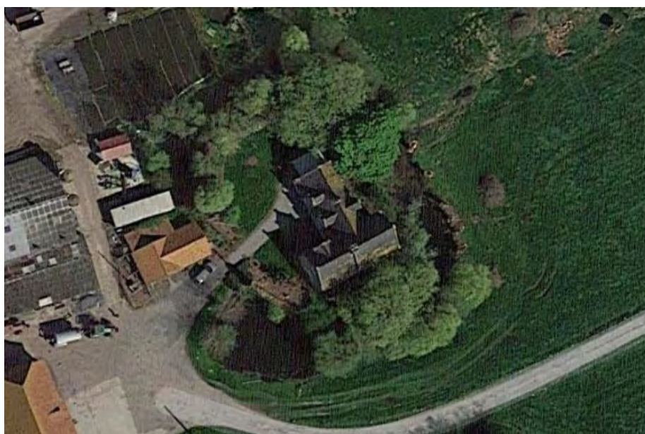
Foto 38: luchtfoto van het landhuis (google maps).
