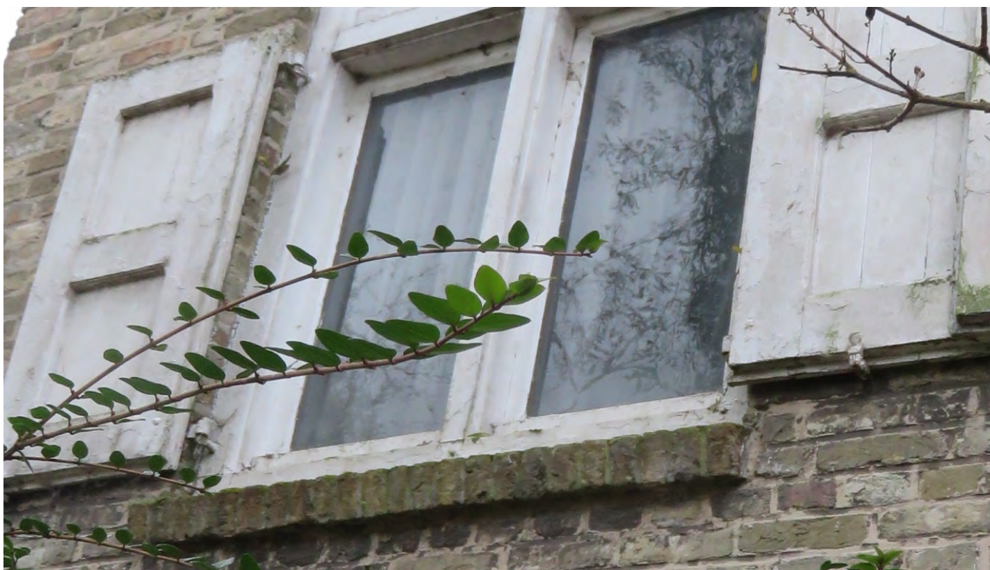
Foto 66: oostelijke zijgevel van de hogere woon- of voutekamer– houten kruiskozijsen op bakstenen afzaat – bewaarde luiken van voutekamer- ijzeren luikduimen (in het kozijn) en gietijzeren luikvasthouders met 'mannetje' (14.11.2019).
