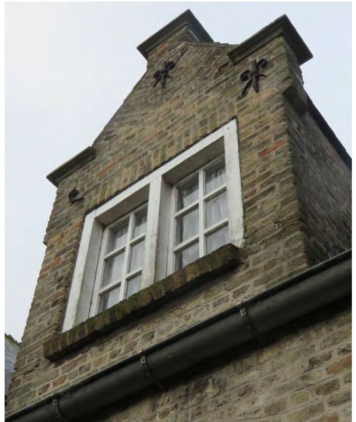
Foto 72: oostelijke langsgevel van de keuken – dakvenster met tuitgevel, aandaken en vlechtingen sierlijke muurankers - houten bolkozijn met kleine roedeverdeling (14.11.2019).
