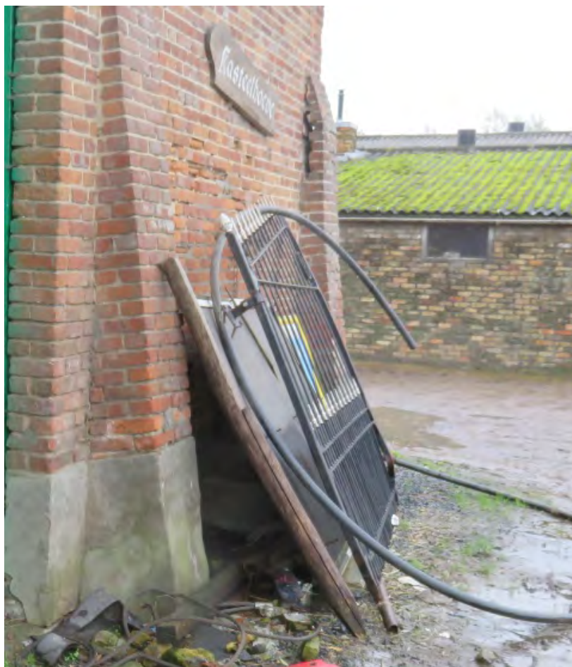
Foto 7: ook de tweede vleugel van het gietijzeren vleugelhek (tussen de bakstenen hekpijlers aan de straatzijde) is bewaard op de hoevesite (14.11.2019).
