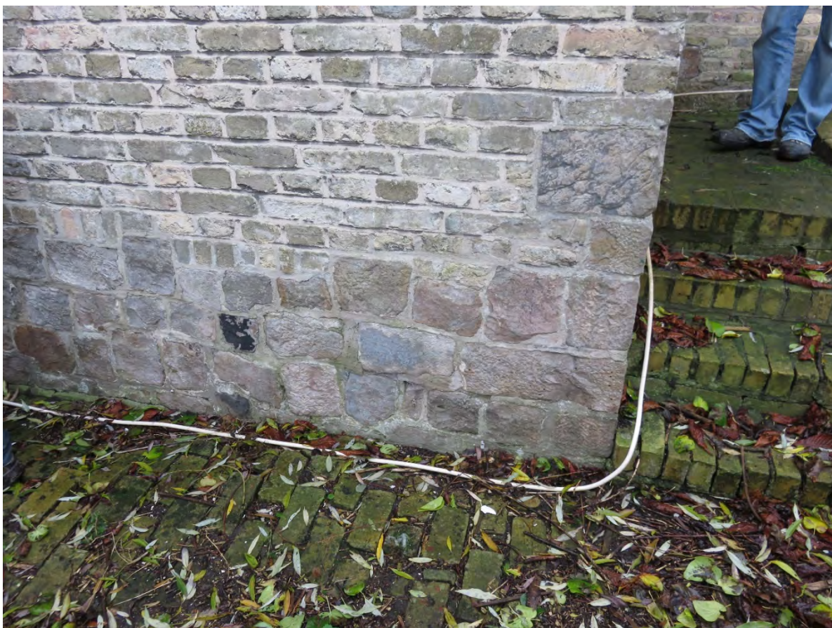
Foto 69: oostelijke zijgevel van de hogere woon- of voutekamer- plint in Artesische zandsteen – dito hoeksteen op hoek met de korte noordelijke langsgevel - omlopend bakstenen pad en dito trapje (14.11.2019).
