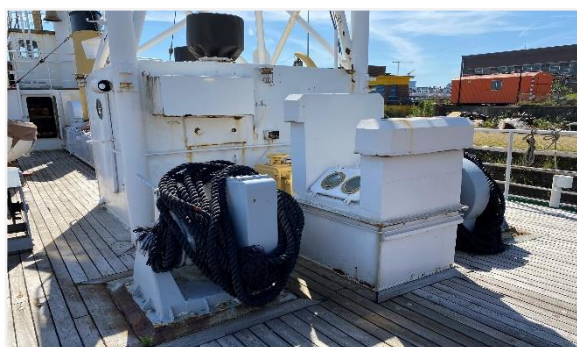
Foto 16: achterschip met bovenlichten baterijruimte tussendeck
