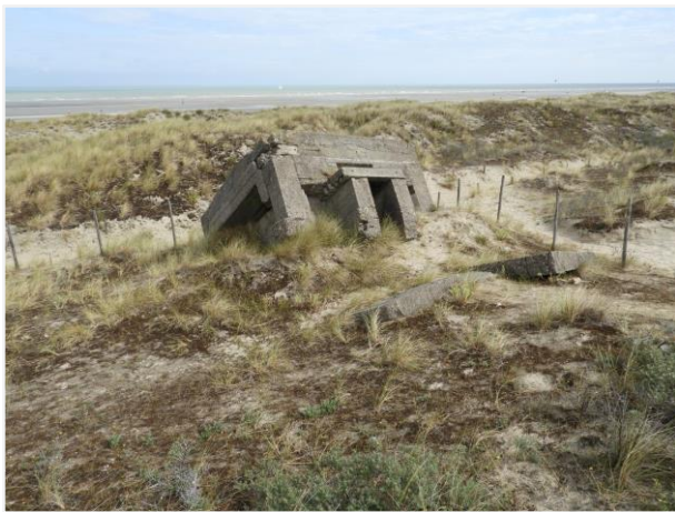
Foto 25: Mitrailleurpost type VF 3, nummer 6. Zicht op zuidelijke en westelijke zijde en vlakbij liggende betonnen stukken (nummer 54). Foto genomen op 5 augustus 2019.
