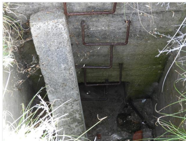
Foto 52: Bunker nummer 17, type VF 2a. Zicht op de klimijzers en de toegang onderaan in de nooduitgang. Foto genomen op 5 augustus 2019.
