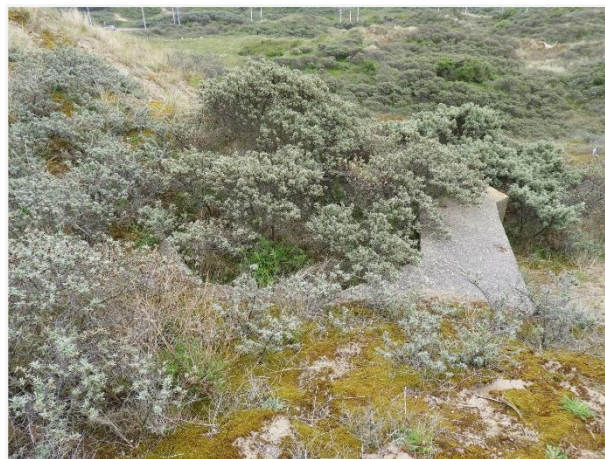
Foto 72: Open bedding voor 5cm KwK met aanpalende bakstenen post (nummer 25). Foto genomen op 20 mei 2019.
