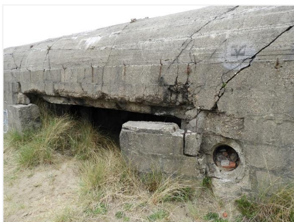
Foto 12: Bunker nummer 1, type 612. Brede toegang aan achterzijde met ernaast een ronde opening voor buis. Foto genomen op 20 mei 2019.
