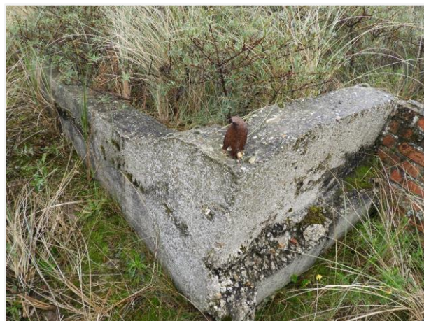
Foto 70: Symmetrisch opgebouwde constructie (nummer 59). IJzer op een hoek van betonnen muren. Foto genomen op 7 oktober 2019.
