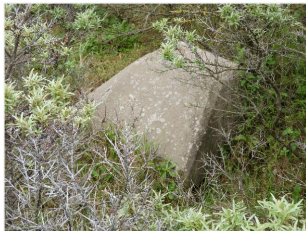
Foto 116: Dak van betonnen wachtpost (nummer 38). De voorzijde is min of meer vlak, terwijl de andere zijden van het dak schuin zijn afgewerkt. Foto genomen op 6 augustus 2019.
