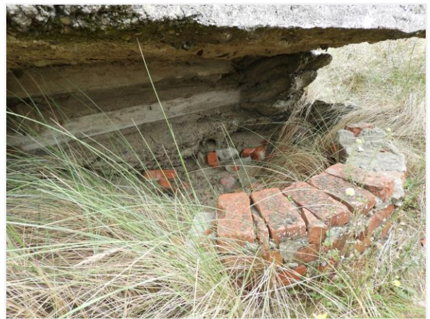
Foto 38: Gebogen bakstenen muurtje onder de voorzijde van Tobruk nummer 10. Foto genomen op 5 augustus 2019.
