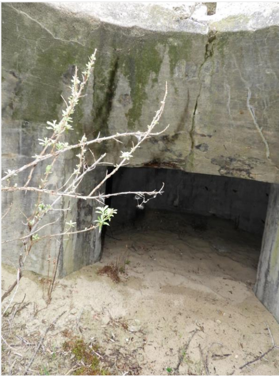
Foto 43: Tobruk nummer 13, in de achthoekige ruimte, met zicht op de toegang tot de rechthoekige binnenruimte. Foto genomen op 20 mei 2019.
