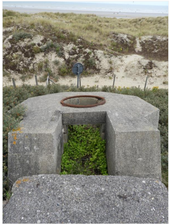
Foto 44: Ringstand voor tankkoepel (nummer 16). Zicht op de toegang aan de achterzijde. Foto genomen op 5 augustus 2019.
