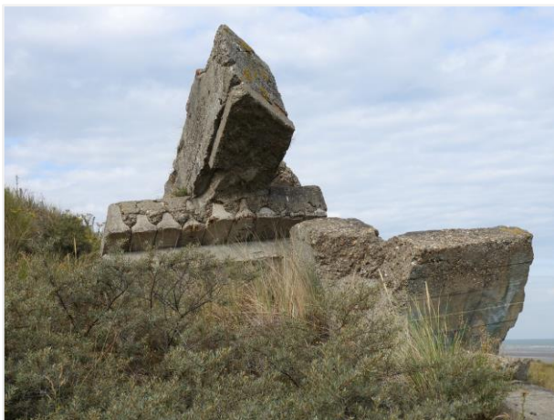
Foto 21: Restanten van de mitrailleurpost type VF 3 (nummer 5). De Hoyerbalken in het dak zijn duidelijk zichtbaar. Foto genomen op 5 augustus 2019.
