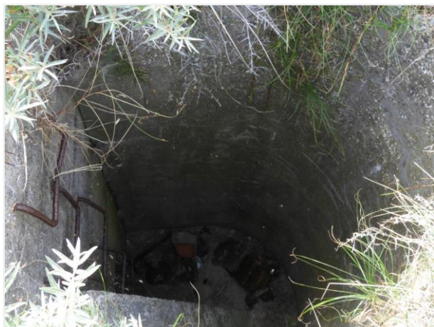
Foto 51: Bunker nummer 17, type VF 2a. Zicht op de half cilindervormige nooduitgang met klimijzers. Foto genomen op 5 augustus 2019.
