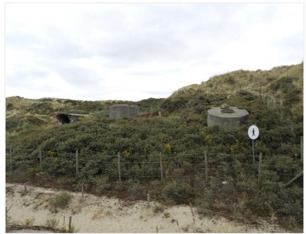
Foto 46: Zicht op de Ringstand voor tankkoepel (nummer 16) (rechts), met links ervan de Tobruk (nummer 10) en de betonnen loopgraaf (nummer 53). Foto genomen op 5 augustus 2019.
