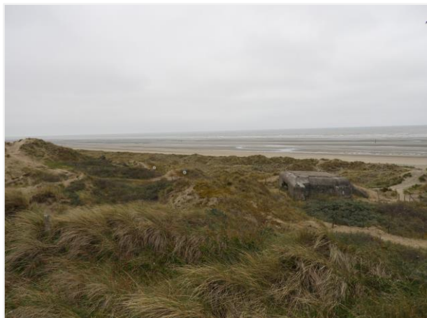
Foto 1: Oostelijke zone van de site met de bunker type 612 (nummer 1). In de achtergrond zijn de ruïnes van de VF 3 (nummer 5) zichtbaar. Foto genomen op 20 mei 2019.
