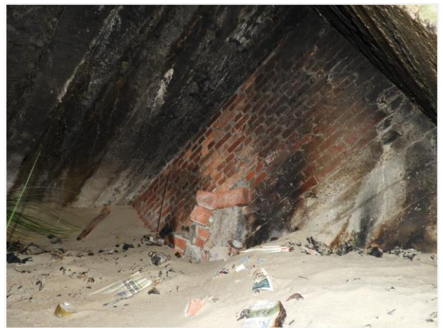
Foto 26: Mitrailleurpost type VF 3, nummer 6. Binnenkant. Foto genomen op 7 oktober 2019.
