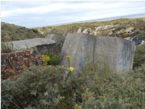
Foto 45: Ringstand voor tankkoepel (nummer 16) met aanpalende bakstenen loopgraaf met betonnen dak. Foto genomen op 5 augustus 2019.
