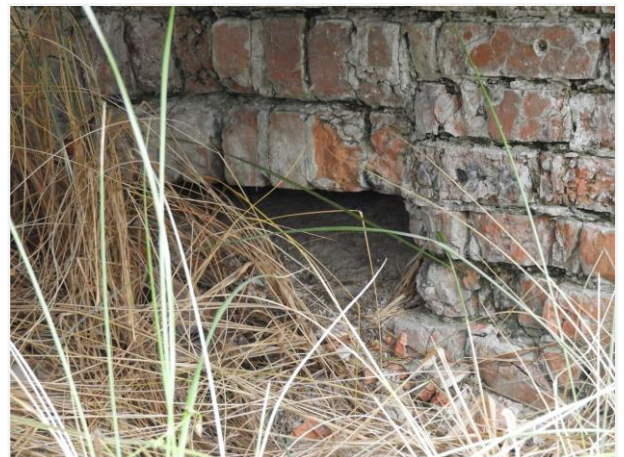
Foto 48: Nis in de bakstenen loopgraaf achter de Ringstand voor tankkoepel (nummer 16). Foto genomen op 5 augustus 2019.
