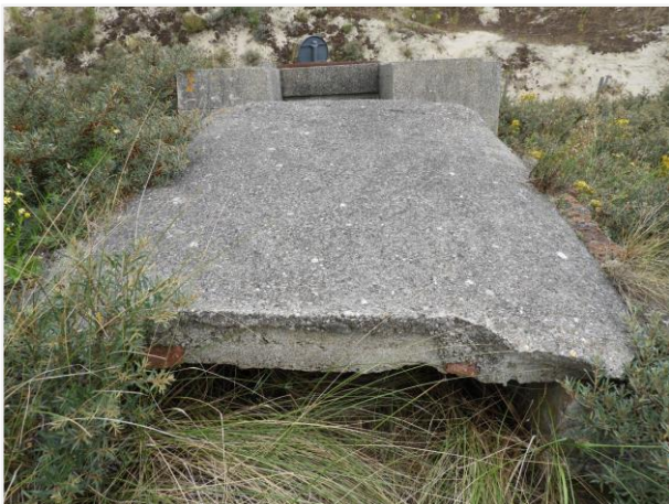
Foto 47: Betonnen dak op bakstenen loopgraaf achter de Ringstand voor tankkoepel (nummer 16). Foto genomen op 5 augustus 2019.
