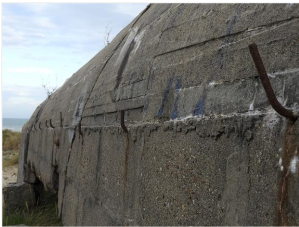
Foto 13: Bunker nummer 1, type 612. IJzeren haken aan de achterzijde. Foto genomen op 5 augustus 2019.
