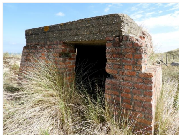
Foto 108: Bakstenen gebouw nummer 46. Foto genomen op 5 augustus 2019.
