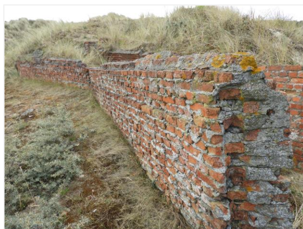
Foto 78: Loopgraaf nummer 48: metselwerk aan de buitenzijde. Foto genomen op 5 augustus 2019.
