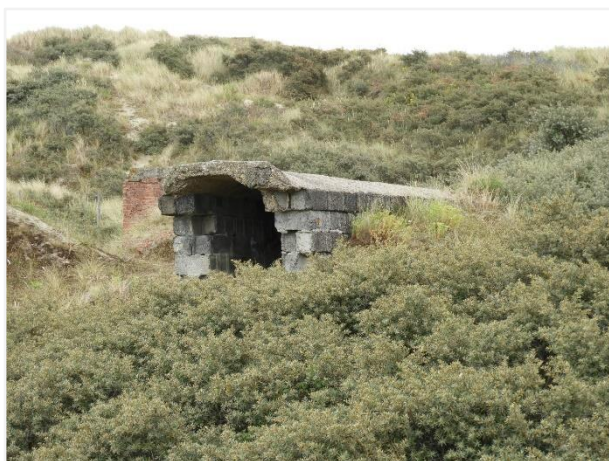
Foto 59: Frontzijde betonnen loopgraaf (nummer 53). Foto genomen op 5 augustus 2019.
