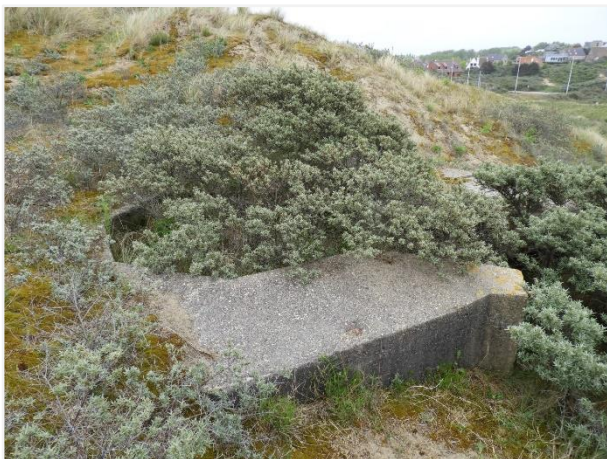
Foto 71: Open bedding voor 5cm KwK met aanpalende bakstenen post (nummer 25). Foto genomen op 20 mei 2019.
