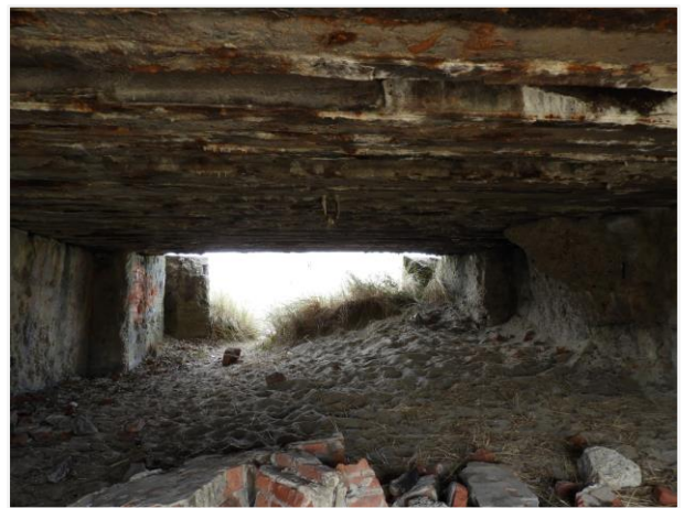
Foto 14: Bunker nummer 1, type 612. Zicht op de achterzijde aan binnenkant. Foto genomen op 5 augustus 2019.
