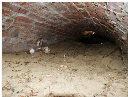
Foto 88: Overdekte loopgraaf (nummer 50), ter hoogte van het pad met betonnen muren (nummer 51). Foto genomen op 5 augustus 2019.
