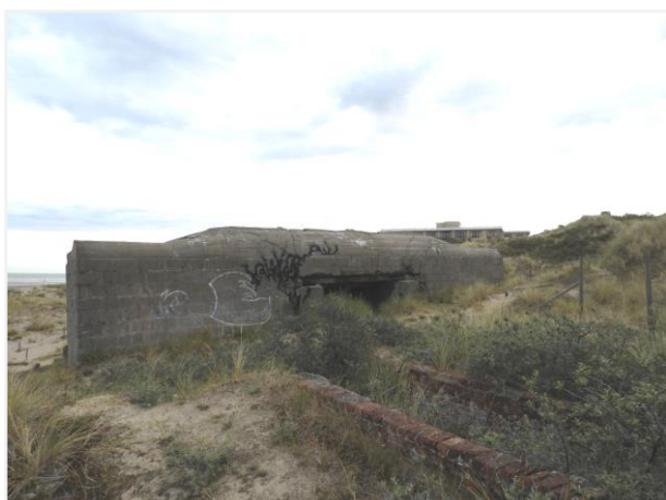
Foto 11: Bunker nummer 1, type 612. Achterzijde met brede toegang en bakstenen loopgraaf. Foto genomen op 5 augustus 2019.
