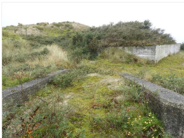
Foto 53: Breed pad (nummer 51) afgebakend met betonnen muren, uitgevend op betonnen remise (nummer 45). Foto genomen op 7 oktober 2019.
