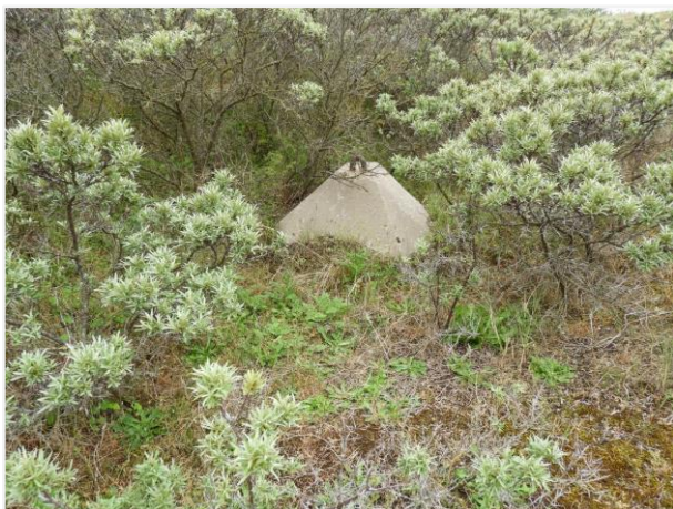
Foto 115: Dak van betonnen wachtpost (nummer 38), met bovenaan ijzeren haak. Foto genomen op 6 augustus 2019.
