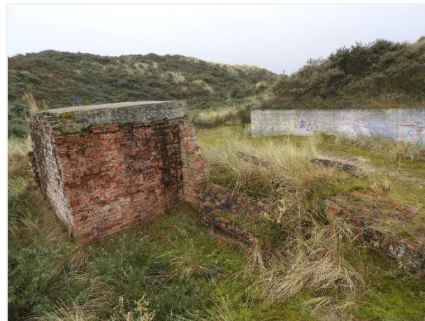
Foto 106: Bakstenen gebouw nummer 46, met aanpalende bakstenen muur. Foto genomen op 7 oktober 2019.
