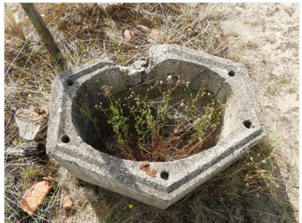
Foto 64: Minimum twee op elkaar geplaatste geprefabriceerde betonnen stenen voor een Deckungsloch (nummer 56). Foto genomen op 5 augustus 2019.
