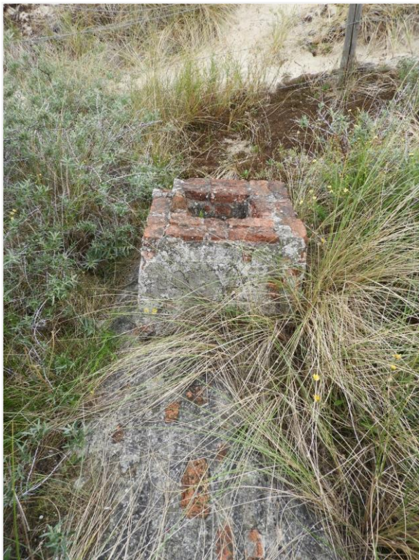
Foto 95: Overdekte loopgraaf (nummer 57) met vierkante verluchttingsopening. Foto genomen op 5 augustus 2019.
