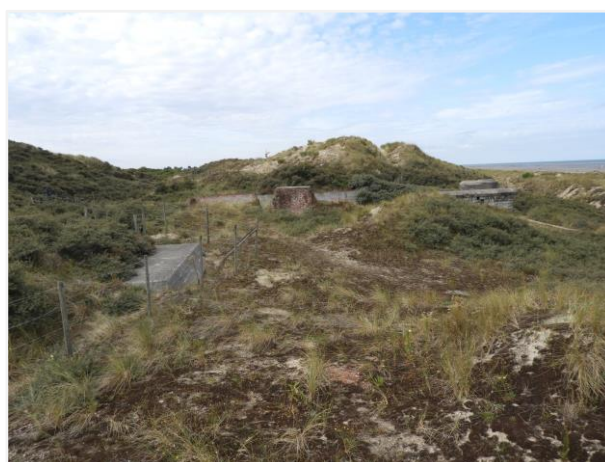
Foto 6: Westelijke zone van de site, met links de VF 2a (nummer 17) en verderop de bakstenen accommodatie (nummer 46), de betonnen remise (nummer 45), de betonnen loopgraaf (nummer 53) en Tobruk (nummer 10). Foto genomen op 5 augustus 2019.
