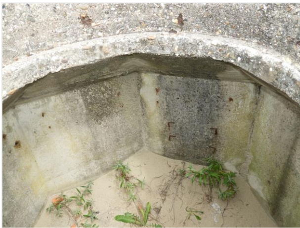
Foto 37: Tobruk nummer 10. Zicht in octagonale ruimte. Foto genomen op 5 augustus 2019.
