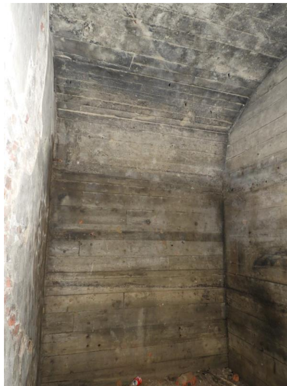
Foto 58: De achterste ruimte in de betonnen remise (nummer 45). Foto genomen op 5 augustus 2019.
