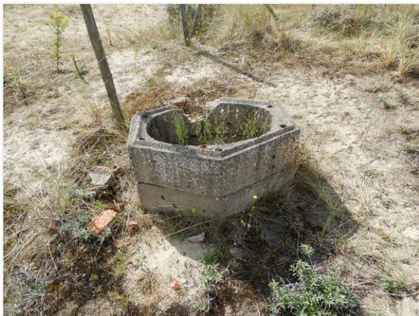
Foto 63: Minimum twee op elkaar geplaatste geprefabriceerde betonnen stenen voor een Deckungsloch (nummer 56). Foto genomen op 5 augustus 2019.
