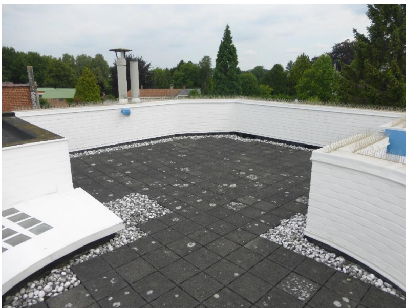
Foto 15: dakterras, derde verdieping.
