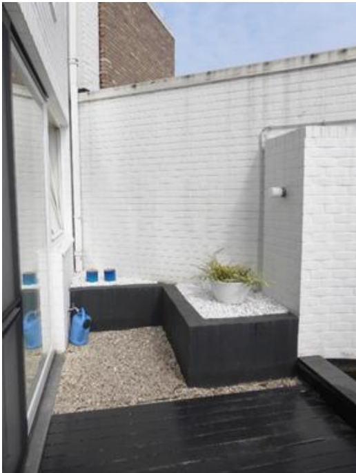
Foto 9: zijmuur en plantvakken.
