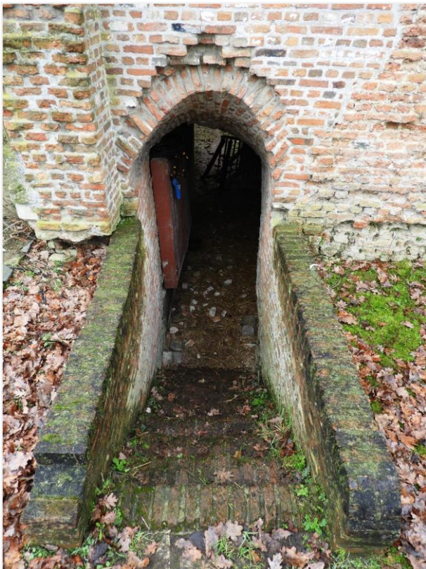
Foto 22: toegang tot de kelder van de westvleugel.
