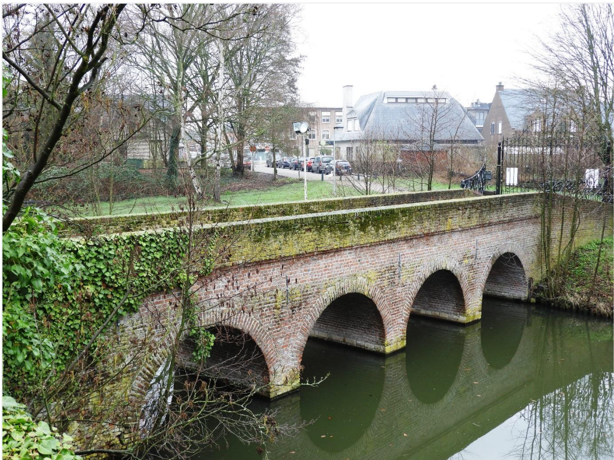
Foto 5: de toegangsbrug over de walgracht.
