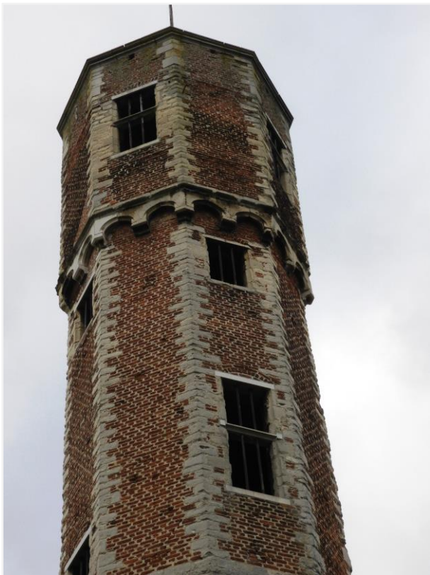
Foto 26: de bovenste geleding van de traptoren.
