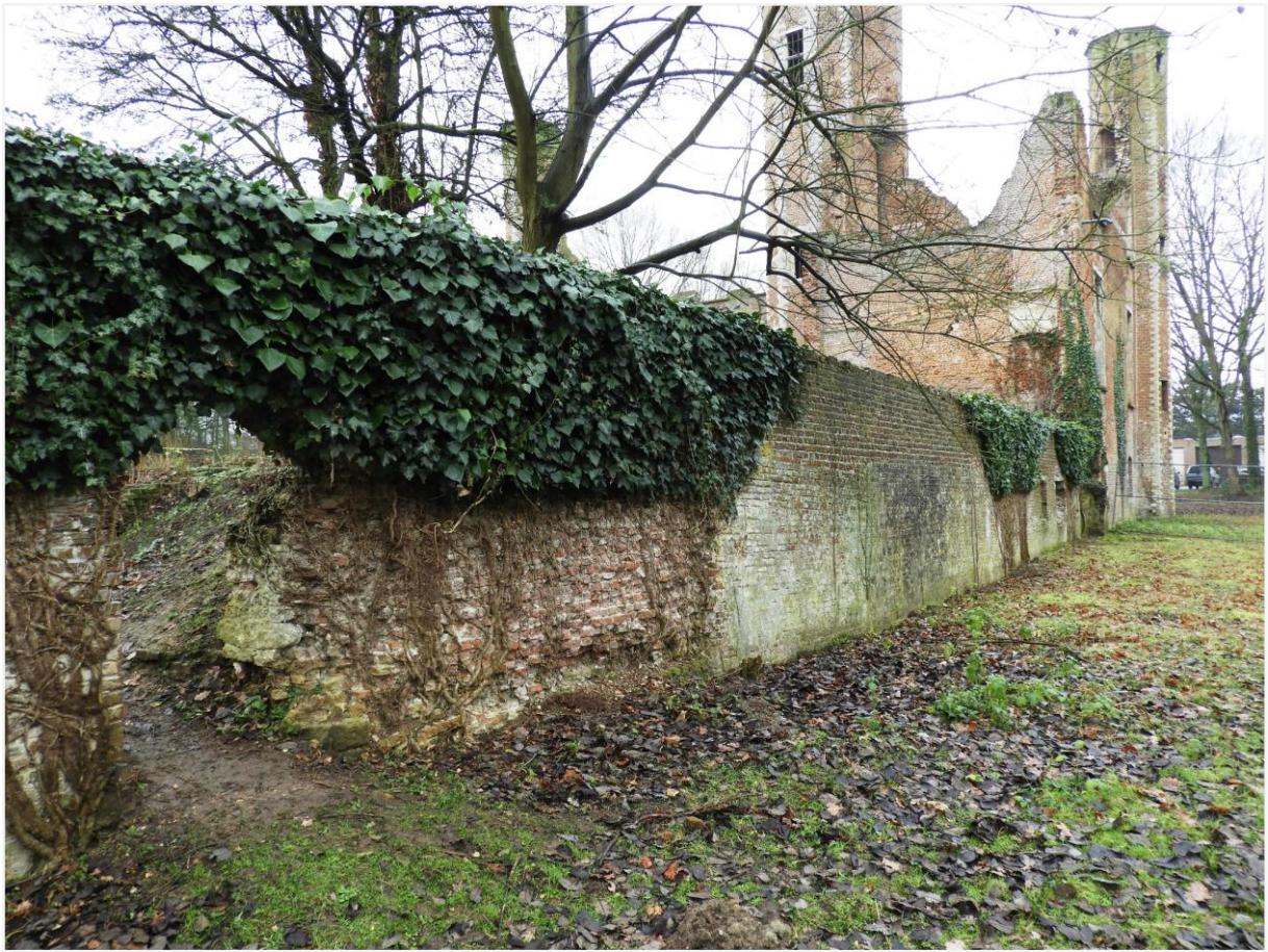
Foto 28: de westelijke zijde van de keermuur van het wooneiland.
