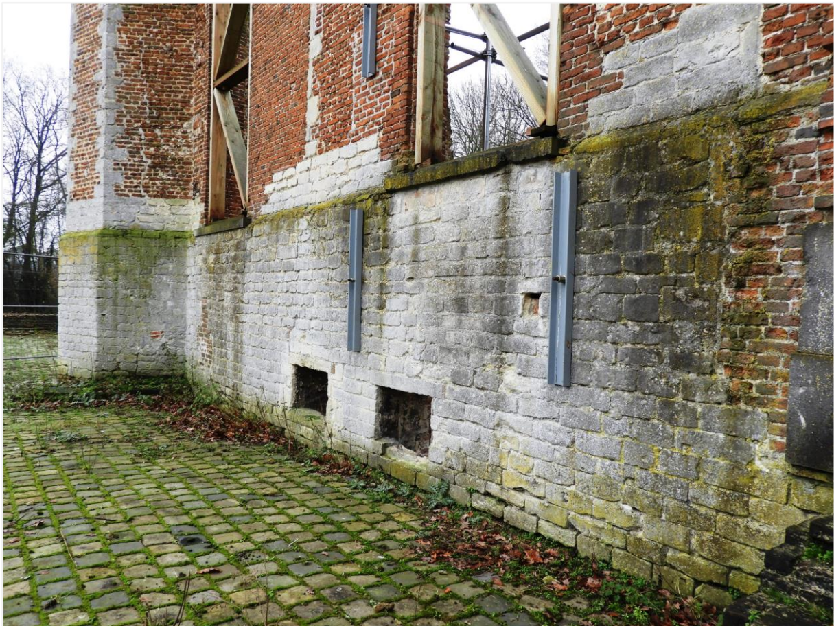
Foto 15: natuurstenen plint van de voorgevel.
