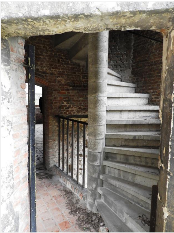
Foto 24: interieur van de traptoren. De betonnen wenteltrap werd toegevoegd tijdens de restauratie van 1981-1982.
