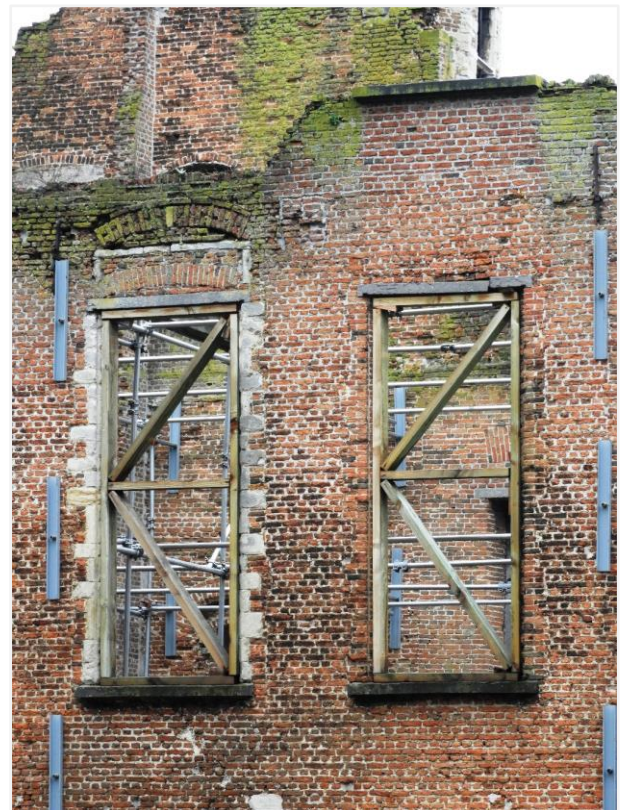
Foto 3: vensteropeningen in de zuidgevel.
