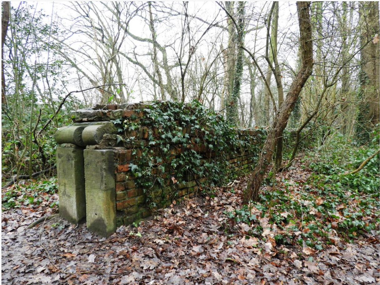
Foto 8: baksteenmuur met hardstenen dagkant, gelegen tussen de walgracht en de Netedijk.
