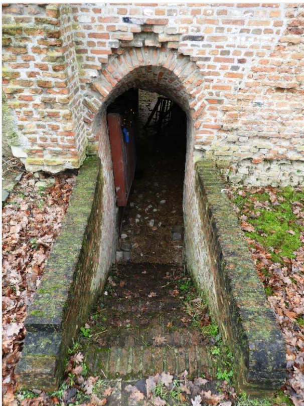
Foto 22: toegang tot de kelder van de westvleugel.
