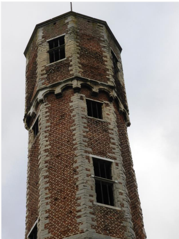
Foto 26: de bovenste geleding van de traptoren.
