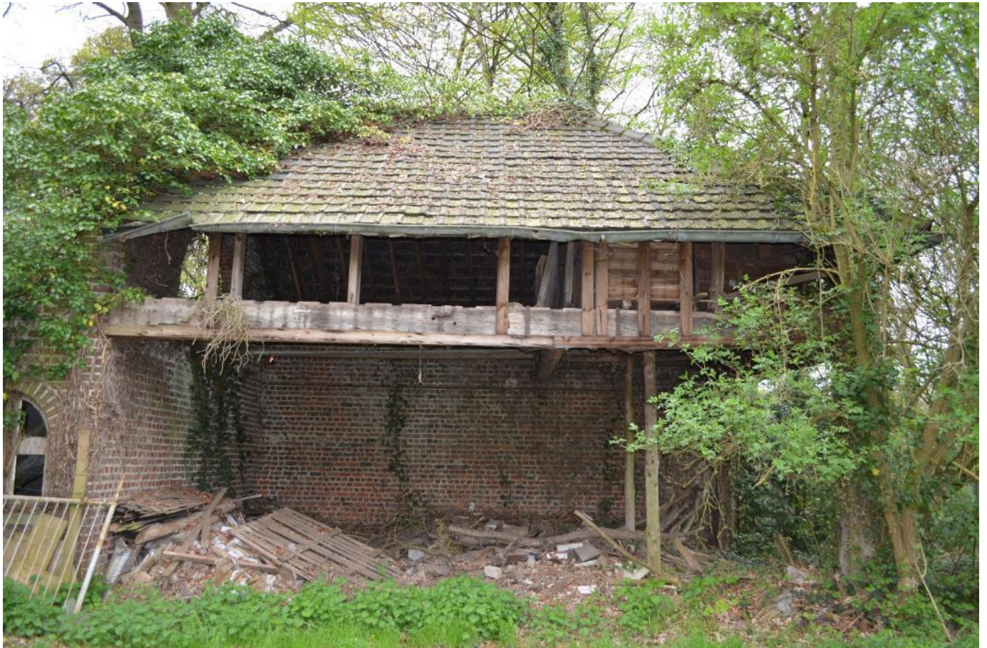
Foto 58: aan de rand van het Klein park staat naast het pad een open loods; zicht op de open noordzijde van de bakstenen loods met gerecupereerde moerbalk en grotendeels verdwenen beschot
