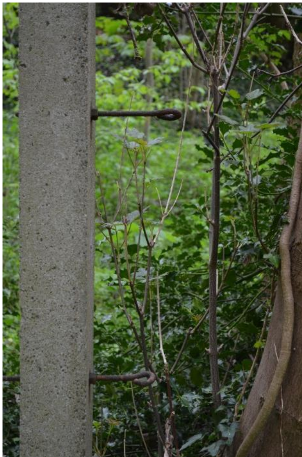
Foto 42: detail met ijzeren ogen voor het vastzetten van de leidraden
