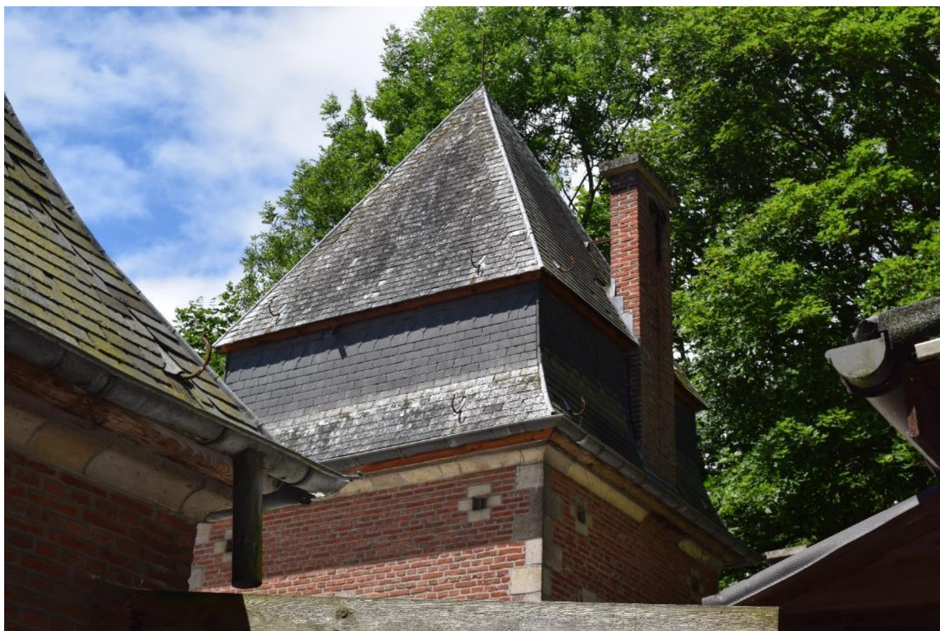
Foto 79: kasteel de Bunswyck: zicht op de achterzijde van de torentjes in traditionele stijl, deels ingebouwd tussen hedendaagse garages en bergingen
