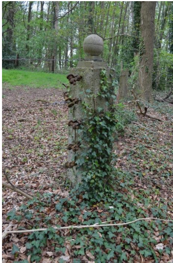
Foto 39: hekpijler in cement tegenover de loods
