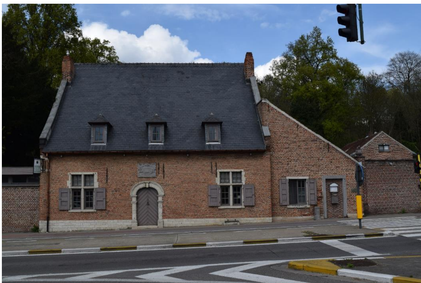
Foto 88: afspanning De Mol: zicht op het breedhuis en op de oostelijke aanbouw onder lessenaarsdak; vlak aan de voorgevel van de aanbouw staat de kilometerpaal K 29
