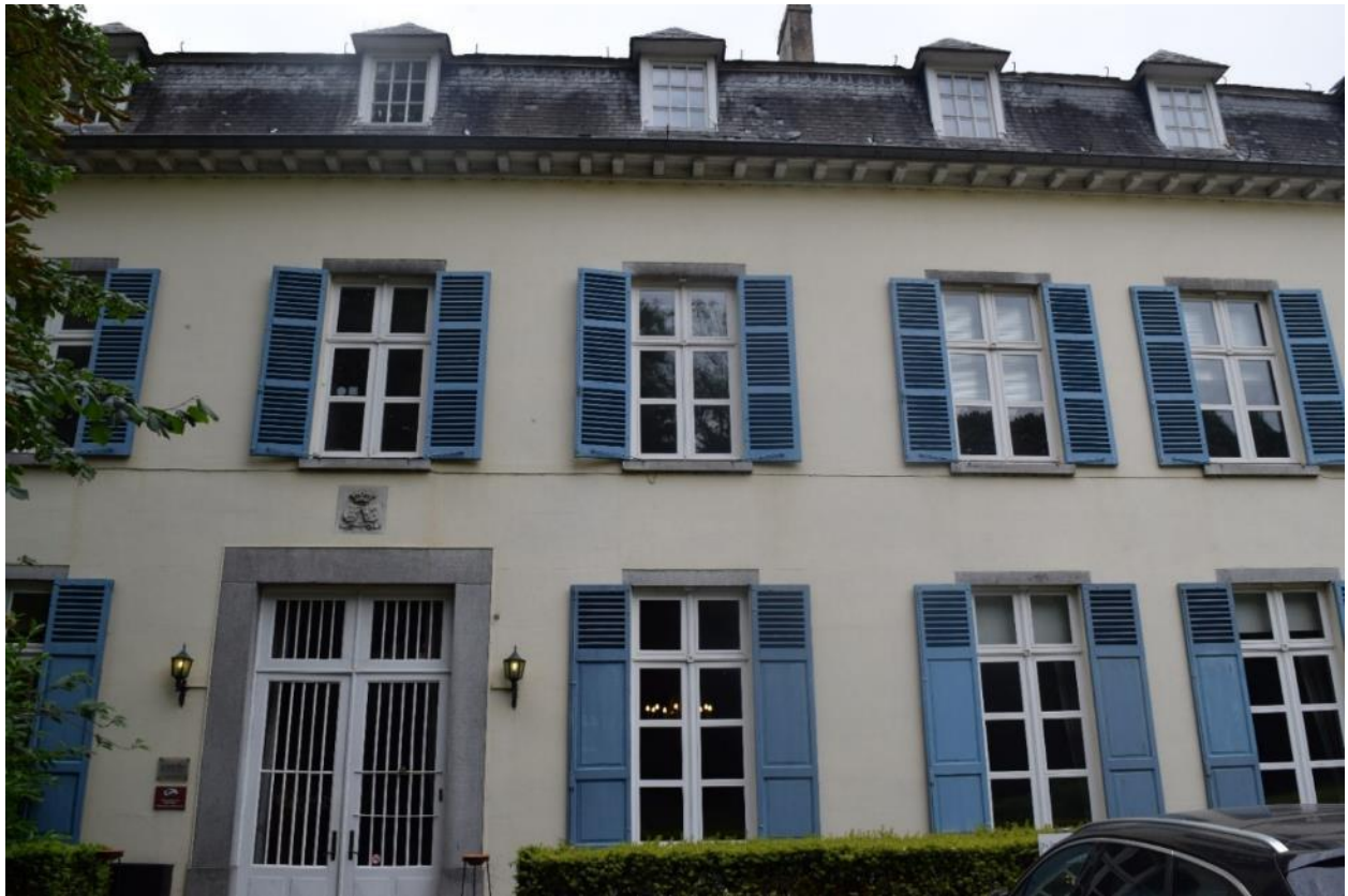
Foto 66: kasteel de Bunswyck: hoofdingang in de oostelijke gevel of voorgevel, gericht naar de parkzijde
