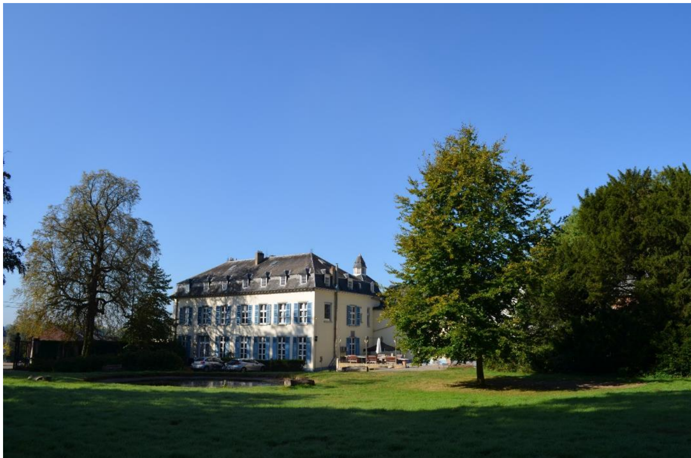
Foto 1: kasteel de Bunswyck: zicht op het hoofgebouw, oostgevel geïntendeerd naar het park
