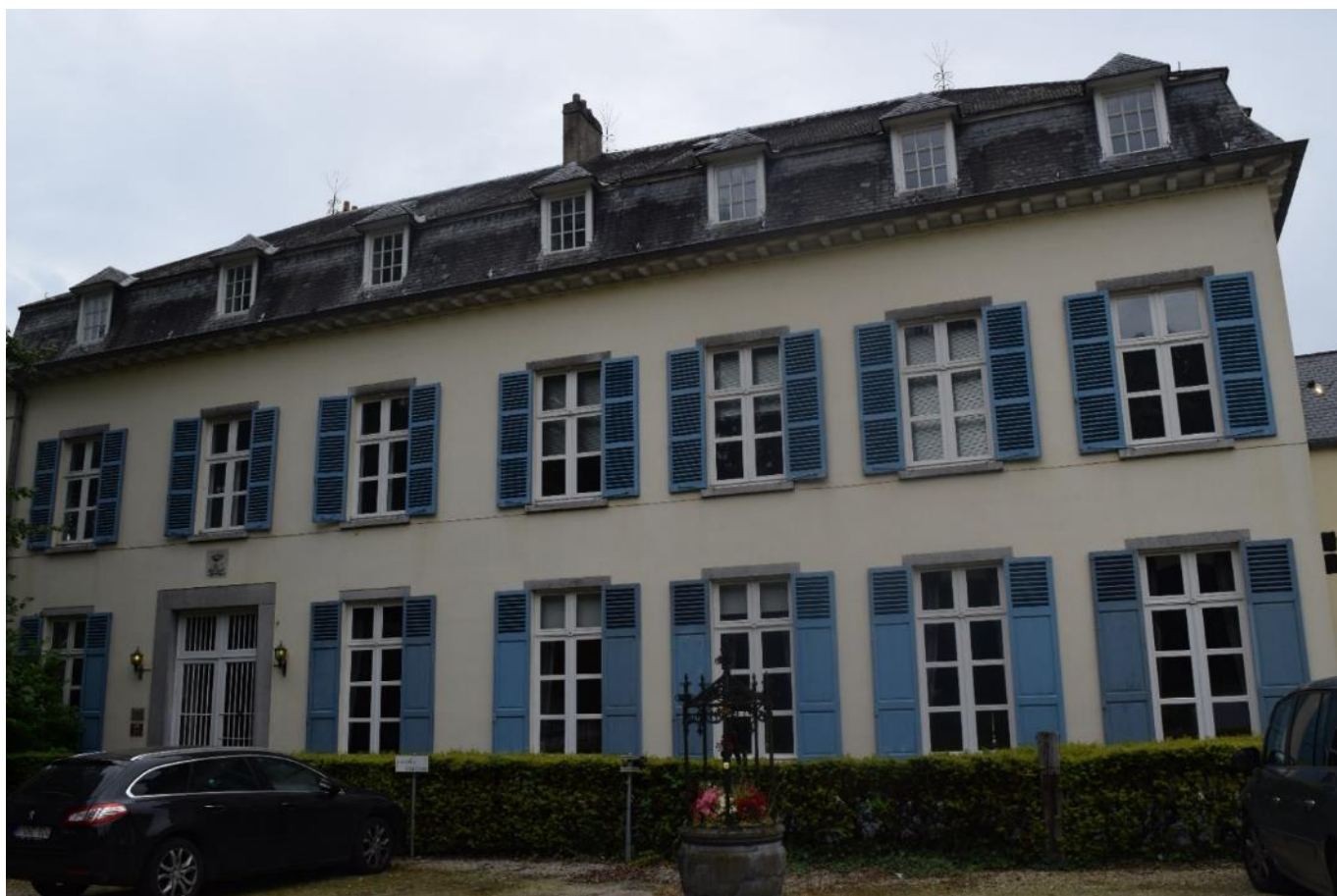
Foto 65: kasteel de Bunswyck: oostelijke gevel of voorgevel, gericht naar de parkzijde
