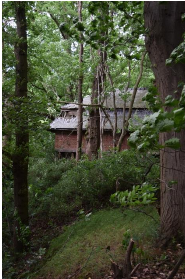
Foto 48: zicht op de zuidgevel van de belvédère, staande op steilrand aan de rand van het bosgedeelte van het Groot park
