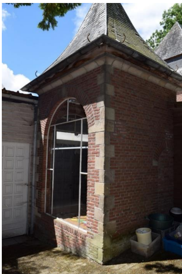
Foto 80: kasteel de Bunswyck: achterzijde van het torentje in neotraditionele stijl op vierkantig grondplan met muuropening met restant van metalen raamframe, vroeger dienstig als volière
