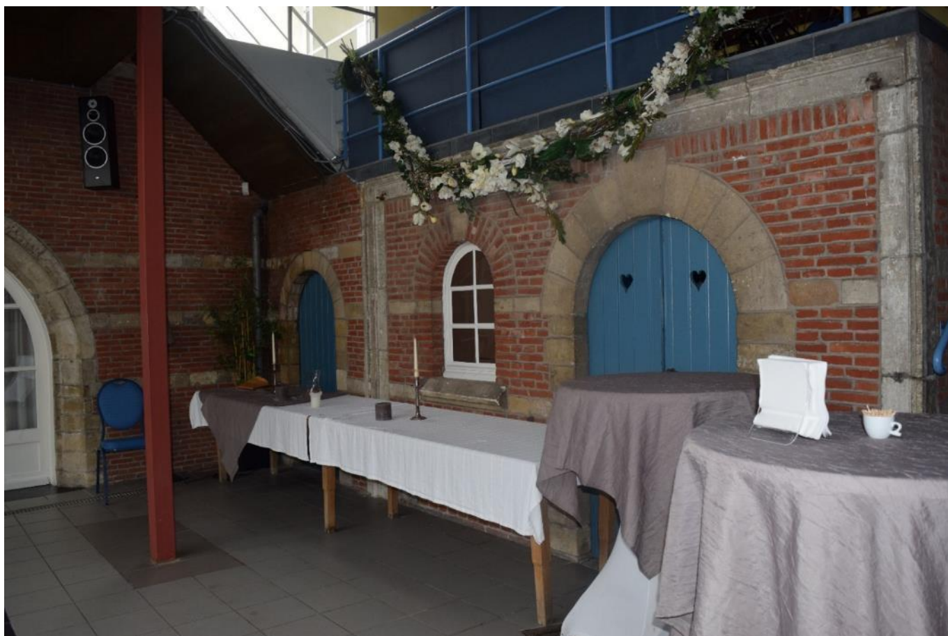
Foto 75: dwarsvleugel van de nutsgebouwen (stalling met hooizolder en schuur), met de buitengevels in neotraditionele stijl, heden aan het zicht onttrokken onder een moderne luifelconstructie; de hooizolder werd opengewerkt tot (feest)zaal.
