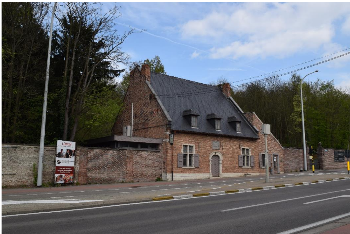
Foto 86: omheiningsmuur van het kasteelpark met in het verlengde de voormalige afspanning De Mol, zicht in oostelijke richting
