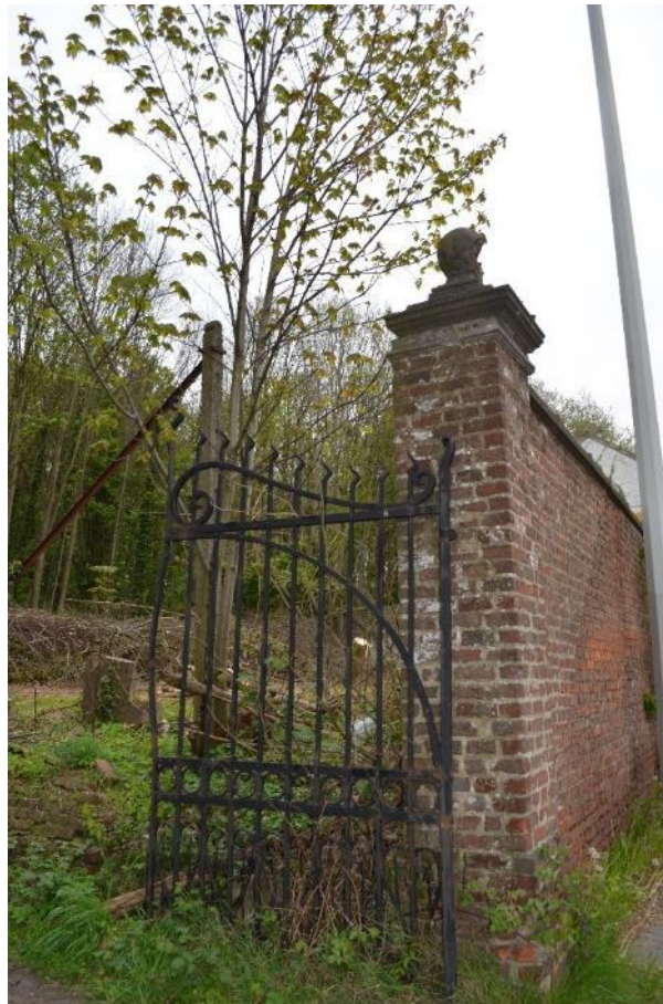
Foto 32: omheiningmuur en toegangshek aan de secundaire toegang op de Tiensesteenweg met toegang tot een pad, dat loopt door het perceel van de moestuin en leidt naar de hoger gelegen boomgaard en het bosgedeelte van het Groot park de Bunswyck
