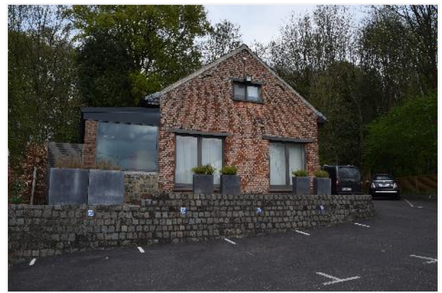
Foto 96: Dienstgebouw bij afspanning De Mol
