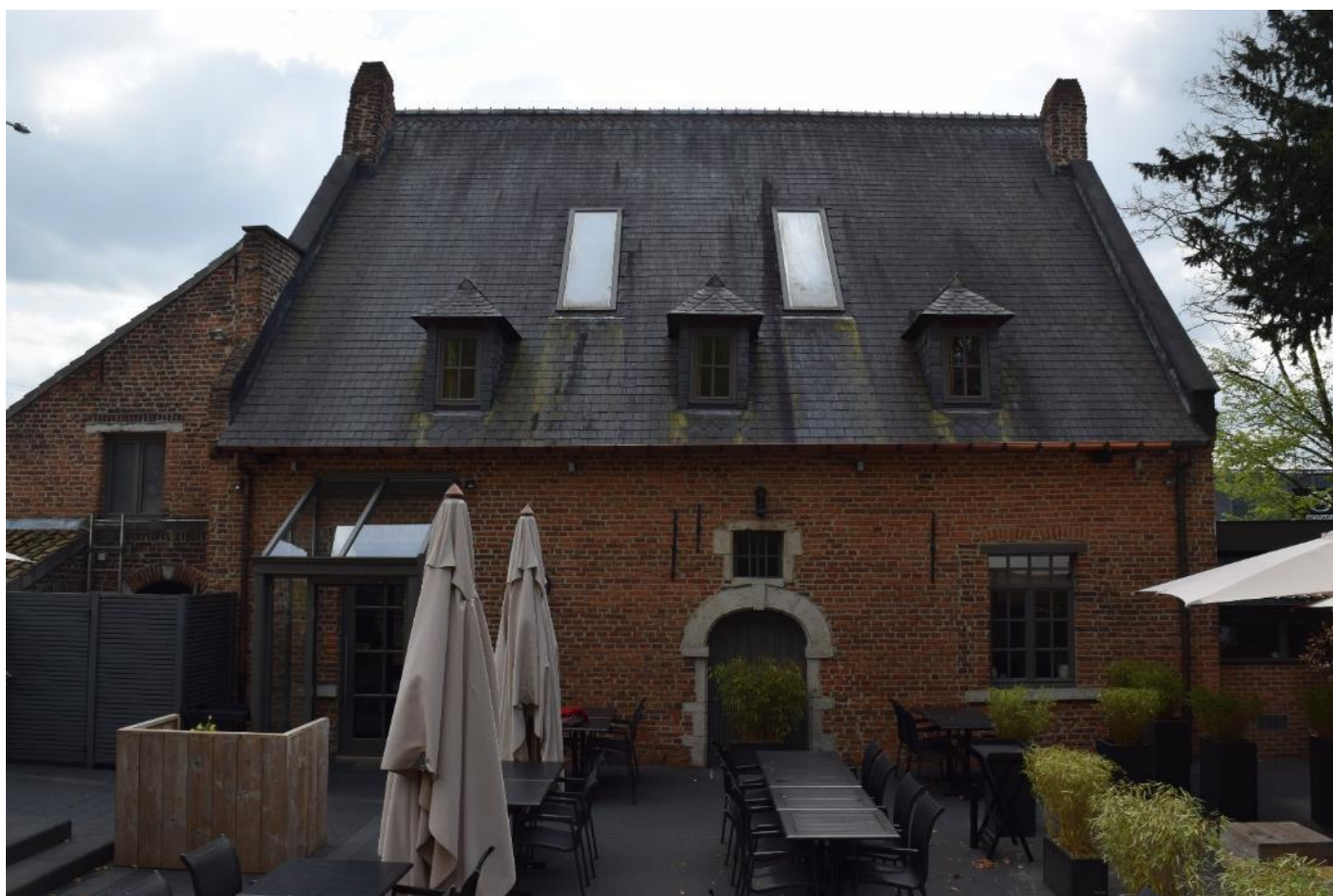
Foto 90: Afspanning De Mol: noordgevel of achtergevel in neotraditionele stijl, met ankers en oude bouwsporen
