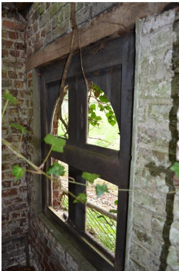
Foto 61: bewaard houten schrijnwerk van een raam aan de noordelijke zichtbare gevel van het dienstgebouw naast de loods
