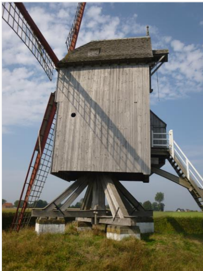
Foto 3: linkerweeg met molenberg, teerlingen en kruisplaat
