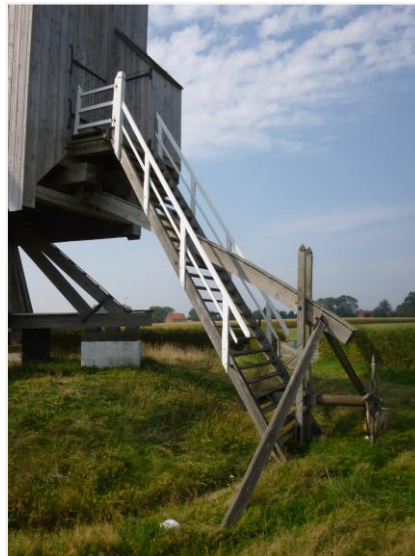
Foto 4: voorweeg met staart, trap en balkon
