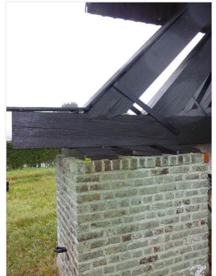
Foto 8: verbinding steekbalken en kruisplaat
