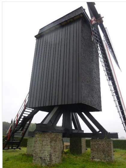
Foto 4: vangzijde en windweeg met gevluht
