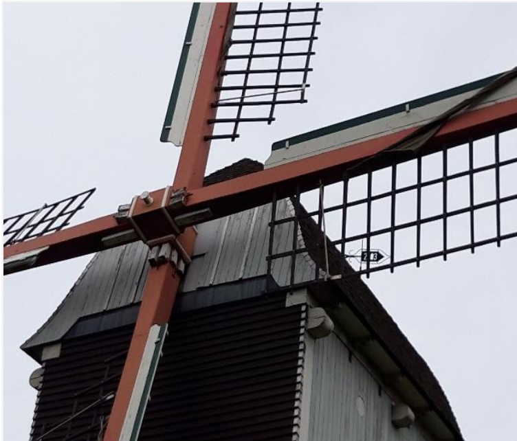
Foto 12: Molenkast met blinde zijwegen. Blinde windweeg onderaan klokvormig uitgewerkt.
