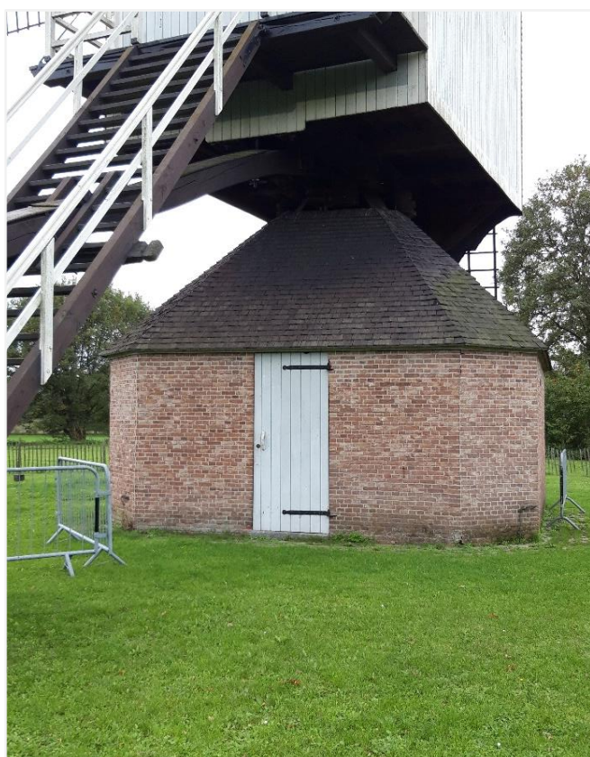
Foto 10: Molenkot. Gesloten gemetselde voet met twee deuren onder tentdak.
