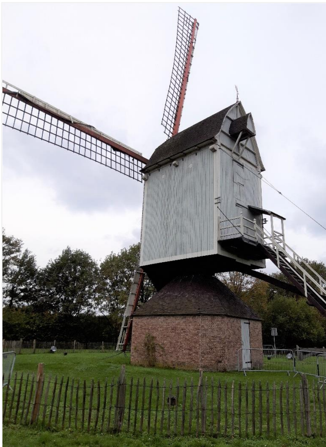
Foto 15: Blinde zijweeg en voorweeg met trap.
