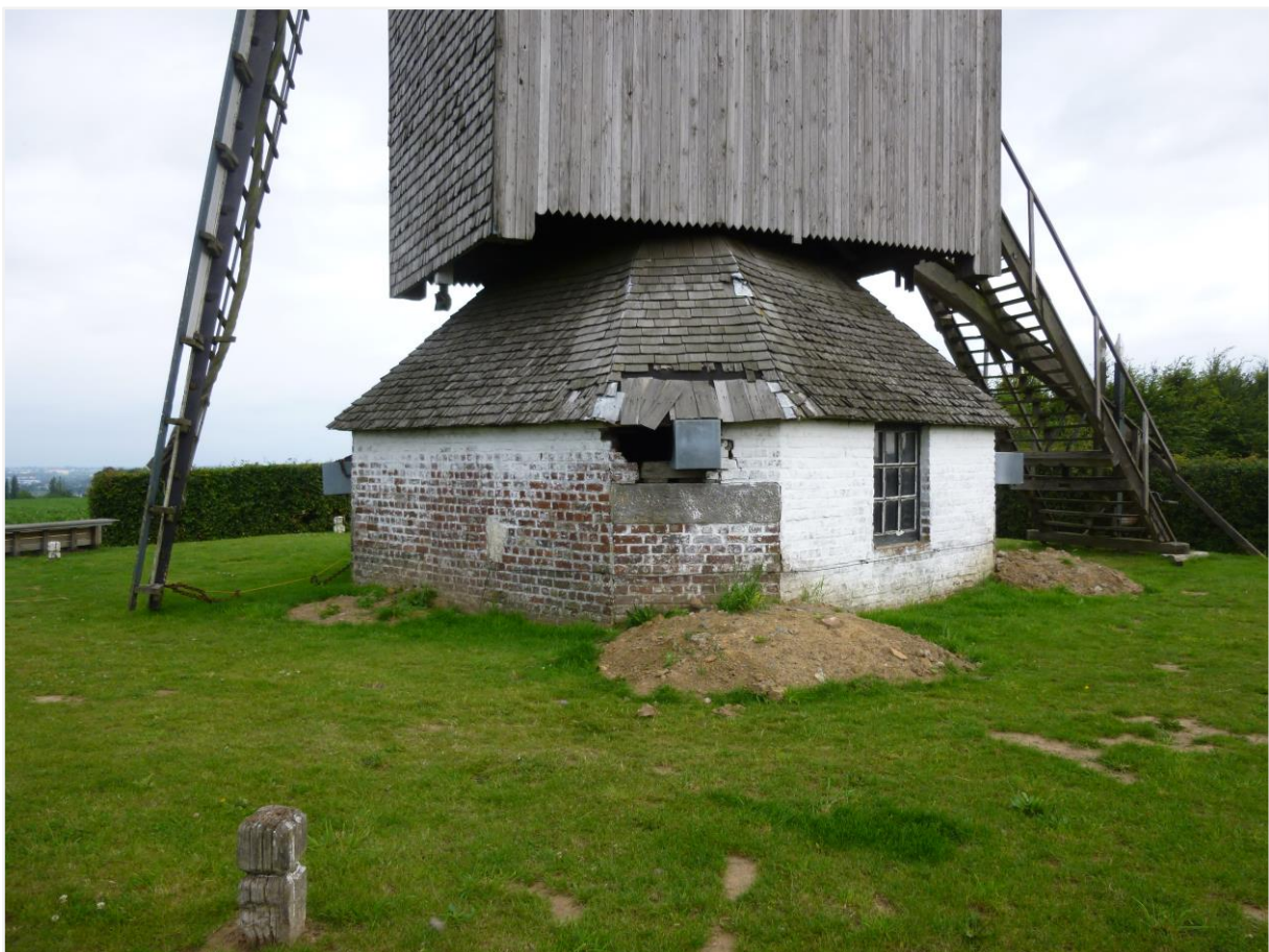
Foto 5: Gesloten molenvoet onder leien torendak. Schade aan leibedekking en het opgaand metselwerk.
