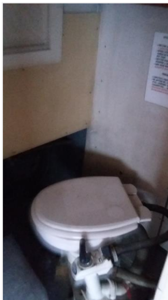
Foto 10: sloopstoilet tussen machinekamer en achterdek
