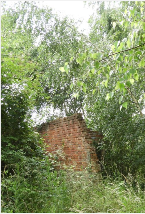
Foto 5: restant van de achtergevel en aansluitend deel van oostelijke zijgevel.
