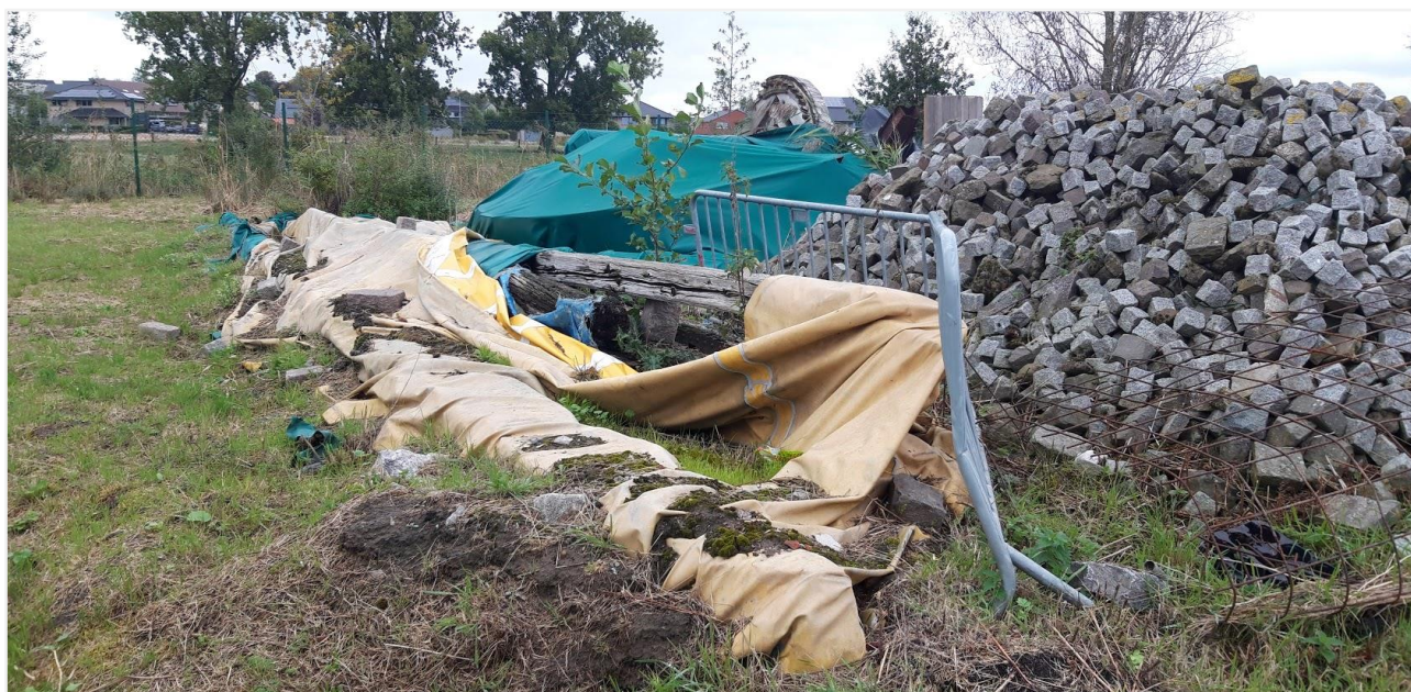
Foto 12: Gezicht op gedemonteerde onderdelen achter de gemeenteloods
