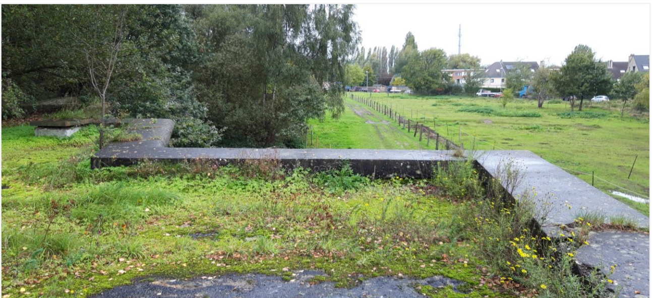
Foto 8: Betonnen kroonlijst op het dak van het schansgebouw
