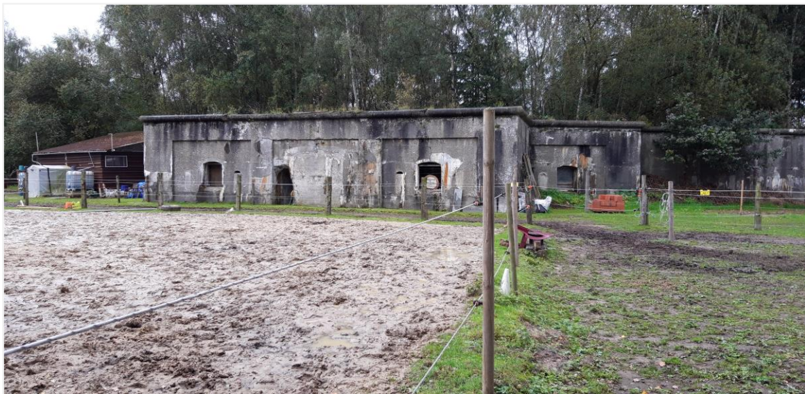
Foto 3: Het betonnen schansgebouw van schans XVII aan de bevariende zijde (keel). De centrale toegang is deels dicht gemetseld, de flankerende zijkamers hebben een raam zonder origineel buitenschrijnwerk
