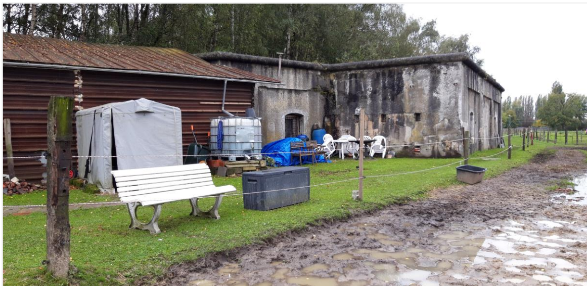
Foto 5: Het schansgebouw met tijdelijke aanbouw in golfplaten, westzijde
