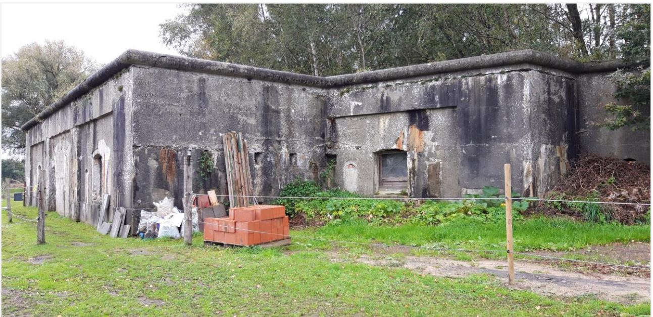
Foto 7: Schansgebouw aan de oostzijde, ook hier zijn de verankeringen van de plaataffuiten zichtbaar. De centrale gevel is geritmeerd door drie traveeën
