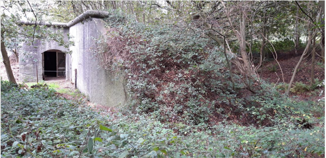
Foto 9: Schansgebouw van schans XVII, westzijde. Het oreillon is een betonnen muur op de uitersten van het schansgebouw, dat bescherming bood aan de manschappen die het schansgebouw aan de zijkant verlieten om hun posities in de geschutkoepel in te nemen. Een aarden dek beschermt het schansgebouw aan de vijandelijke zijde tegen inslaande projectielen
