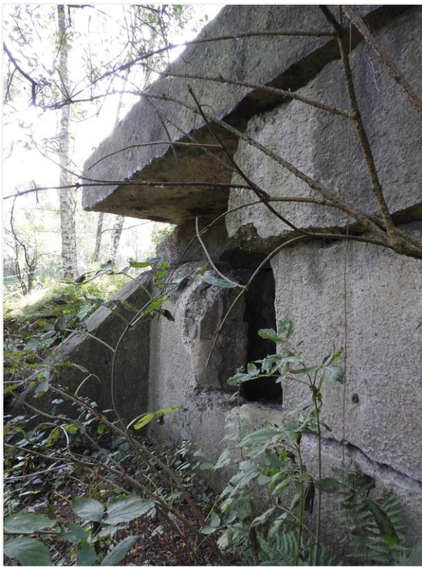
Foto 15: Geschutkoepel, een opvallend details links is het schuin aflopend oreillon dat tegen de vuurkam was aangebouwd
