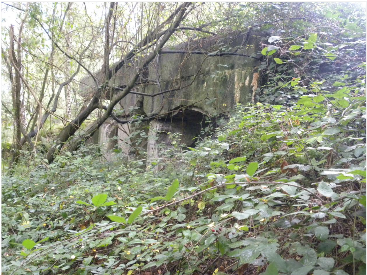
Foto 13: De betonnen geschutkoepel, ingewerkt in de vuurkam
