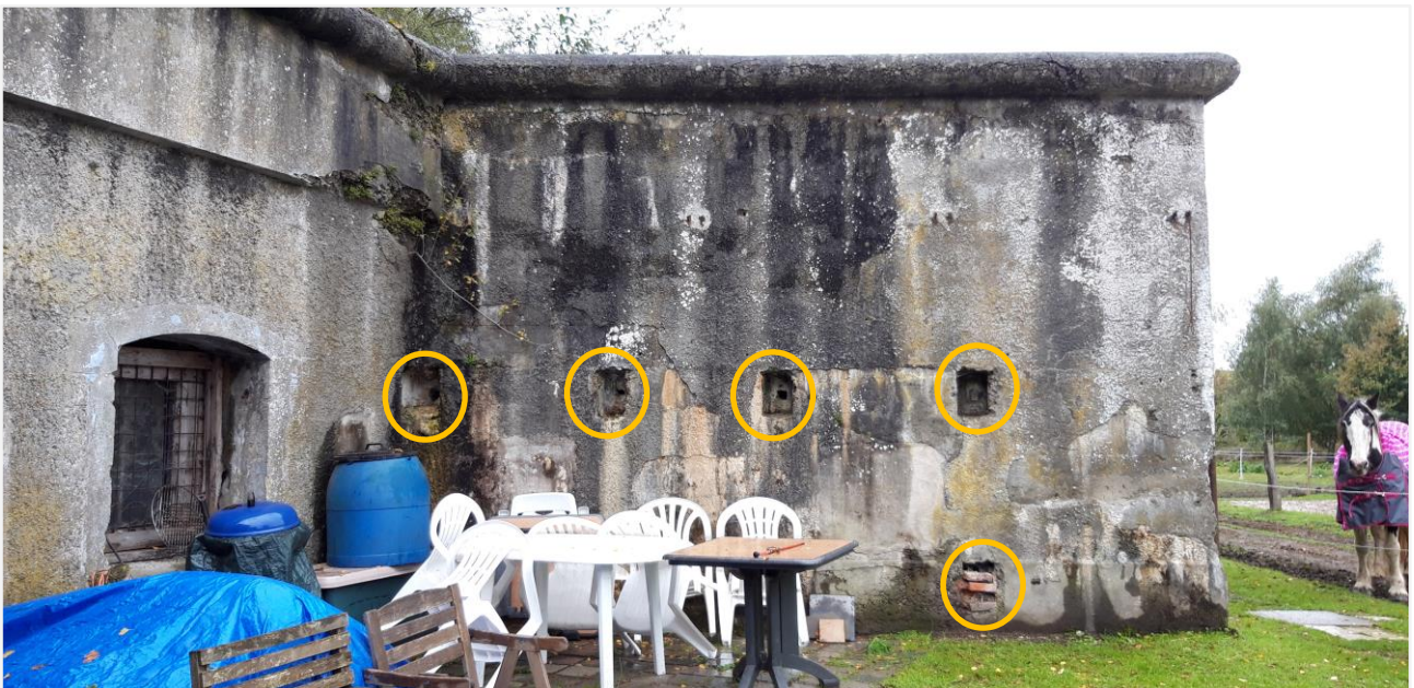
Foto 6: Schansgebouw van schans XVII, zijaanzicht van het centrale gedeelte. De verankeringen van de plaataffuiten van de 7,5cm kanonnen zijn duidelijk in de gevel zichtbaar
