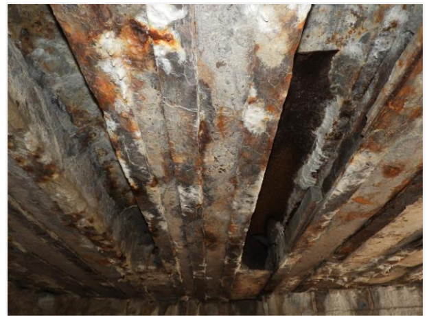
Foto 16: Bunker nummer 1, type 612. Uitsparingen voor buizen in het plafond. Foto genomen op 5 augustus 2019.
