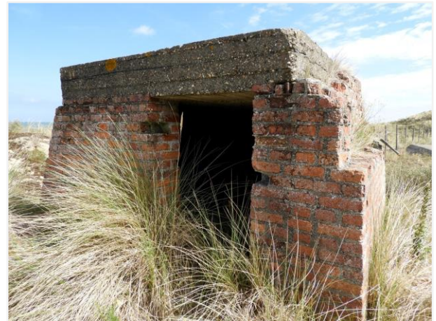
Foto 108: Bakstenen gebouw nummer 46. Foto genomen op 5 augustus 2019.
