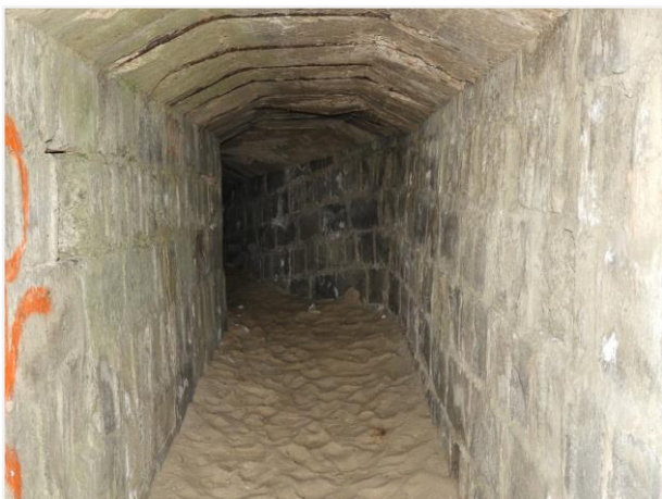
Foto 61: Zicht in de betonnen loopgraaf in zuidoostelijke richting (nummer 53). Foto genomen op 5 augustus 2019.
