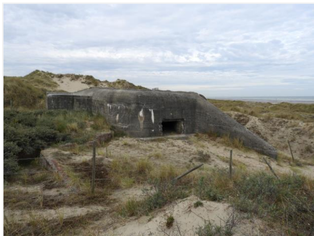
Foto 7: Bunker nummer 1, type 612. Zicht op voorzijde met scherfmuur en bakstenen loopgraaf. Foto genomen op 5 augustus 2019.
