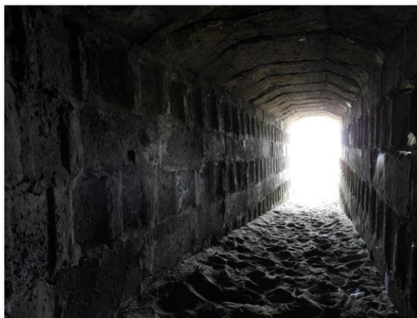
Foto 62: Zicht in de betonnen loopgraaf, richting noordwesten (nummer 53). Foto genomen op 5 augustus 2019.
