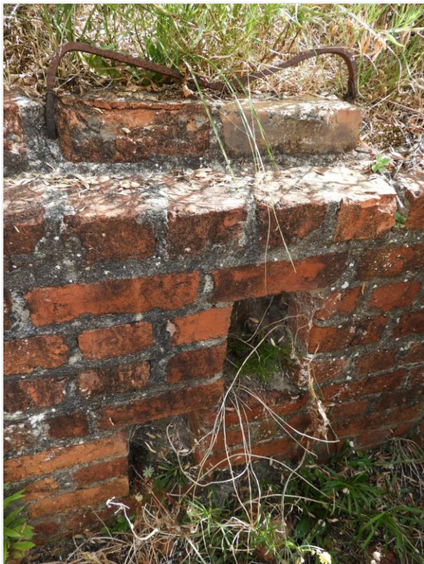
Foto 91: Detail toegang tot overdekte loopgraaf (nummer 50), net ten oosten van het pad met betonnen muren (nummer 51). Bemerkt de uitgespaarde treden en de ijzeren handgreep. Foto genomen op 5 augustus 2019.
