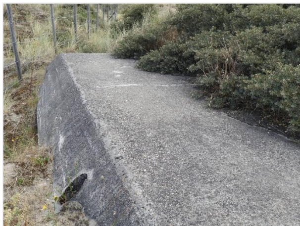
Foto 50: Bunker nummer 17, type VF 2a. Zicht op de noordelijke zijde van het dak, met ronde opening. Foto genomen op 5 augustus 2019.
