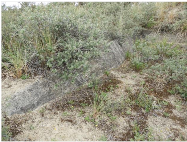
Foto 19: Bovenste rand van de westelijke scherfmuur en achtermuur van de bunker nummer 3 (type 502). Foto genomen op 5 augustus 2019.
