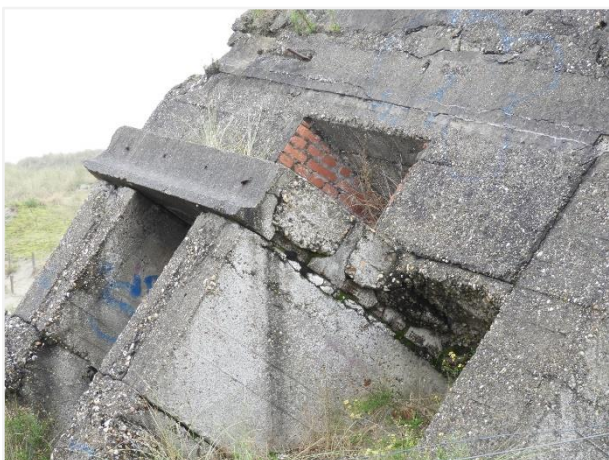
Foto 27: Mitrailleurpost, type VF 3, nummer 6. Detail toegang, afgedekt met Hoyerbalken , met bovenaan een schietopening in baksteen. Foto genomen op 7 oktober 2019.
