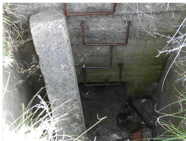
Foto 52: Bunker nummer 17, type VF 2a. Zicht op de klimijzers en de toegang onderaan in de nooduitgang. Foto genomen op 5 augustus 2019.
