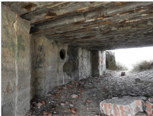
Foto 15: Bunker nummer 1, type 612. Zicht op zuidoostelijke binnenmuur. Foto genomen op 5 augustus 2019.
