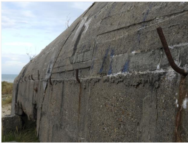
Foto 13: Bunker nummer 1, type 612. IJzeren haken aan de achterzijde. Foto genomen op 5 augustus 2019.
