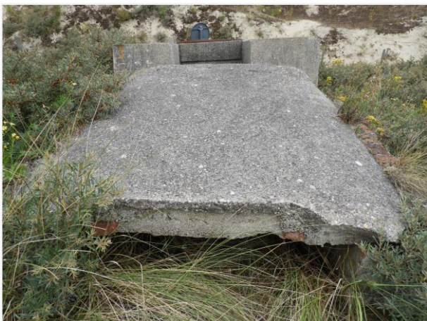
Foto 47: Betonnen dak op bakstenen loopgraaf achter de Ringstand voor tankcoepel (nummer 16). Foto genomen op 5 augustus 2019.
