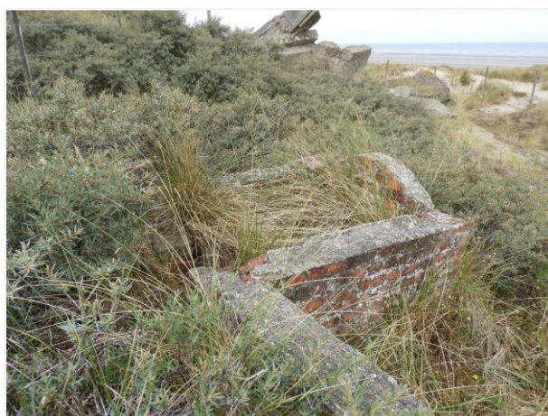
Foto 66: Symmetrisch opgebouwde constructie (nummer 59). Zicht op het bakstenen deel met gebogen frontzijde. Foto genomen op 5 augustus 2019.
