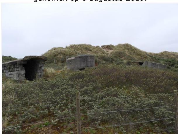
Foto 5: De betonnen loopgraaf (nummer 53), Tobruk (nummer 10) en Ringstand voor tankkoepel (nummer 16), vanaf het wandelpad ten noordwesten van de site. Foto genomen op 20 mei 2019.
