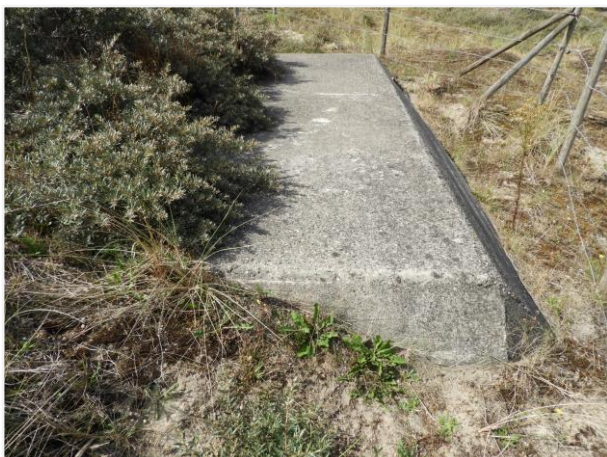
Foto 49: Bunker nummer 17, type VF 2a. Zicht op de oostelijke zijde van het dak. Foto genomen op 5 augustus 2019.
