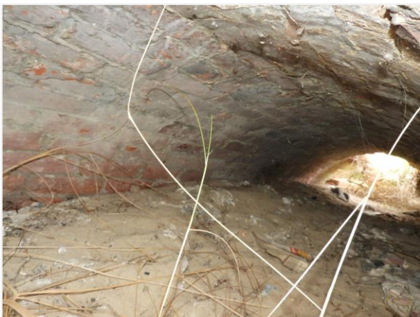
Foto 87: Overdekte loopgraaf (nummer 50) nabij de bunker VF 2a (nummer 18). Foto genomen op 5 augustus 2019.
