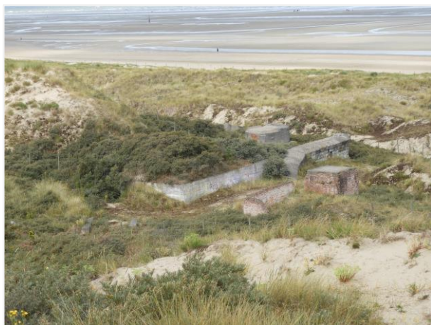
Foto 3: Westelijke zone van de site, met onder meer de bakstenen accommodatie (nummer 46), betonnen remise (nummer 45) met betonnen pad (nummer 51), betonnen loopgraaf (nummer 53), Tobruk (nummer 10) met net daarachter de Ringstand voor tankkoepel (nummer 16). Foto genomen op 6 augustus 2019.
