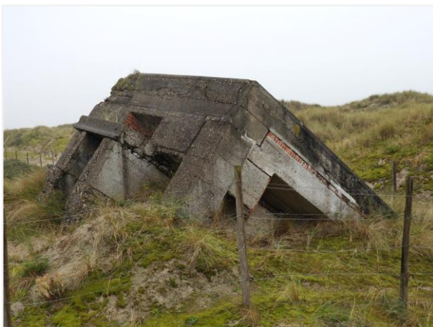
Foto 23: Mitrailleurpost type VF 3, nummer 6. Zicht op oostelijke en zuidelijke zijde. Foto genomen op 5 augustus 2019.
