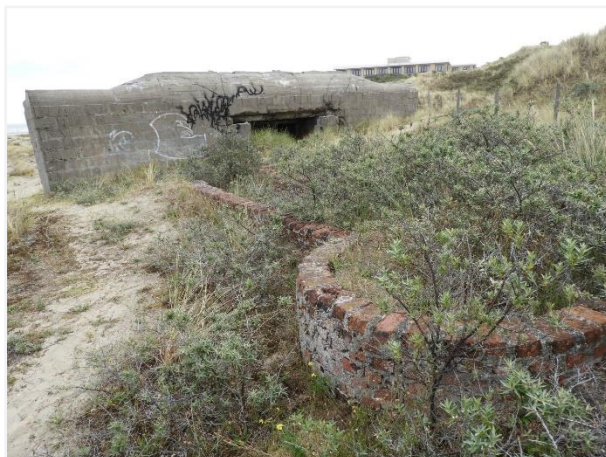
Foto 98: Halve cilindervormige uitsprong bij het loopgravensysteem nummer 58, aan de achterzijde van de bunker type 612 (nummer 1). Foto genomen op 5 augustus 2019.
