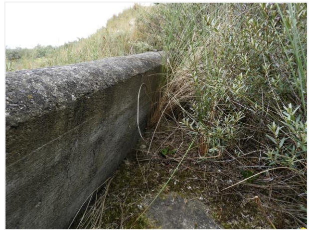
Foto 20: Bovenste deel van de oostelijke scherfmuur van bunker nummer 3 (type 502). Foto genomen op 5 augustus 2019.
