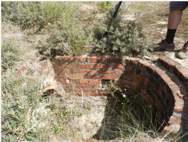
Foto 85: Toegang tot overdekte loopgraaf ter hoogte van nummer 50. Bemerkt de uitgespaarde treden en de ijzeren handgreep. Foto genomen op 5 augustus 2019.
