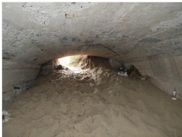
Foto 56: Zicht op de brede opening aan de achterzijde van de betonnen remise (nummer 45). Foto genomen op 5 augustus 2019.
