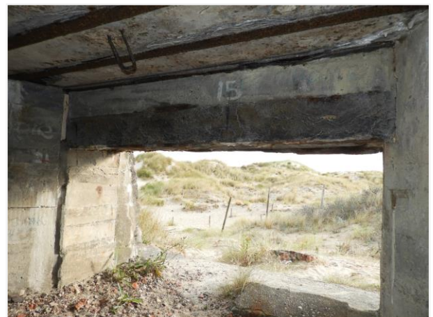
Foto 18: Bunker nummer 1, type 612. Schietgat vanaf de binnenzijde. Foto genomen op 5 augustus 2019.
