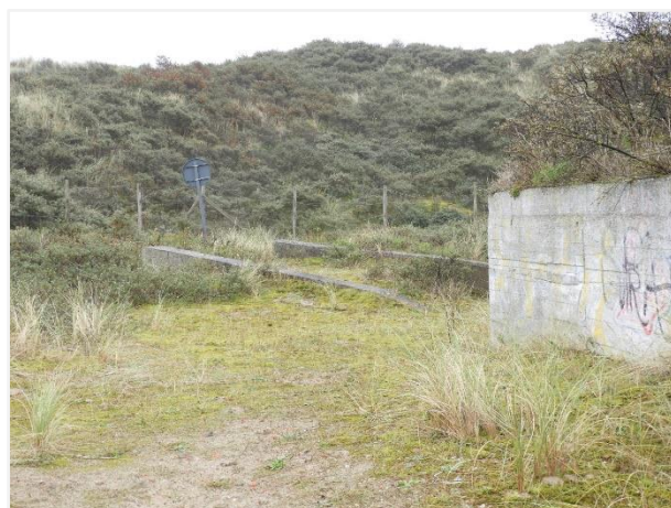
Foto 54: Breed pad (nummer 51) afgebakend met betonnen muren, uitgevend op betonnen remise (nummer 45). Foto genomen op 7 oktober 2019.
