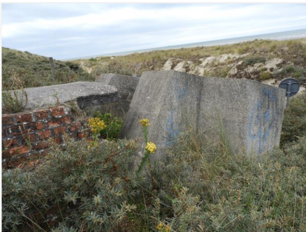
Foto 45: Ringstand voor tankcoepel (nummer 16) met aanpalende bakstenen loopgraaf met betonnen dak. Foto genomen op 5 augustus 2019.
