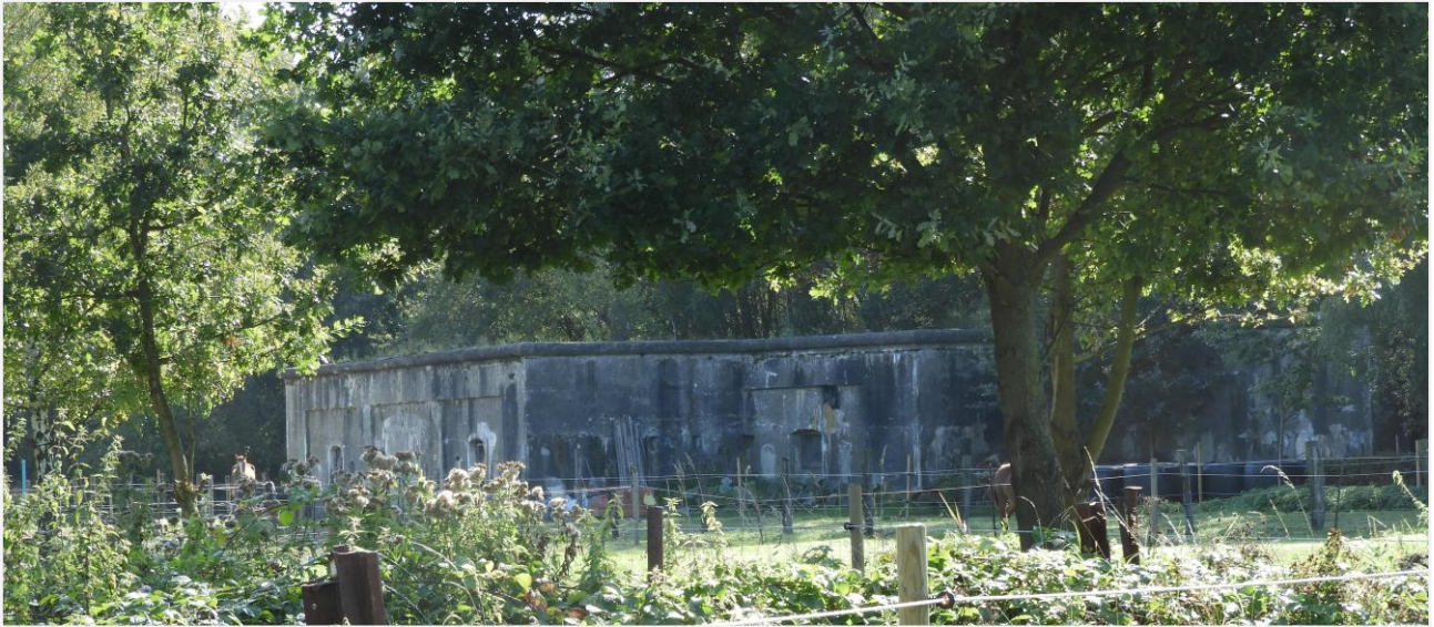
Foto 1: Zicht op schans XVII vanuit de Sint-Bernardsesteenweg, tussen de bebouwing en tuinen door, 10/9/2019
