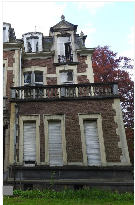
Foto 52: Kasteel, noordgevel, uitbouw
