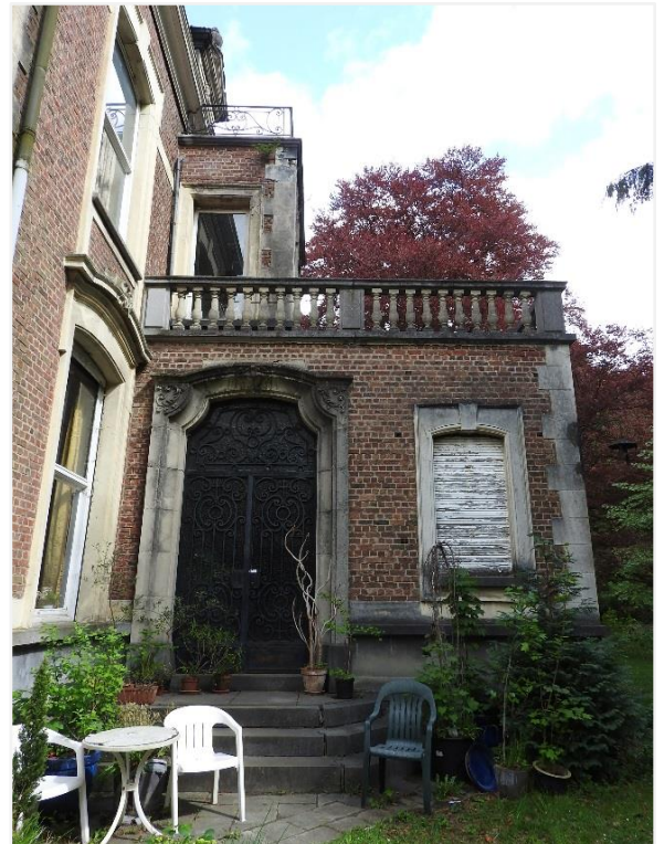
Foto 28: Kasteel, zuid- en oostgevel, detail van lagere uitbouw naar ontwerp van Spéder van 1950
