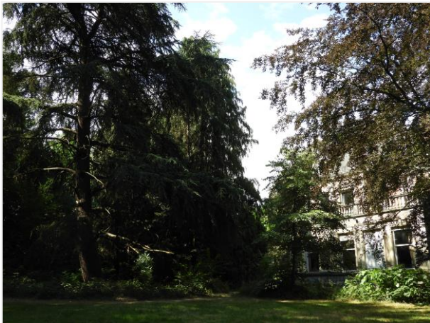
Foto 45: Zicht op oostgevel kasteel
