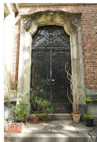
Foto 35: Kasteel, zuid- en oostgevel, detail van lagere uitbouw naar ontwerp van Spéder van 1950
