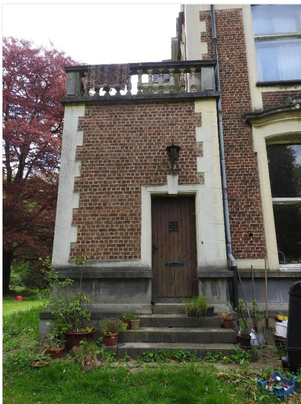
Foto 61: Kasteel, westgevel, op begane grond de eenlaagse uitbouw naar ontwerp van Spéder met bijkomende keldertoegang
