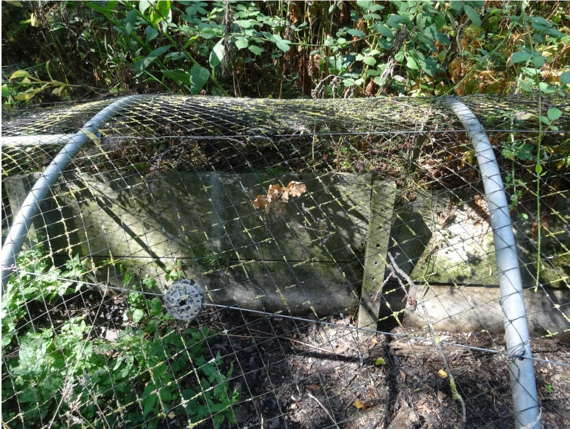
Foto 13: detail van nylon-gaasnet met spankabel boven half-cirkelvormige beugel in gegalvaniseerd buisframe bij de gereconstrueerde zuidoostelijke vangpijp (Meetkerke)
