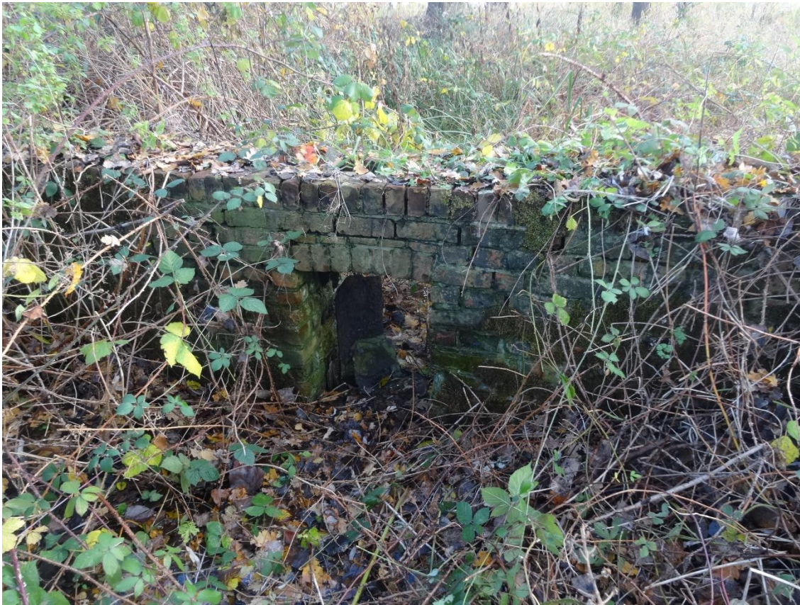
Foto 17: voormalig schuifje op de verbindingsgracht tussen het Sint-Andrieszwin en de kooiplas (Meetkerke)
