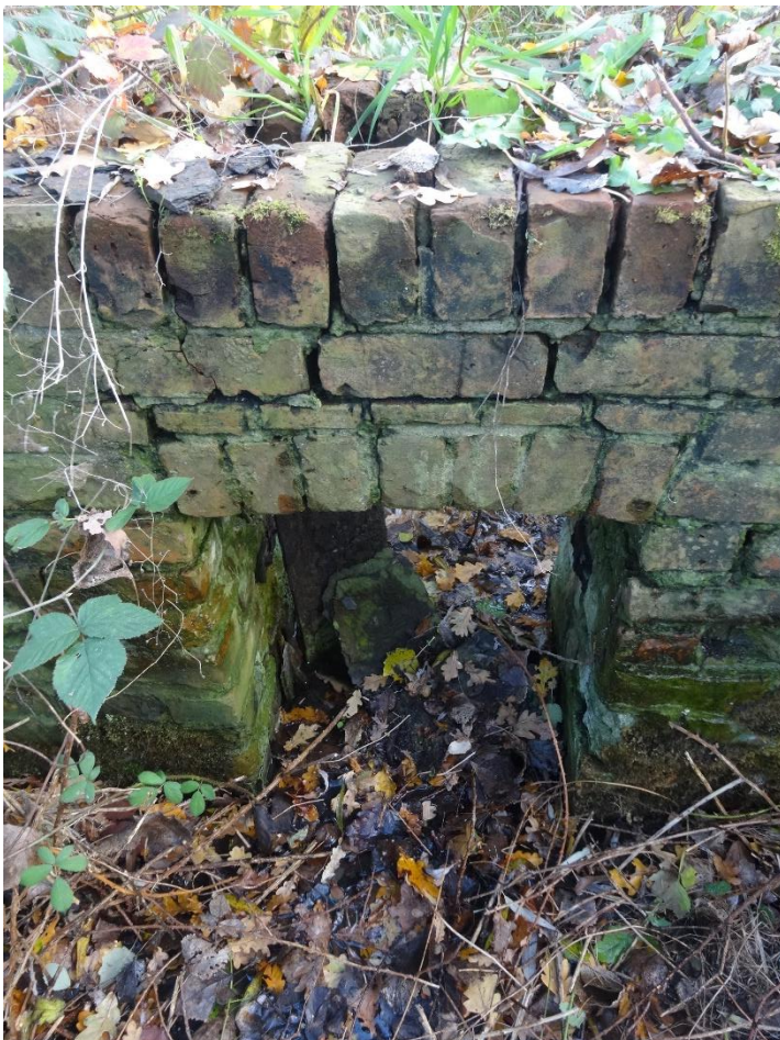
Foto 18: detail van het metselwerk en van het verweerde metalen schuifje ter hoogte van de doorstroomopening (Meetkerke)
