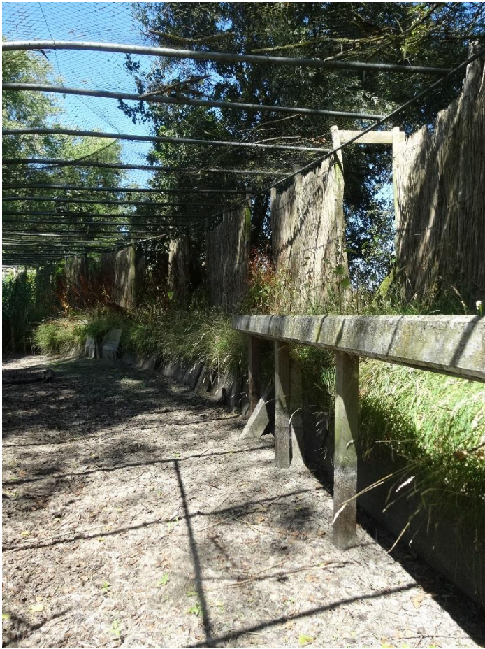
Foto 11: detail van de gereconstrueerde zuidoostelijke vangpijp volgens het Gelderse of Brabantse type met kwart-cirkelvormige beugels (Meetkerke)
