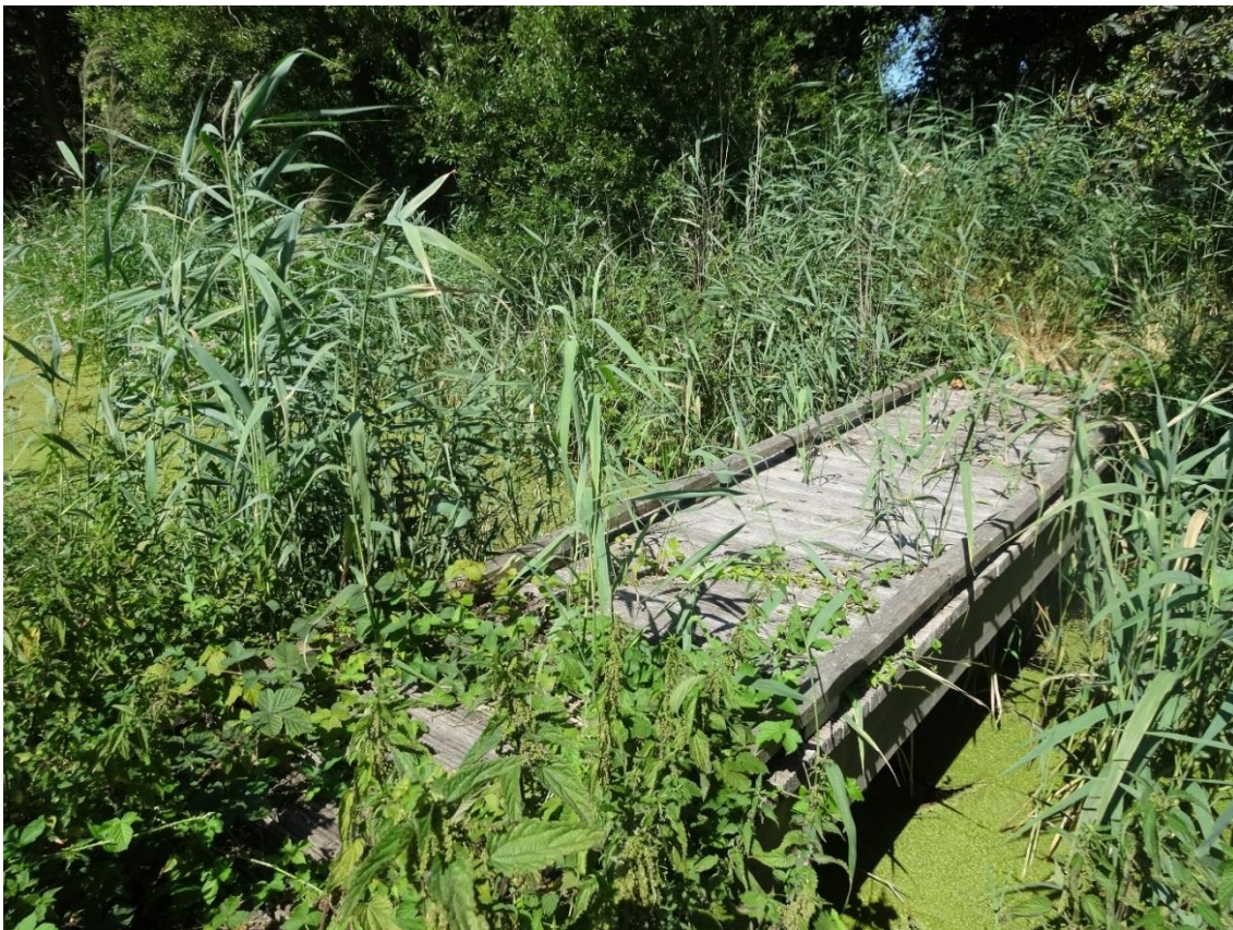
Foto 4: houten passerelle op betonnen liggers over het Sint-Andrieszwin met toegang tot de eendenkooi van Meetkerke (Sint-Andries-Brugge / Meetkerke)
