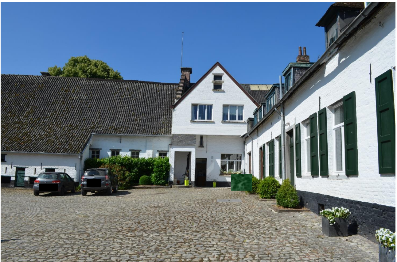
Foto 24: zicht op zuidwestelijke schuurvleugel aan de erfzijde: achtergevel van de hoofdwoning met vooruitspringende puntgevel geïntegreerd in de westelijke hoek van het hoevecomplex
