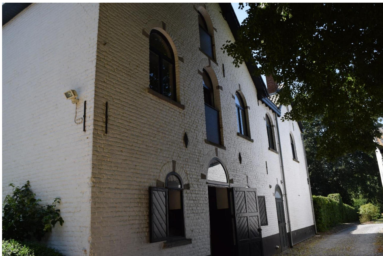
Foto 53: voorgevel van het bijgebouw, doorbroken door rondbogige muuropeningen op alle verdiepingen, ingericht als paardenstal met aanpalend een (vroegere) personeelswoning
