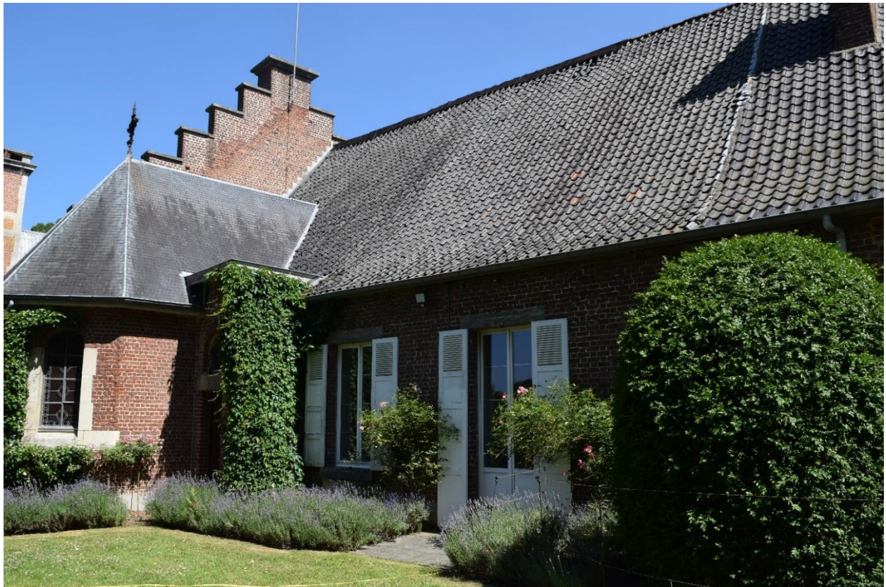
Foto 36: gedeelte van de schuur dat werd ingenomen door een woongedeelte of dienstwoning en werd toegevoegd aan de woning van 1926. De uiterst linker travée is uitgebouwd tot een huiskapel met driezijdige sluiting en zijlingse deurtravée.
