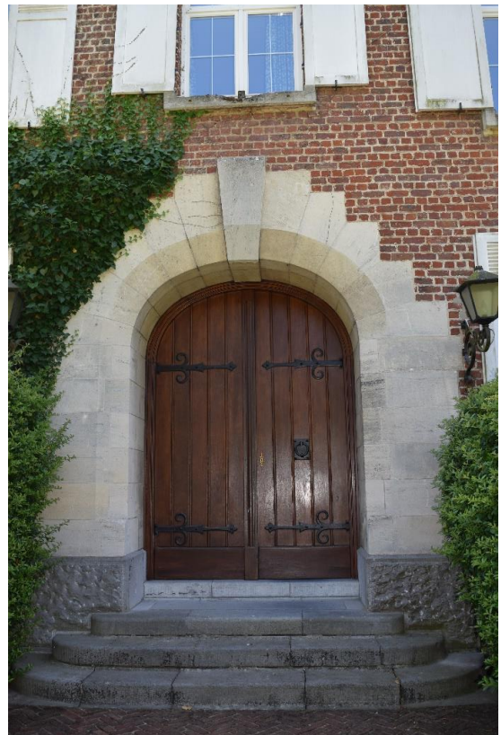
Foto 43: De rondboogvormige inkom wordt opvallend gekenmerkt door het gebruik van witte natuursteen voor de zware geblokte omlijsting met zware sluitsteen en rustend op een gebouchardeerde hardstenen voetstuk.
