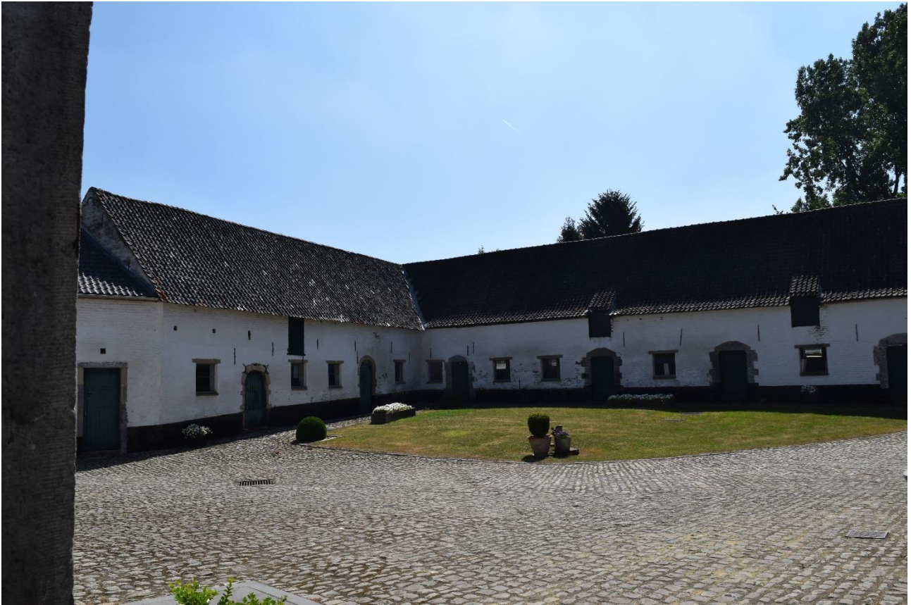
Foto 9: noordoostelijke en zuidoostelijke stalvleugels van anderhalve bouwlaag onder pannen zadeldaken met minstens 18de-eeuwse kern en 19de-eeuwse aanpassing.
