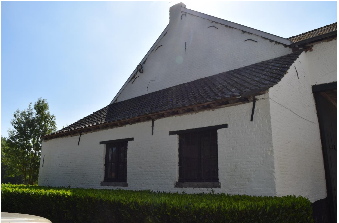
Foto 6: langs de inkomzijde (links van de noordelijke toegangspoort) een 19de-eeuwse aanbouw onder lessenaarsdak bij de kopse vleugel van het kleine bouwvolume bij de noordwestelijke stalvleugel
