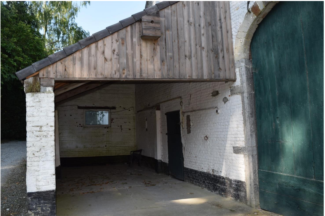
Foto 29: links van de schuurpoort, een aangepaste open bakstenen wagenberging onder lessenaarsdak, die een houten toegangsdeur in de zuidelijke kopse zijgevel van de schuur verbergt
