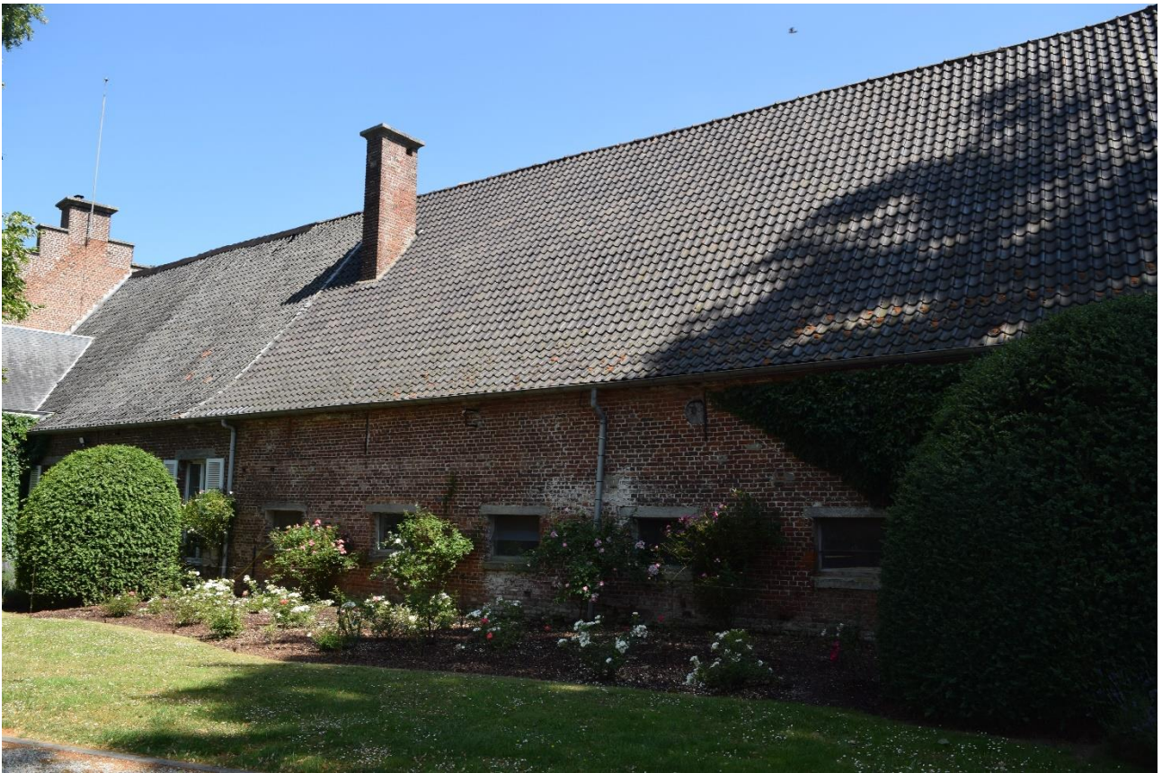
Foto 35: achtergevel van de zuidwestelijke schuurvleugel gericht naar de zuidelijk gelegen siertuin; het westelijk of het hier linker bouwdeel van de schuur werd verbouwd tot woonruimte met huiskapel (bouwnaad)
