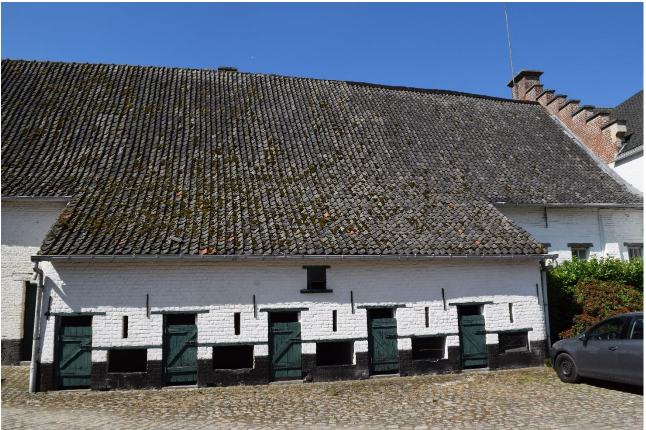
Foto 21: Aan de erfzijde is een jongere aanbouw onder zwartpannen lessenaarsdak toegevoegd aan de schuur; de gevel wordt doorbroken door vijf lage geklante deurtjes, luchtgaten en lage vensteropeningen; vroeger in gebruik als (varkens)stallen
