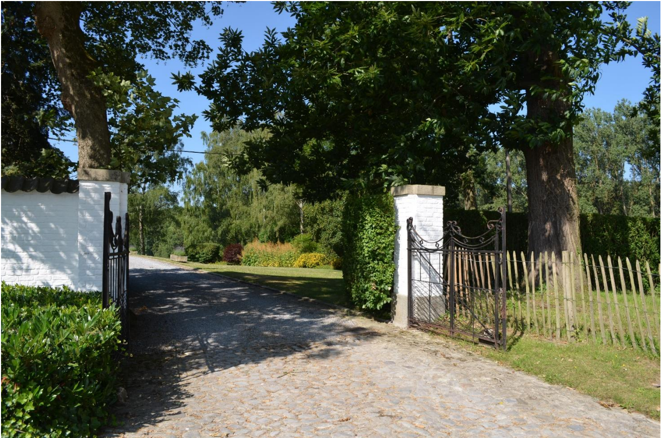
Foto 48: zicht op de hekpijlers en hekken als toegang tot de siertuin.
