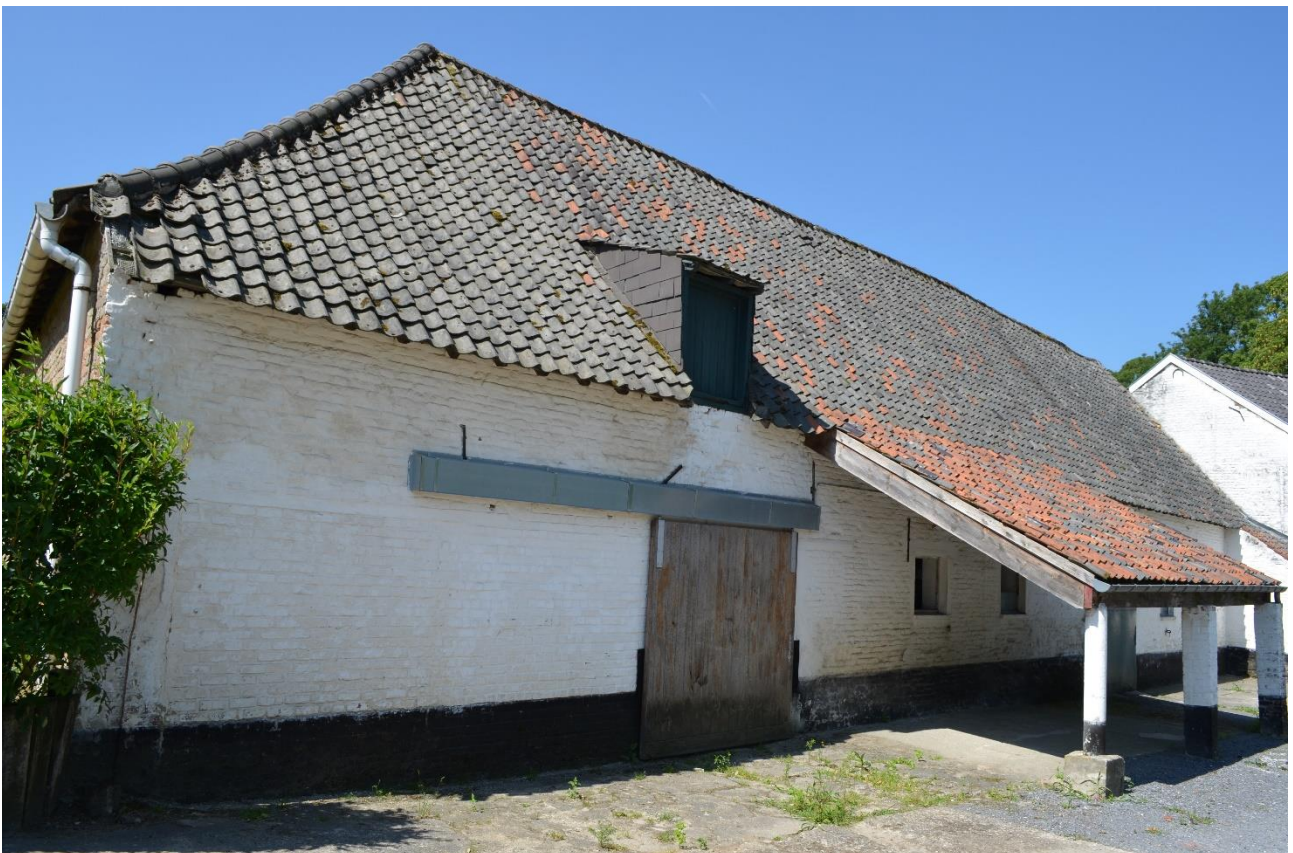
Foto 32: noordoostelijke stalvleugel: zicht op oostelijke hoek gericht naar de veldzijde met jongere metalen schuifpoort en vierkante vensteropeningen, en met aansluitend een toegevoegde open wagenberging op palen onder pannen lessenaarsdak
