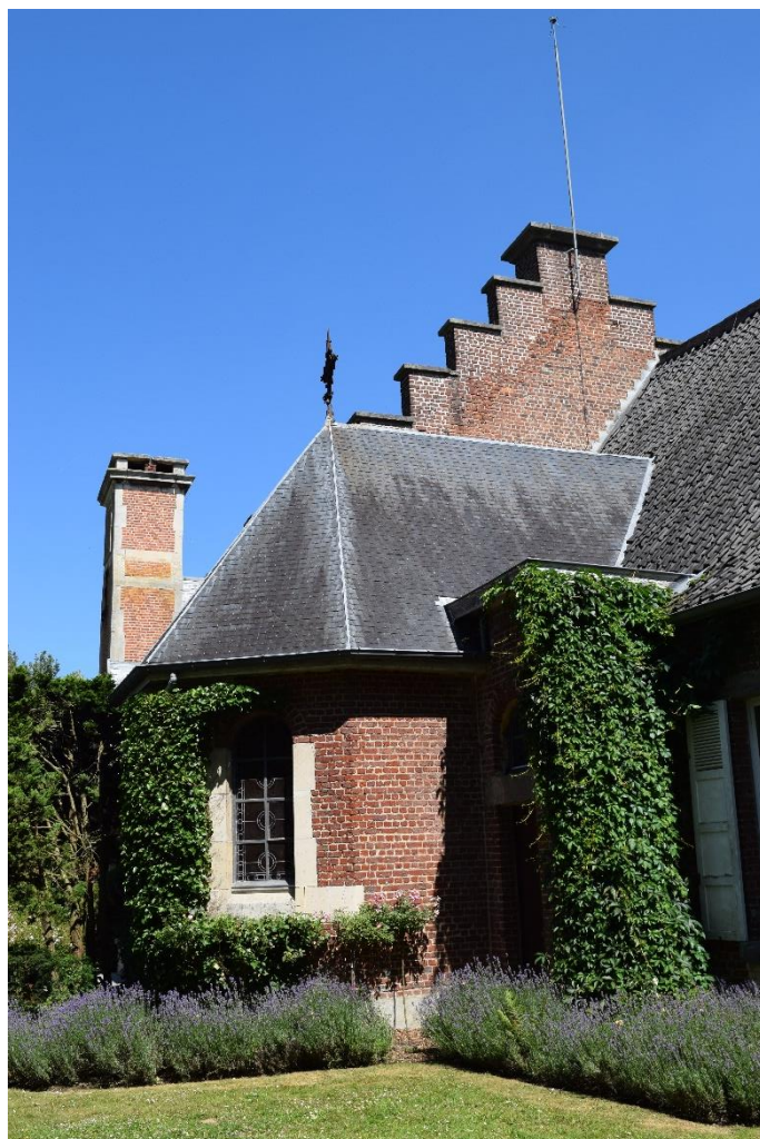
Foto 37: uitspringende huiskapel uit het begin van de 20ste-eeuw ingewerkt in de schuurvleugel, die door een trapgevel wordt afgescheiden van de interbellumwoning in de westhoek
