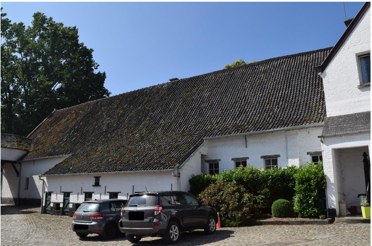
Foto 22: het rechter schuurgedeelte is doorbroken door vier vensteropeningen en werd ingenomen als woningruimte en toegevoegd aan de interbellumwoning in de westhoek (rechterzijde)
