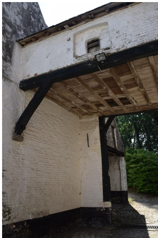
Foto 18: zuidelijke veldpoort met balkenzoldering op dwarsbalk met korbeel en met gekasseide doorgang
