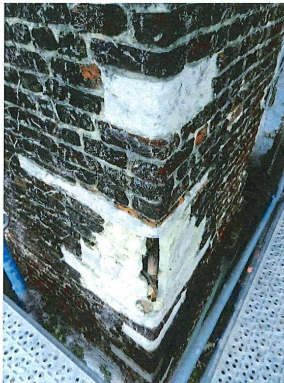
Foto 9: schietgat in één van de hoeken van het Spaans Toreken, ter hoogte van de gelijkvloerse verdieping.
