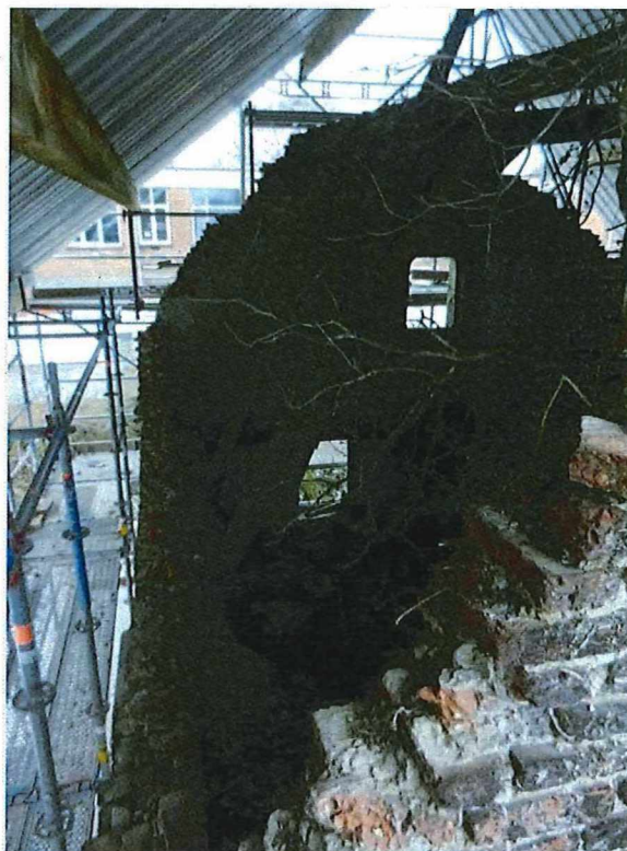
Foto 19: zicht op de westelijke topgevel (voorgrond), de noordelijke langsgevel en de oostgevel.
