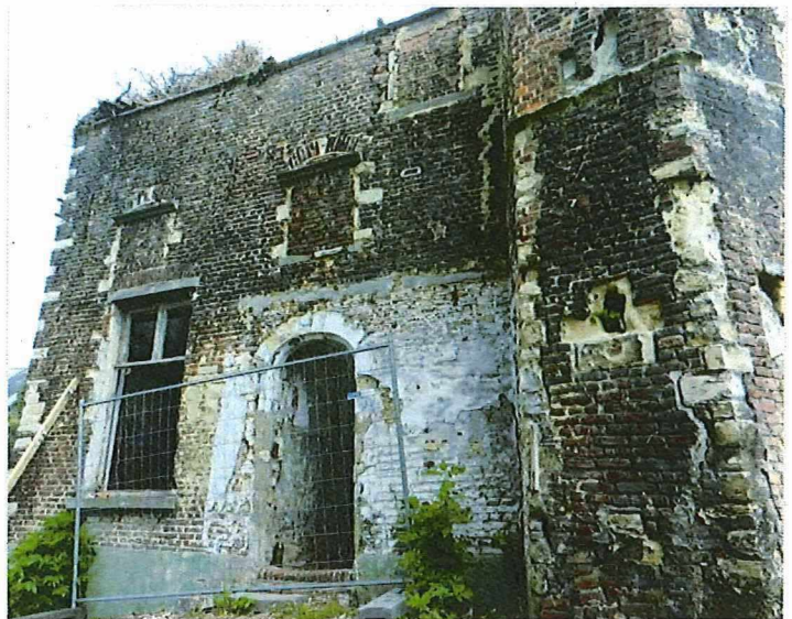
Foto 6: zuidgevel van het Spaans Toreken, met traptoren op de zuidoosthoek.
