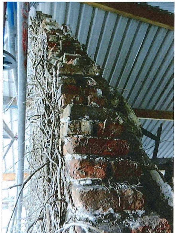
Foto 16: westelijke topgevel (zuidzijde).
