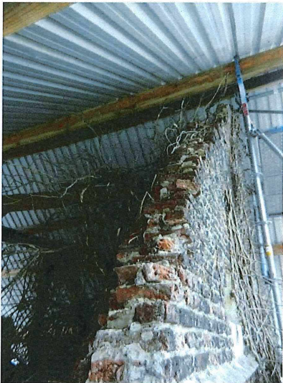
Foto 15: westelijke topgevel (noordzijde).
