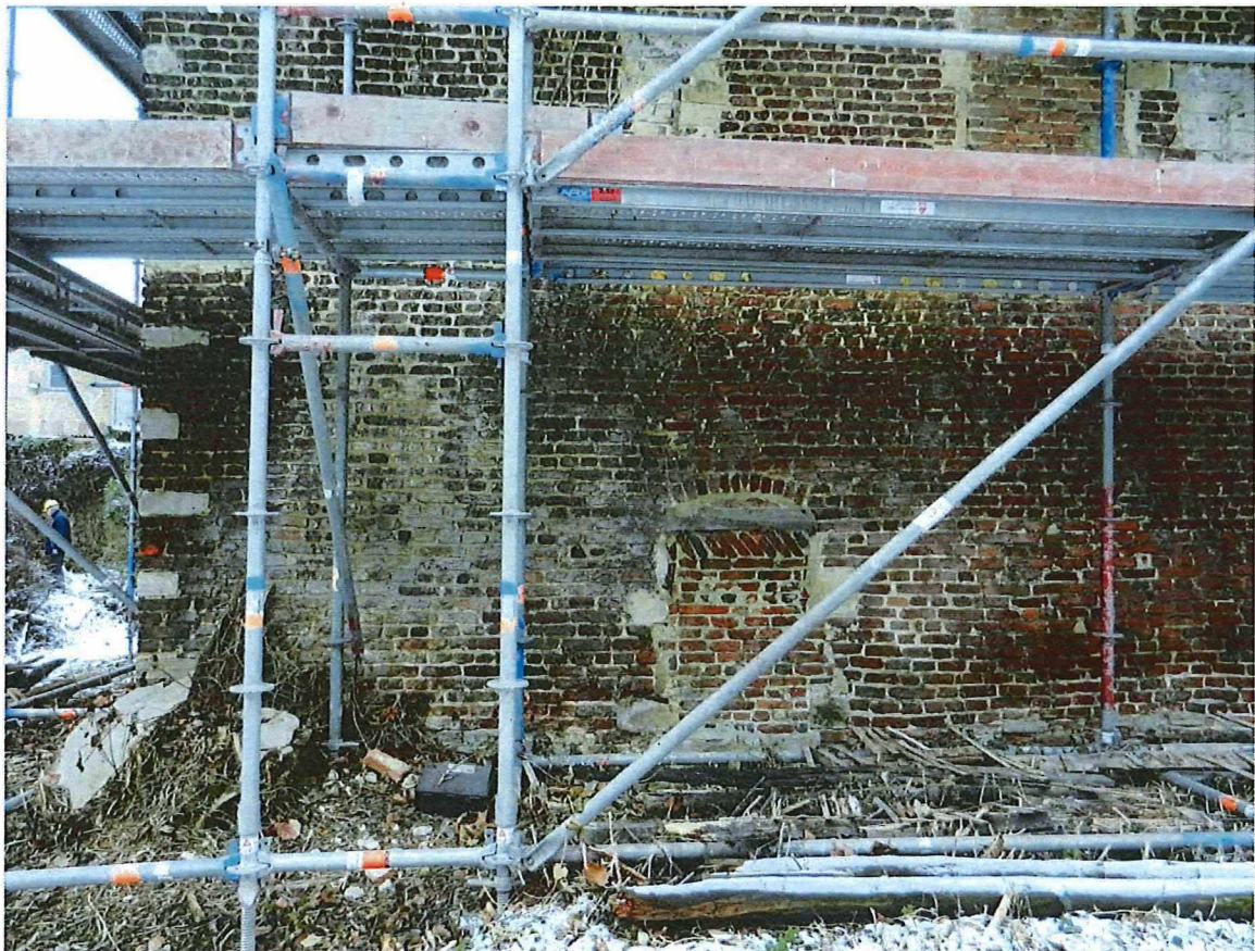
Foto 7: noordgevel met gedicht oorspronkelijk keldergat.
