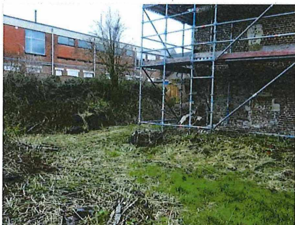
Foto 20: zicht op de noordgevel van het Spaans Toreken, met op de voorgrond het verzonken tracé van de vroegere walgracht.
