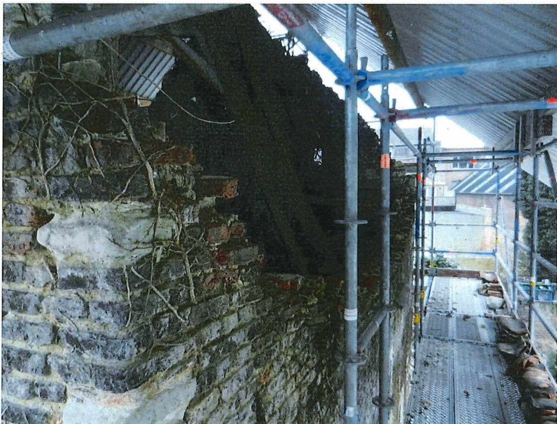
Foto 17: de noordelijke langsgevel ter hoogte van de zolderverdieping.
