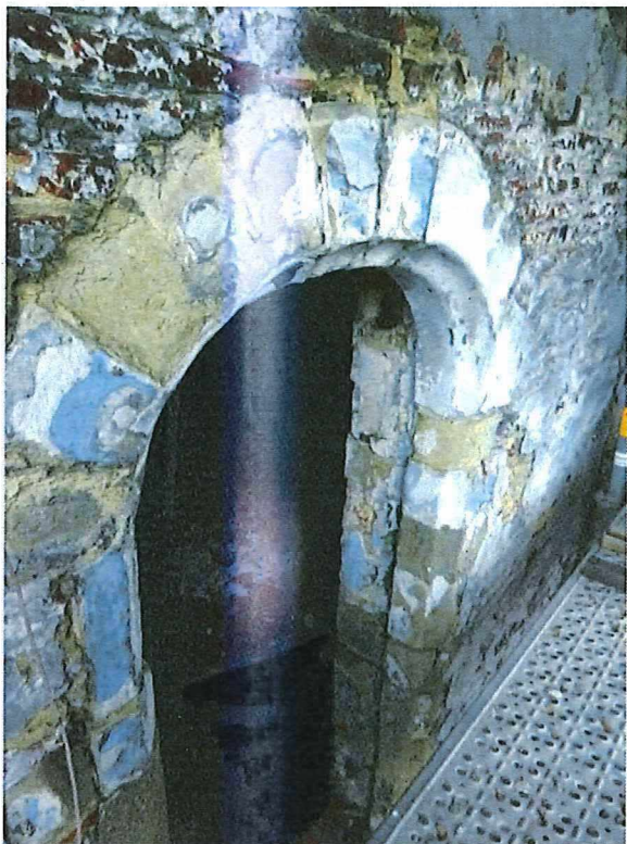
Foto 8: oorspronkelijke deuropening in de zuidgevel.
