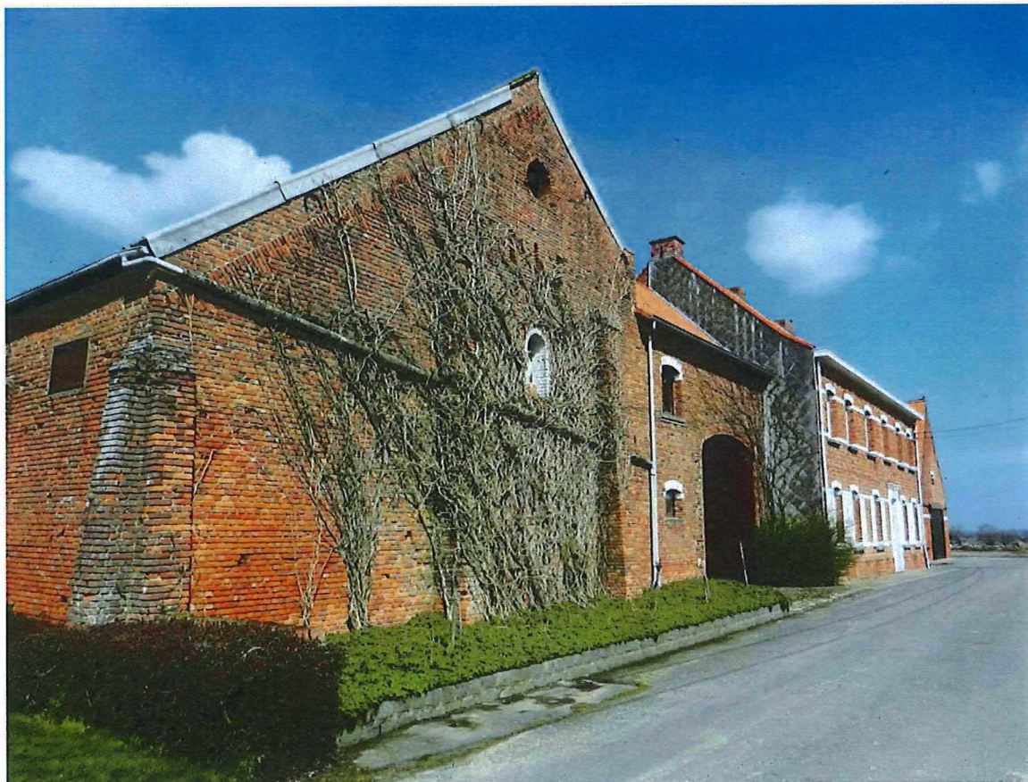
Foto 4: de gevelwand van de hoeve aan de Pont Malletstraat, met de voorgevels van de schuur, het poortgebouw en het woonhuis.
