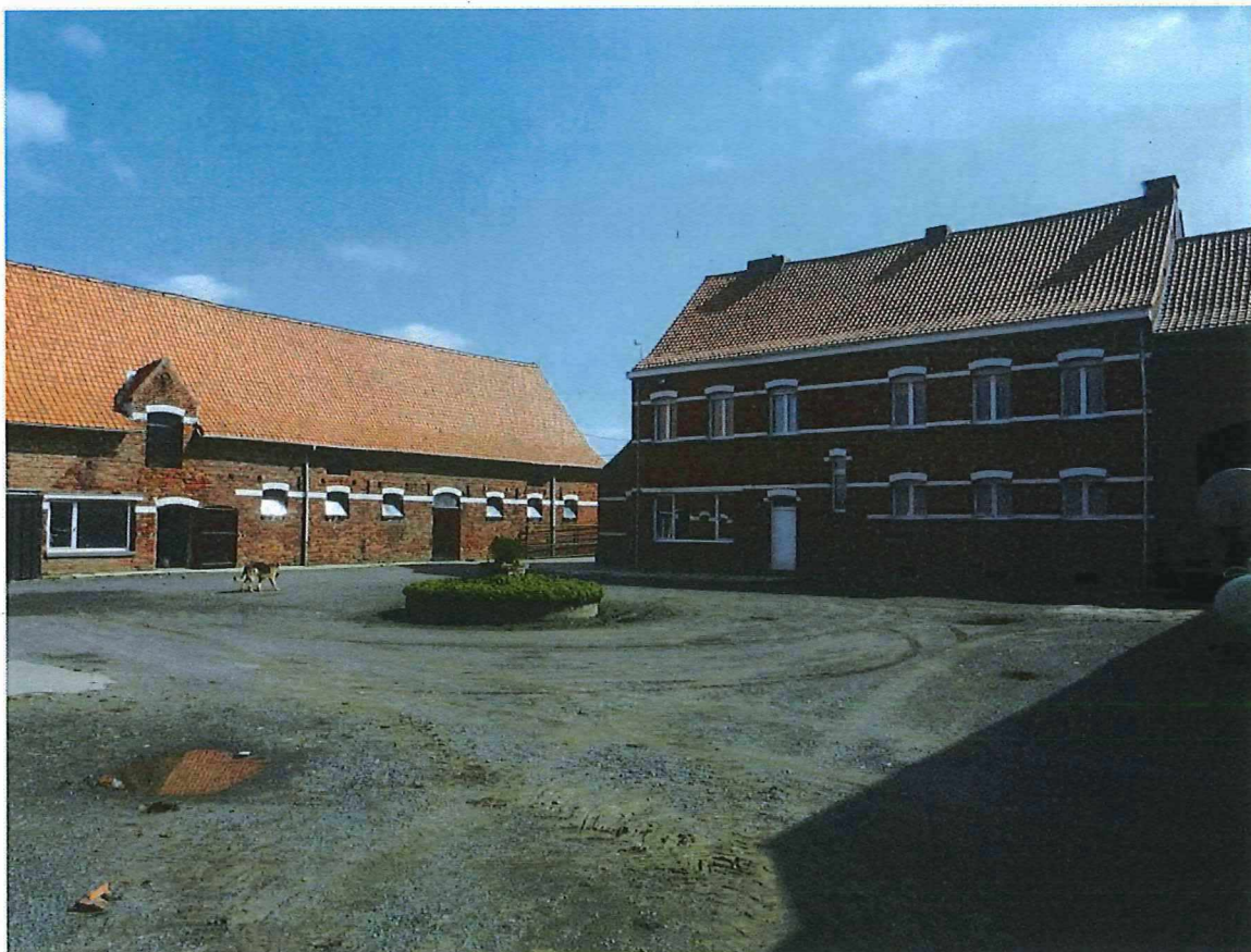
Foto 8: zicht op de oostelijke stalvleugel en het woonhuis.
