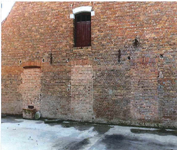
Foto 30: de oostgevel van de noordvleugel.
