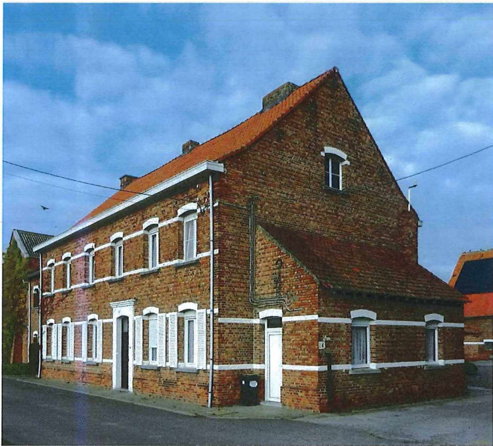
Foto 5: de voorgevel van het woonhuis, met achterkeuken tegen de oostzijde.
