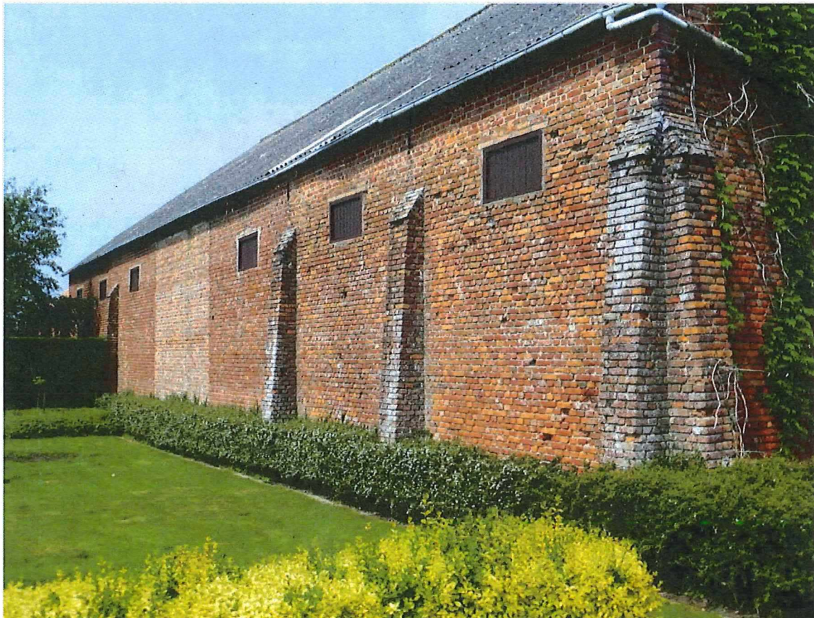
Foto 16: de westelijke langsegevel van de schuur, met gedichte poortopening.
