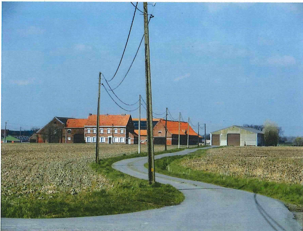
Foto 2: zicht op de hoeve vanuit het zuiden.
