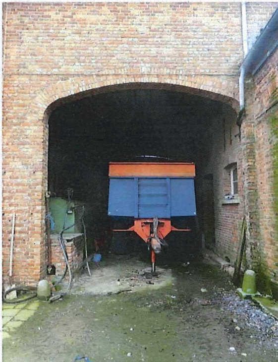
Foto 23: de doorrit van het poortgebouw aan de erfzijde.
