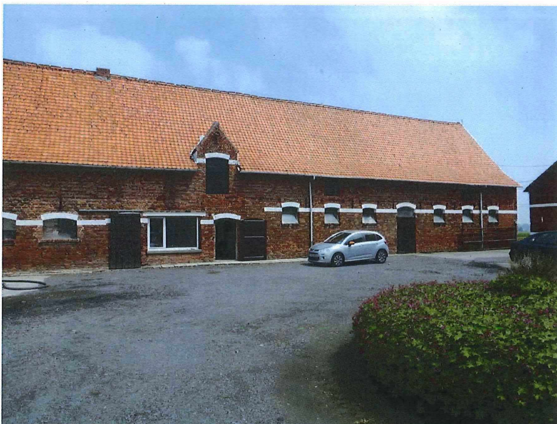
Foto 10: zicht op de oostelijke stalvleugel.
