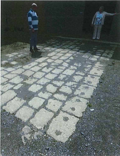
Foto 21: hergebruikte abristenen voor de poort van de schuur (erfzijde).
