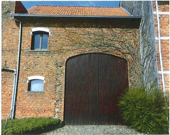
Foto 22: het poortgebouw aan de straatzijde.
