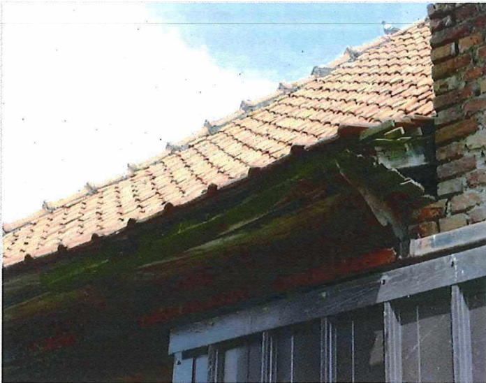
Foto 11: oorspronkelijke dakrand op modillons van de overdekte mestvaalt.
