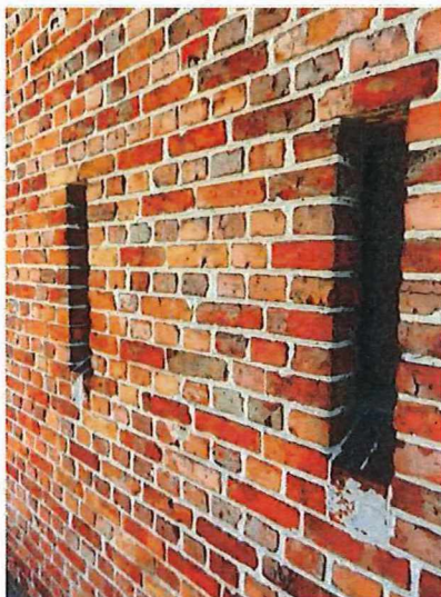
Foto 21: verluchtingsspleten in de voorgevel van de schuur, met bakstenen afzaten.
