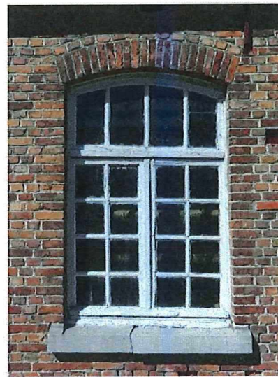
Foto 16: venster in de voorgevel met oorspronkelijk schrijnwerk.
