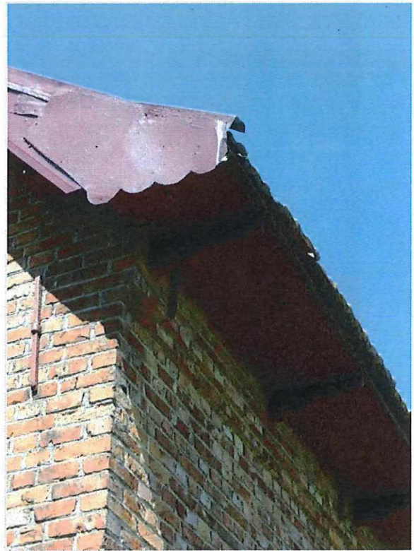
Foto 20: zuidelijke dwarsgevel van de schuur, met zinken bekleding van het aandak.
