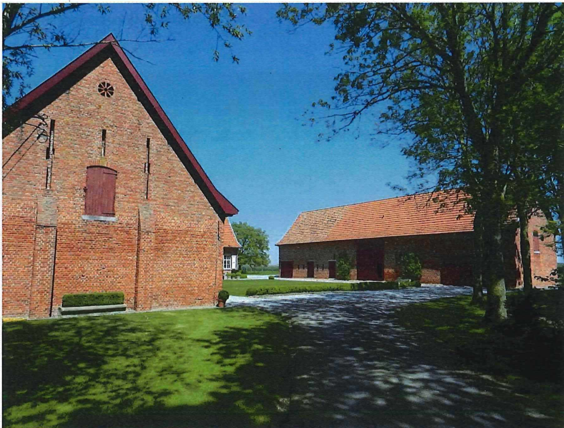
Foto 5: de toegang tot de binnenkoer van de hoeve. Links de westvleugel met de stallen, rechts de schuur.
