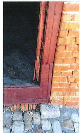
Foto 23: voorgevel van de schuur, met oorspronkelijk poortluik op betonnen draaisteen. De dorpel in baksteen is eveneens oorspronkelijk.
