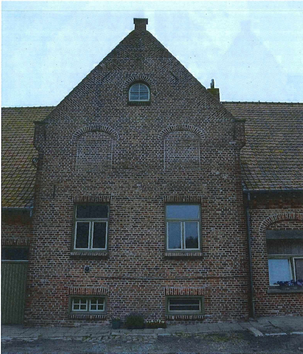
Foto 7: Hoeve 'Oosthof'. Boerenhuis. Erfgevel, juni 2018 (Onroerend Erfgoed)
