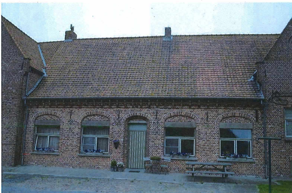
Foto 8: Hoeve 'Oosthof'. Boerenhuis. Erfgevel, juni 2018 (Onroerend Erfgoed)
