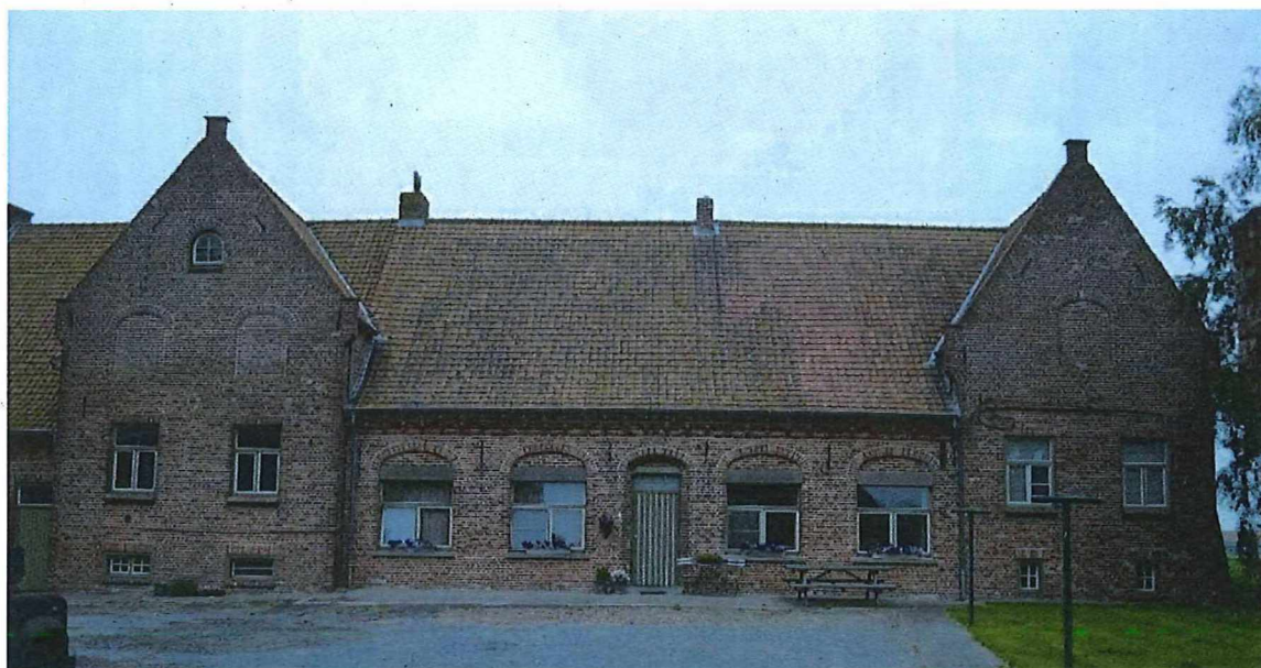
Foto 6: Hoeve 'Oosthof'. Boerenhuis. Erfgevel, juni 2018 (Onroerend Erfgoed)
