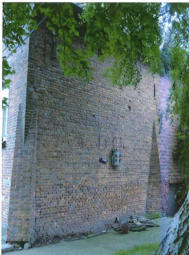
Foto 10: Hoeve 'Oosthof'. Boerenhuis. Erfgevel, juni 2018 (Onroerend Erfgoed)
