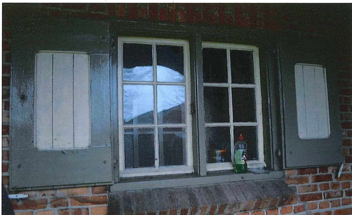
Foto 16: Hoeve 'Oosthof'. Boerenhuis. Achter- of oostgevel. Authentiek raam en luiken in arcade, juni 2018 (Onroerend Erfgoed)
