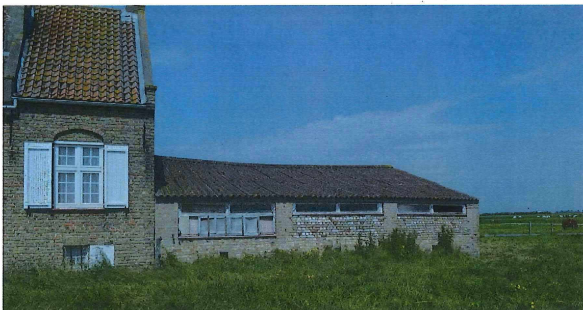
Foto 10: Hoeve 't Geuzegat'. Boerenhuis. Tegen oostgevel aangebouwde stal, mei 2018 (Onroerend Erfgoed)
