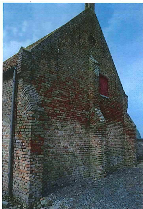
Foto 20: Hoeve 't Geuzegat'. Schuurvleugel. Oostgevel, mei 2018 (Onroerend Erfgoed)
