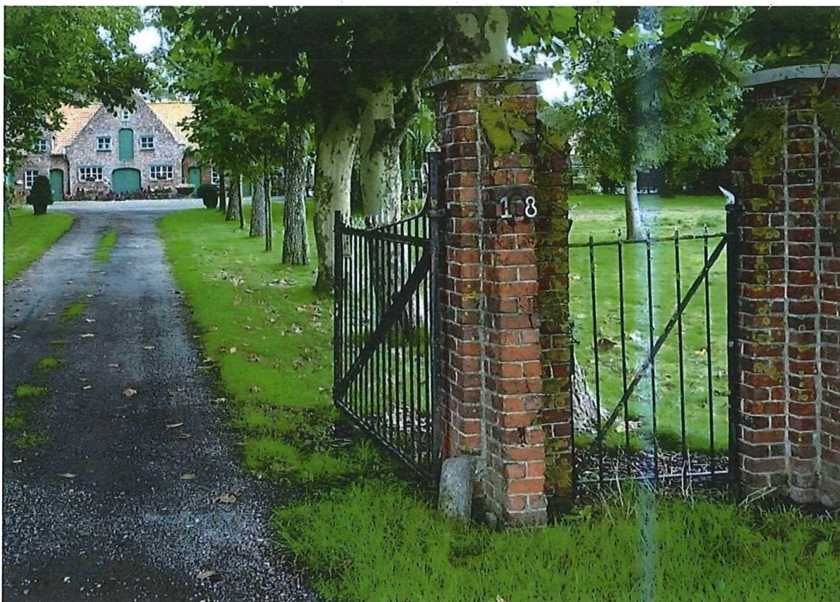
Foto 5: statige toegang met pijlers en hekken aan de straatzijde. De bakstenen pijlers zijn voorzien van schuin oplopende steunberen en van schamppalen ter hoogte van de doorrit voor rijtuigen (30.08.2018).
