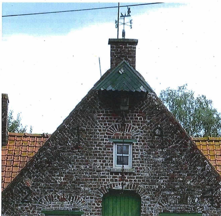
Foto 25: de tuitgevel van de voeder- en de machinekamer is met jaarankers "1924" gedateerd - de hijskap onder pannen zadeldakje is afgewerkt met een houten windplank (30.08.2018).
