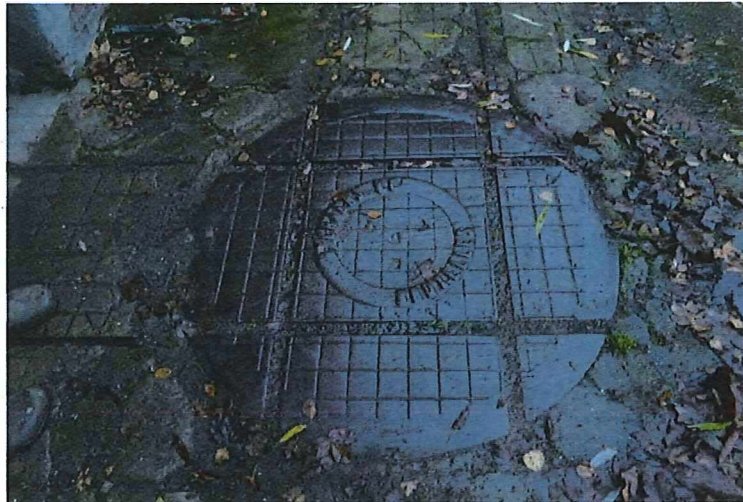
Foto 28: smalspoor voor de stallen - wissel of draaicirkel voor voeder- en machinekamer (met breuk) - opschrift "R. Eraers & Co, Bruxelles" (19.04.2018).
