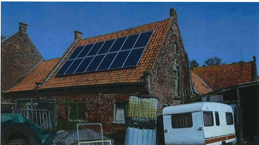
Foto 40: achterzijde of zuidzijde van de hoeve, meer bepaald de kalverstal met deels bewaard houtwerk - rechts in beeld, het vooruitspringende dakvolume van de voeder- en machinekamer (19.04.2018).
