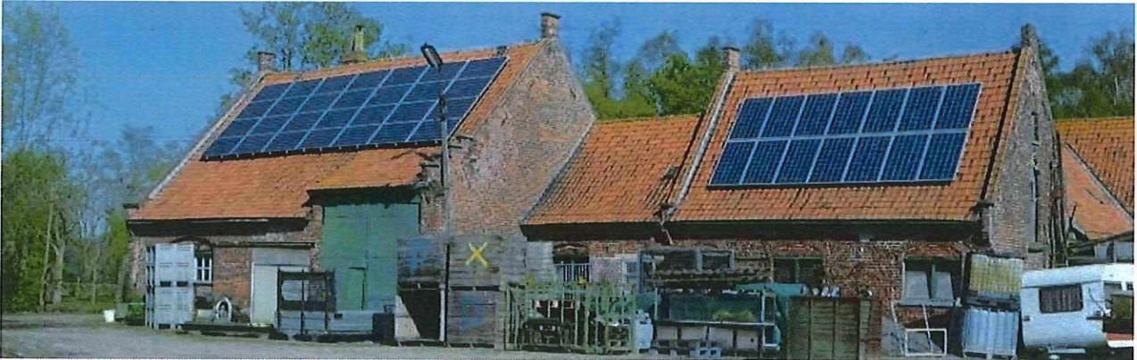
Fot 38: achterzijde of zuidzijde van de hoeve met links het hogere schuurvolume met geïncorporeerd koets- en wagenhuis - links van de schuurpoort onder hogere dakoverstek geeft een recente garagepoort de plaats van de oorspronkelijke garage aan - rechts sluit de lagere kalverstal aan (19.04.2018).
