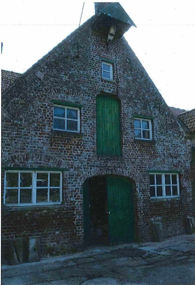
Foto 26: volume van voeder- en machinekamer met korfboogpoort, geflankeerd door stalvensters onder houten latei en korfbogige ontlastingsboog (19.04.2018).
