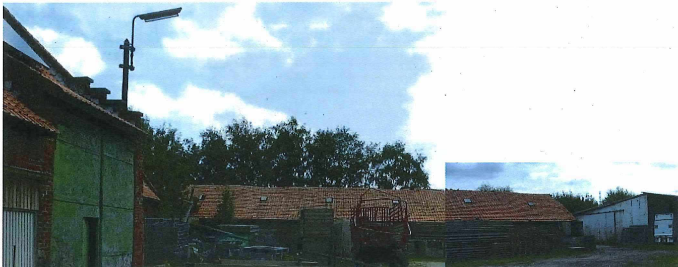
Foto 48: zicht vanaf de achtergevel van de schuur op het langgestrekte volume van de varkensstal - roodpannen zadeldak met kleine ijzeren dakvenstertjes - zicht op de recente loods ten zuidoosten van de varkensstal (geen erfgoedwaarde) (30.08.2018).
