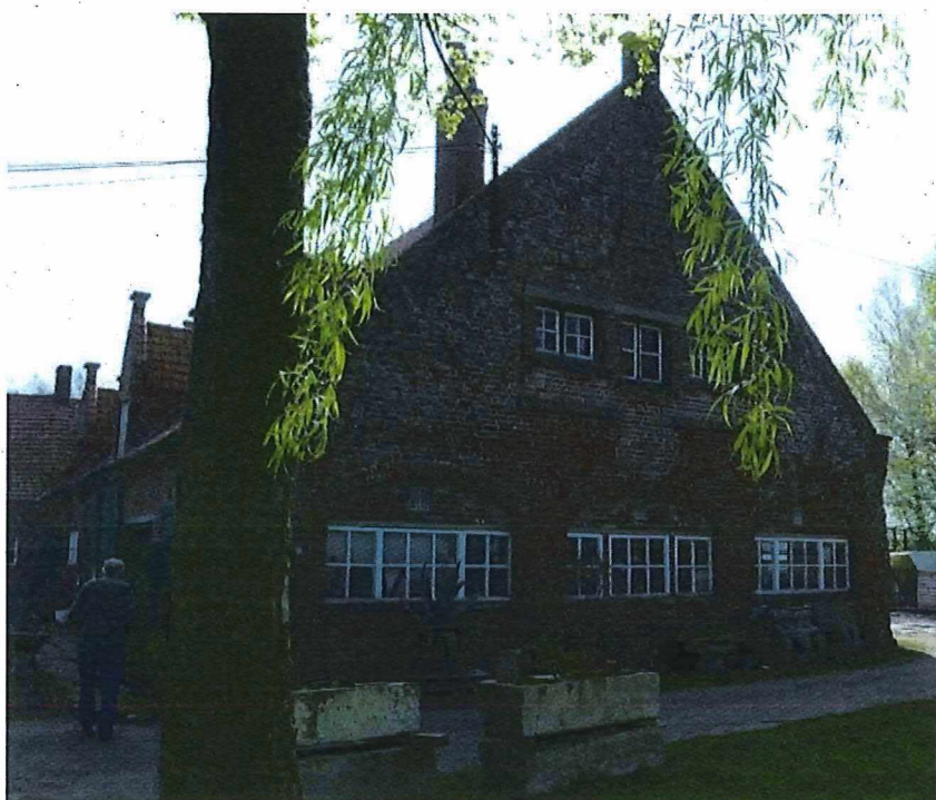
Foto 33: zijtuitgevel van de schuur met geïncorporeerd koets- en wagenhuis - de drie deels dichtgemetselde korfboogpoorten voor de toegang van wagens en koetsen zijn nog afleesbaar (19.04.2018).
