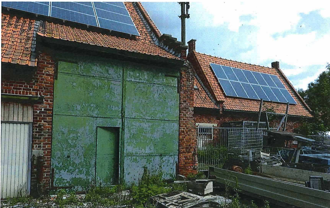
Foto 39: achterzijde of zuidzijde van de dwarsschuur - schuurpoort onder hogere dakoverstek met steunbeer en getrapte aanzet van de zijgevel (30.08.2018).
