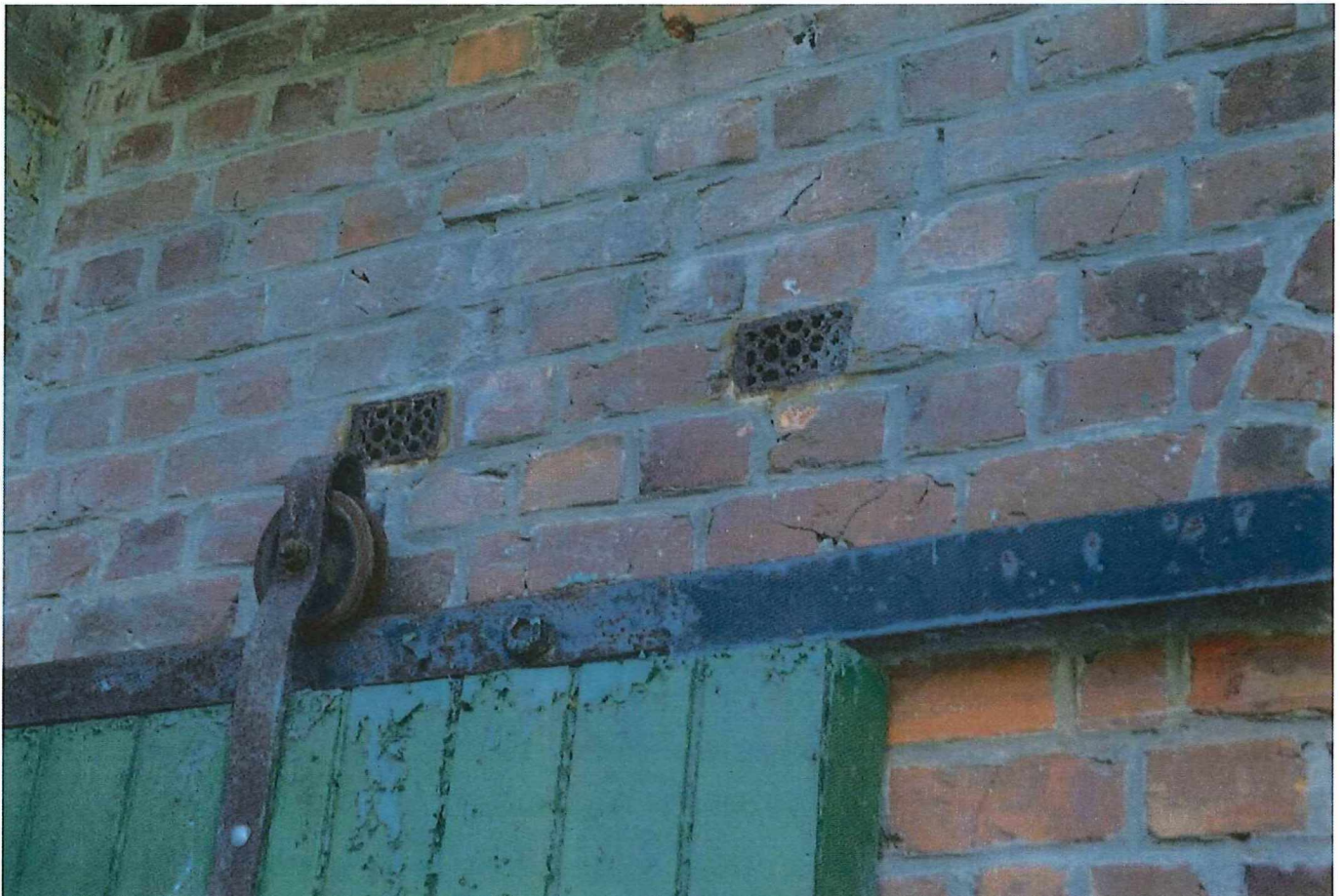
Foto 30: kalverstal (erfzijde) detail van schuifpoort met metalen rail en wieltjes - boven de rail voorbeeld van metalen geperforeerde verluchtingsroosters in baksteenvorm (19.04.2018).
