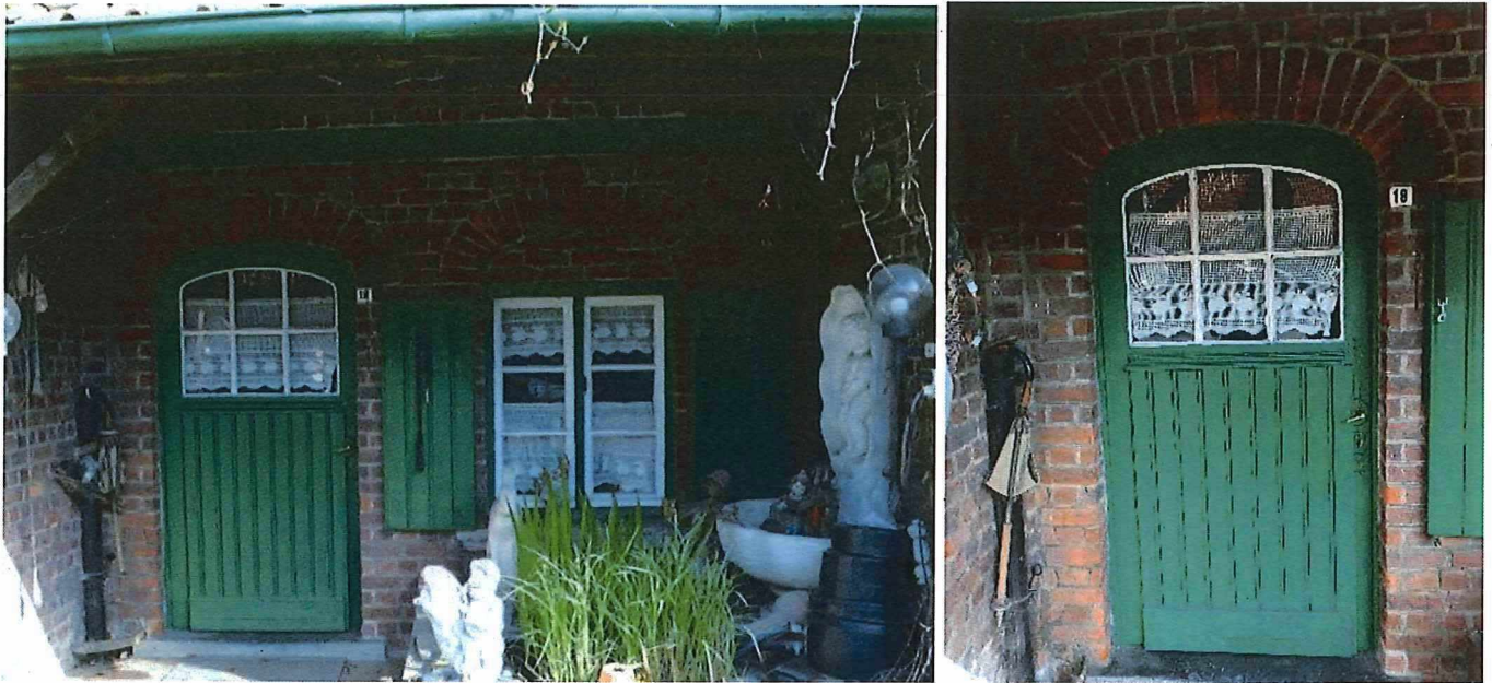
Foto 21: lagere volume met deur voor de landbouwer met oorspronkelijke deur, venster en luiken - ijzeren I-profiel met rozetvormige bouten boven de muuropeningen (30.08.2018). Foto 22: groenbeschilderde deur met beglaasd bovenlicht (30.08.2018).
