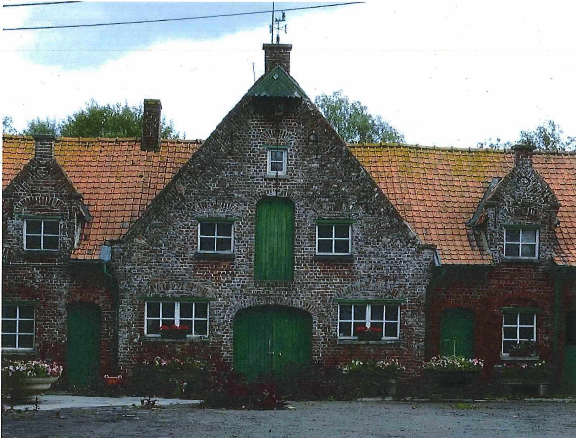
Foto 24: het volume met voeder- en machinekamer is uitgewerkt met een sierlijke tuitgevel met superpositie van poort, laaddeur en hijskap, en jaarankers "1924" (30.08.2018).
