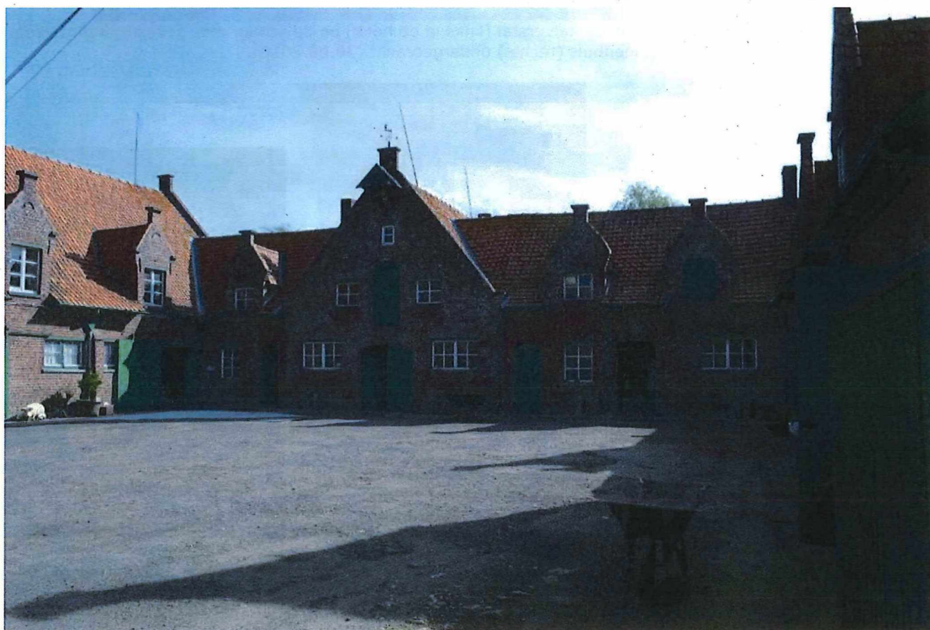
Foto 12: de asymmetrische oostvleugel wordt bepaald door de vooruitspringende voeder- en machinekamer met brede tuitgevel, korfboogpoort en hijskap. Deze wordt links geflankeerd door het melkhuys, rechts door de paardenstal (19.04.2018).
