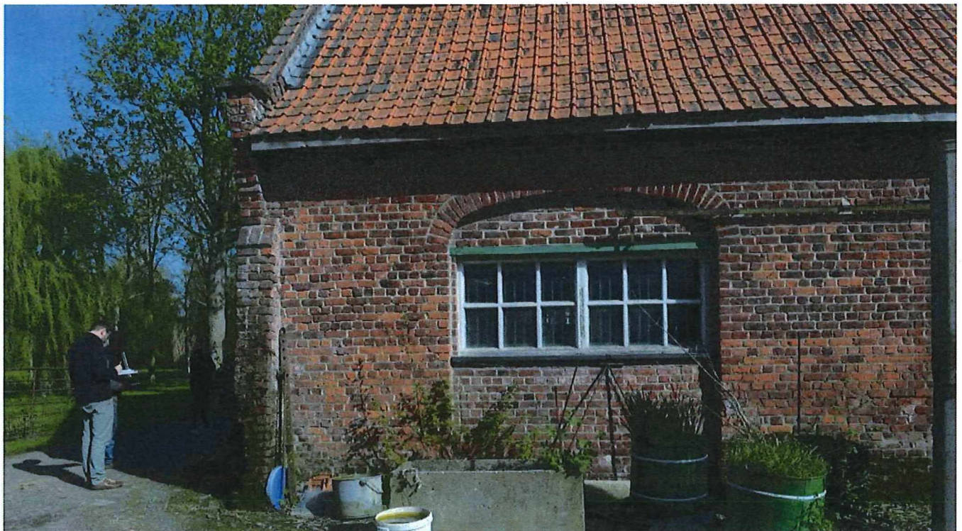
Foto 37: achter- of zuidgevel van het koets- en wagenhuis, geïncorporeerd in het schuurvolume – korbboognis met rechthoekig venster (19.04.2018).
