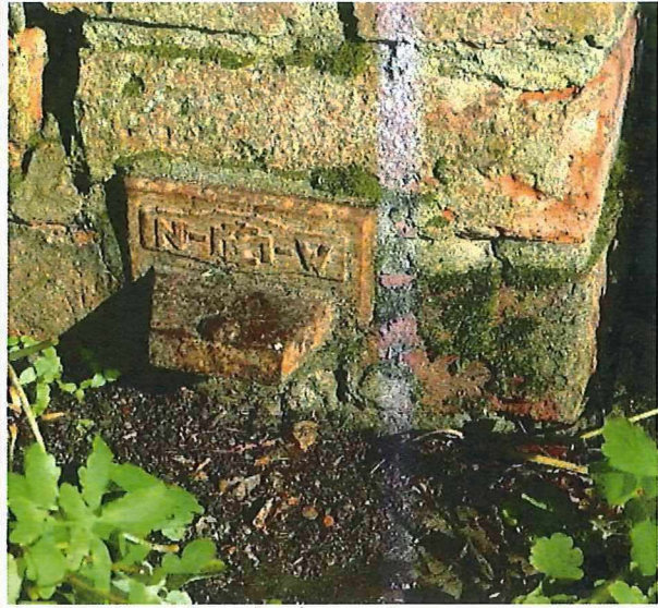
Foto 17: steunbeer op de hoek van de eindgevel en de langse gevel van de herenwoning – schouderstuk van de tuitgevel (30.08.2018).
