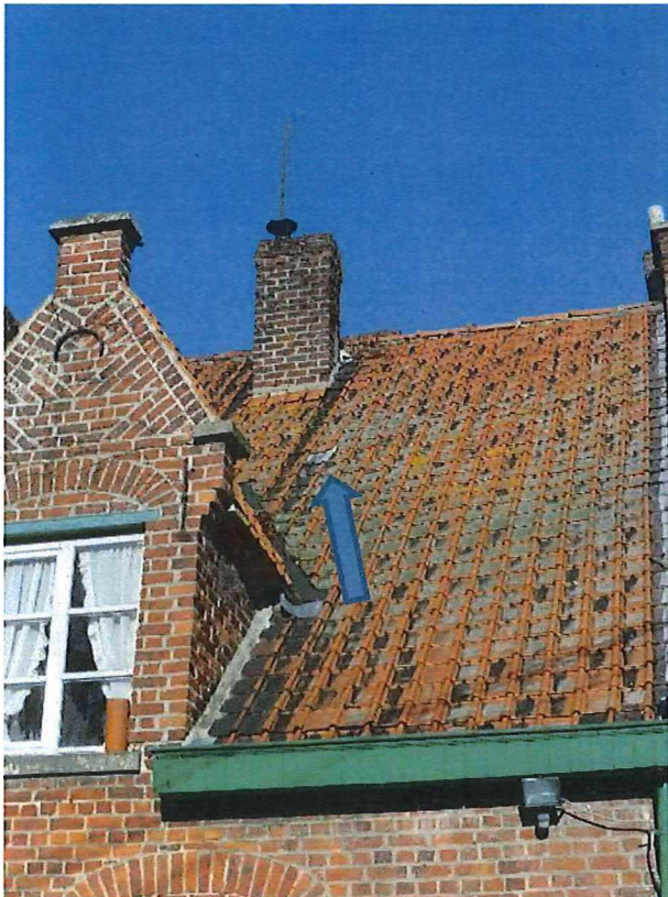
Foto 19. overloop van het waterreservoir in het dak van de herenwoning (aangeduid met pijl, 30.08.2018).
