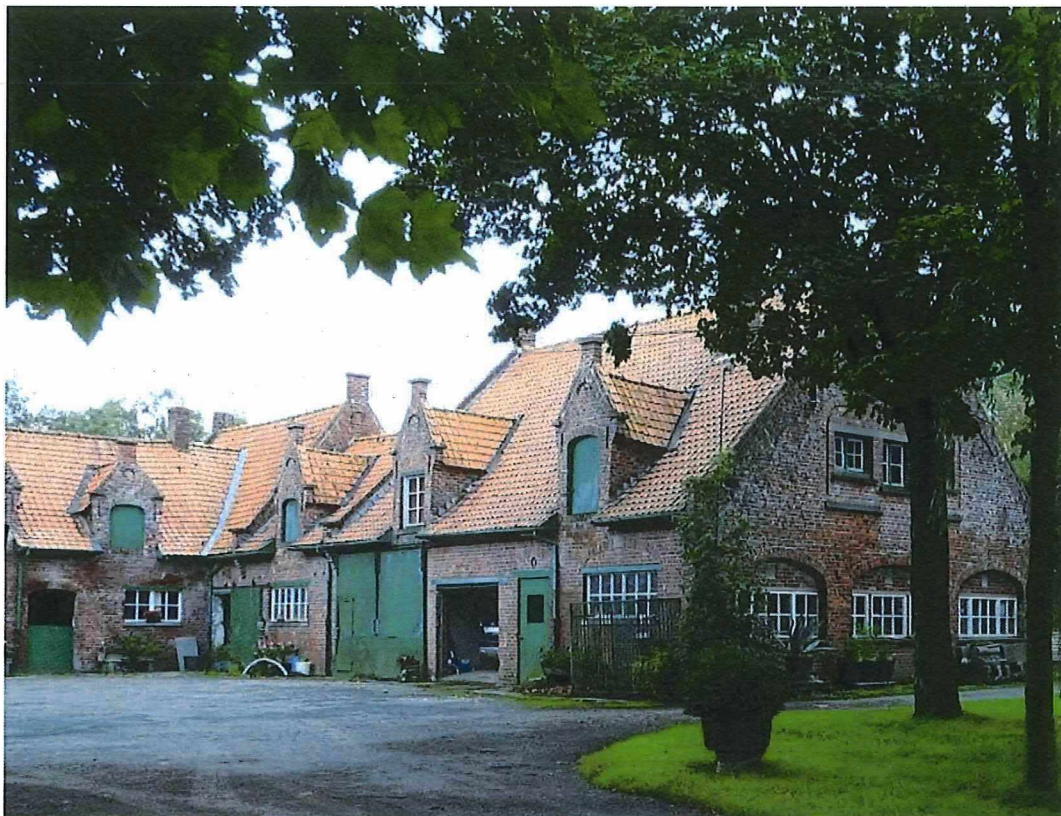
Foto 13: in de haakse zuidvleugel zijn de kalverstal (links in de hoek) en de schuur met geïncorporeerd koets- en wagenhuis (rechts) ondergebracht (30.08.2018).
