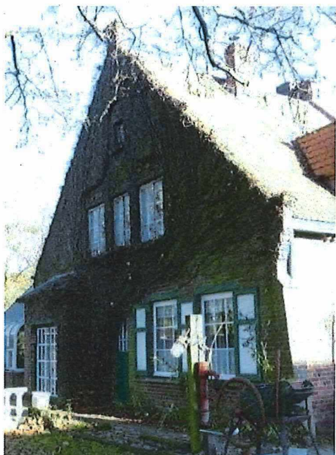
Foto 14: brede zijtuitgevel van de herenwoning – de gekoppelde bovenvensters en het venstertje daarboven zijn gevat in een zogenaamde Brugse travee - de oorspronkelijke erker links van de deur is voorzien van een gewijzigde muuropening (19.04.2018).
