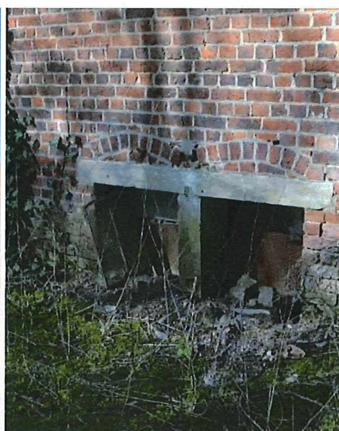
Foto 52: zuidelijke zijgevel van de varkensstal, een deel van de oorspronkelijk overkragende dakrand is bewaard - oostelijke langse gevel met uitlooptuikje (19.04.2018). Foto 53: gekoppelde uitlooptuikjes in de lange gevels van de varkensstal (19.04.2018).
