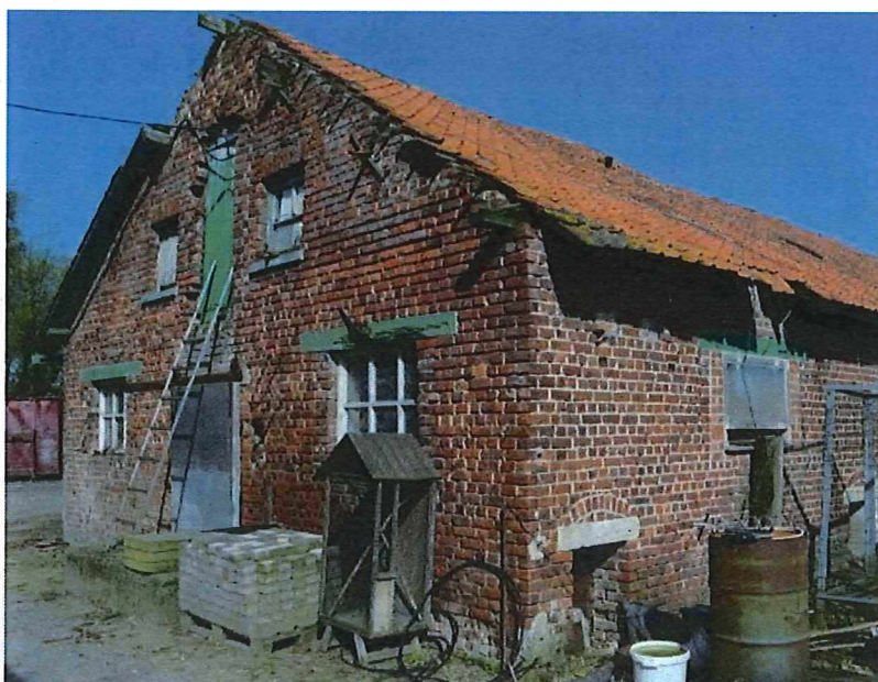
Foto 52: zuidelijke zijgevel van de varkensstal, een deel van de oorspronkelijk overkragende dakrand is bewaard - oostelijke langse gevel met uitlooptuikje (19.04.2018). Foto 53: gekoppelde uitlooptuikjes in de lange gevels van de varkensstal (19.04.2018).
