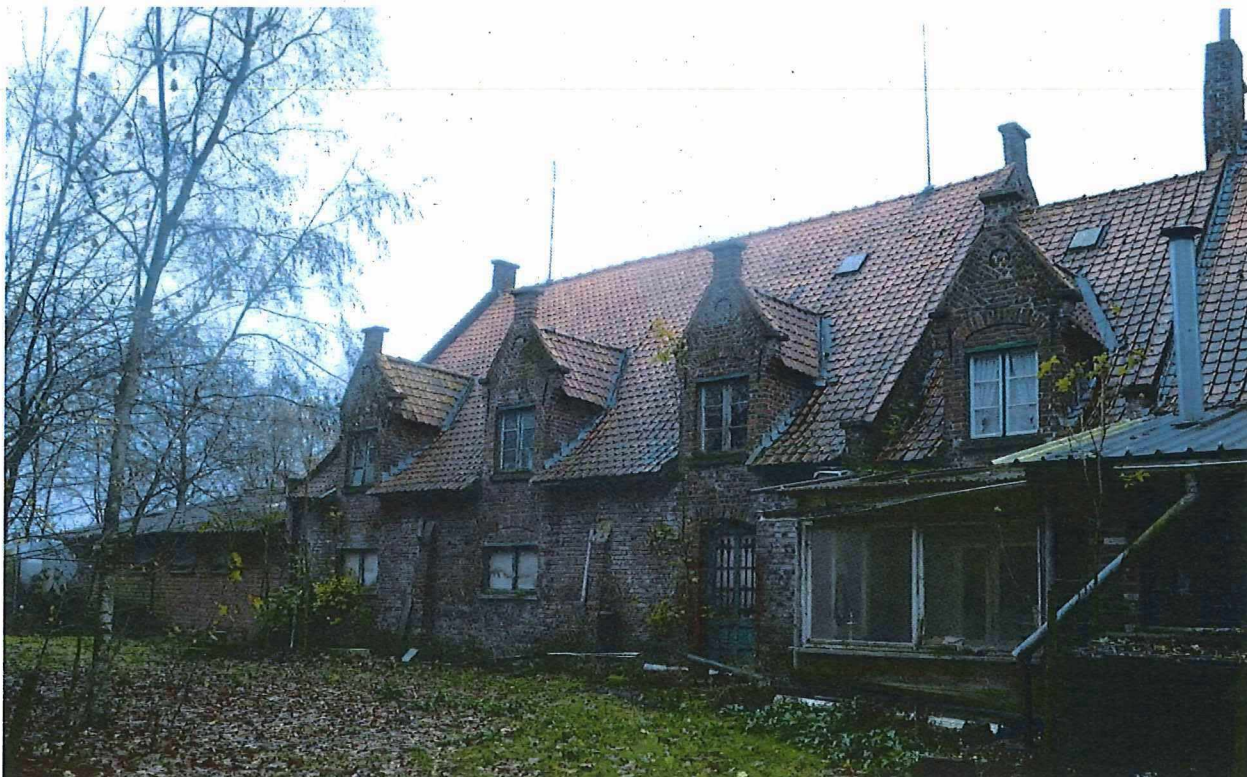
Foto 32: achtergevel van de koeienstal - korfboogdeurtje rechts gedeeltelijk dichtgemetseld in recentere baksteen (29.11.2018).
