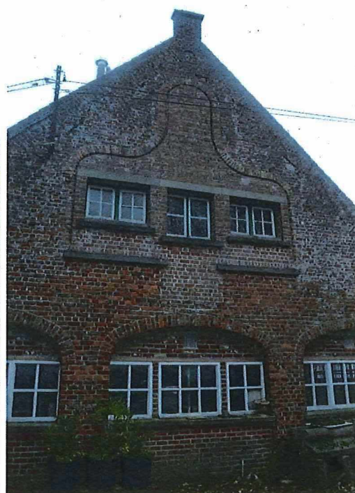
Foto 33: zijtuitgevel van de schuur met geïncorporeerd koets- en wagenhuis - de drie deels dichtgemetselde korfboogpoorten voor de toegang van wagens en koetsen zijn nog afleesbaar (19.04.2018).
