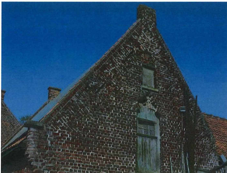
Foto 41: achterzijde van de hoeve, meer bepaald zij- of oostgevel van de kalverstal - deze gevel is opgevat als tuitgevel met schouderstukken, aandaken en vlechtingen (19.04.2018).
