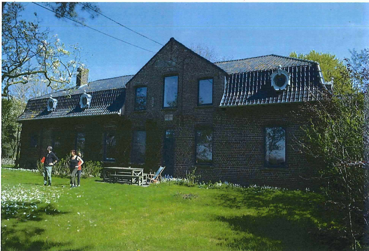
Foto 34: representatieve straatgevel van de boerenwoning - breed dakvenster ter hoogte van de deur. Blauwpannen mansardedak met oeijs de boeuf - vernieuwd houtwerk met uitzondering van het keldervenster (19.04.2018).
