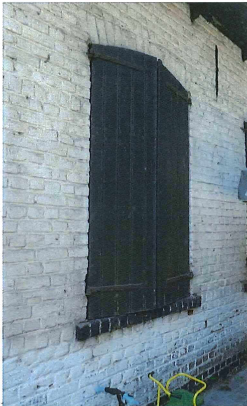
Foto 47: boerenwoning met bewaarde beluikte vensters. De oorspronkelijke roedeverdeling is verdwenen. Onderdorpel in geschilderde baksteen (19.04.2018).
