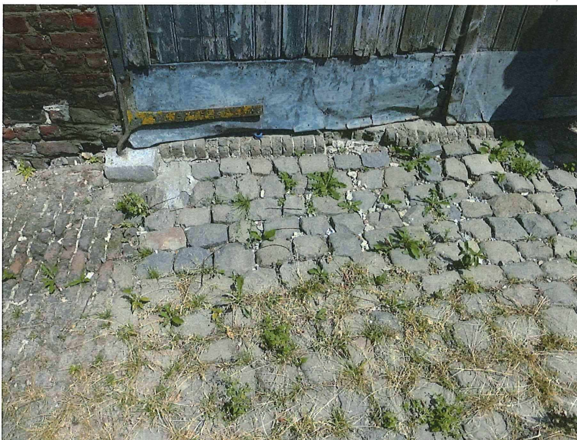
Foto 63: de bakstenen stoep langs de schuur gaat voor de schuurpoorten over in een kasseistrook – bakstenen onderdorpels van de deuren en poorten (26.07.2018).
