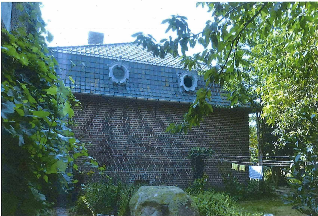
Foto 37: grotendeels blinde zijgevel (noordzijde) van de woning. Oeils-de-boeuf in het mansardedak (26.07.2018).
