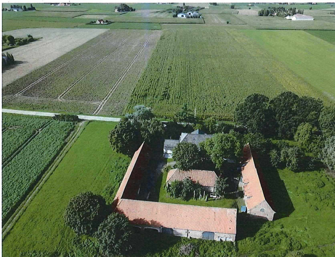
Foto 23: luchtopname met drone vanuit het oosten. Zicht op de semi-gesloten hoeveconfiguratie, en in het midden van het erf de overdekte mestvaalt. Links van het L-vormige volume met schuur en koeienstal staan volwassen bomen, onder meer paardenkastanje en esdoorn. Rechts van de boerenwoning, het boomgaardperceel met de eiken (30.08.2018).
