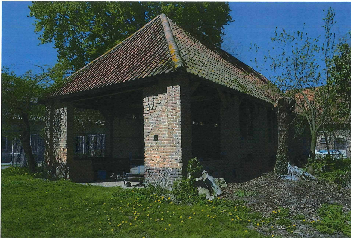
Foto 67: zuidelijke zijgevel met inrit en oostelijke langsgevel van de overdekte mestvaalt (19.04.2018).
