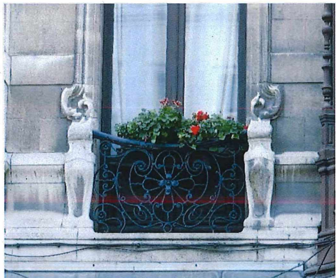
Foto 27: Detail siersmeed- en lijstwerk van enkelvoudig venster.
