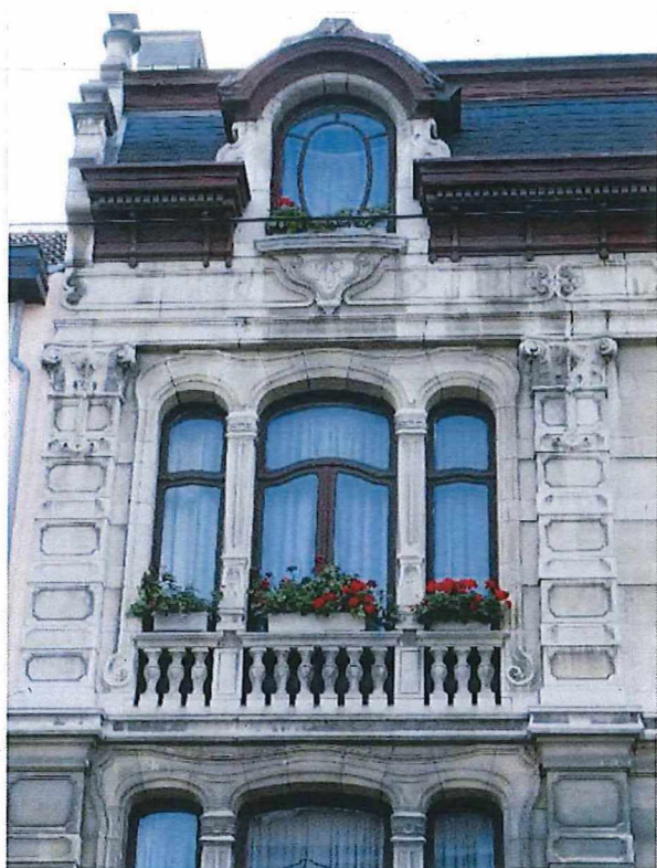
Foto 28: Tweede verdieping en mansardedak met dakvenster – oostelijke travee
