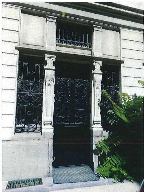
Foto 38: Achtergevel - deur die toegang geeft tot de traphal.
