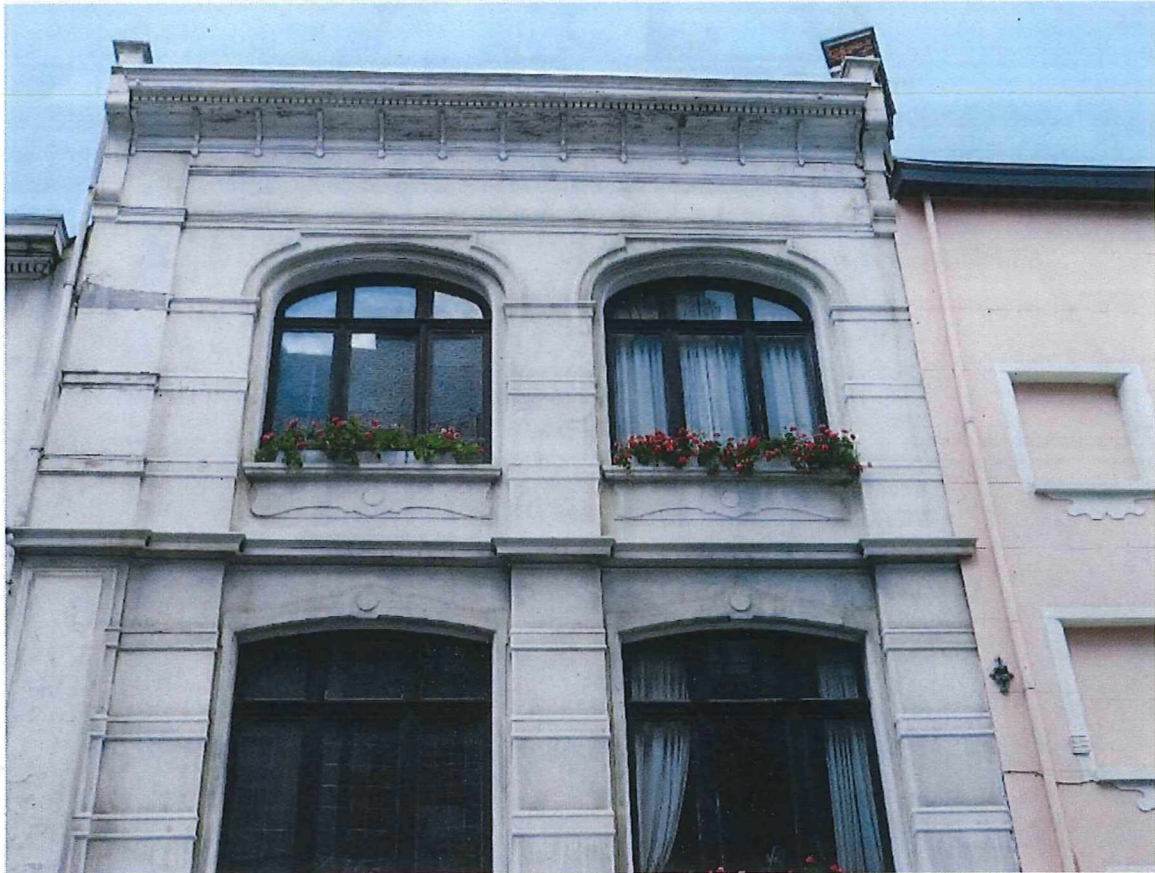
Foto 42: Achtergevel – tweede verdieping – venster van traphal (links) en slaapkamer (rechts).
