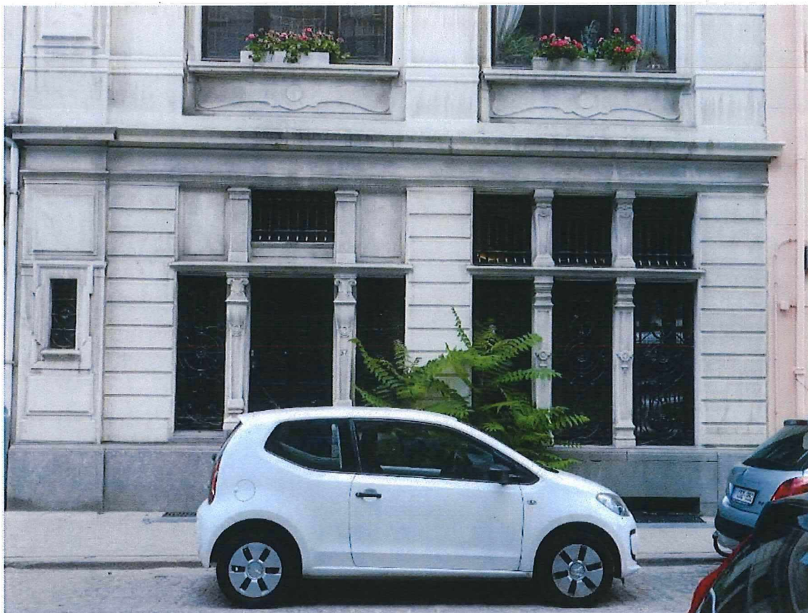
Foto 37: Achtergevel – begane grond met toegang naar privégedeelte en burelen.
