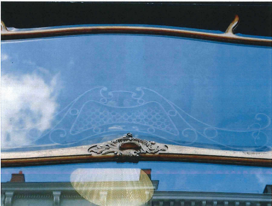
Foto 13: Begane grond – detail van decoratief houtwerk van vitrine – siersmeedwerk aan binnenzijde als frame van originele verlichtingsarmaturen.
