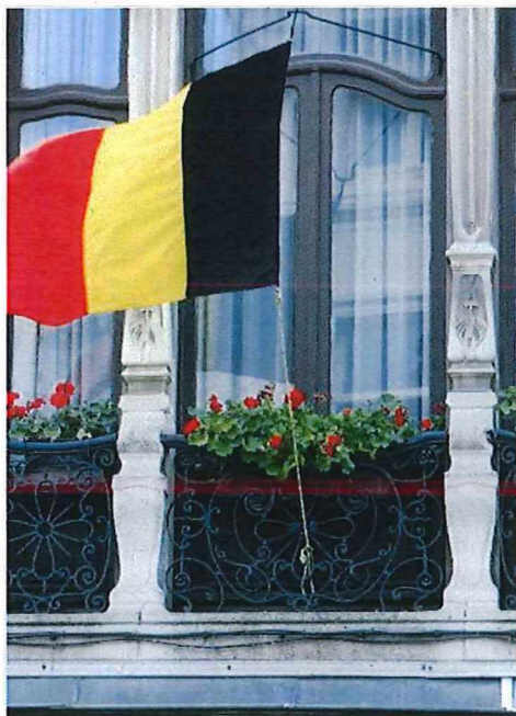
Foto 26: Detail siersmeedwerk driedelig venster in oosttravee.
