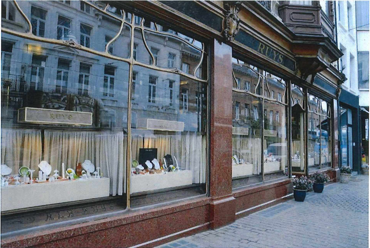
Foto 7: Voorgevel - begane grond - winkelpui.
