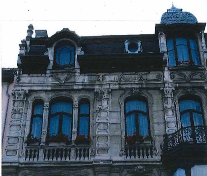
Foto 31: Tweede verdieping en mansardedak met dakvenster en oeil-de-boeuf.
