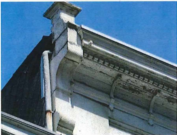
Foto 43: Achtergevel – detail kroonlijst.
