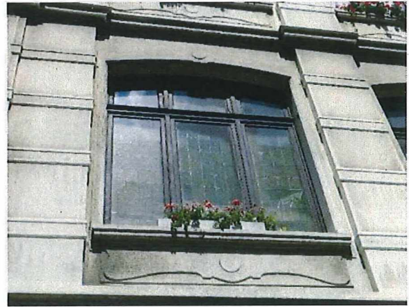
Foto 44: Achtergevel – detail bovenvenster met origineel hout- en glaswerk.
