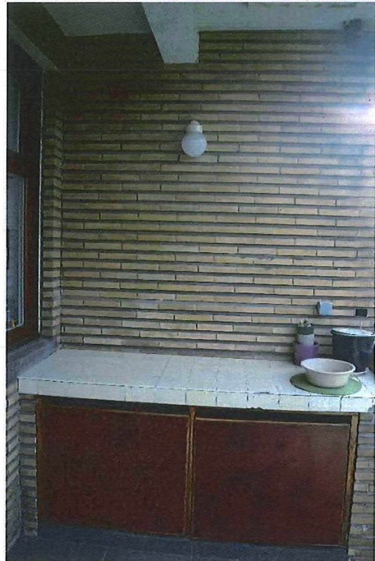
Foto 57: achtergevel: bel-etage: overdekt terras-buitenkeuken
