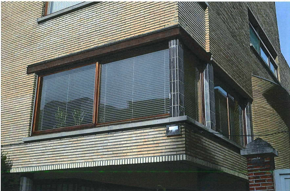
Foto 11: bel-etage: om de hoek doorgetrokken vensterpartij met betegelde vensterposten
