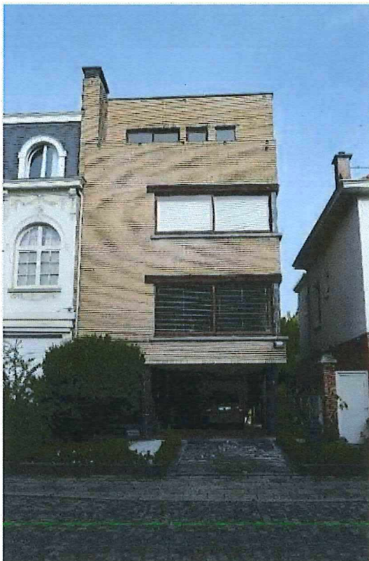
Foto 2: frontaal zicht op voorgevel
