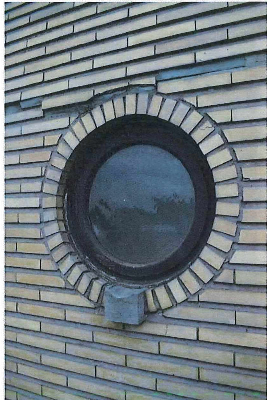
Foto 92: achtergevel: derde verdieping: patrijspoort-toilet
