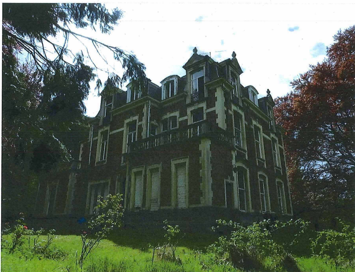
Foto 59: Kasteel, noord- en westgevel
