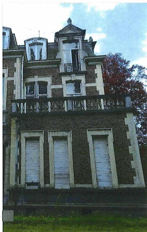
Foto 52: Kasteel, noordgevel, uitbouw
