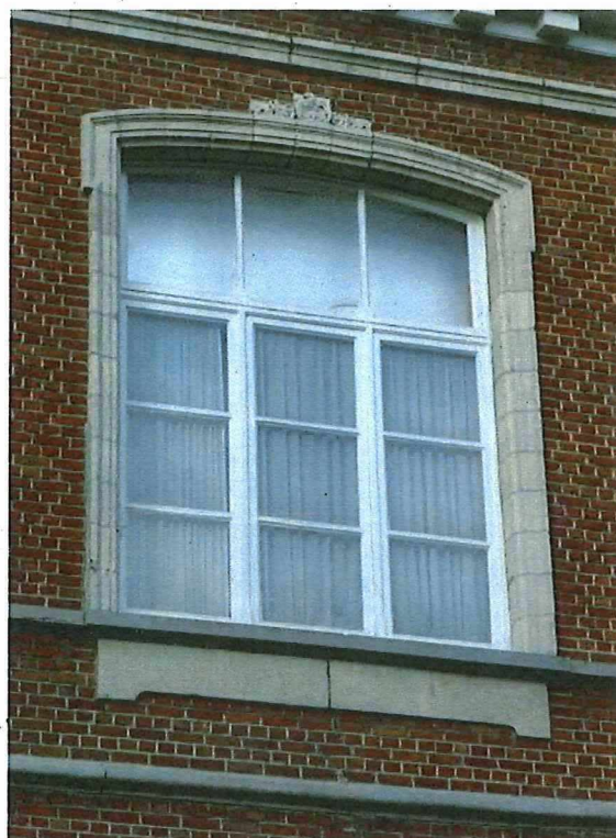
Foto 14: Oostgevel van de voormalige directeurswoning Dassonville, kant Izegemsestraat, vensteropening met behouden vensterschrijnwerk opgebouwd uit grote roeden en een mok.
