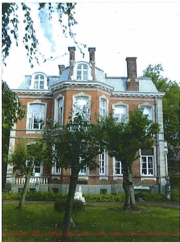
Foto 19: Zuidgevel van de voormalige directeurswoning Dassonville met zuidelijk tuindeel, kant Dorpsplein. Algemeen beeld.
