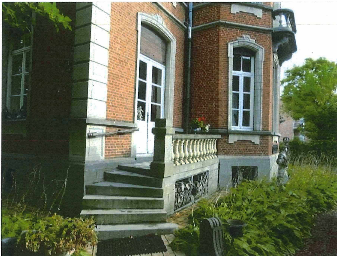
Foto 18: Zuidgevel van de voormalige directeurswoning Dassonville, kant Dorpsplein, toegangstrap.
