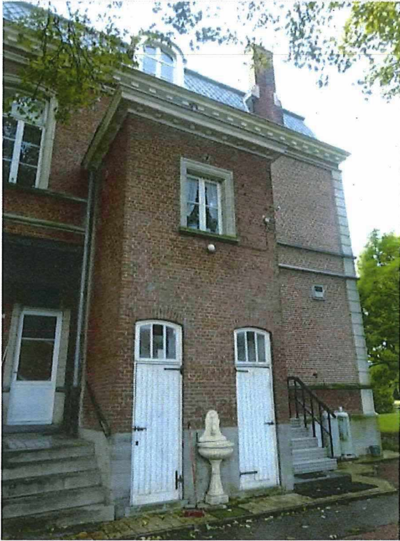
Foto 29: Noordgevel van de voormalige directeurswoning Dassonville, centraal volume met sanitaire voorzieningen.
