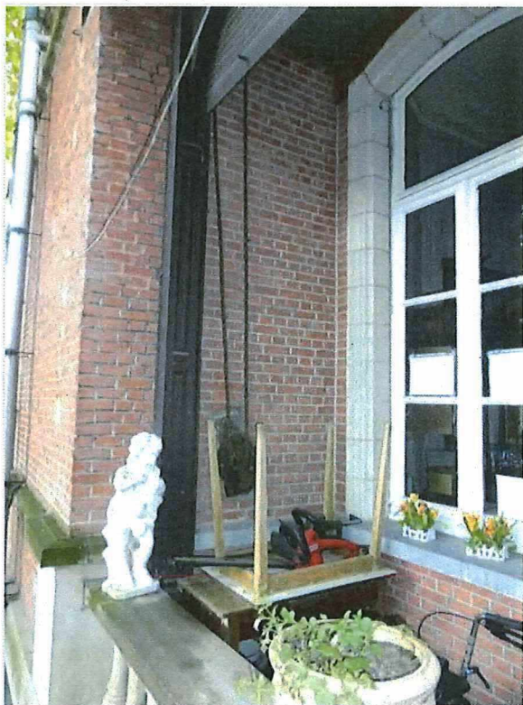
Foto 35: Noordgevel van de voormalige directeurswoning Dassonville, detail rolluikstelsel.
