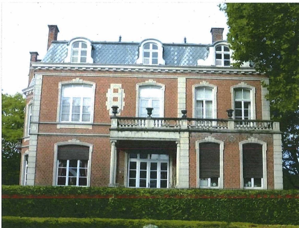
Foto 10: Zicht op de oostgevel van de voormalige directeurswoning Dassonville, kant Izegemsestraat.
