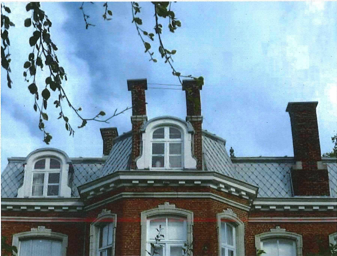
Foto 17: Zuidgevel van de voormalige directeurswoning Dassonville, kant Dorpsplein, dakvenster geflankeerd door schouwen.
