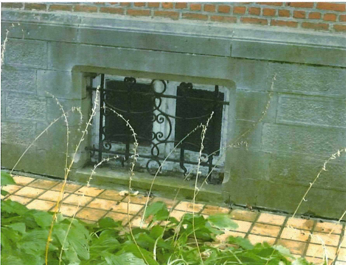
Foto 21: Westgevel van de voormalige directeurswoning Dassonville, plint met kelderopening voorzien van behouden smeedwerk.
