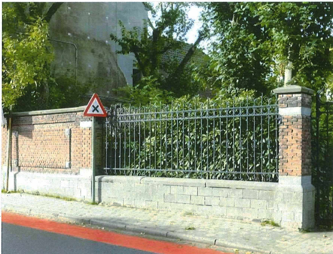
Foto 7: Tuinmuur en hekwerk aan de Izegemsestraat.
