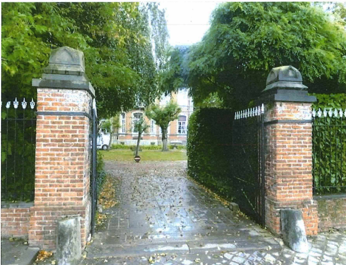
Foto 3: Toegang tot de site Dassonville van aan het Dorpsplein, met zicht op de voormalige directeurswoning.
