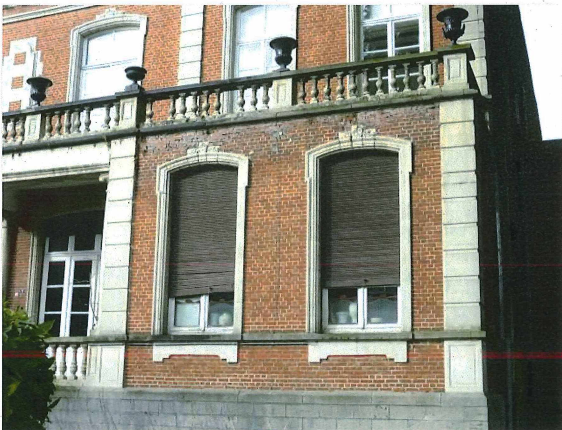
Foto 12: Oostgevel van de voormalige directeurswoning Dassonville, kant Izegemsestraat, vensteropeningen.
