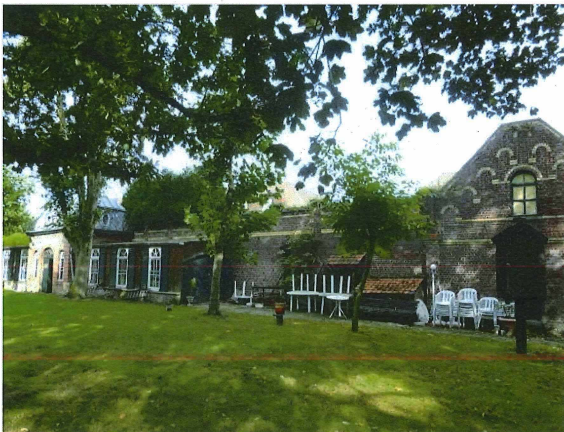
Foto 54: Restanten van de vroegere fabrieksgebouwen van de olieslagerij Dassonville, nu deel uitmakend van de tuinmuur.
