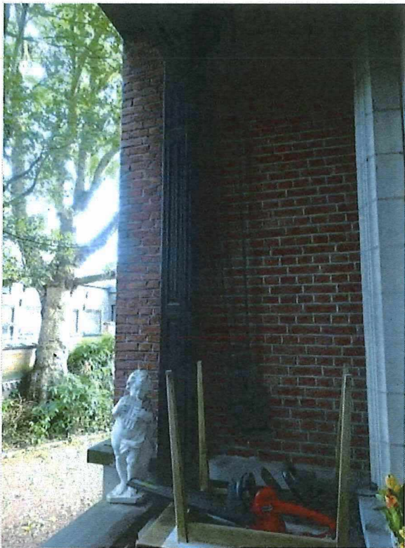
Foto 33: Noordgevel van de voormalige directeurswoning Dassonville, rolluikstelsel.
