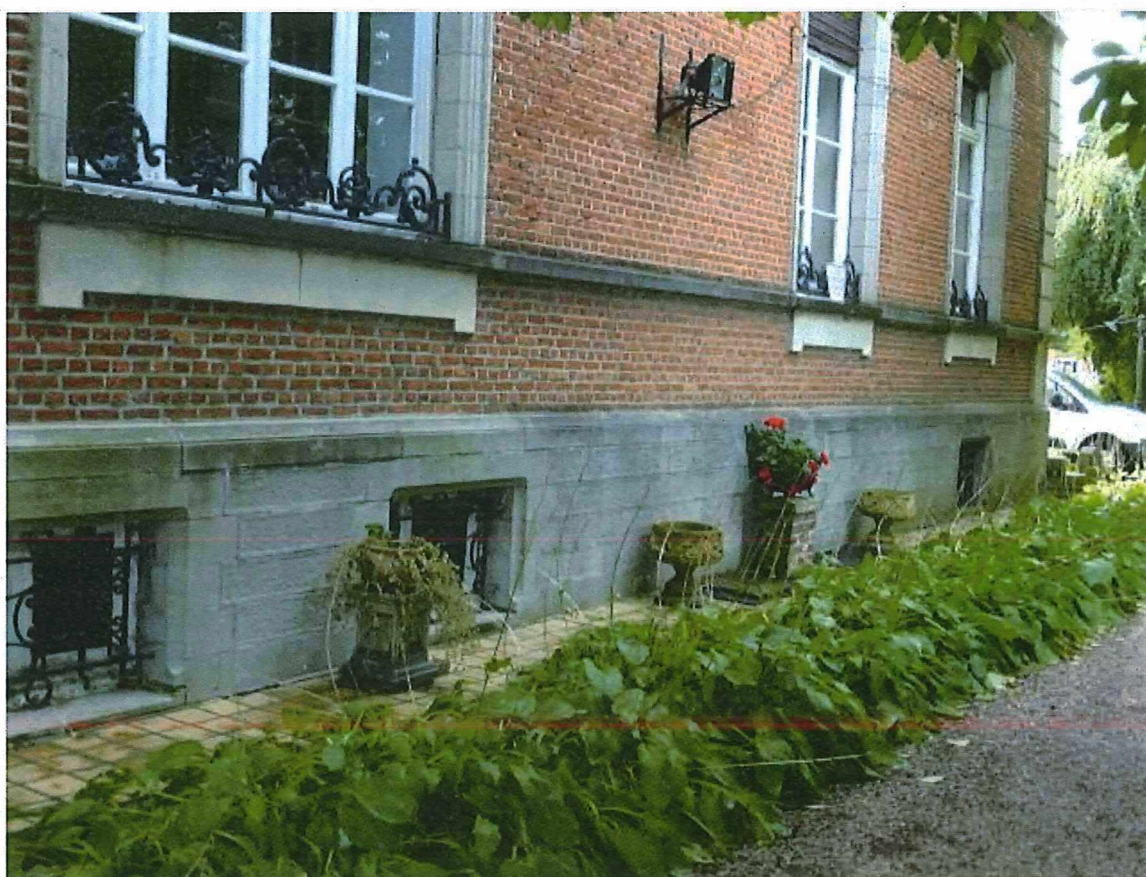
Foto 22: Westgevel van de voormalige directeurswoning Dassonville, plint met kelderopening.
