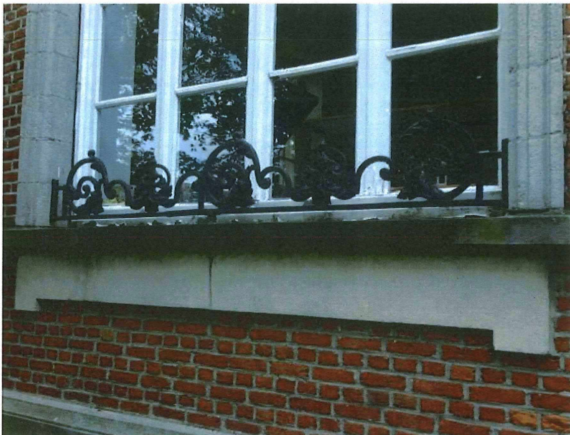
Foto 23: Westgevel van de voormalige directeurswoning Dassonville, gietijzeren vensterleuning.
