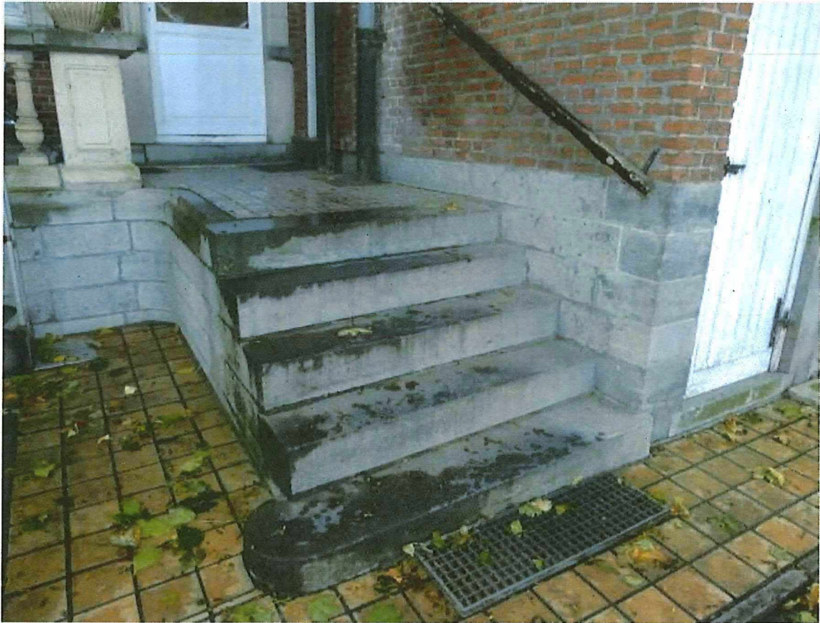
Foto 27: Noordgevel van de voormalige directeurswoning Dassonville, toegangstrap van blauwe hardsteen.
