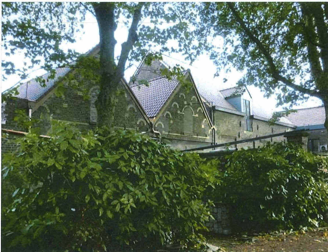
Foto 53: Restanten van de vroegere fabrieksgebouwen van de olieslagerij Dassonville, nu deel uitmakend van de tuinmuur.
