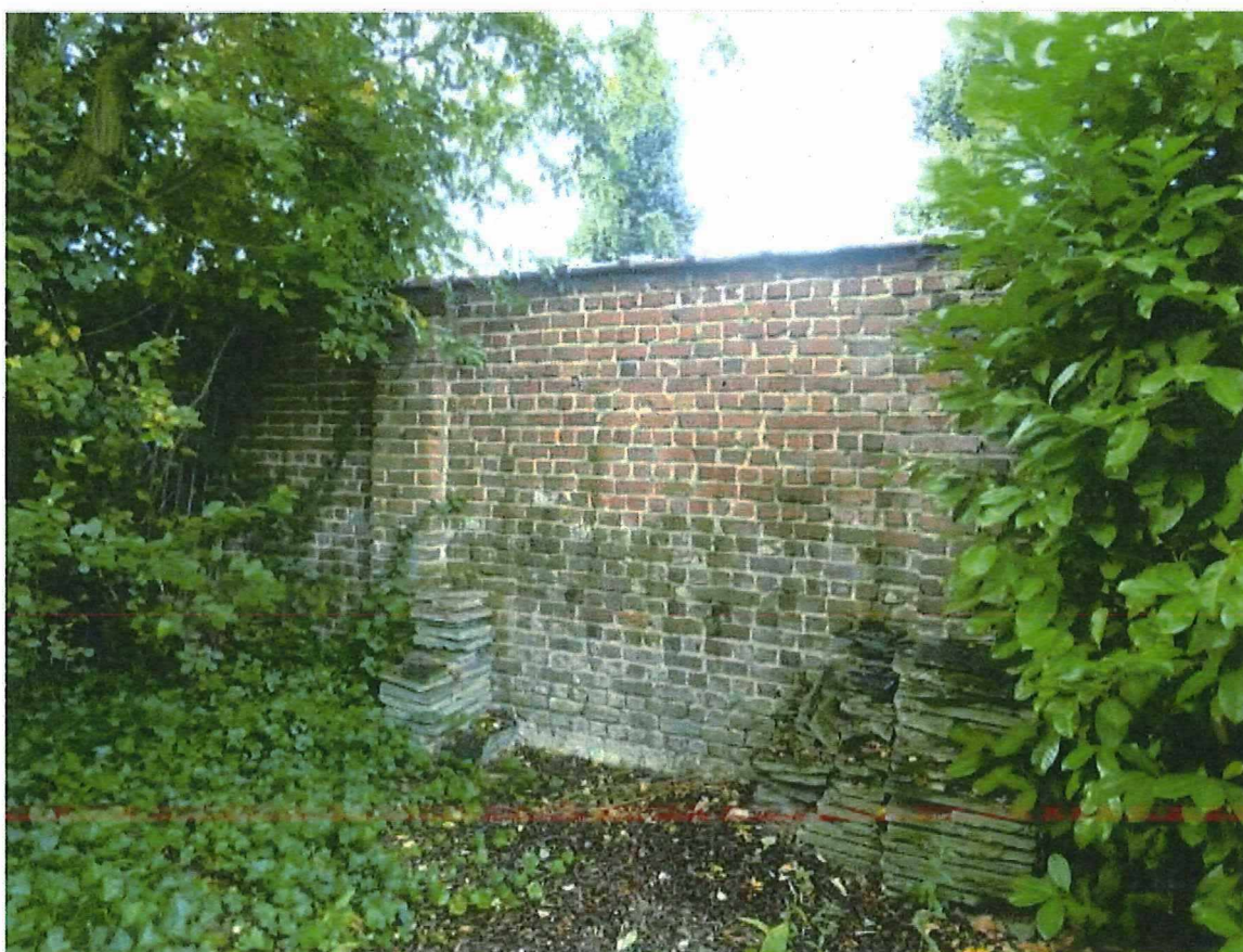
Foto 52: Tuinmuur, kant A. Dassonvillelaan.
