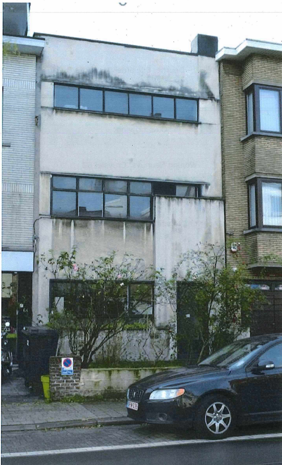
Foto 1: Voorgevel met simipleisterwerk en vensterbanden met stalen schrijnwerk
