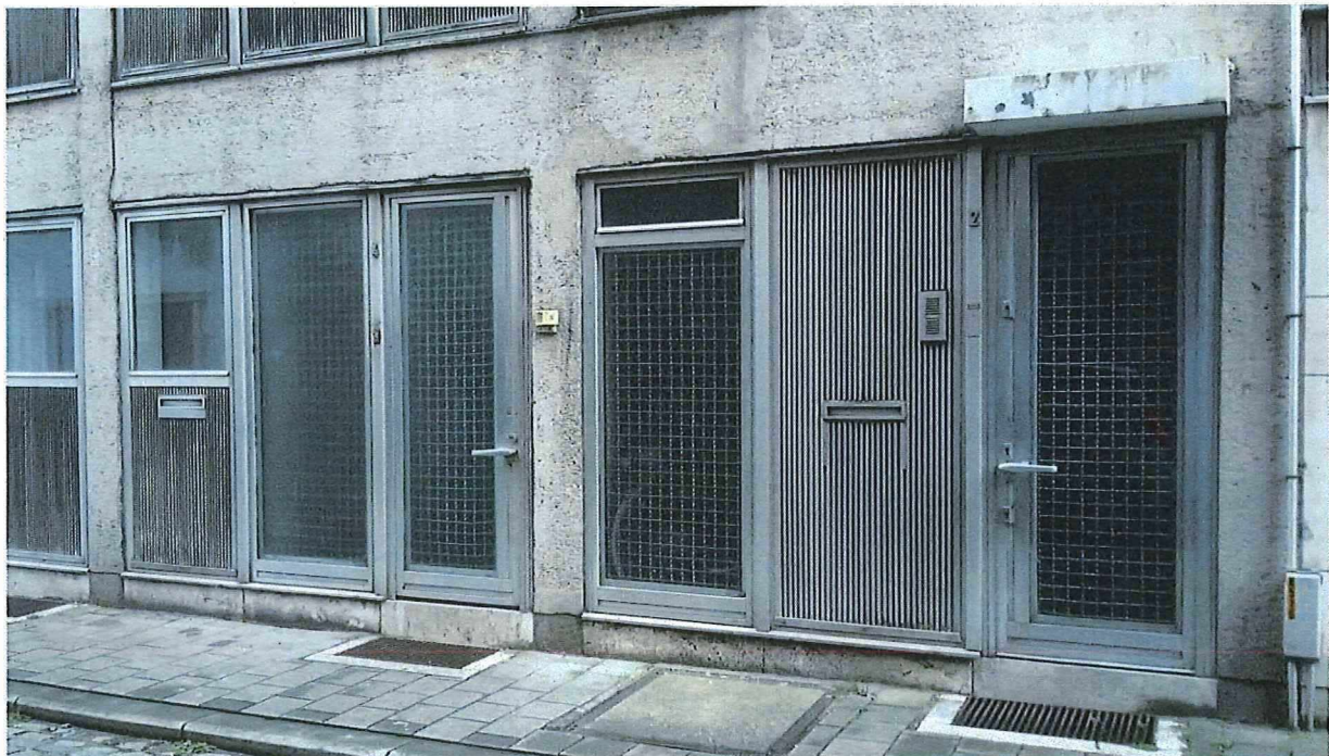
Foto 9: Zijgevel, pui (fietsenstalling, ingang architectenkantoor)
