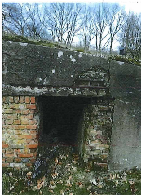
Foto 5: De toegang. Bovenaan zijn de stalen liggers zichtbaar. Er is reliëf (camouflage) aangebracht op het beton boven de toegang.
