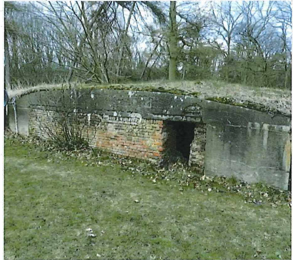
Foto 2: De dichtgemetselde toegangszijde.
