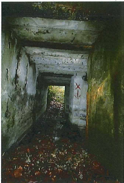
Foto 5: Zicht in de gang van de bunker, met rechts de doorgangen tot de binnenruimtes. De verticale betonnen randen van de doorgangen zijn afgewerkt met een schuine boord.
