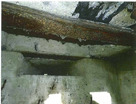
Foto 14: De observatiegleuf aan de binnenzijde versmalt tot een klein gaatje aan de buitenzijde. Tegen het plafond zijn stalen profielen en restanten van houten planken te zien.
