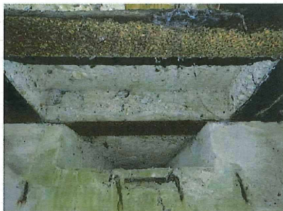
Foto 20: Zicht op de rechthoekige uitsparing in het plafond boven de observatiegleuf.
