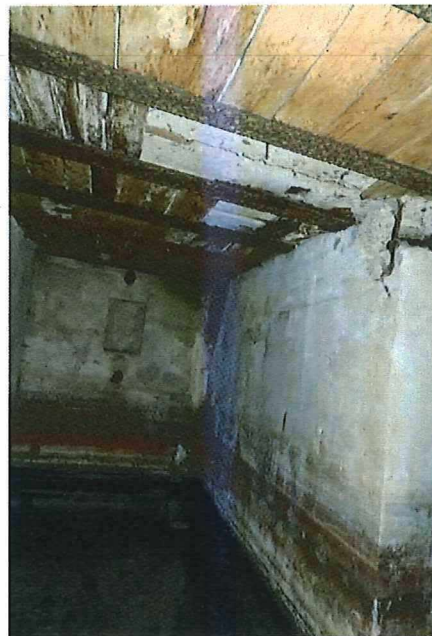
Foto 6: Zicht in de westelijke binnenruimte. Tegen het plafond zitten houten planken. In de frontmuur zit een nis, met bovenaan en onderaan een ijzeren buis.
