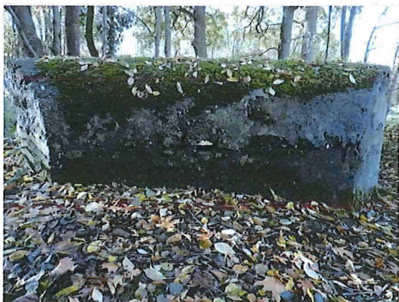
Foto 17: De gebogen frontzijde met kleine waarnemingsopening aan noordoostelijke zijde.
