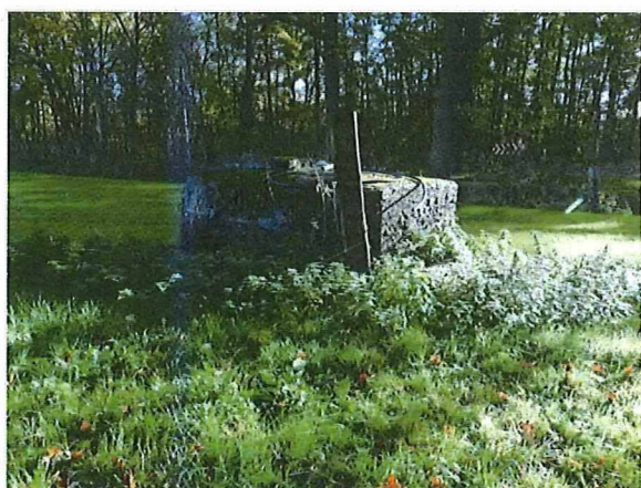
Foto 10: De bunker vanuit westelijke richting.
