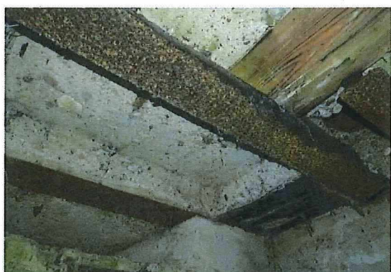
Foto 21: Zicht op het plafond, met rechthoekige uitsparing en opening met buis uit grès. Tussen de stalen profielen zitten nog houten planken.
