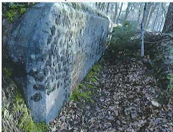
Foto 40: Bunker 19 (type VI). Foto genomen op 16 februari 2018.
