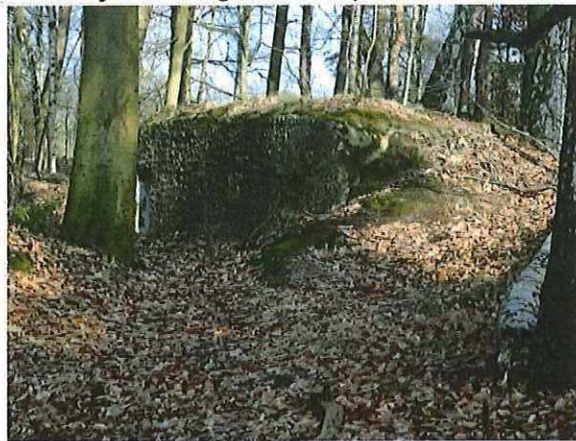
Foto 138: Bunker 65 (type VI). Foto genomen op 21 februari 2018.
