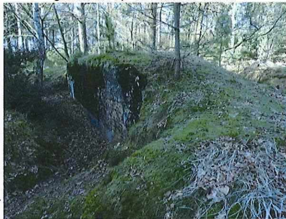
Foto 24: Bunker 13 (type VI). Foto genomen op 13 februari 2018.
