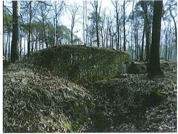
Foto 101: Bunker 49 (type VI). Foto genomen op 21 februari 2018.
