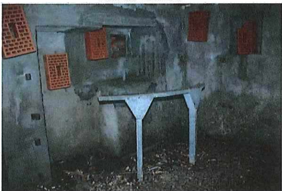
Foto 45: Bunker 22 (type VI), met nieuw gecreëerde schietopening en chardome-affuit. Foto genomen door Tom Oliviers op 26 september 2016.
