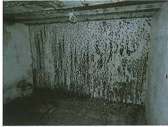
Foto 150: Bunker 69 (type XVI): stalen bekleding tegen binnenmuur frontzijde grootste ruimte. Foto genomen op 16 januari 2019.
