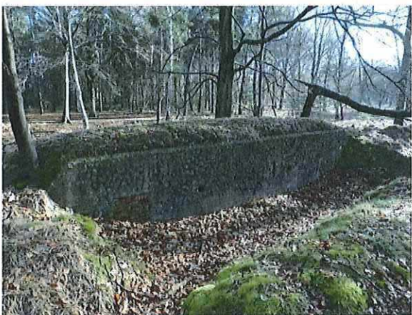
Foto 46: Bunker 23 (type VI). Foto genomen op 16 februari 2018.
