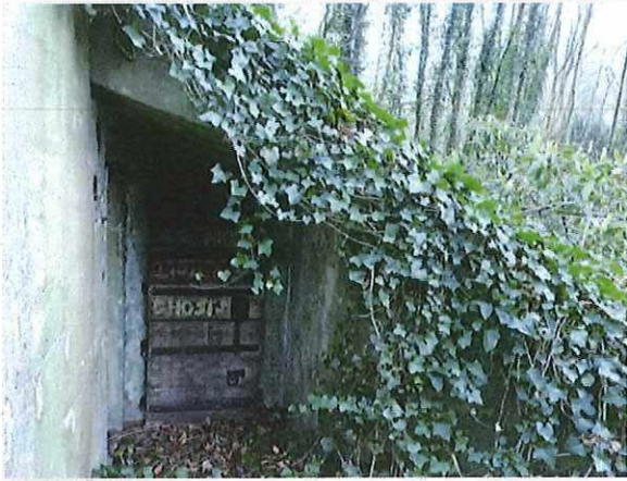
Foto 149: Bunker 69 (type XVI): overkapping toegang zuidwestelijke hoek. Foto genomen op 16 januari 2019.
