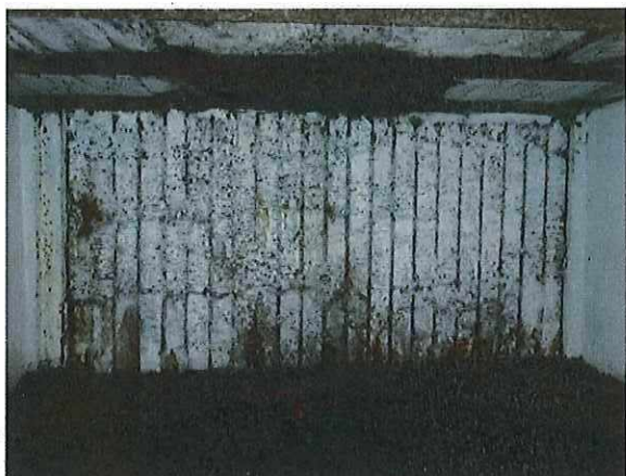
Foto 145: Bunker 68 (type II): binnenmuur frontzijde. Foto genomen op 18 april 2018.
