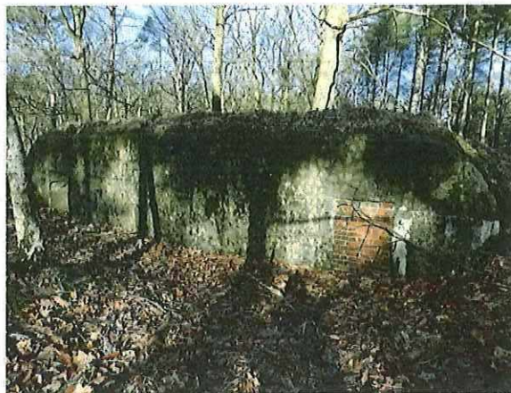
Foto 57: Bunker 29 (type VII). Foto genomen op 16 februari 2018.
