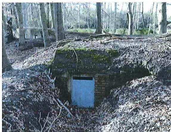
Foto 61: Bunker 31 (type II). Foto genomen op 16 februari 2018.
