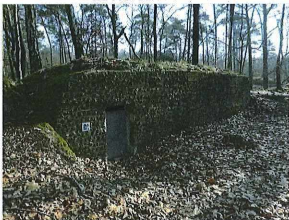
Foto 139: Bunker 65 (type VI). Foto genomen op 21 februari 2018.
