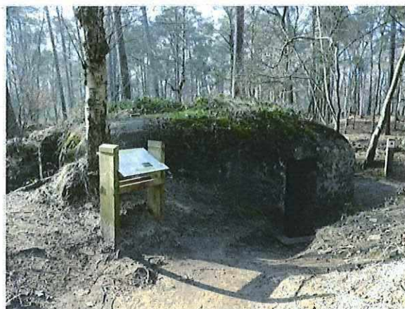
Foto 126: Bunker 60 (type VIII): toegang. Foto genomen op 21 februari 2018.
