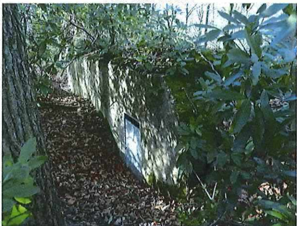
Foto 9: Bunker 5 (type VI). Foto genomen op 13 februari 2018.
