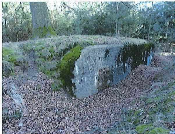
Foto 26: Bunker 14 (type VI). Foto genomen op 13 februari 2018.
