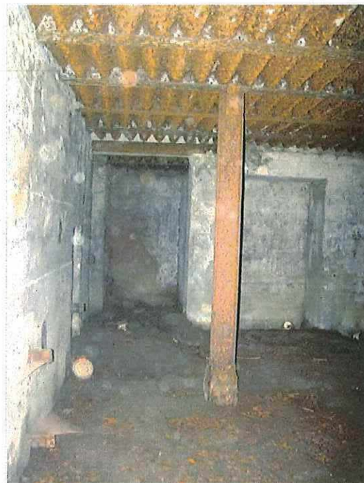
Foto 124: Bunker 59 (type VI). Verticale stalen balk in binnenruimte. Ter hoogte van de toegang is camouflageverf te zien. Foto genomen door Tom Oliviers op 5 mei 2014.
