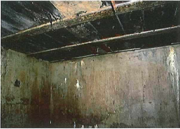
Foto 62: Bunker 31 (type II). Houten beplanking tegen plafond. Foto genomen door Tom Oliviers op 8 september 2016.
