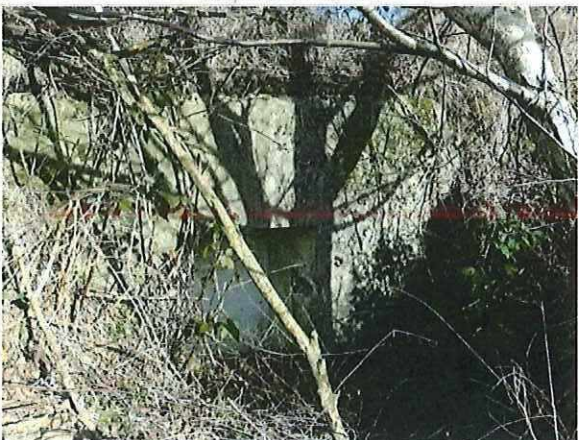
Foto 13: Bunker 7 (type VI). Foto genomen op 13 februari 2018.
