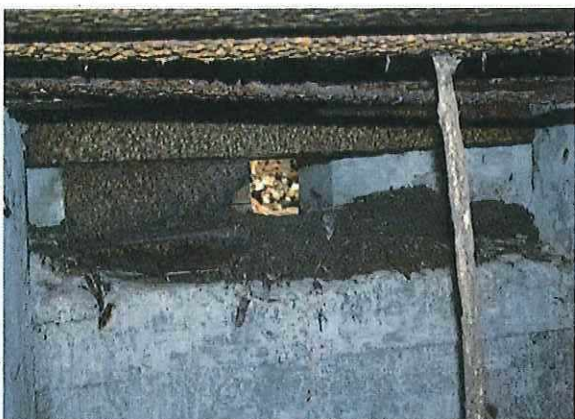
Foto 96: Bunker 47 (type IX): Bewaarde schuif vóór observatiegleuf. Foto genomen door Tom Oliviers op 25 juni 2018.
