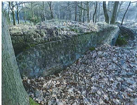
Foto 44: Bunker 22 (type VI). Foto genomen op 16 februari 2018.
