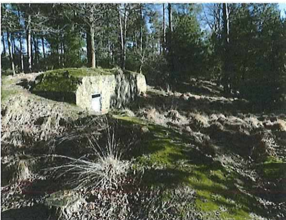
Foto 5: Bunker 3 (type VI). Foto genomen op 13 februari 2018.
