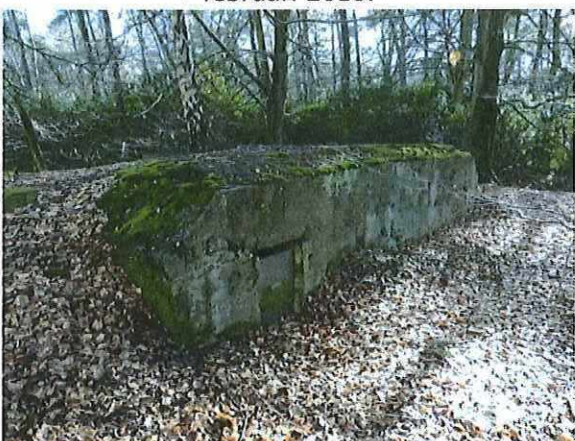
Foto 70: Bunker 35 (type VI). Foto genomen op 16 februari 2018.
