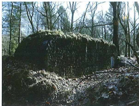
Foto 49: Bunker 25 (type VI). Foto genomen op 16 februari 2018.
