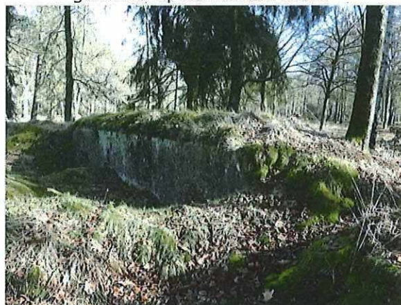
Foto 50: Bunker 26 (type VI). Foto genomen op 16 februari 2018.
