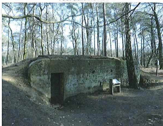
Foto 132: Bunker 63 (type VII). Foto genomen op 21 februari 2018.
