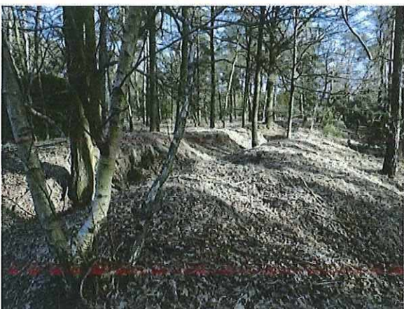
Foto 163: Loopgraaf tweede lijn ten zuidoosten van bunker 10 (percelen 60B/59C/54C). Foto genomen op 13 februari 2018.
