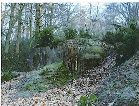
Foto 90: Bunker 44 (type IV): dichtgemetselde toegang. Foto genomen op 21 februari 2018.
