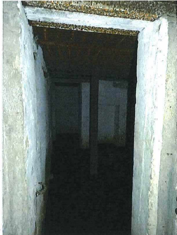
Foto 32: Bunker 17 (type VI): interieur met verticale balk. Foto genomen op 13 februari 2018.
