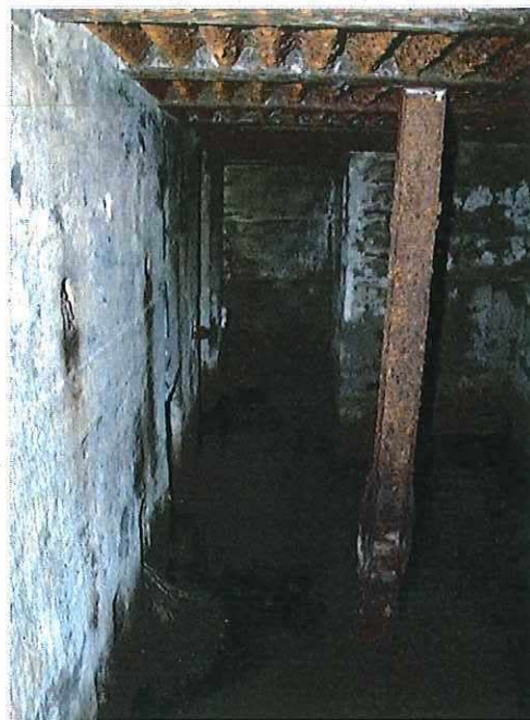
Foto 77: Bunker 39 (type VI). Verticale stalen balk in bunker. Foto genomen door Tom Oliviers op 13 september 2016.
