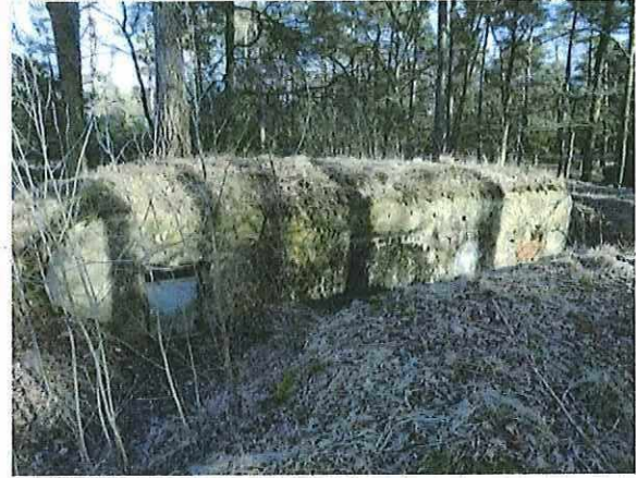
Foto 18: Bunker 10 (type VII). Foto genomen op 13 februari 2018.
