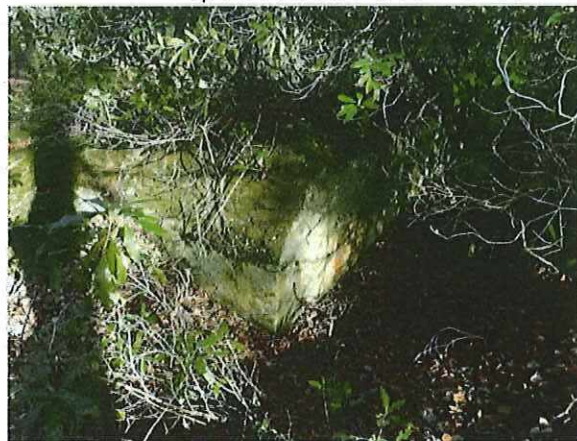
Foto 10: Bunker 5 (type VI). Foto genomen op 13 februari 2018.
