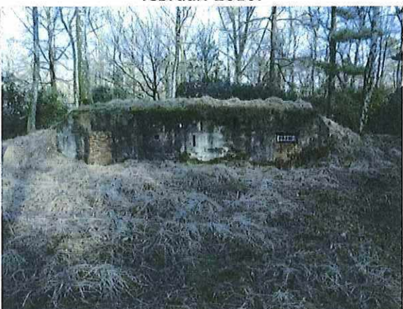
Foto 72: Bunker 36 (type VI). Foto genomen op 16 februari 2018.
