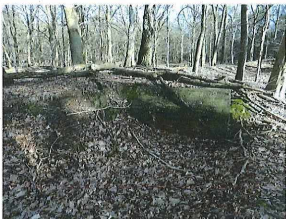
Foto 60: Bunker 31 (type II): dichtgemetselde toegang. Foto genomen op 16 februari 2018.
