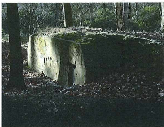
Foto 59: Bunker 30 (type VI). Foto genomen op 16 februari 2018.
