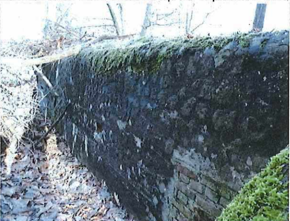
Foto 39: Bunker 18 (type VI): achtergevel. Foto genomen op 16 februari 2018.
