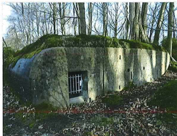
Foto 81: Bunker 40 (type VII). Foto genomen op 16 februari 2018.
