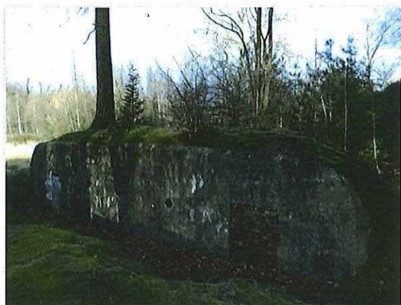
Foto 78: Bunker 39 (type VI). Foto genomen op 16 februari 2018.
