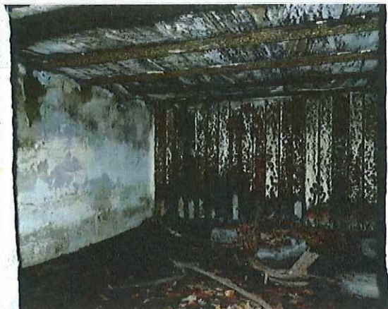
Foto 143: Bunker 67 (type II): stalen bekleding aan frontmuur binnenzijde. Foto genomen op 21 februari 2018.
