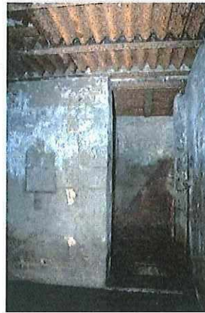
Foto 83: Bunker 41 (type XVII). Bewaarde camouflageverf bij toegang. Foto genomen door Tom Oliviers op 16 september 2016.
