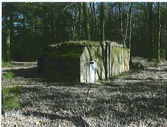
Foto 7: Bunker 4 (type VI). Foto genomen op 13 februari 2018.
