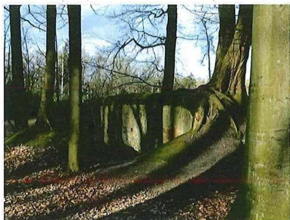
Foto 80: Bunker 40 (type VII). Foto genomen op 16 februari 2018.
