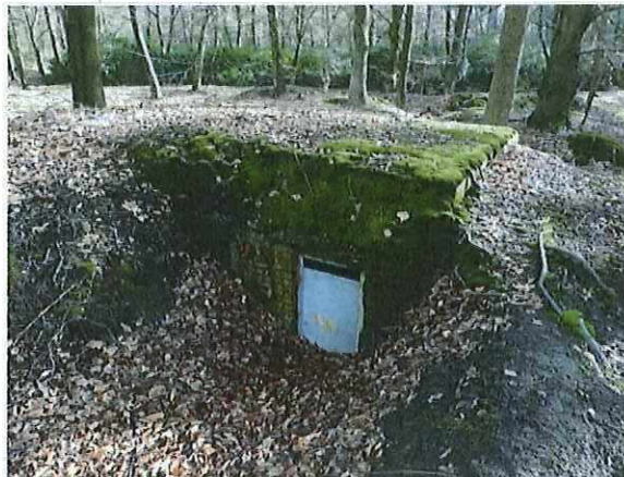
Foto 69: Bunker 34 (type II). Foto genomen op 16 februari 2018.
