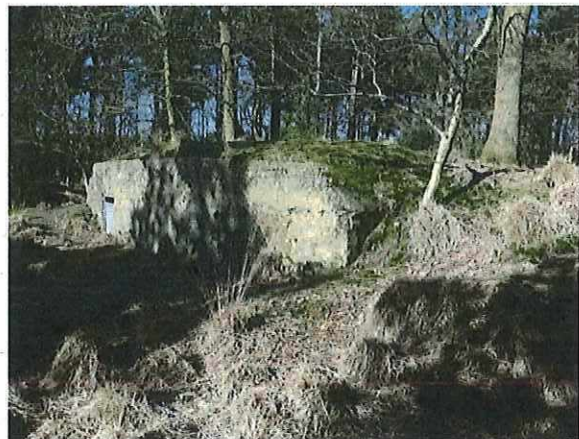
Foto 6: Bunker 3 (type VI). Foto genomen op 13 februari 2018.
