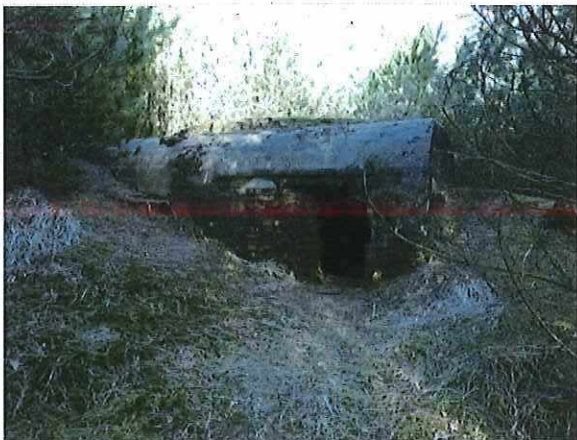
Foto 27: Bunker 15 (type IV). Foto genomen op 13 februari 2018.
