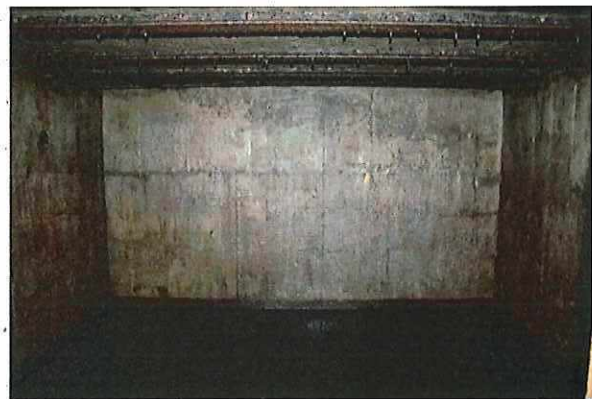
Foto 67: Bunker 34 (type II). Zicht op frontmuur aan binnenzijde. Foto genomen door Tom Oliviers op 9 september 2016.
