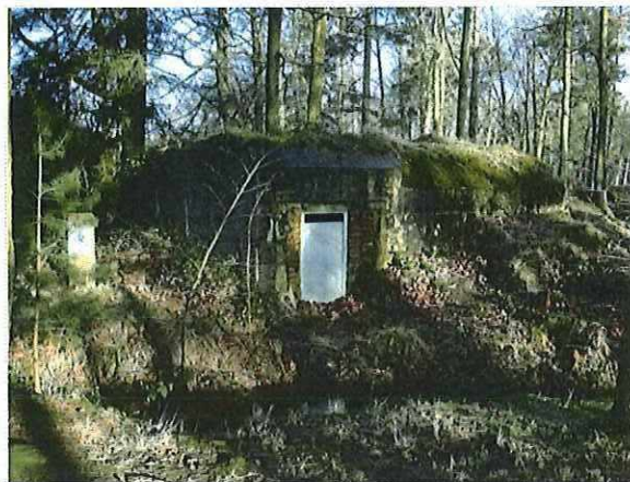
Foto 140: Bunker 66 (type II). Foto genomen op 16 februari 2018.
