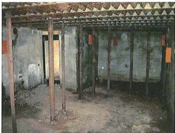
Foto 56: Bunker 29 (type VII): restanten ijzeren structuur in bunker. Foto genomen door Tom Oliviers op 18 april 2014.
