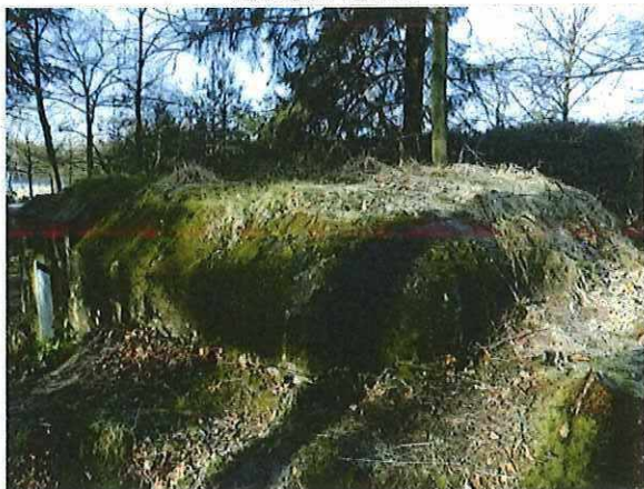
Foto 141: Bunker 66 (type II). Foto genomen op 16 februari 2018.
