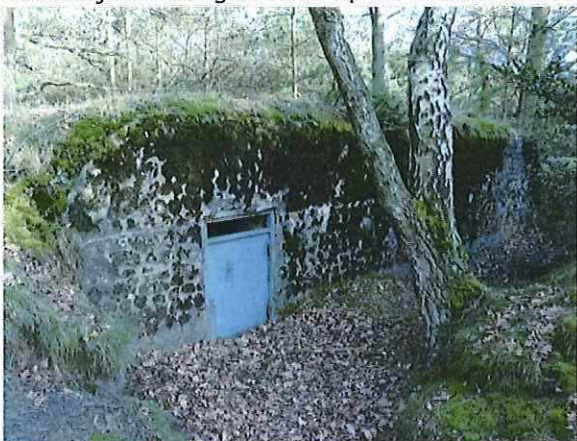
Foto 25: Bunker 13 (type VI). Foto genomen op 13 februari 2018.
