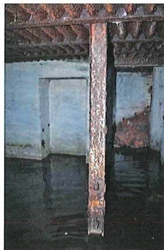
Foto 87: Bunker 43 (type VI): Verticale stalen balk in bunker. Foto genomen door Tom Oliviers op 13 september 2016.
