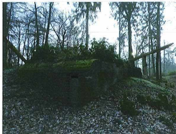
Foto 89: Bunker 44 (type IV): toegang met vleermuizendeur. Foto genomen op 21 februari 2018.
