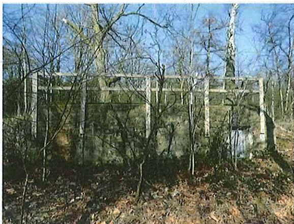
Foto 111: Bunker 53 (type VI). Foto genomen op 21 februari 2018.
