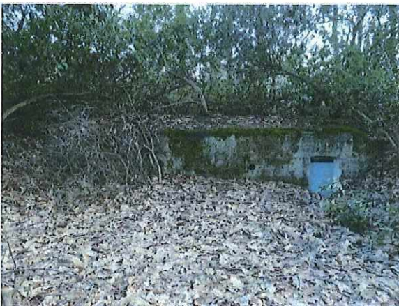
Foto 86: Bunker 43 (type VI). Foto genomen op 21 februari 2018.
