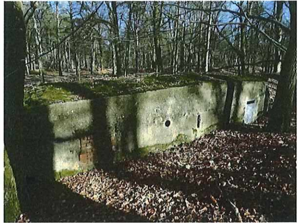
Foto 65: Bunker 33 (type VI). Foto genomen op 16 februari 2018.
