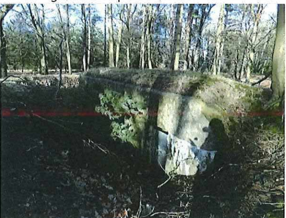
Foto 41: Bunker 19 (type VI). Foto genomen op 16 februari 2018.
