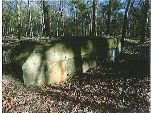
Foto 63: Bunker 32 (type VI). Foto genomen op 16 februari 2018.
