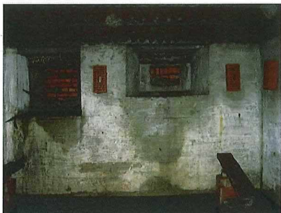
Foto 88: Bunker 44 (type IV). Dichtgemetselde muuropeningen aan frontzijde. Foto genomen door Tom Oliviers op 15 april 2014.
