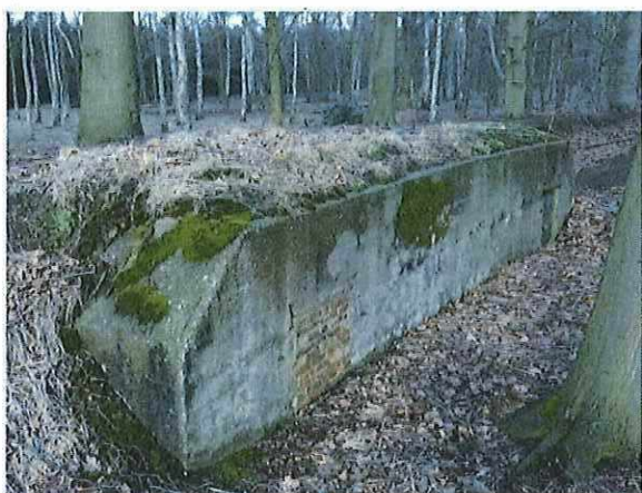
Foto 58: Bunker 30 (type VI). Foto genomen op 16 februari 2018.
