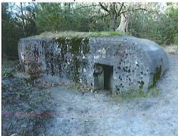
Foto 33: Bunker 17 (type VI). Foto genomen op 13 februari 2018.
