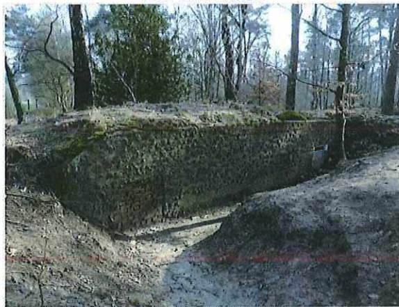
Foto 116: Bunker 56 (type VI). Foto genomen op 21 februari 2018.
