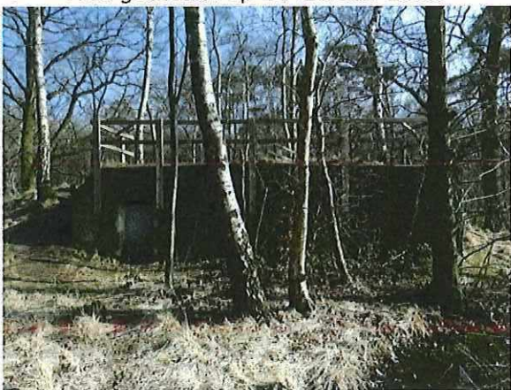
Foto 115: Bunker 55 (type VI). Foto genomen op 21 februari 2018.
