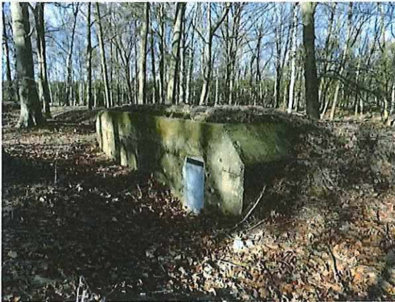
Foto 64: Bunker 32 (type VI). Foto genomen op 16 februari 2018.
