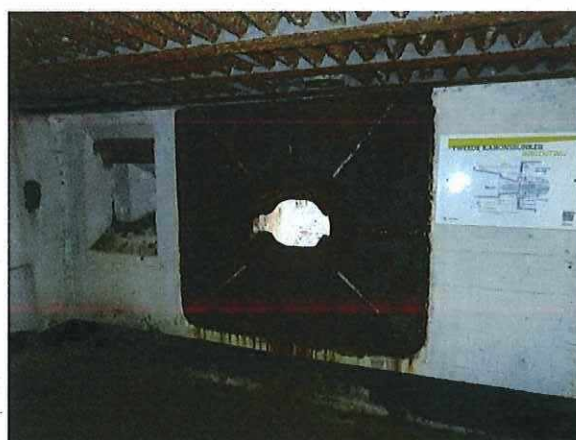
Foto 128: Bunker 60 (type VIII): plaataffuit en kijkopening binnenzijde. Foto genomen op 21 februari 2018.
