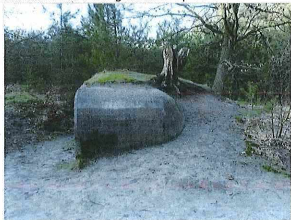
Foto 34: Bunker 17 (type VI). Foto genomen op 13 februari 2018.
