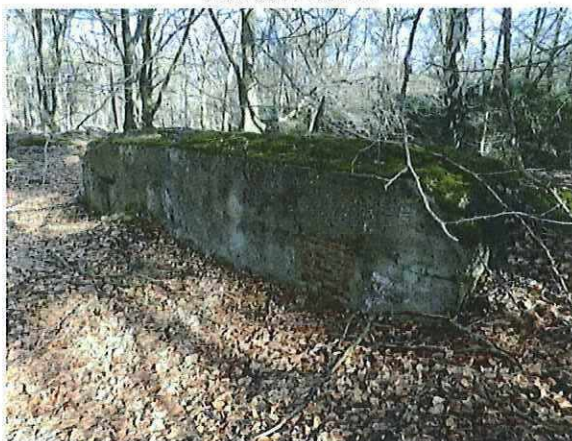
Foto 71: Bunker 35 (type VI). Foto genomen op 16 februari 2018.
