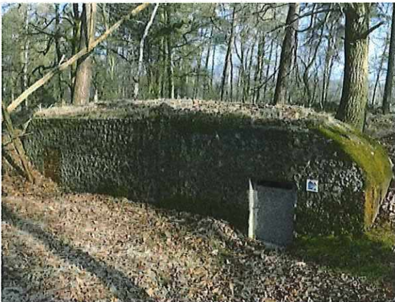
Foto 102: Bunker 50 (type VI). Foto genomen op 21 februari 2018.
