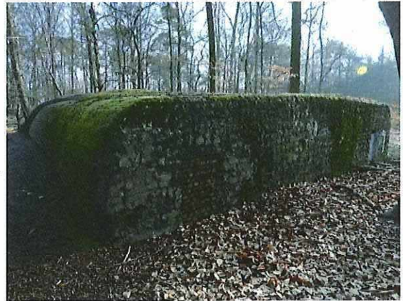
Foto 103: Bunker 51 (type VII). Foto genomen op 21 februari 2018.
