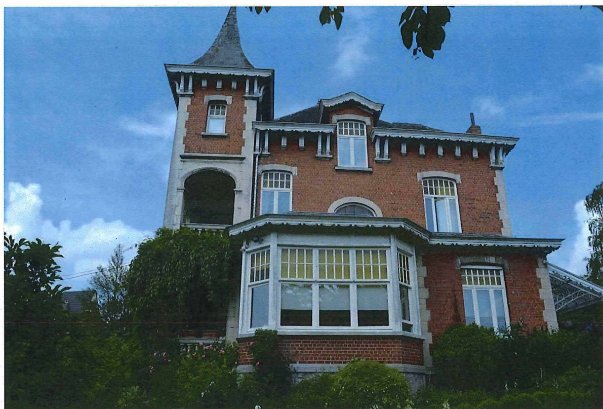
Foto 6: Serristenvilla Muyldermans, oostgevel (25/05/2018).
