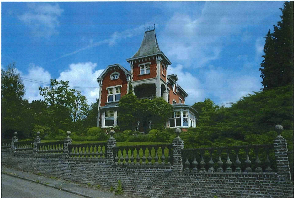
Foto 1: Serristenvilla Muyldermans met afsluiting aan de Edmond Vandervarenstraat (25/05/2018).
