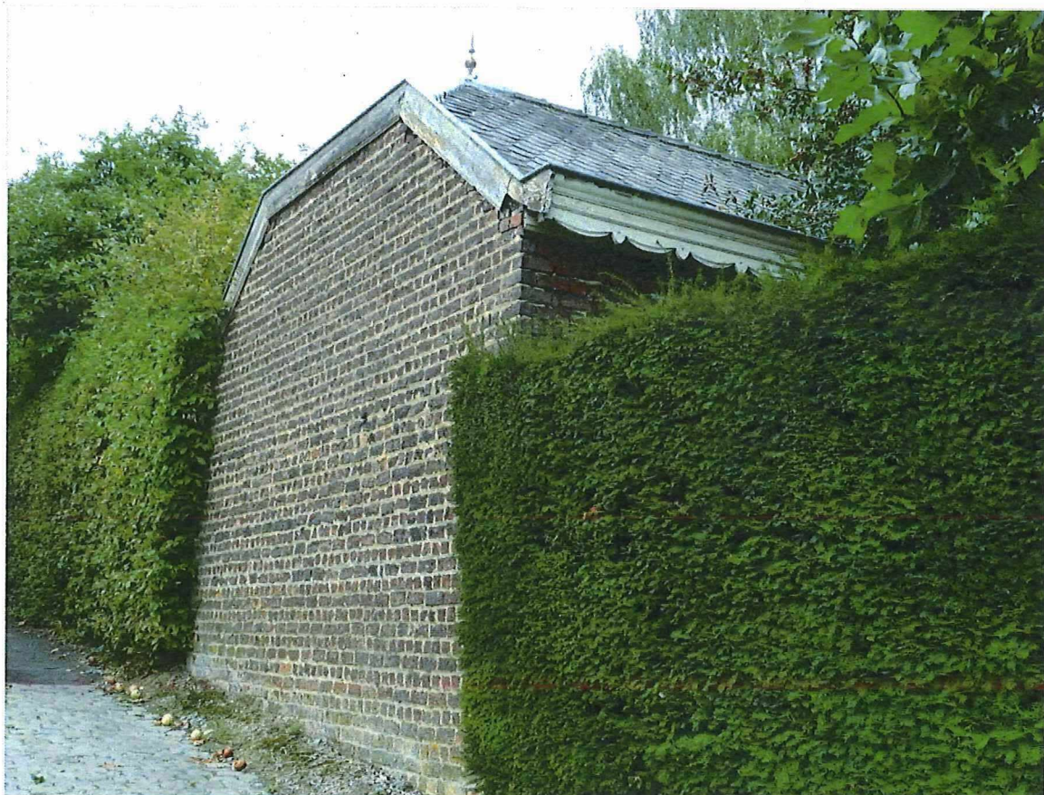
Foto 12: Garage ten noordwesten van de villa, zicht vanop Wagebak (13/09/2018).
