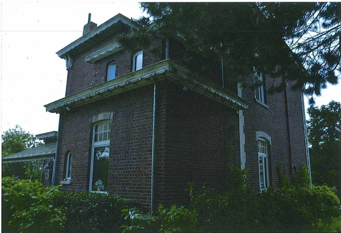
Foto 9: Serristenvilla Muyldermans, vanaf het noordwesten (25/05/2018).
