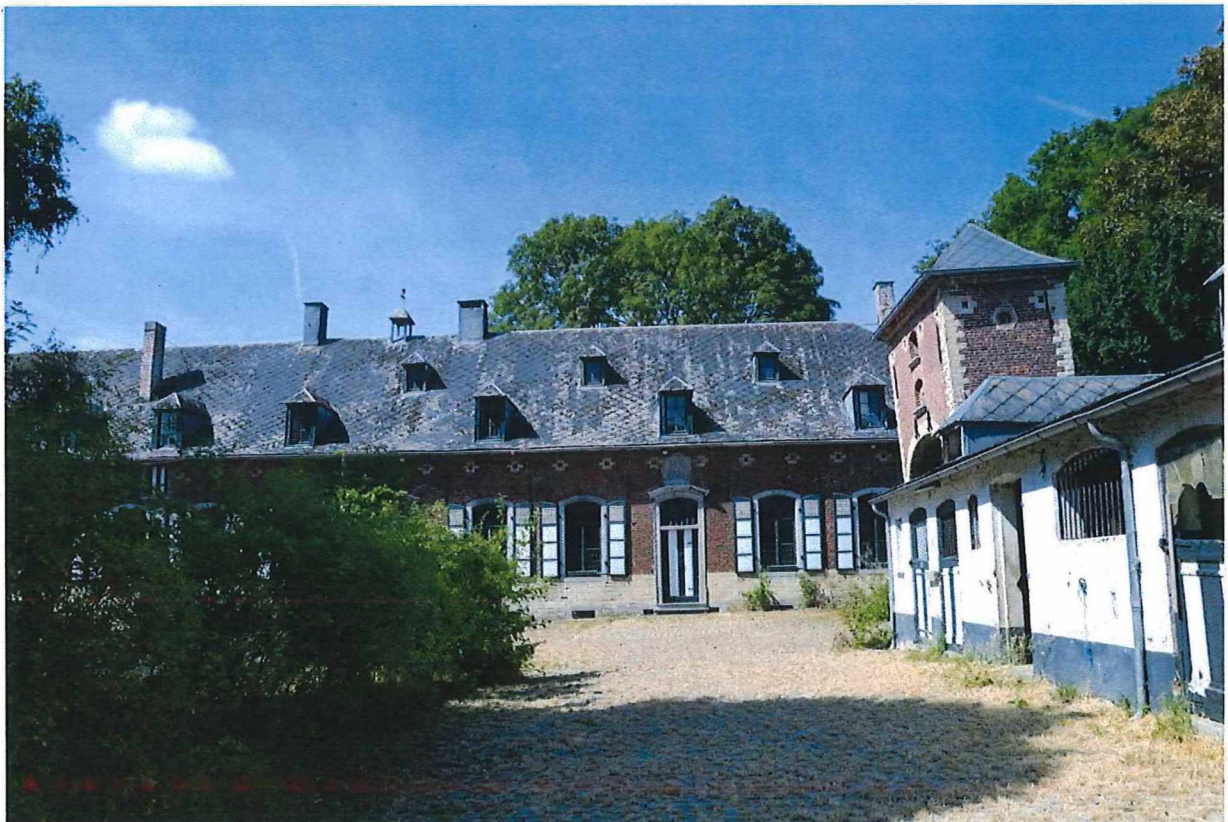
Foto 25: Erfgevel van de noordwestelijke vleugel met boerenwoning. Rechts de straatvleugel met poortgebouw en paardenstallen.
