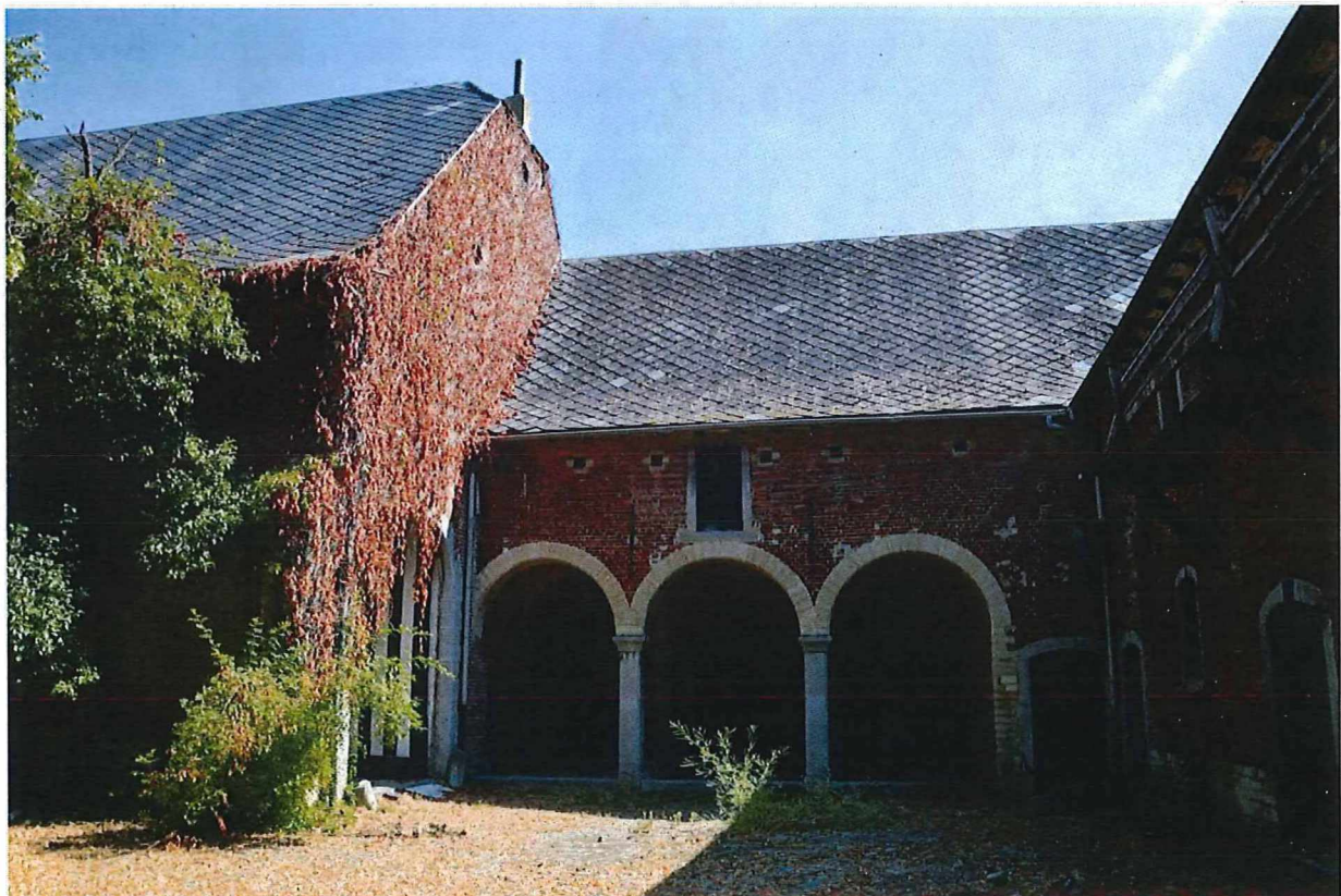
Foto 23: Erfgevel van het wagenhuis, met links de schuur en rechts de stalvleugel.
