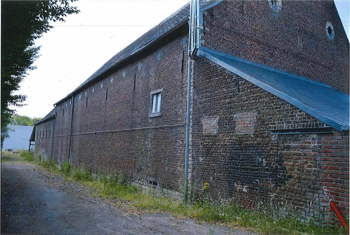
Foto 5: De noordoostelijke vleugel, nagenoeg volledig gesloten buitengevel. Het hoger volume bevat de schuur, het achterliggend lager volume is het wagenhuis met aanpalende stal.
