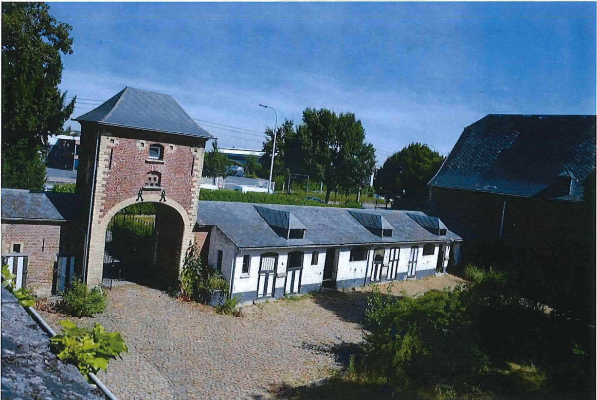
Foto 13: De straatvleugel, gezien vanaf de binnenplaats. Tussen het poortgebouw en de schuur bevinden zich de in 1938 aangebouwde paardenstallen.
