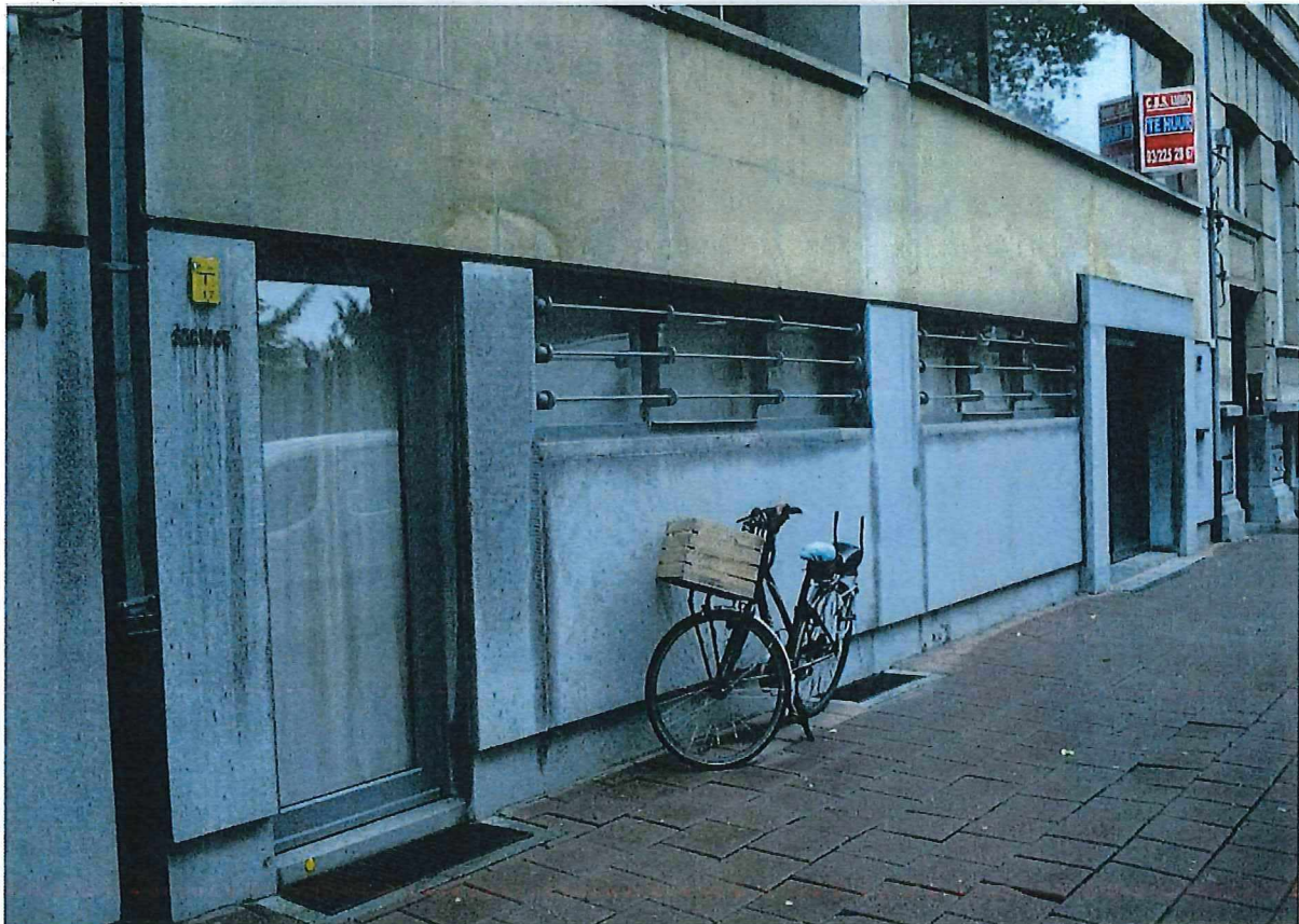
Foto 5: Voorgevel: begane grond met gedrukte pui in blauwe hardsteen: vroegere dienstingang en hoofdingang
