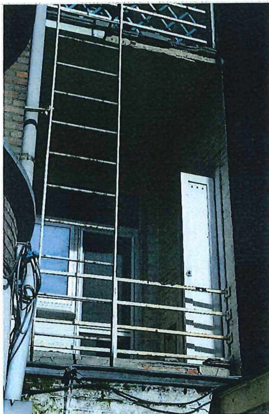
Foto 12: Achtergevel: keuken met koer, voorzien van ingebouwde voorraadkast en vuilluik
