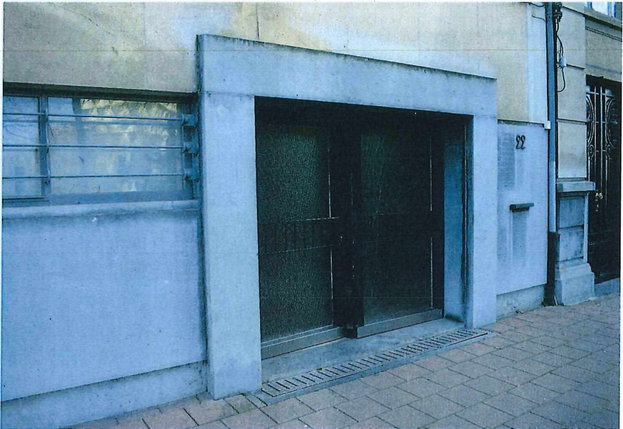
Foto 6: Voorgevel: begane grond, hoofdingang
