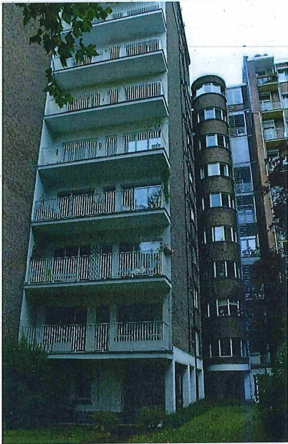
Foto 8: Achtergevels voor- en achterbouw
