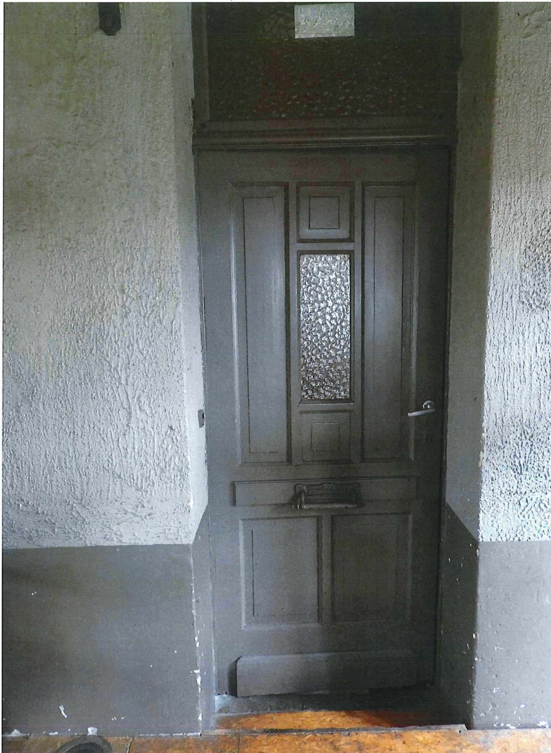
8. Het estaminet 'Au Cher Ami', exterieur, buitenschrijnwerk
