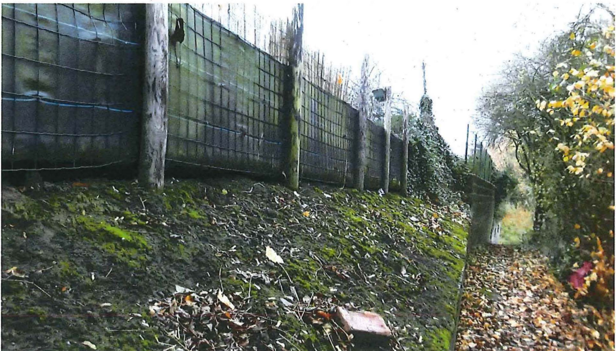
Foto 14: Kattensteeg met betonnen keermuren, kijkend naar het oosten (richting Tongersestraat).
