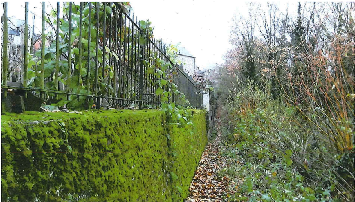
Foto 12: bakstenen tuinmuur langs de Kattensteeg, kijkend naar het oosten (richting Tongersestraat).
