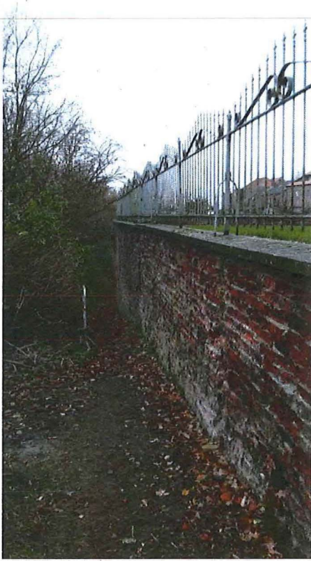
Foto 9: bakstenen tuinmuur langs de Kattensteeg, kijkend naar het westen.
