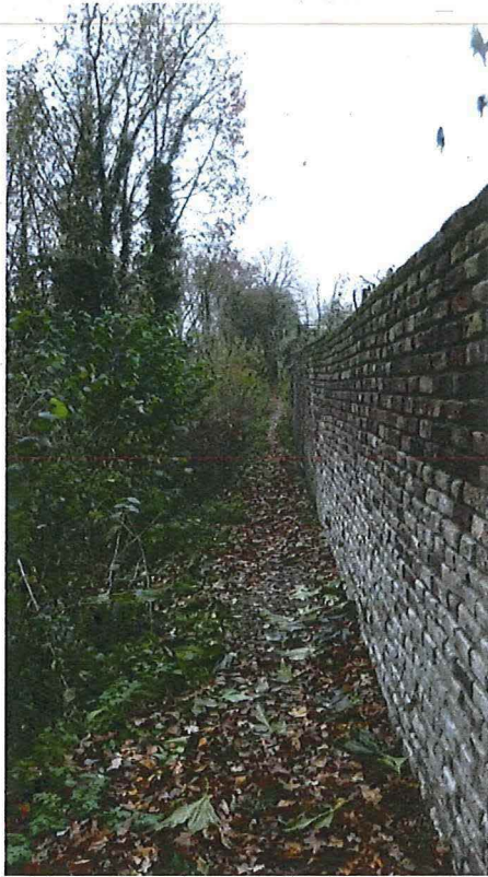
Foto 10: bakstenen tuinmuur langs de Kattensteeg, kijkend naar het westen.
