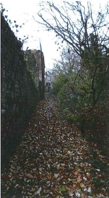
Foto 11: bakstenen tuinmuur langs de Kattensteeg, kijkend naar het oosten (richting Tongersestraat).
