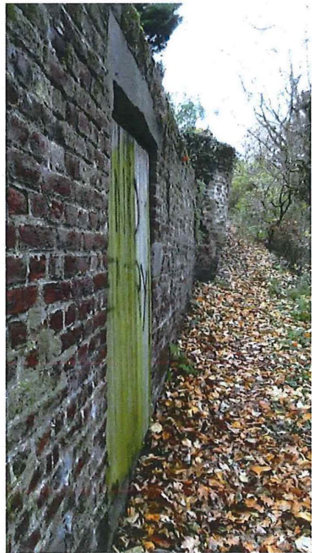
Foto 9: bakstenen tuinmuur langs de Kattensteeg, kijkend naar het oosten (richting Tongersestraat).
