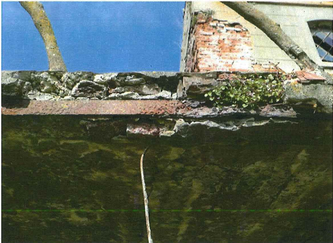
Foto 20: Detail van de wapening van het betonnen platform (© Bressers Architecten 22/11/2017).
