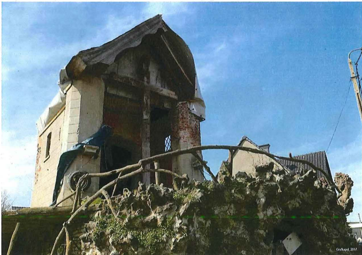
Foto 8: Zicht op bovenbouw met kapelportiek en trappenspui in rotsimitatie (© Bressers Architecten 22/11/2017).
