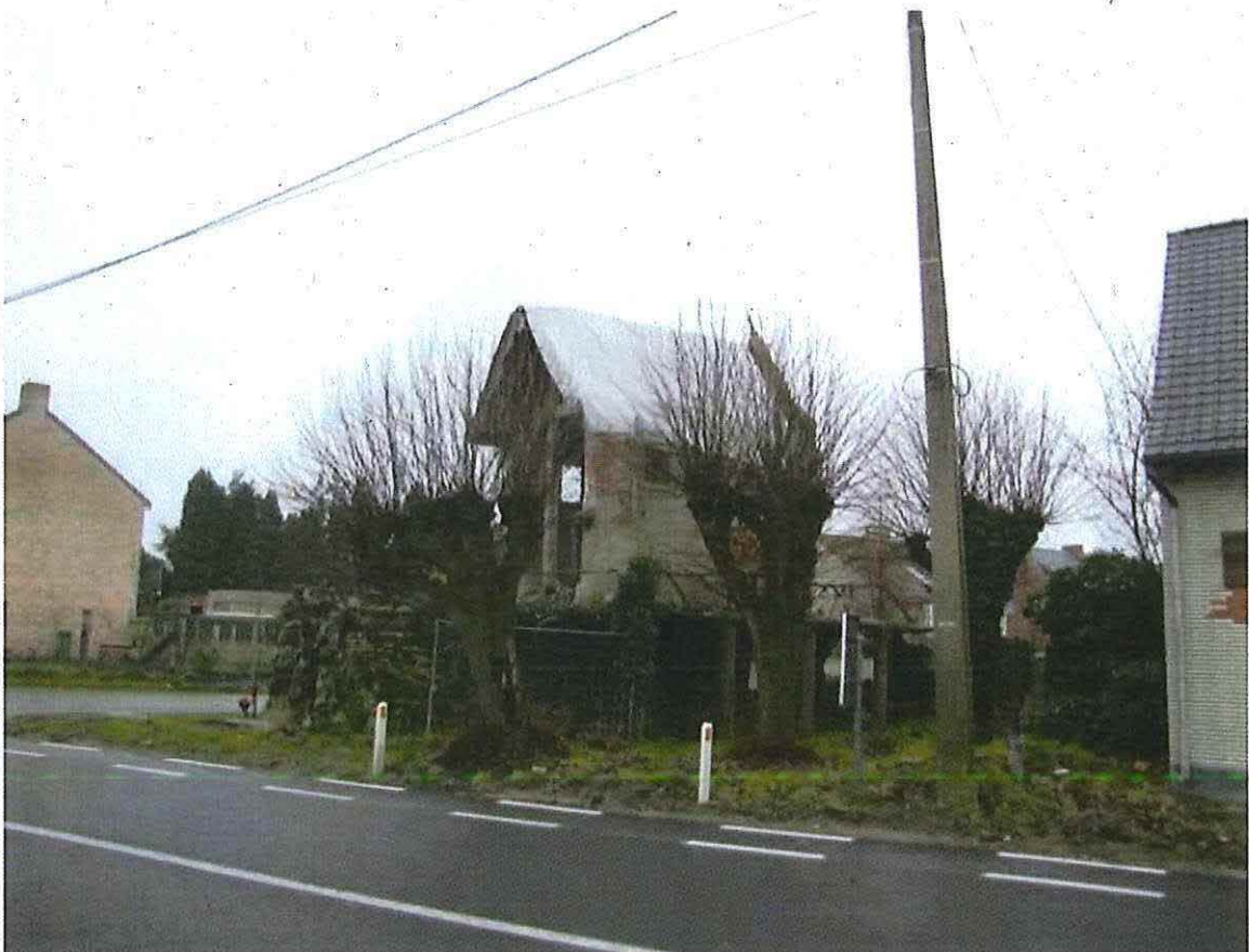
Foto 12: Drie leilindes ter hoogte van de noordwestelijke zijgevel (© Triconsult 07/02/2017).
