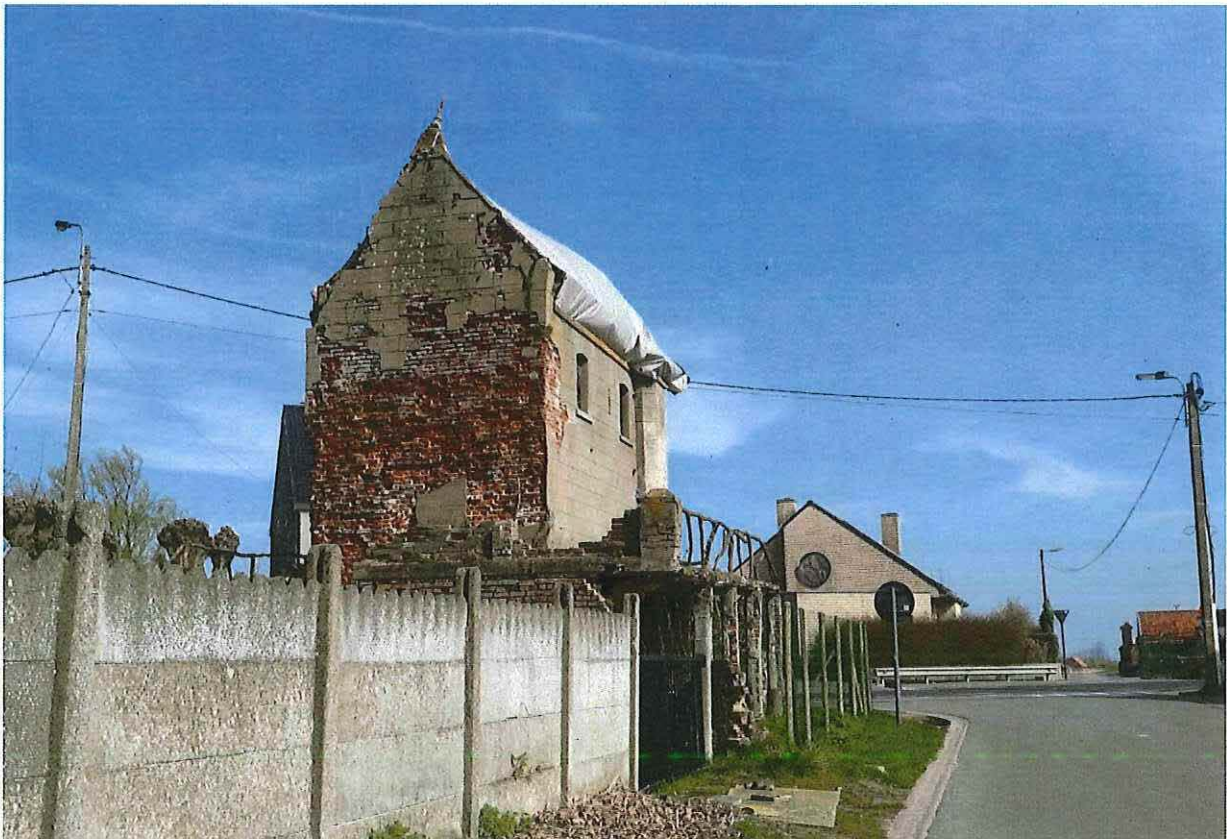
Foto 3: Achtergevel (© Bressers Architecten 22/11/2017).
