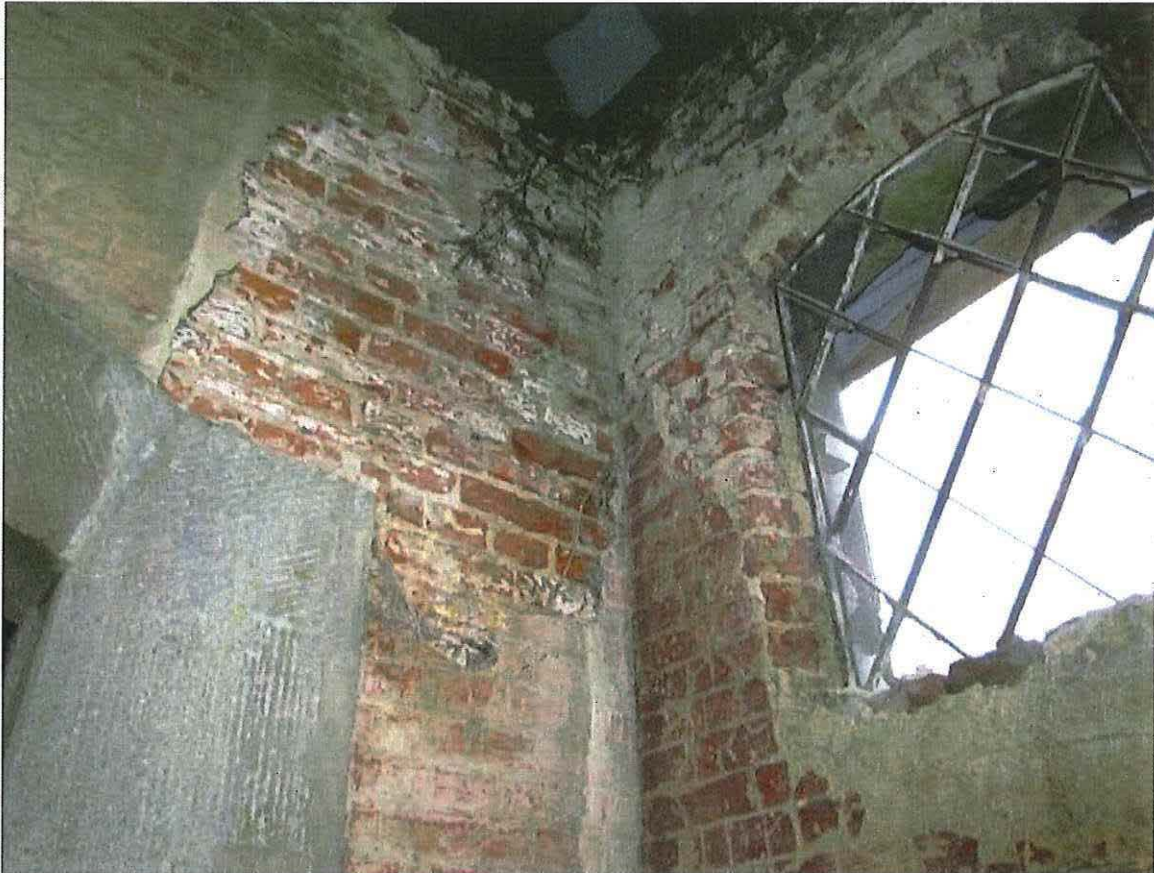
Foto 43: Noordwestelijke buitenmuur met getoogde vensteropening, oorspronkelijk voorzien van glas in lood (© Triconsult 07/02/2017).
