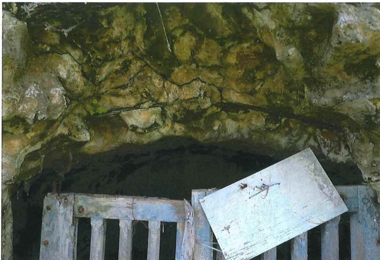
Foto 29: Detail ingang grafkapel onder de trappenui (© Bressers Architecten 22/11/2017).
