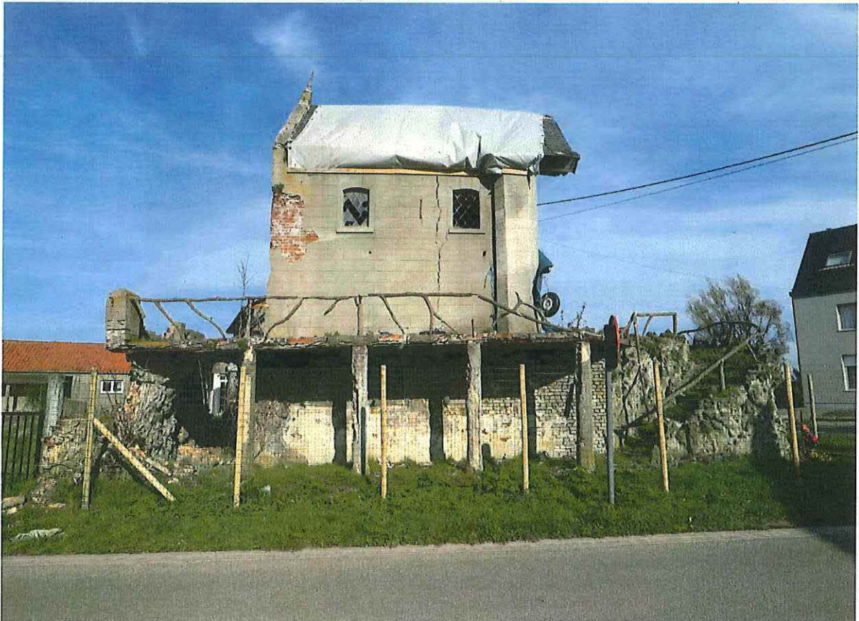
Foto 4: Zuidoostelijke zijgevel (© Bressers Architecten 22/11/2017).
