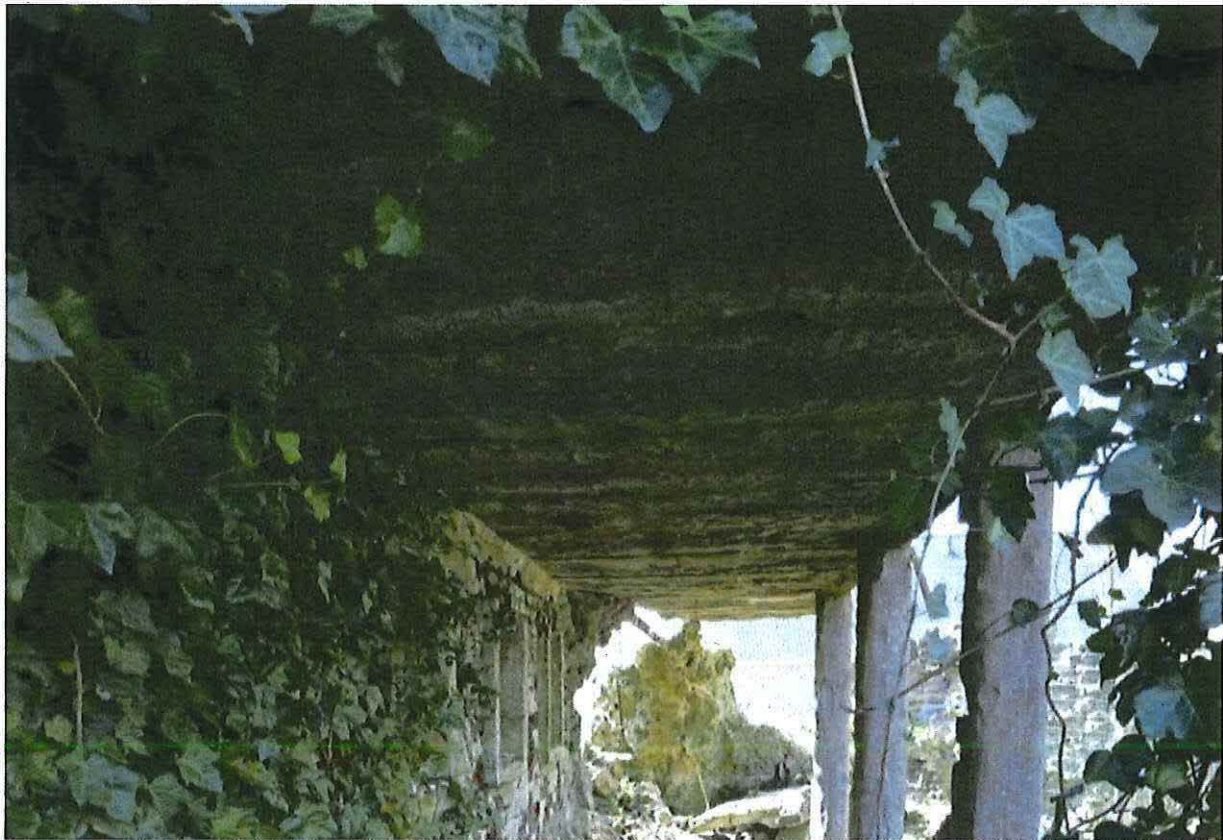
Foto 22: Omgang (© Bressers Architecten 07/02/2017)
