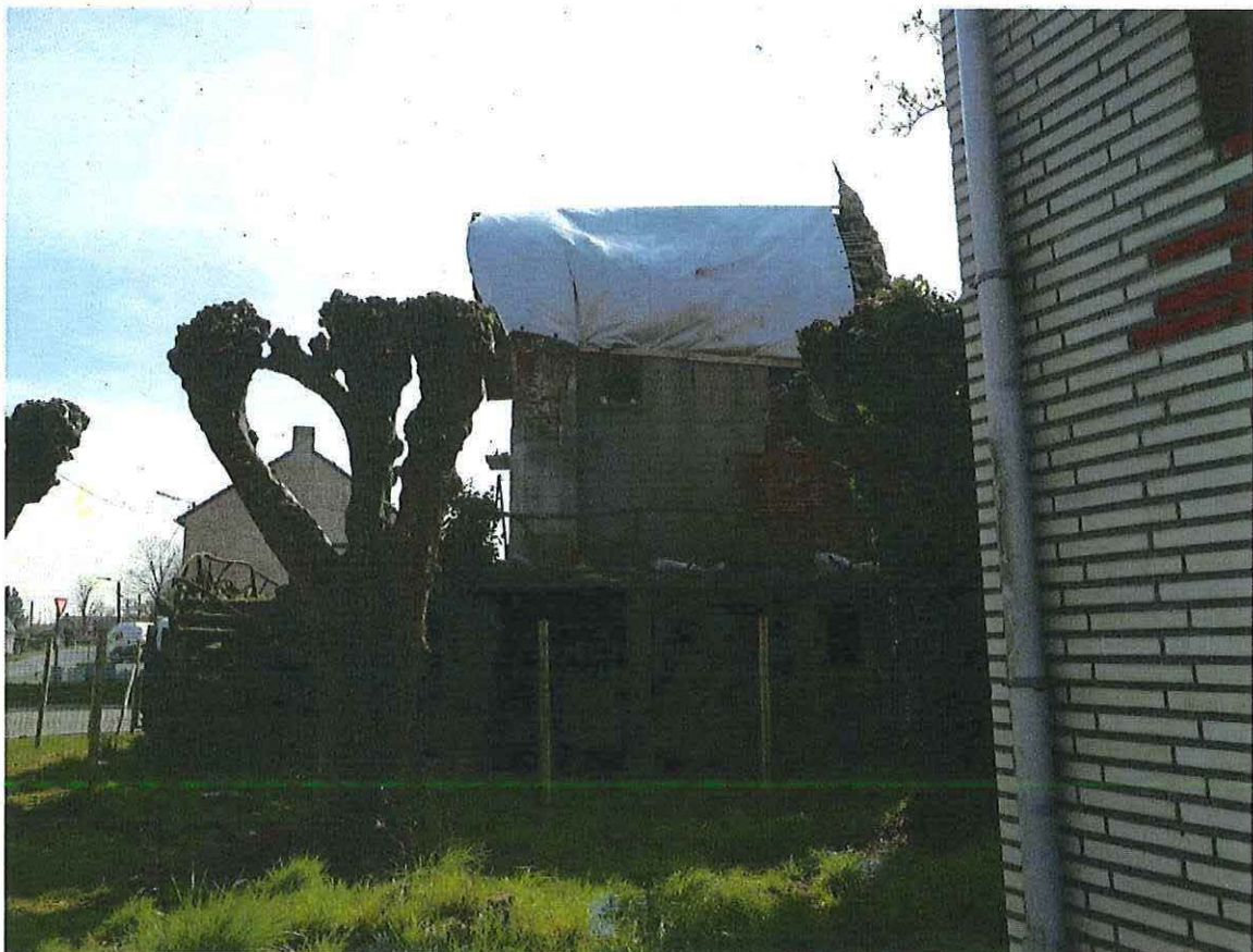
Foto 5: Noordwestelijke zijgevel (© Bressers Architecten 22/11/2017).
