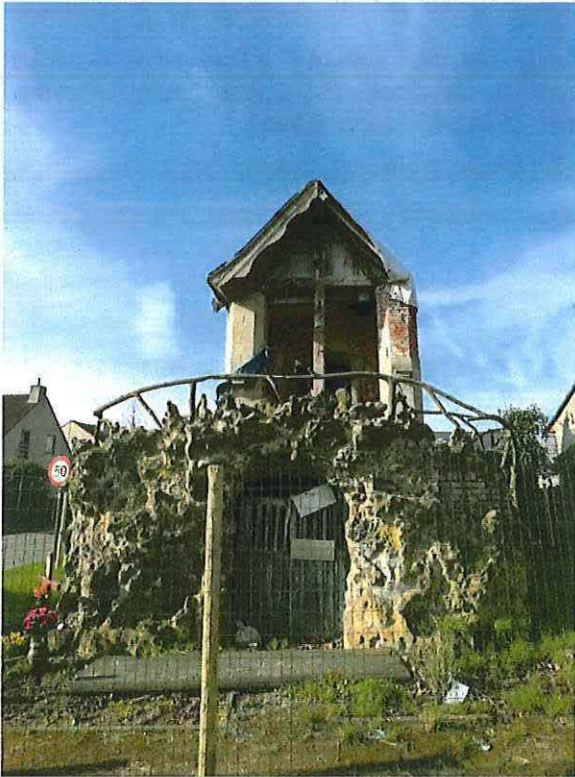
Foto 1: Voorgevel grafkapel De Kalvaer (© Bressers Architecten 22/11/2017).
