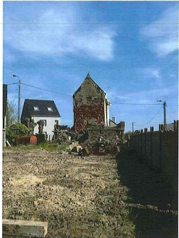
Foto 2: Achtergevel grafkapel De Kalvaer, gezien vanuit belendende perceel (© Bressers Architecten 22/11/2017).
