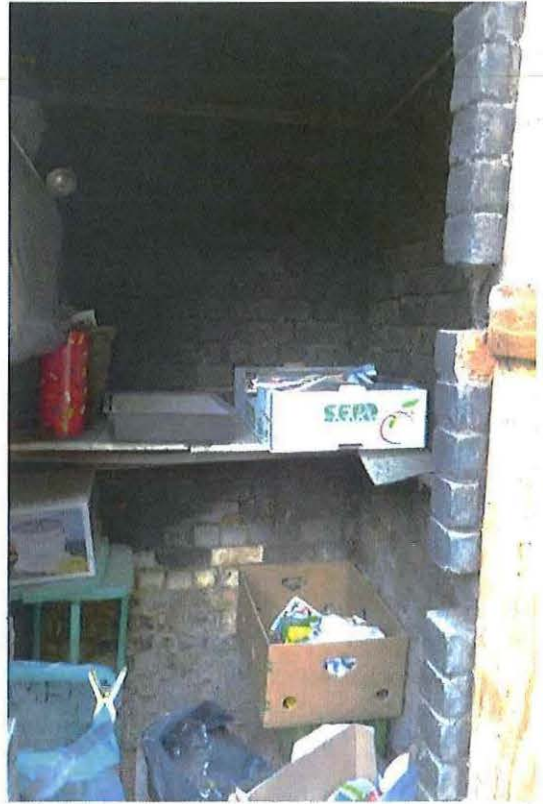
Foto 32: Rookoventje. Binnenkant. Toestand 5 september 2012.
