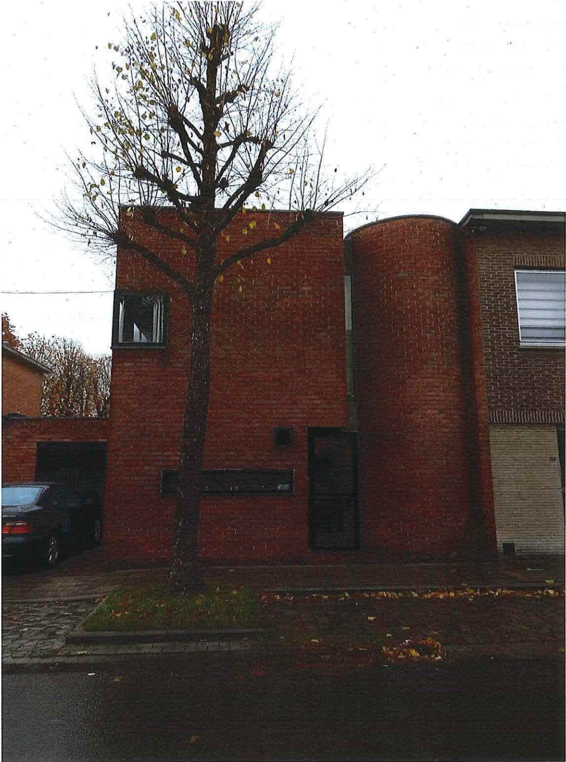
Foto 1: Woning De Bruycker, voorgevel (12 november 2018)
