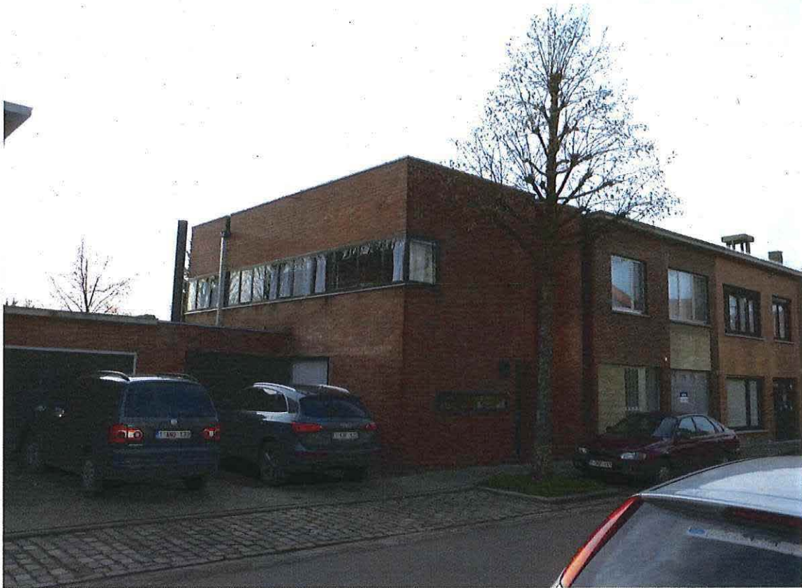
Foto 4: Zicht op zijgevel (17 december 2015)
